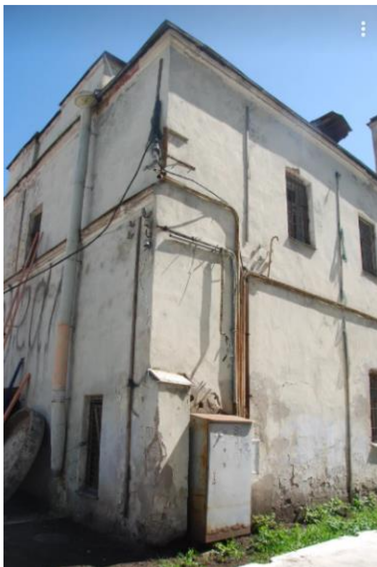
29. Западный фасад объекта культурного наследия регионального значения «Усадьба Игеля Э.Г.», расположенного по адресу: г. Санкт-Петербург, Каменноостровский пр., д. 58-60, литера А. Фрагмент. 15.07.2022
