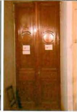
Вид со стороны коридора
