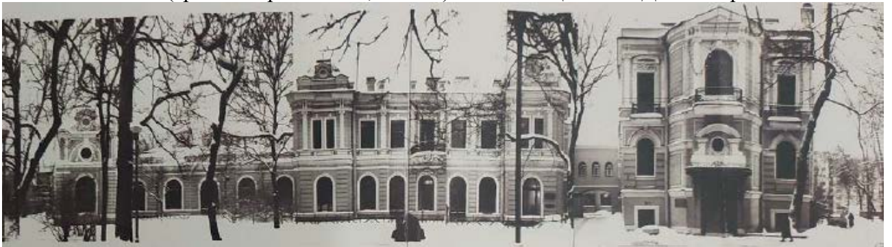
13. Фасад существующий зданий по Каменноостровскому пр. д.58-60, Лит. А и Лит. Б. 1984 г. // КГИОП. Н-9170. Л. 65.
