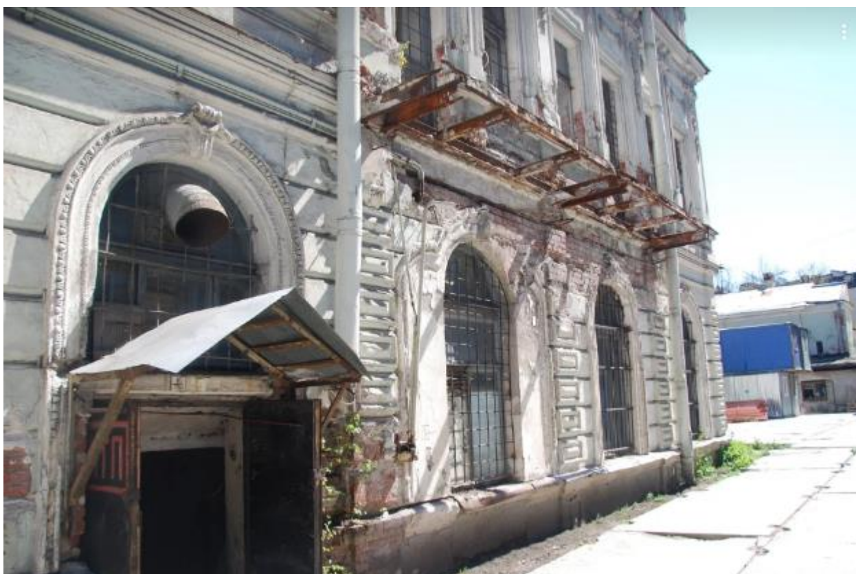
32. Западный фасад объекта культурного наследия регионального значения «Усадьба Игеля Э.Г.», расположенного по адресу: г. Санкт-Петербург, Каменноостровский пр., д. 58-60, литера А. Фрагмент. 15.07.2022
