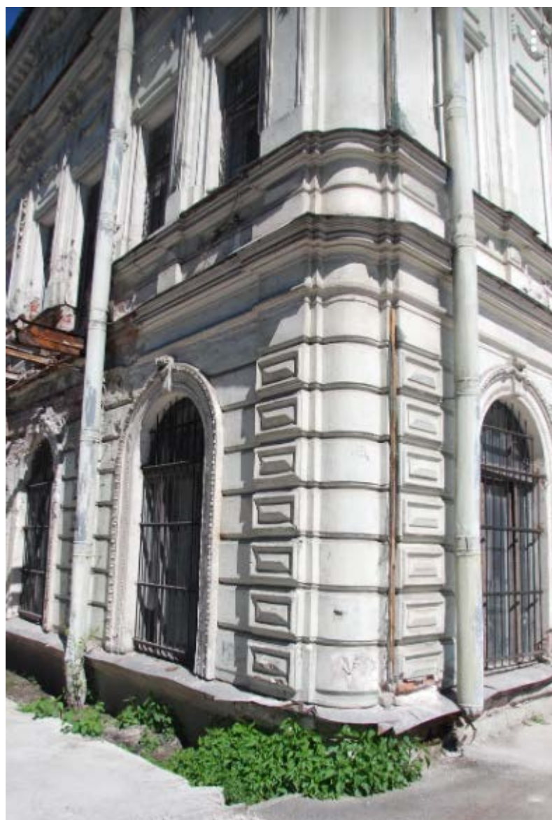
34. Западный фасад объекта культурного наследия регионального значения «Усадьба Игеля Э.Г.», расположенного по адресу: г. Санкт-Петербург, Каменноостровский пр., д. 58-60, литера А. Фрагмент. 15.07.2022
