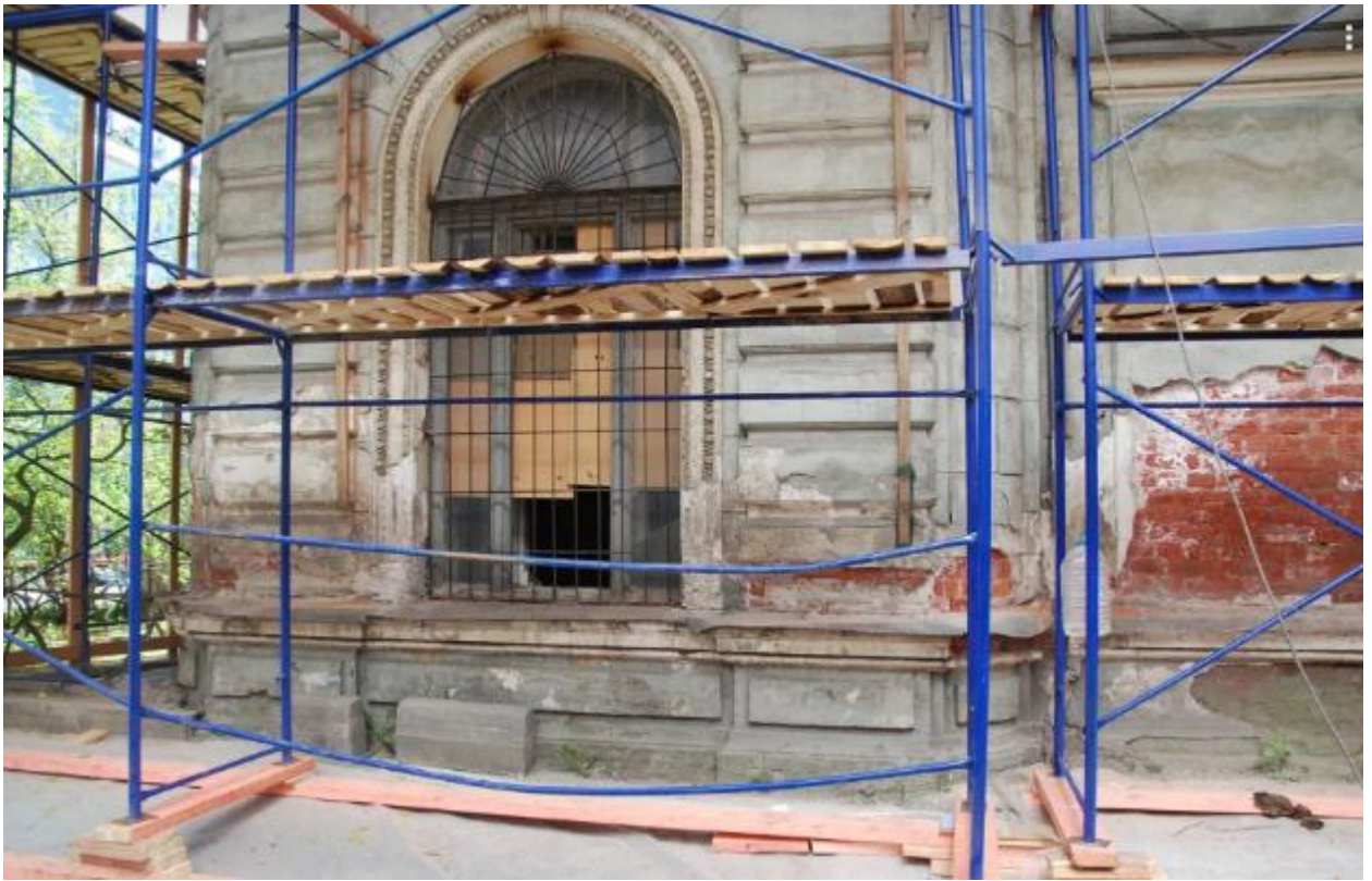
16. Северный дворовый фасад объекта культурного наследия регионального значения «Усадьба Игеля Э.Г.», расположенного по адресу: г. Санкт-Петербург, Каменноостровский пр., д. 58-60, литера А. Фрагмент. 15.07.2022
