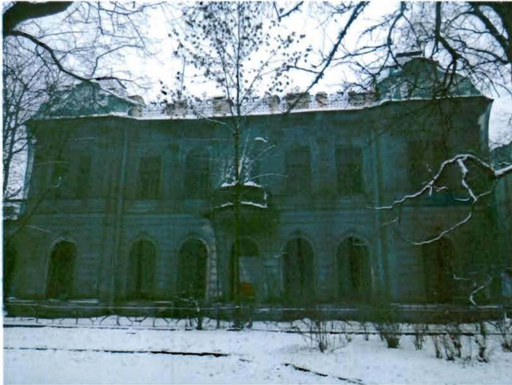
1. Особняк (восточный фасад)
