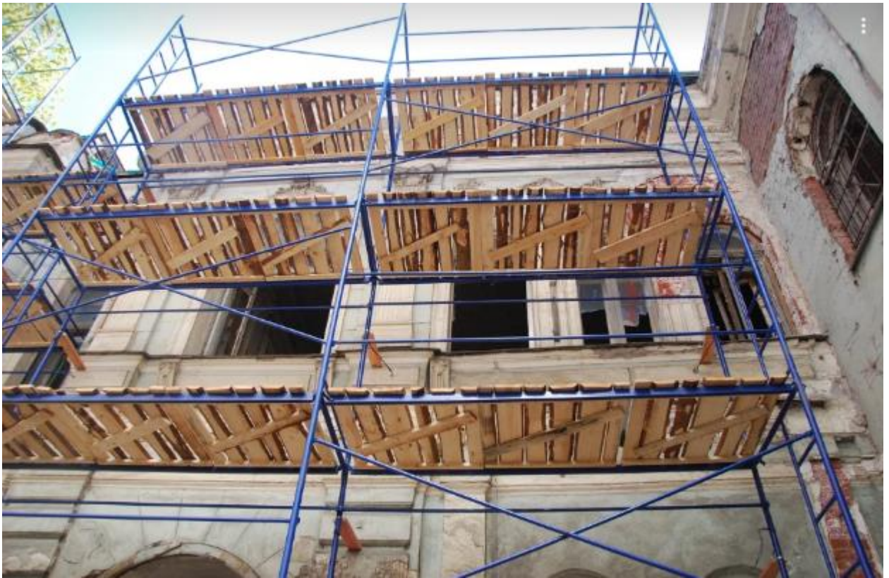
15. Северный дворовый фасад объекта культурного наследия регионального значения «Усадьба Игеля Э.Г.», расположенного по адресу: г. Санкт-Петербург, Каменноостровский пр., д. 58-60, литера А. Фрагмент. 15.07.2022
