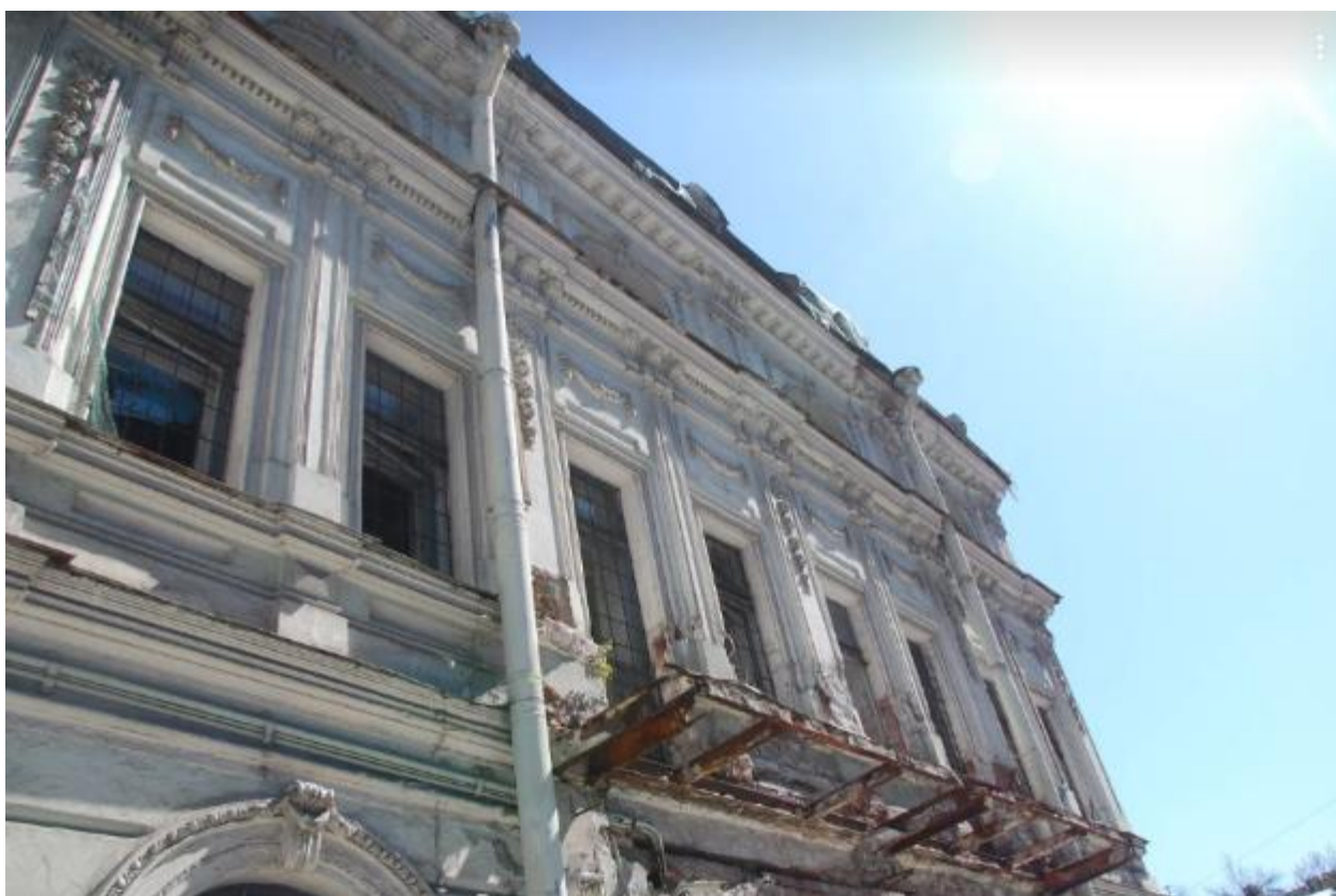
33. Западный фасад объекта культурного наследия регионального значения «Усадьба Игеля Э.Г.», расположенного по адресу: г. Санкт-Петербург, Каменноостровский пр., д. 58-60, литера А. Фрагмент. 15.07.2022
