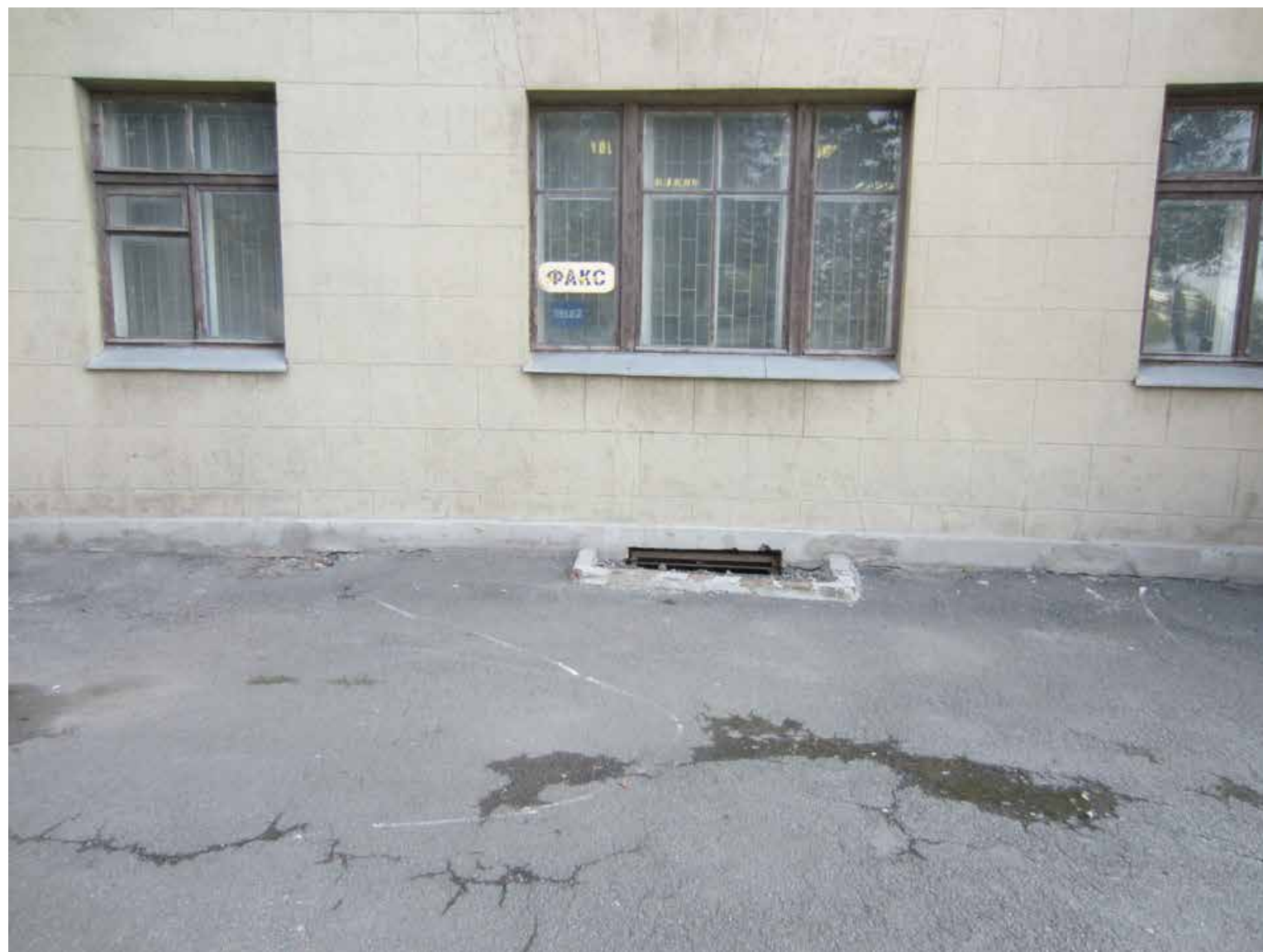
4. Объект культурного наследия регионального значения «Комплекс жилых домов (6 зданий)», расположенный по адресу: Санкт-Петербург, Красногвардейский район, Малоохтинский пр., 86, лит. А Фрагмент облицовки цоколя, заполнение оконных проемов в уровне 1-го этажа Съемка: 12 сентября 2019г.
