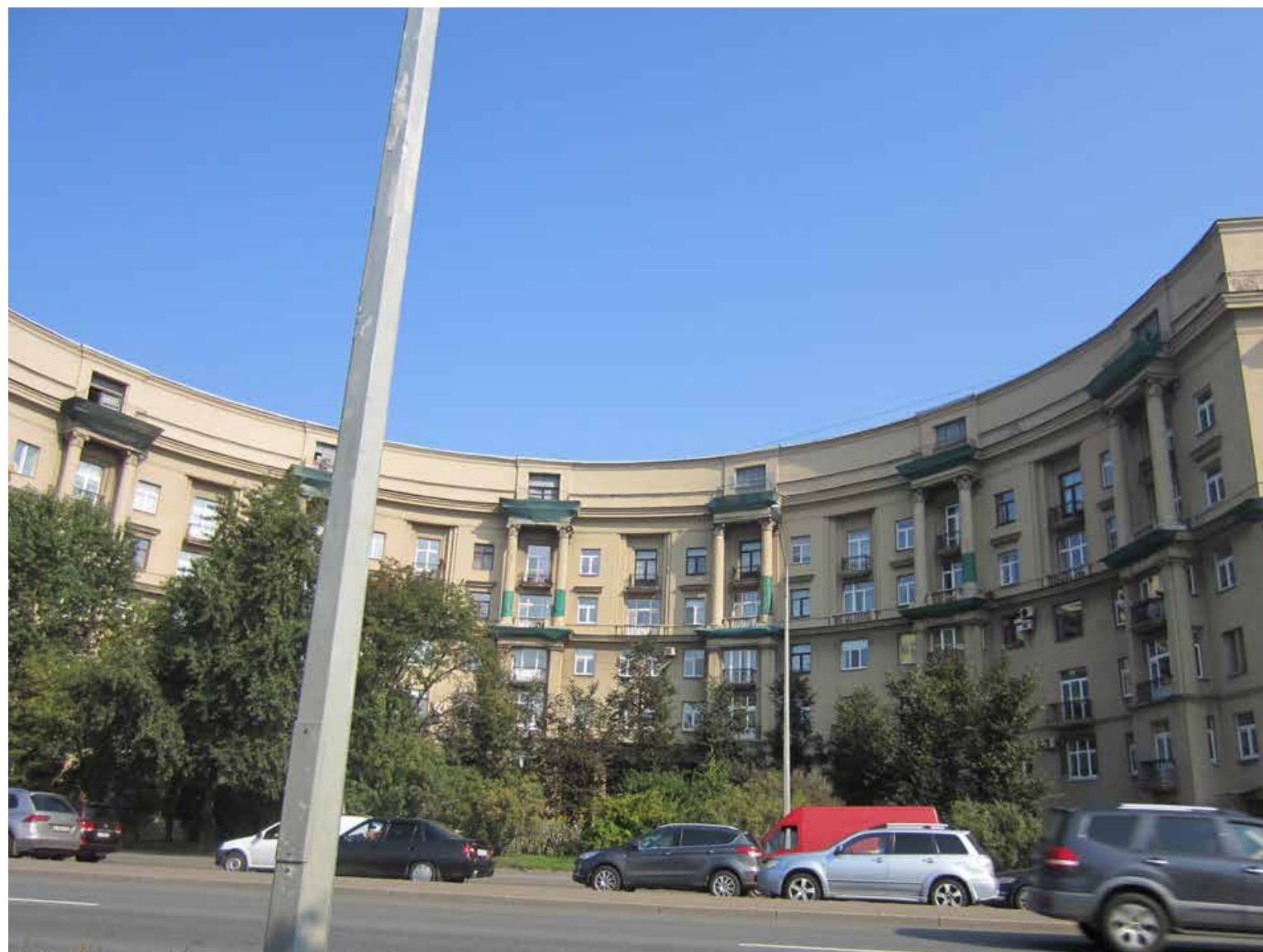
2. Объект культурного наследия регионального значения «Комплекс жилых домов (6 зданий)», расположенный по адресу: Санкт-Петербург, Красногвардейский район, Малоохтинский пр., 86, лит. А Вид лицевого фасада с Малоохтинского проспекта. Эркеры на высоте 1-2 этажей, завершенные 2-х ярусными порталами (с пилонами на уровне 3-4 этажей и колоннами на уровне 5-6 этажей) Съемка: 12 сентября 2019г.
