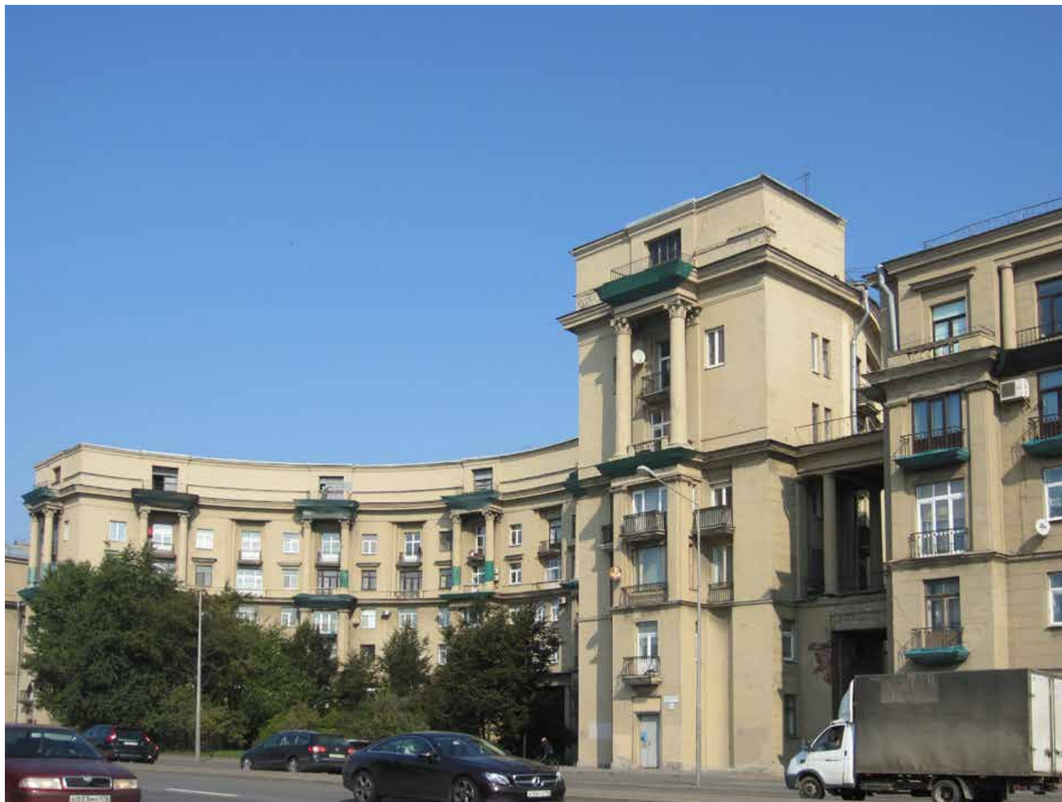
3. Объект культурного наследия регионального значения «Комплекс жилых домов (6 зданий)», расположенный по адресу: Санкт-Петербург, Красногвардейский район, Малоохтинский пр., 86, лит. А Общий вид рассматриваемого объекта с юга. Эркер в торцевой части здания Съемка: 12 сентября 2019г.
