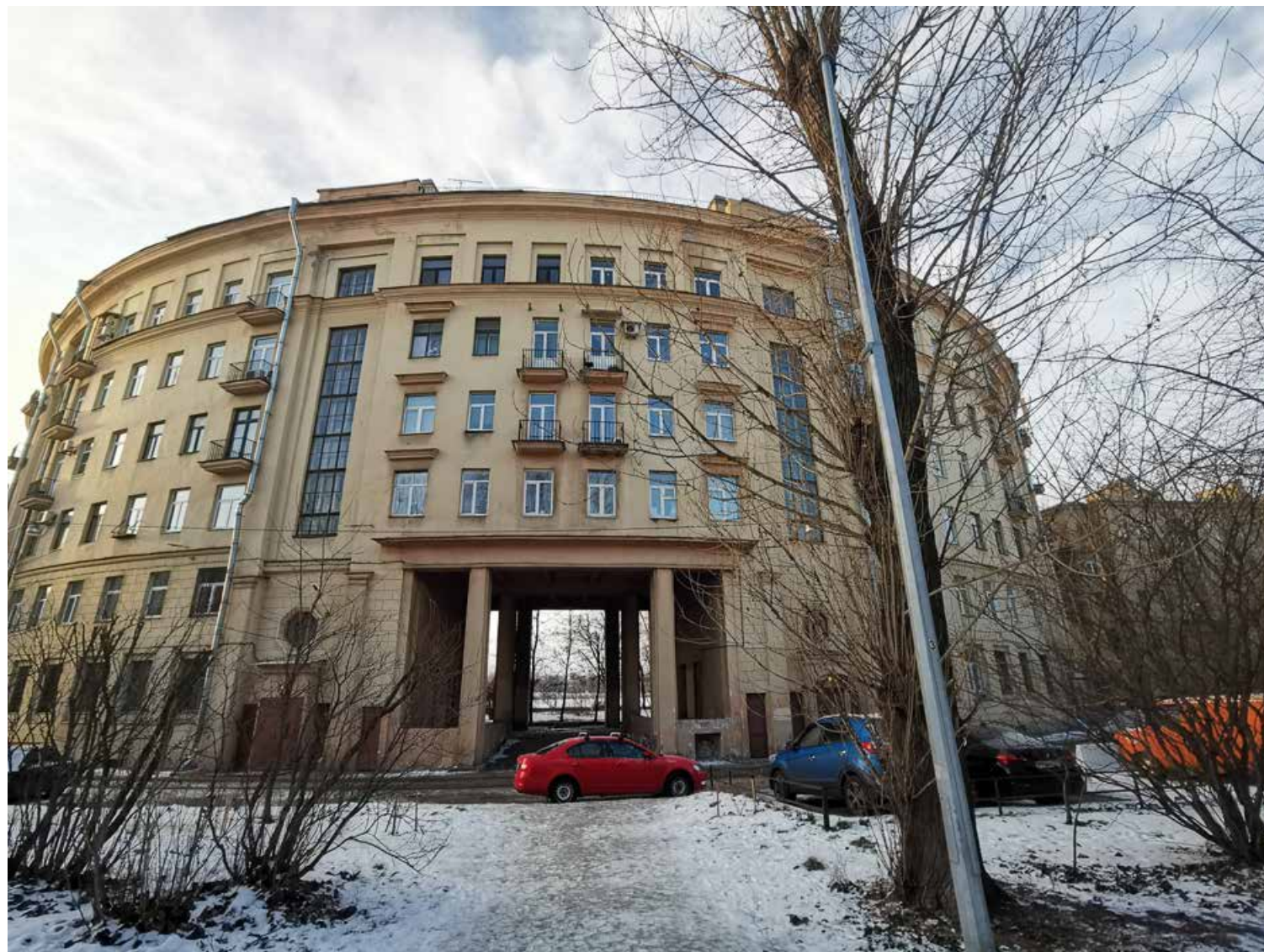
39. Объект культурного наследия регионального значения «Комплекс жилых домов (6 зданий)», расположенный по адресу: Санкт-Петербург, Красногвардейский район, Малоохтинский пр., 86, лит. А Центральный воротный проезд на пилонах с плоским кессонированным перекрытием Съемка: 14 декабря 2020 г.
