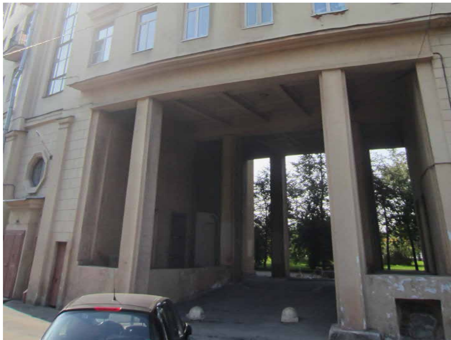
14. Объект культурного наследия регионального значения «Комплекс жилых домов (6 зданий)», расположенный по адресу: Санкт-Петербург, Красногвардейский район, Малоохтинский пр., 86, лит. А Центральный воротный проезд на пилонах с плоским кессонированным перекрытием Съемка: 12 сентября 2019г.
