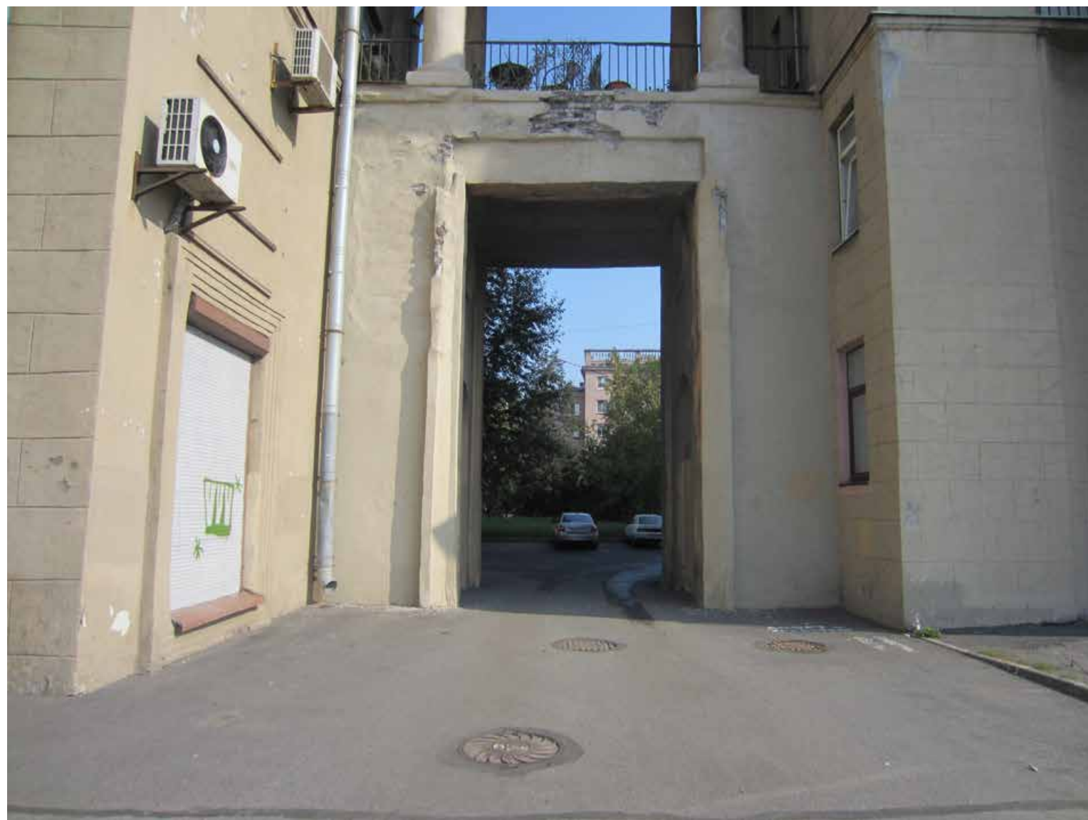
17. Объект культурного наследия регионального значения «Комплекс жилых домов (6 зданий)», расположенный по адресу: Санкт-Петербург, Красногвардейский район, Малоохтинский пр., 86, лит. А Фрагмент северной пристройки здания Съемка: 12 сентября 2019г.
