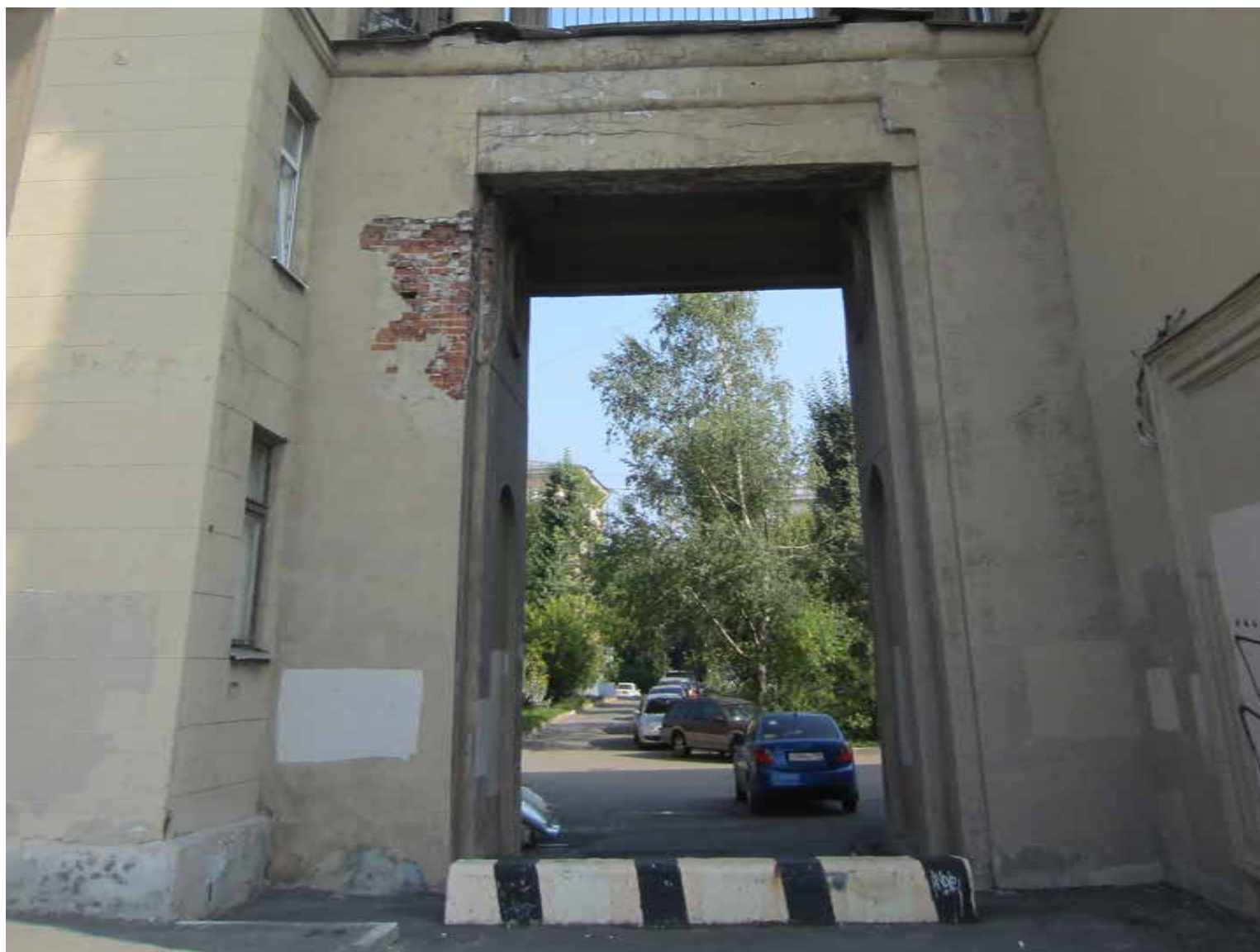
23. Объект культурного наследия регионального значения «Комплекс жилых домов (6 зданий)», расположенный по адресу: Санкт-Петербург, Красногвардейский район, Малоохтинский пр., 86, лит. А Фрагмент южной пристройки здания Съемка: 12 сентября 2019г.
