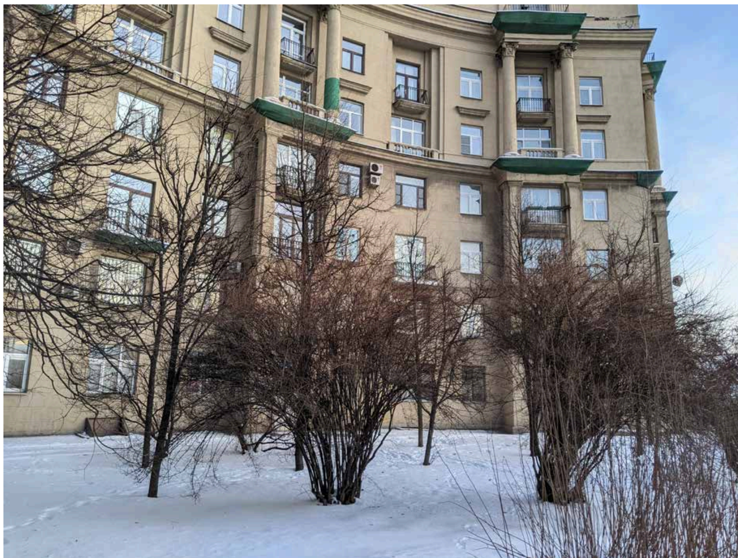
29. Объект культурного наследия регионального значения «Комплекс жилых домов (6 зданий)», расположенный по адресу: Санкт-Петербург, Красногвардейский район, Малоохтинский пр., 86, лит. А Фрагмент облицовки цоколя, заполнение оконных проемов в уровне 1-го этажа Съемка: 14 декабря 2020 г.
