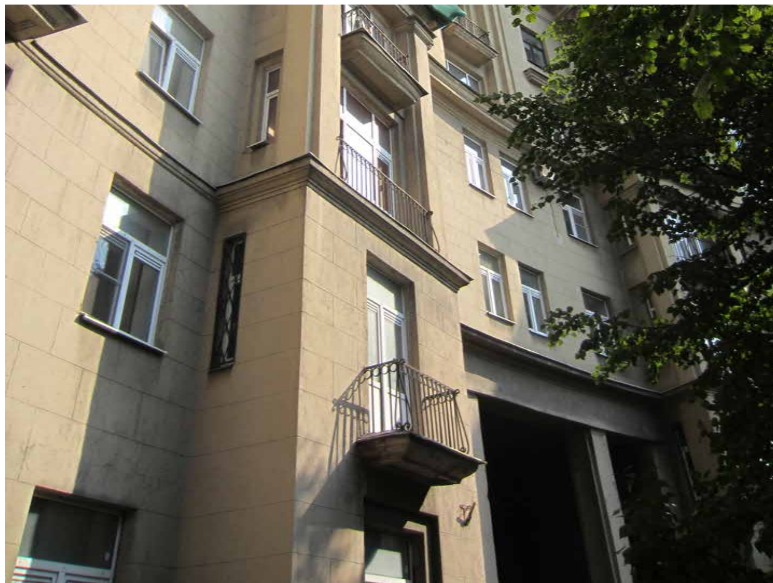
5. Объект культурного наследия регионального значения «Комплекс жилых домов (6 зданий)», расположенный по адресу: Санкт-Петербург, Красногвардейский район, Малоохтинский пр., 86, лит. А Фрагмент лицевого фасада, один из восьми экреров на высоту 1-2 этажей Съемка: 12 сентября 2019г.
