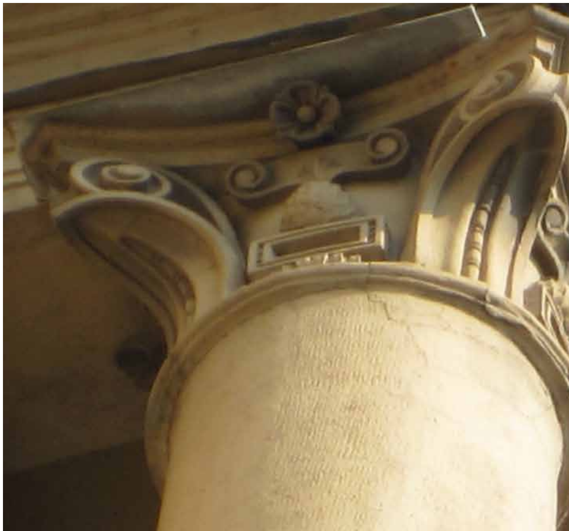
34. Объект культурного наследия регионального значения «Комплекс жилых домов (6 зданий)», расположенный по адресу: Санкт-Петербург, Красногвардейский район, Малоохтинский пр., 86, лит. А Фрагмент фасада. Стилизованная дорическая колонна в эркере на уровне 6 этажа Съемка: 14 декабря 2020 г.
