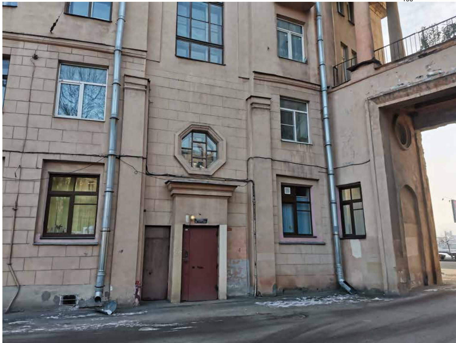
37. Объект культурного наследия регионального значения «Комплекс жилых домов (6 зданий)», расположенный по адресу: Санкт-Петербург, Красногвардейский район, Малоохтинский пр., 86, лит. А Фрагмент дворового фасада. Профилированный наличник восьмигранного окна, прямой сандрик над дверным проемом Съемка: 14 декабря 2020 г.
