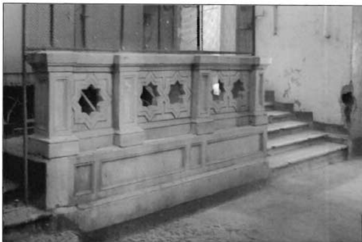
14. Интерьер. Фрагмент. Солея с ограждением.
