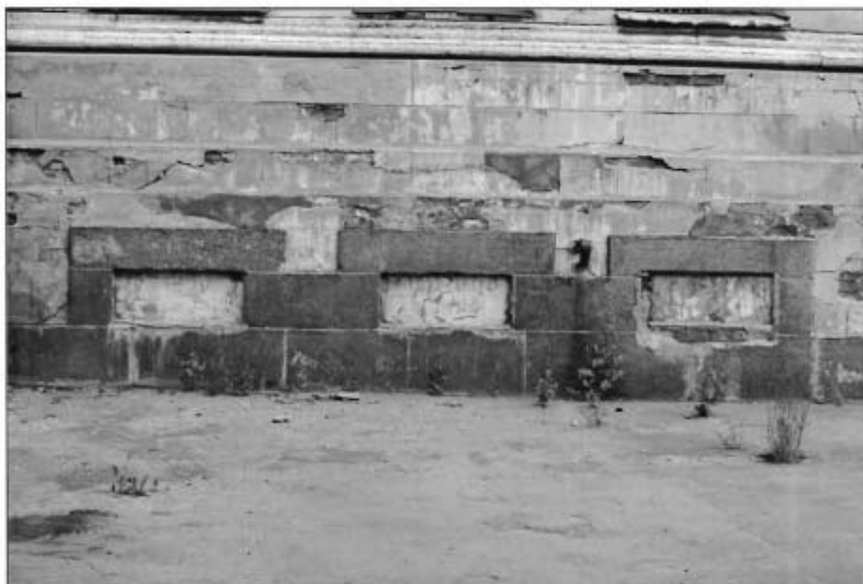
7. Западный фасад. Фрагмент. Цоколь.
