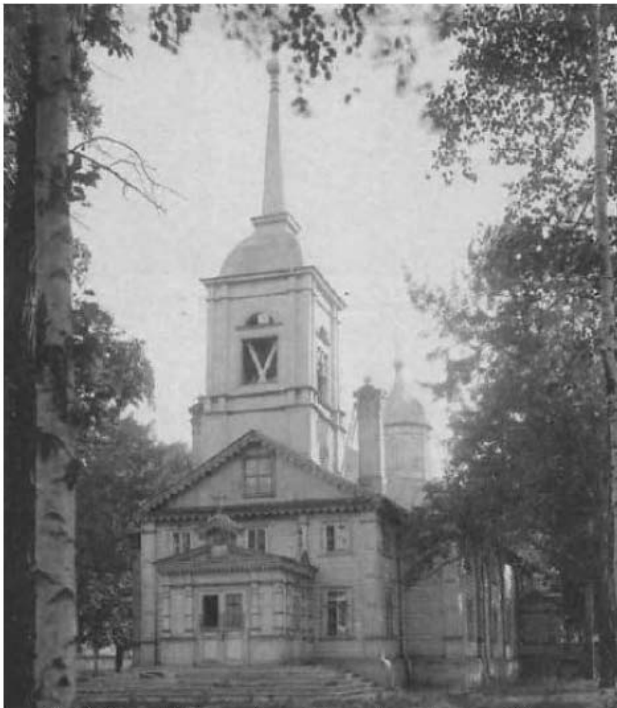
Илл.90. Церковь Св.Троицы в Галерной Гавани. Фотография начала XX века //Историческая записка. Шифр 154/18-М-И. ООО «СтройТехПроект».
