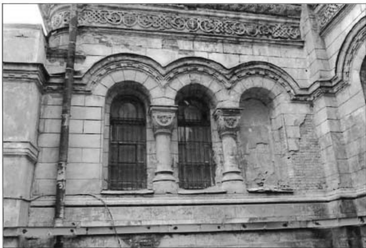
9. Западный фасад. Фрагмент.
