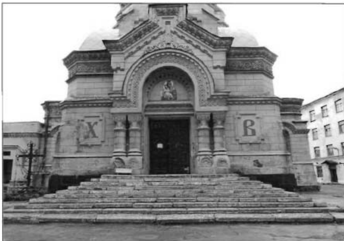
5. Западный фасад. Фрагмент.
