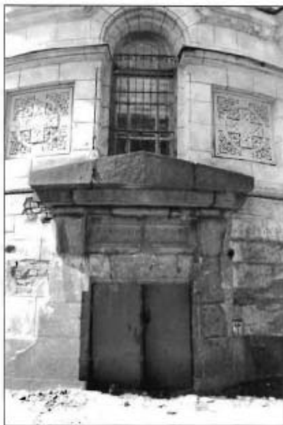
12. . Восточный фасад. Фрагмент. Входной проем в уровне подвала.
