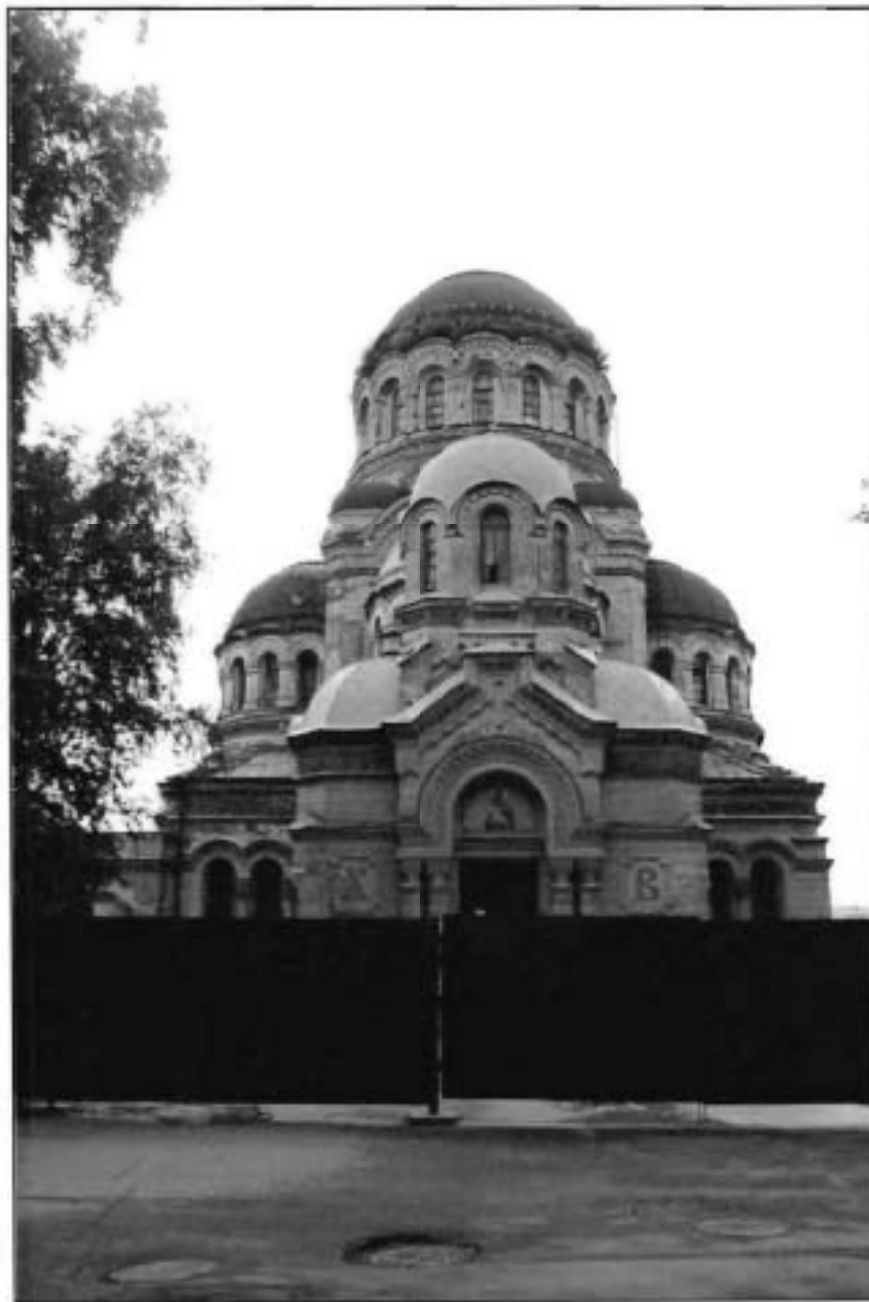
1. Западный фасад. Общий вид.
