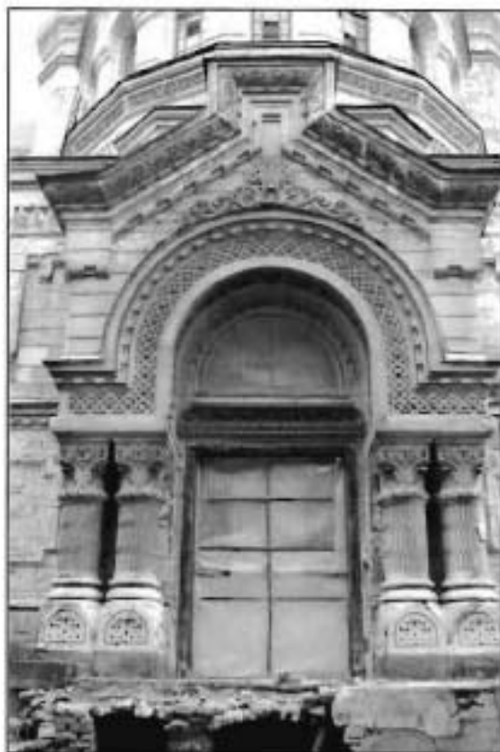
6. Южный фасад. Фрагмент.
