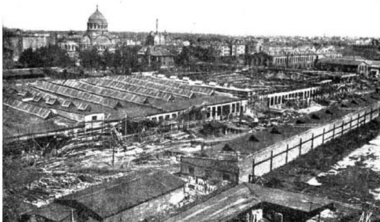
Илл. 70 Строительство нового цеха на заводе «Севкабель». 1930-е гг. // ЦГА КФФД СПб. Шифр: Вр 815.
