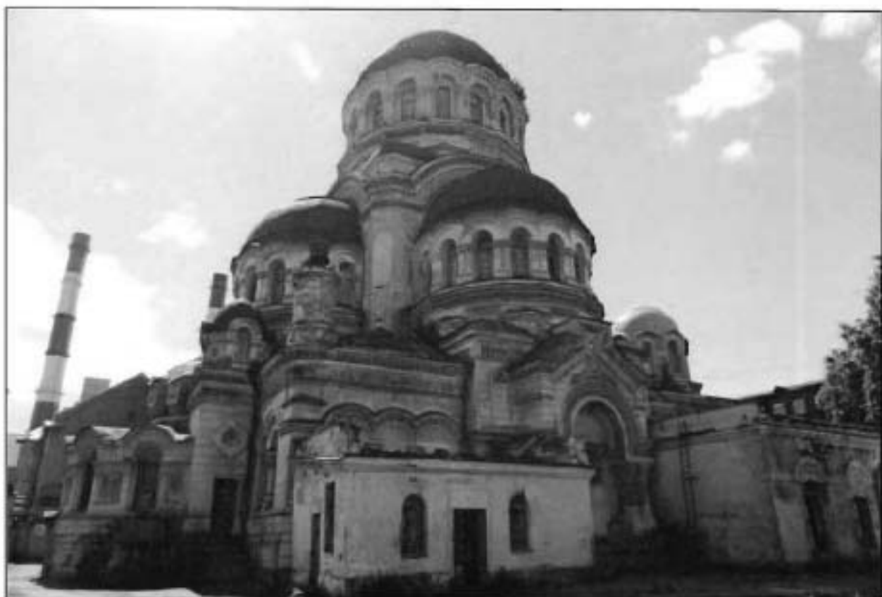
2. Общий вид с северо-востока.
