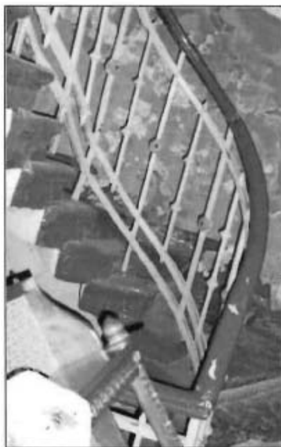
15. Интерьер. Фрагмент. Лестница на хоры
