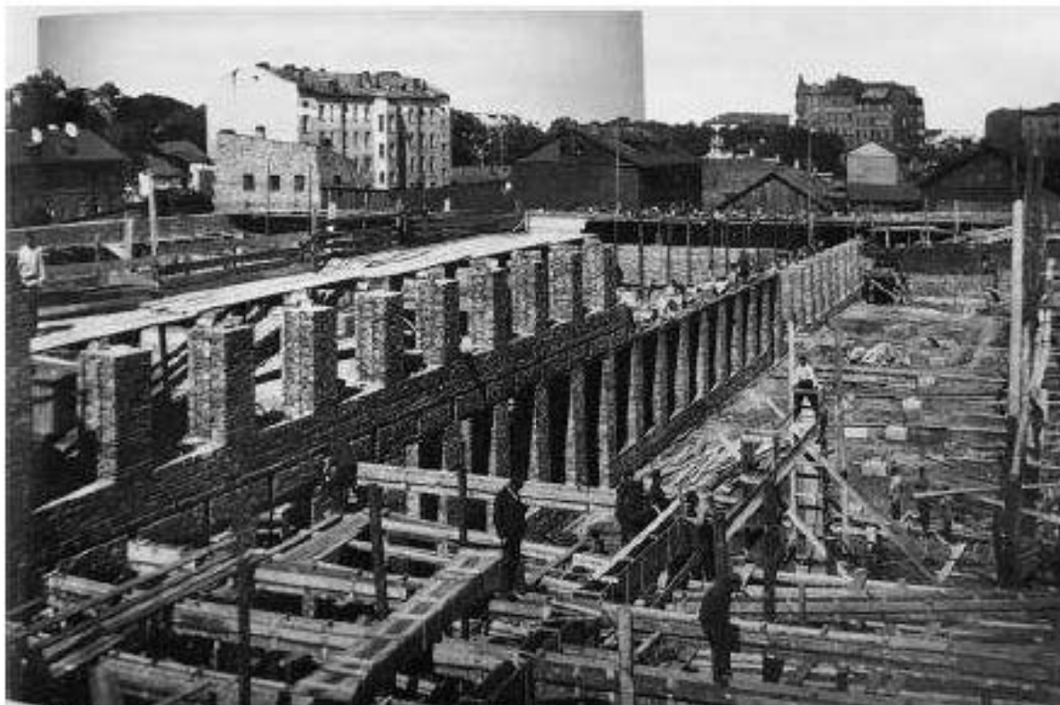
Илл. 68 Строительство цехов акционерного общества русских электротехнических заводов «Сименс и Гальске». (В.О., Кожевенная линия, д.39). // [Электронный ресурс]:URL: http://pastvu.com .
