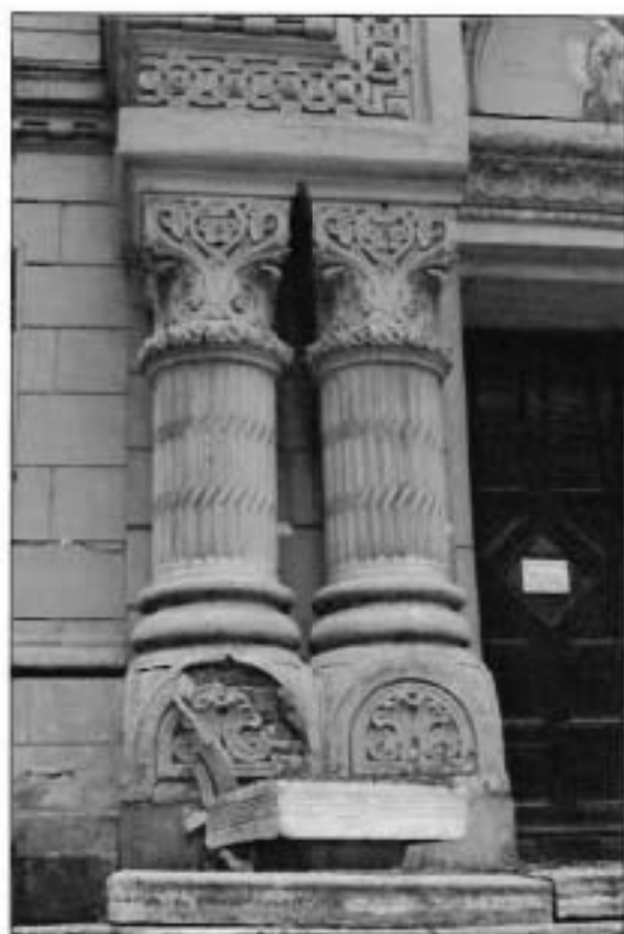
10. Западный фасад. Фрагмент.
