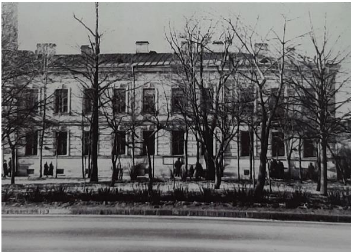
3. Бульвар Большого проспекта Васильевского острова у дома №59. Фото конца 1920-х гг. Архив КГИОП. Инв. № 0587 (04-69-08).
