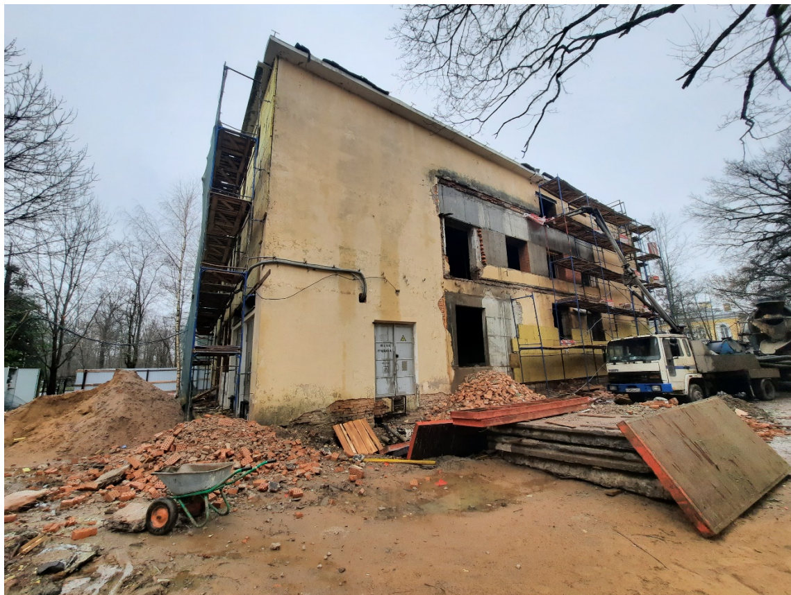
Фото 3. Место предполагаемого устройства временной переходной галереи
