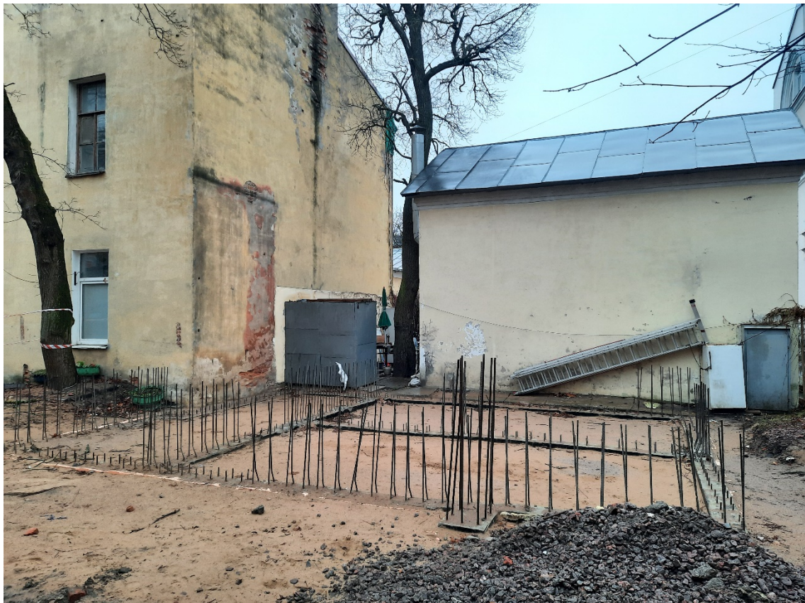
Фото 2. Реконструируемое здание по адресу: г. Санкт-Петербург, город Петергоф, улица Аврова, дом 5, литера Б
