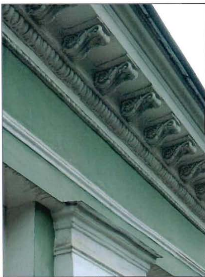
6. Западный фасад. Фрагмент. Венчающий карниз.
