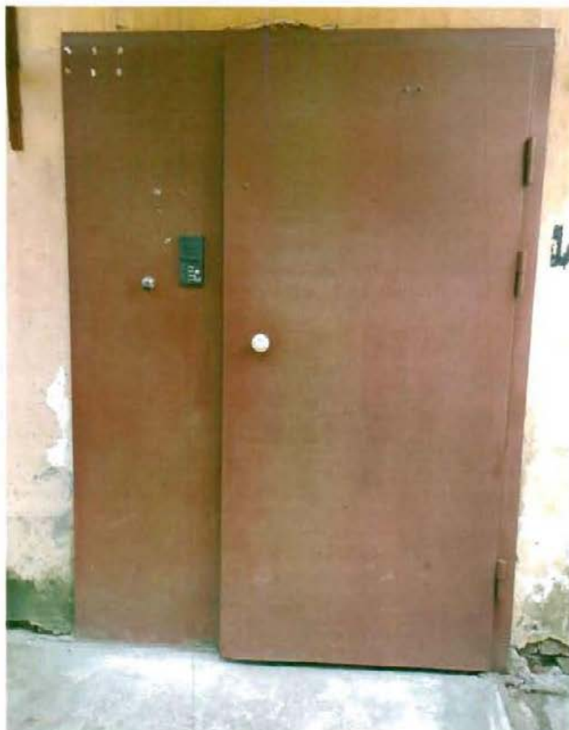
16. Дверное заполнение западного фасада.
