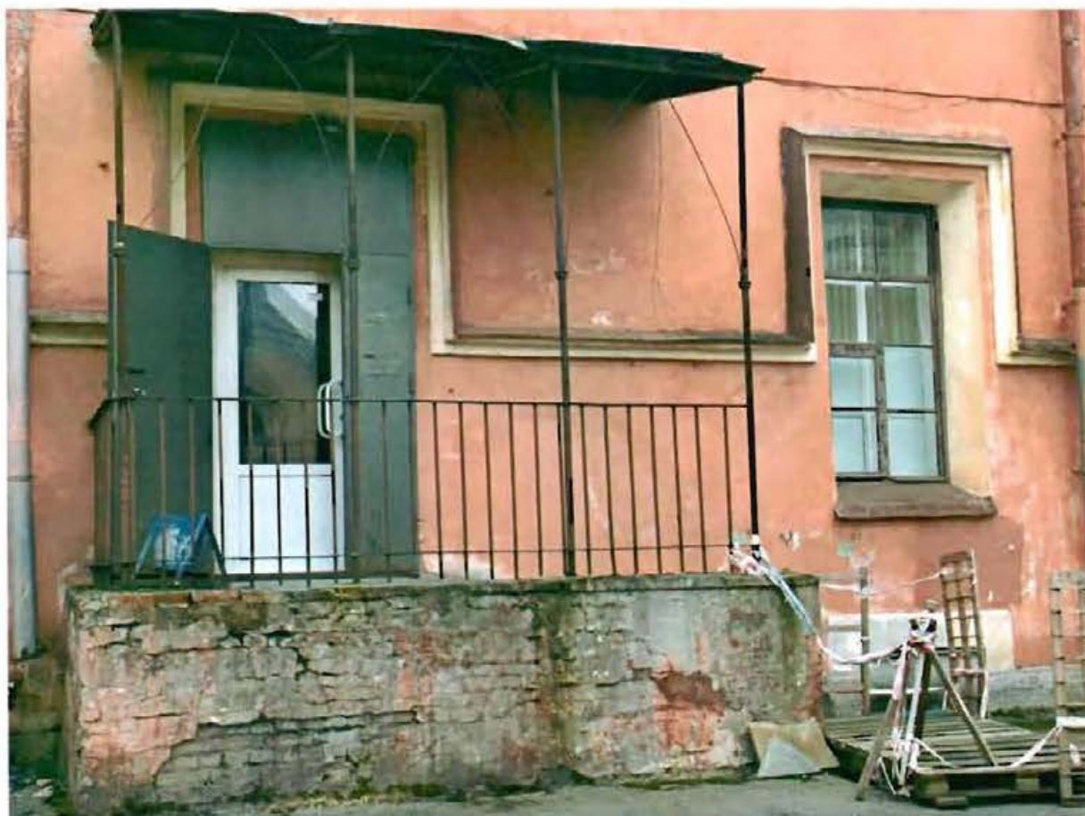
4. Крыльцо дворового фасада.
