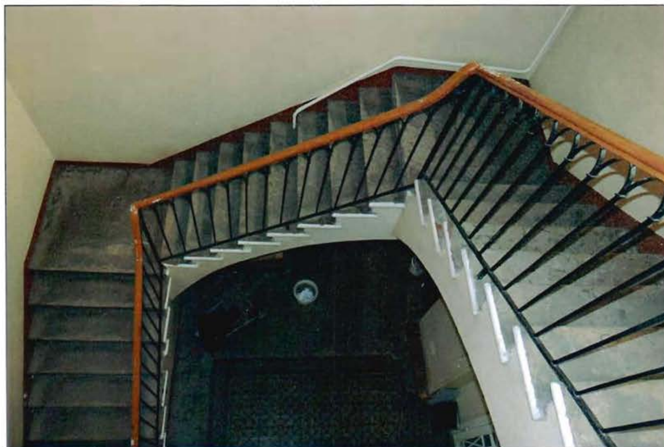
8. Интерьер. Фрагмент. Главная лестница.
