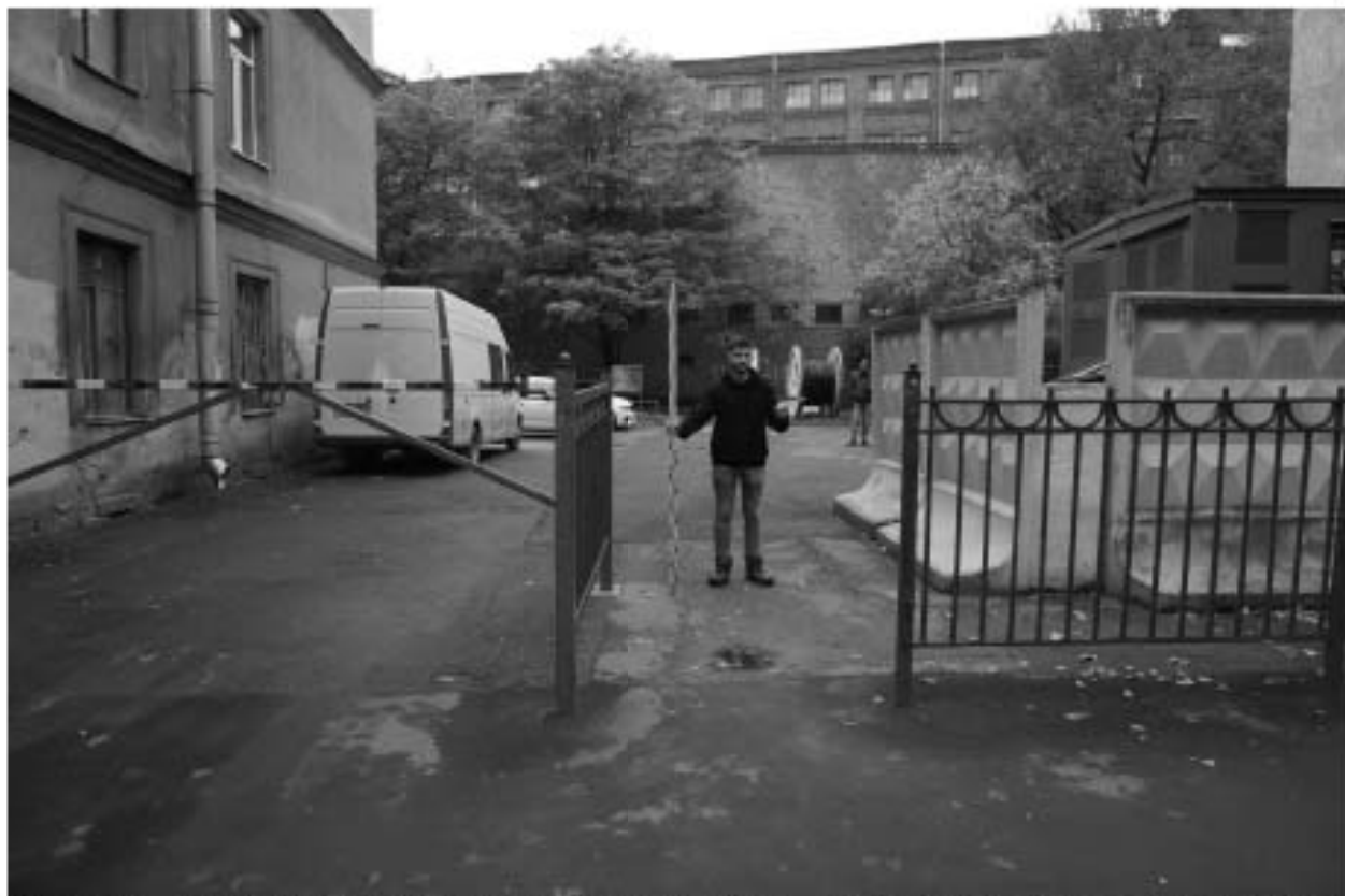
Рис 9. ОАН «Провиантская улица (Мытный переулок) 1. Участок культурного слоя окрестностей Мытного двора города Санкт-Петербурга XVIII-XX вв.». Общий вид территории. Вид с востока
