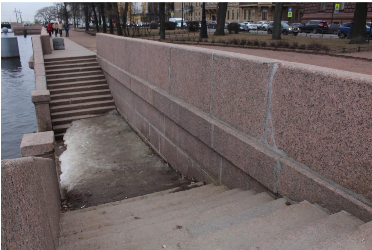
Фото 3. Вид на нижнюю площадку спуска № 2 с юго-запада.
