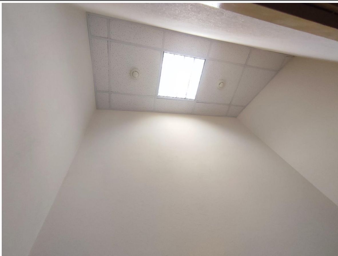
16. Фрагмент пом. 15-Н (3) в уровне 2-го этажа.
