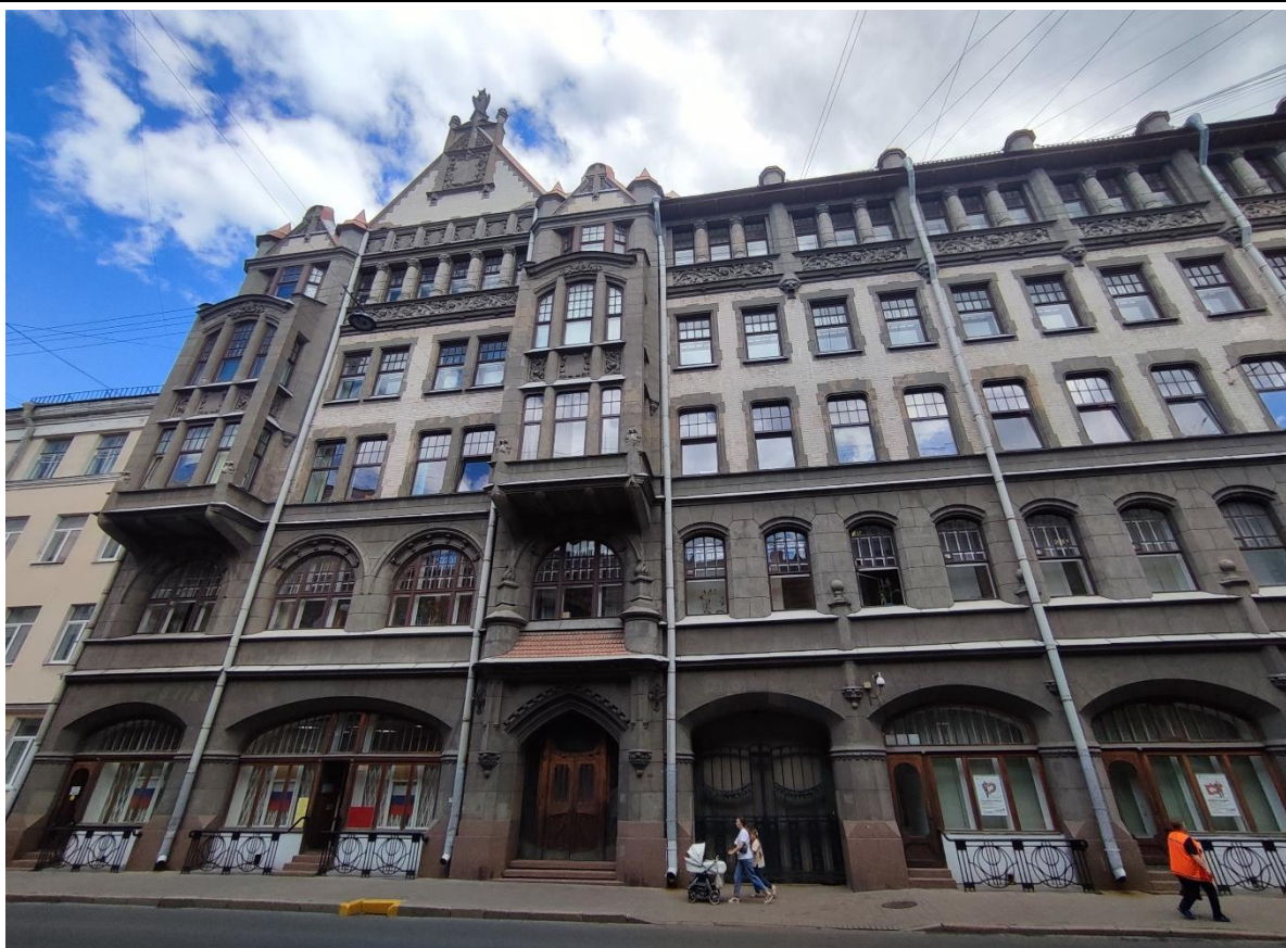
6. Фрагмент западного лицевого фасада объекта культурного наследия федерального значения «Дом городских учреждений».
