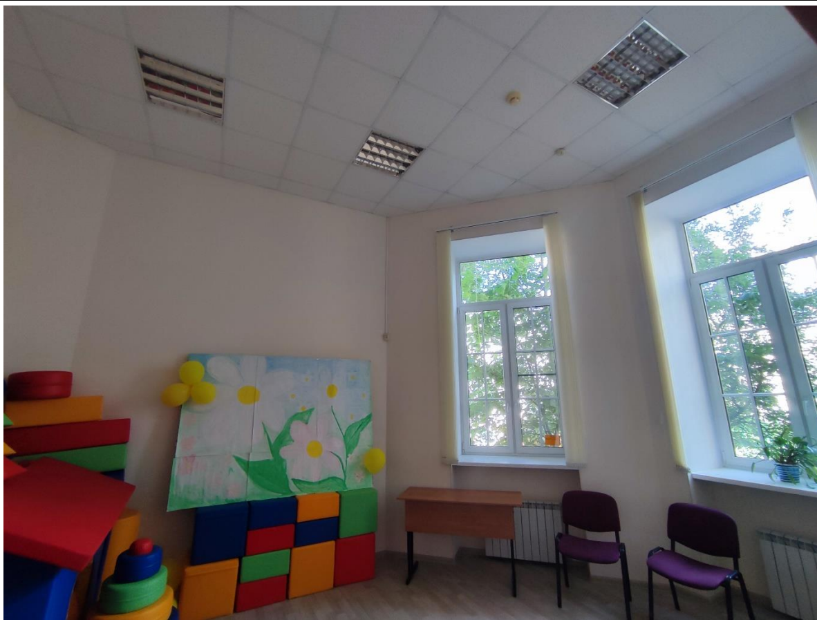
15. Общий вид пом. 15-Н (4) в уровне 2-го этажа.
