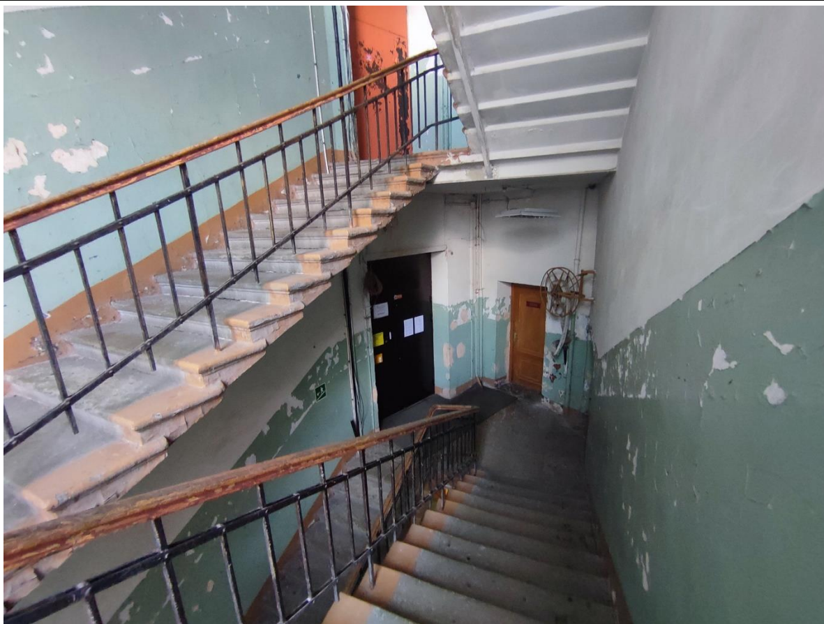
9. Общий вид лестничной клетки 4ЛК с площадки между 2-м и 3-м этажами.
