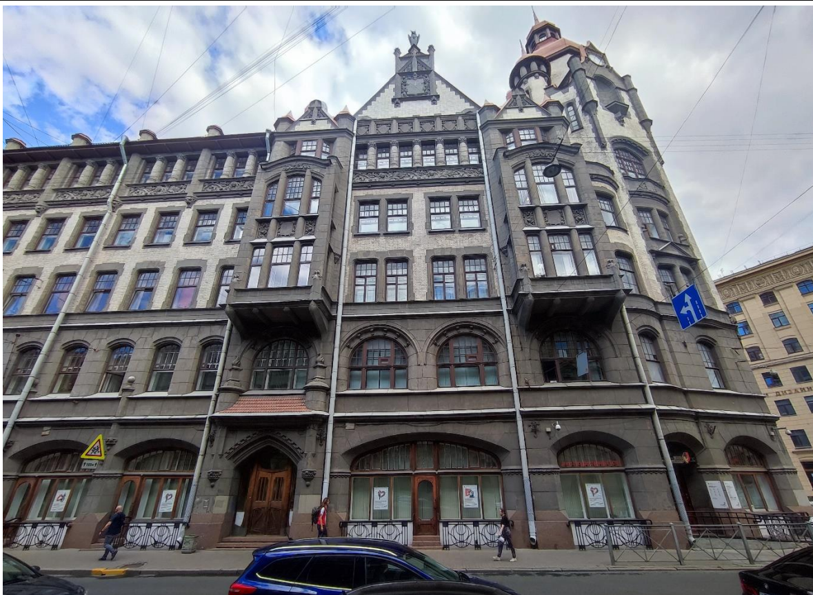
5. Фрагмент западного лицевого фасада объекта культурного наследия федерального значения «Дом городских учреждений».
