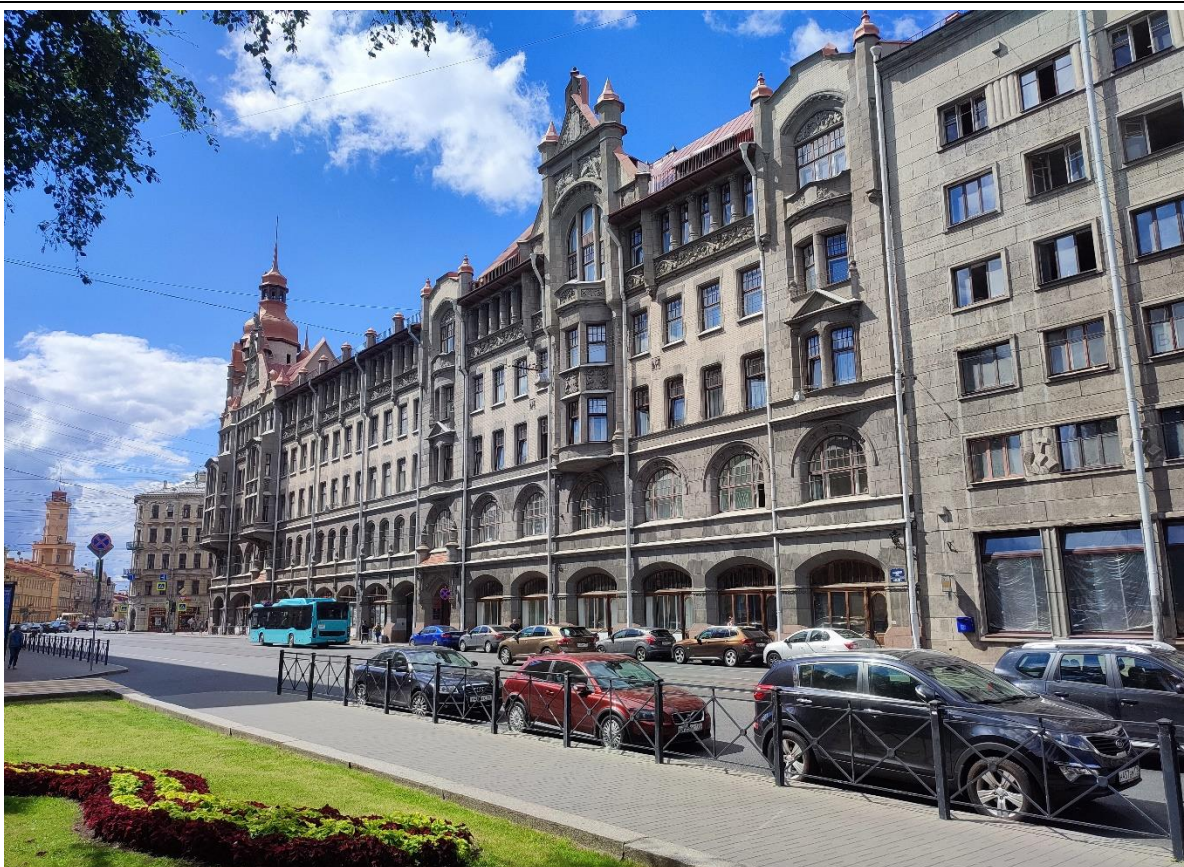
1. Общий вид объекта культурного наследия федерального значения «Дом городских учреждений» в перспективе Садовой улицы.
