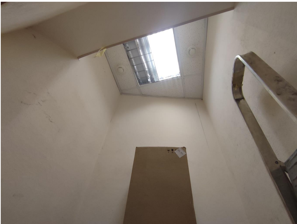
12. Фрагмент пом. 15-Н (2) в уровне 2-го этажа.
