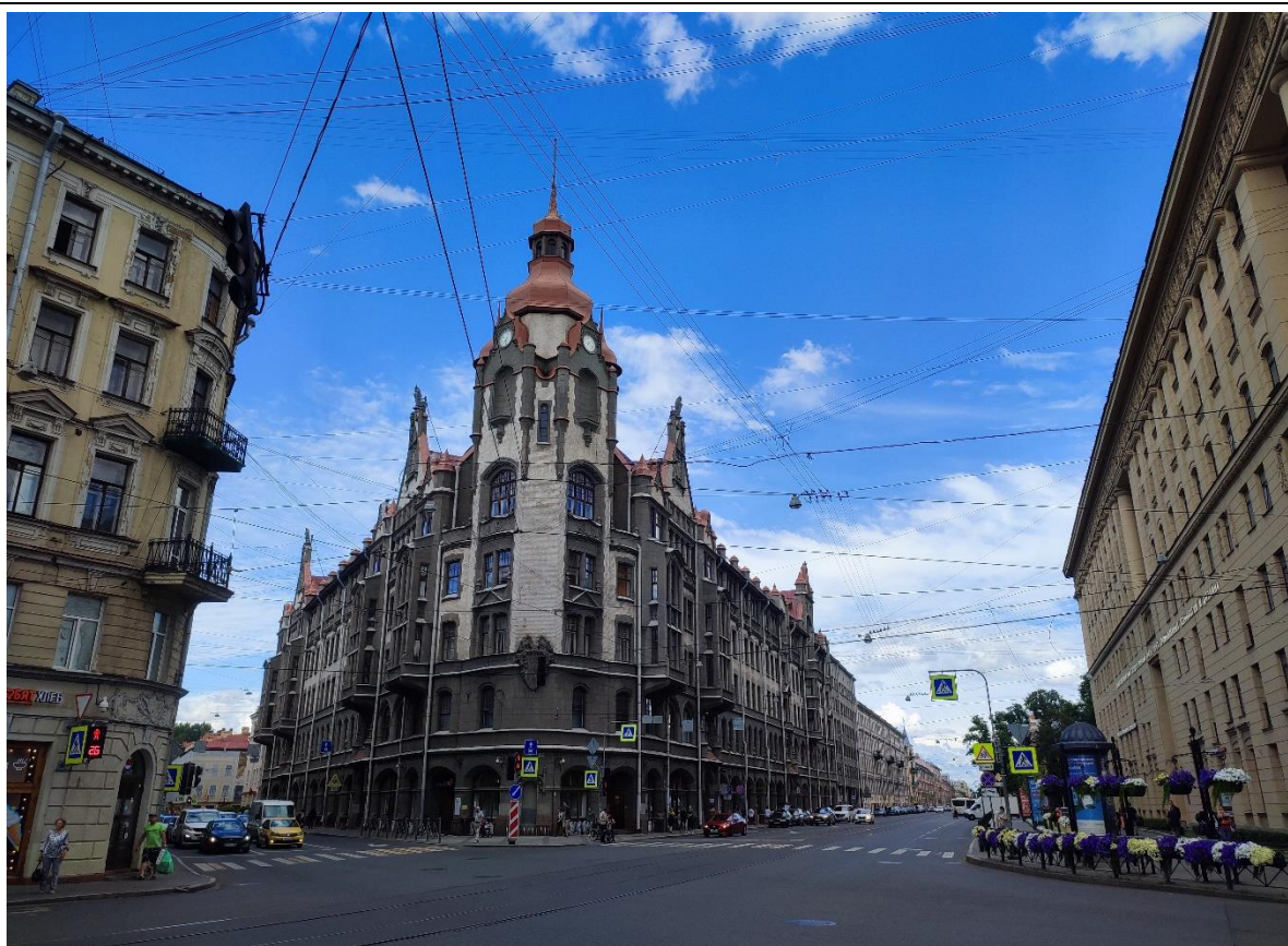
4. Общий вид объекта культурного наследия федерального значения «Дом городских учреждений» от пересечения Садовой улицы и Вознесенского проспекта.
