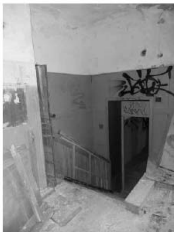
Фото 23. Юго-восточное помещение с лестницей на третий этаж.
