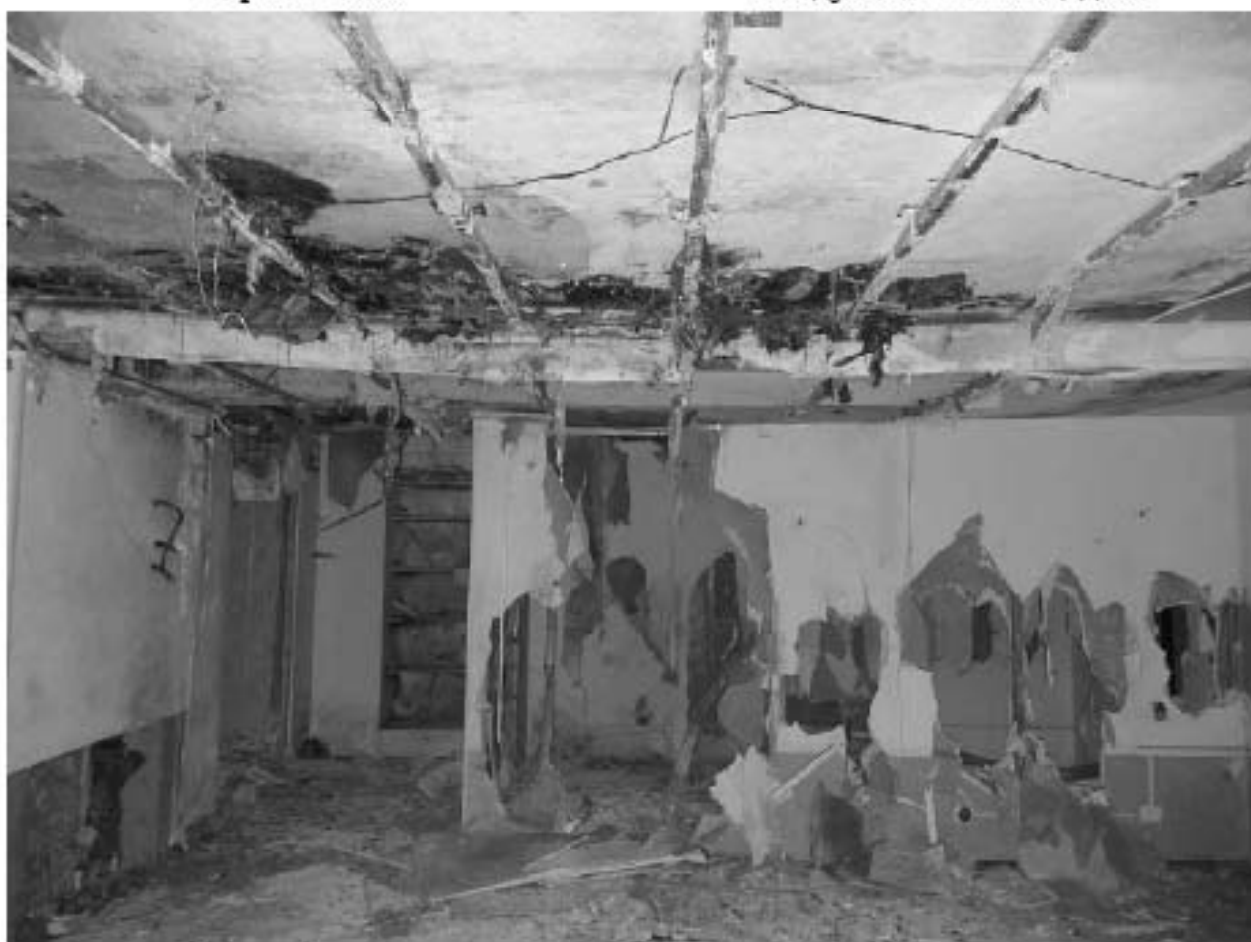
Фото 13. Помещение 1, южного корпуса.
