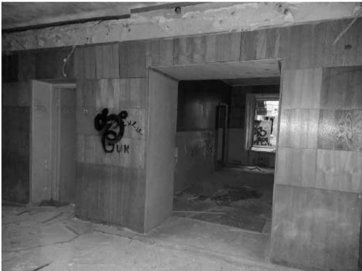
Фото 22. Проемы в помещении 10.
