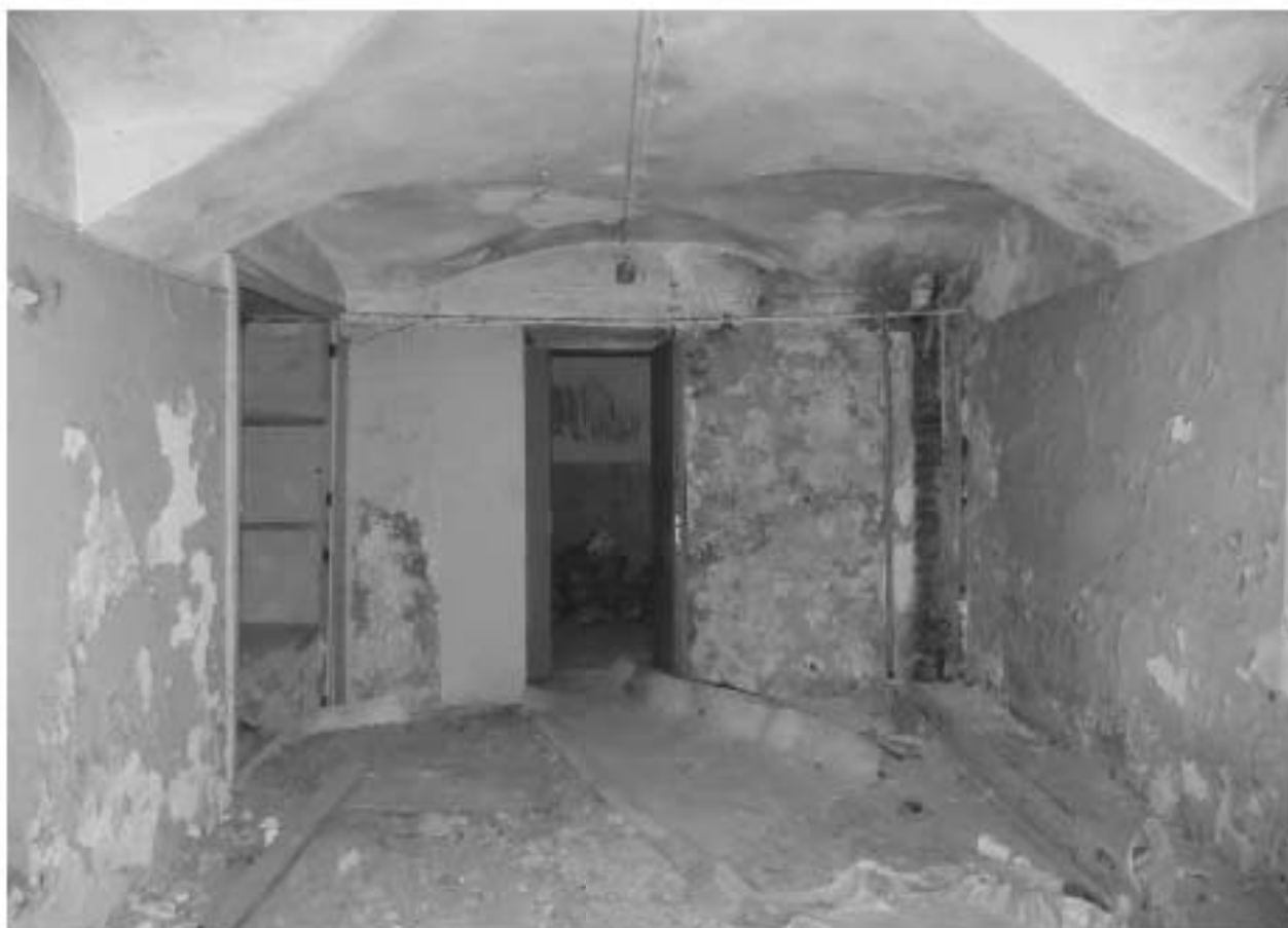
Фото 12. Помещение 5, по дворовому фасаду.
