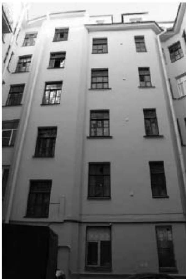
Фото 6. Фасад восточного дворового корпуса.
