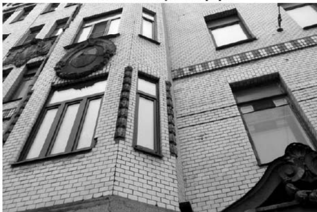
Фото 7. Фрагмент южного фасада.
