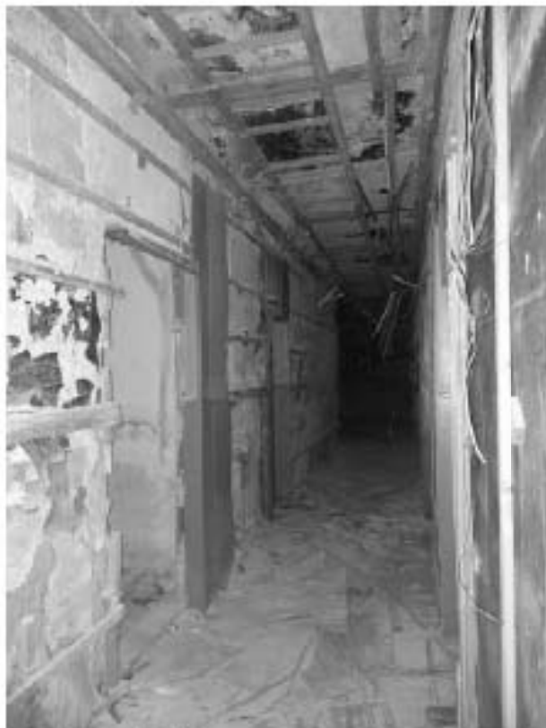
Фото 29. Коридор центрального корпуса.
