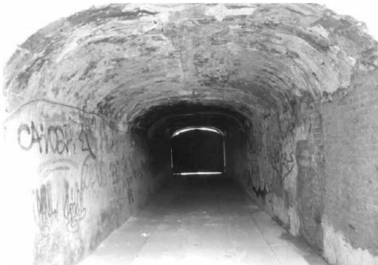
Фото 6. Проездная арка, вид со двора.
