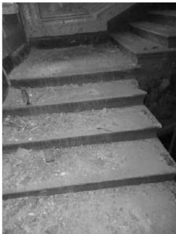
Фото 53. Лестничные марши северной лестницы.
