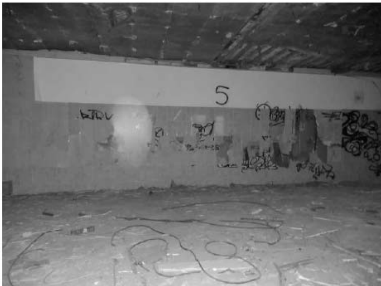
Фото 17. Помещение первого этажа восточного корпуса второго двора.
