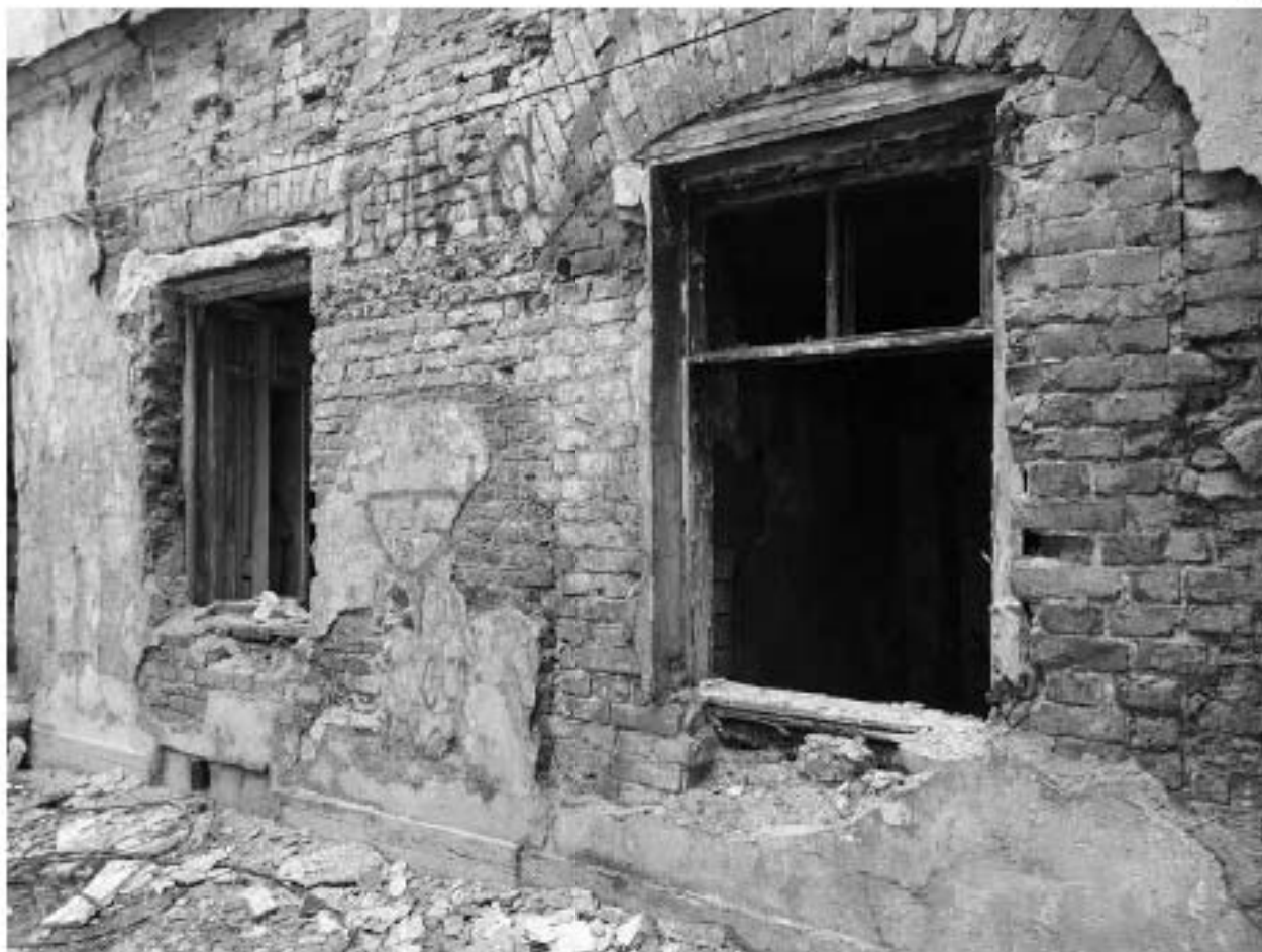
Фото 8. Проемы первого этажа.
