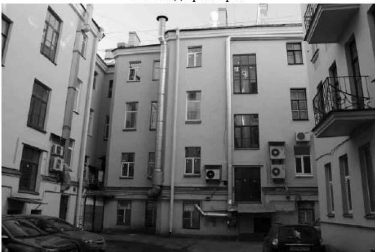
Фото 11. Общий вид северного двора.
