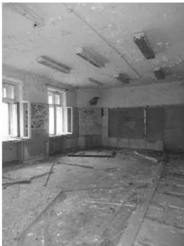
Фото 52. Помещение северное (6 этаж).
