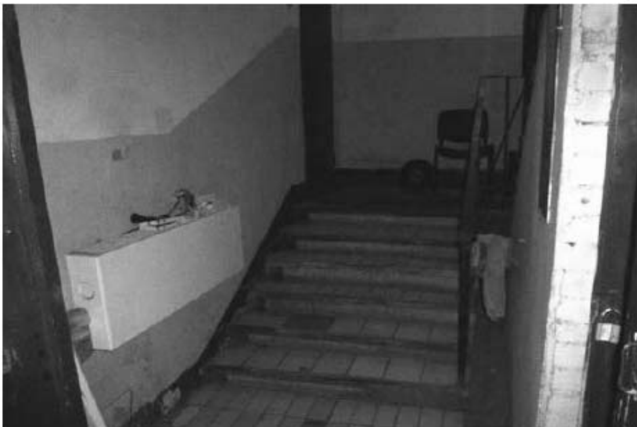
Фото 16. Вход в 5ЛК.
