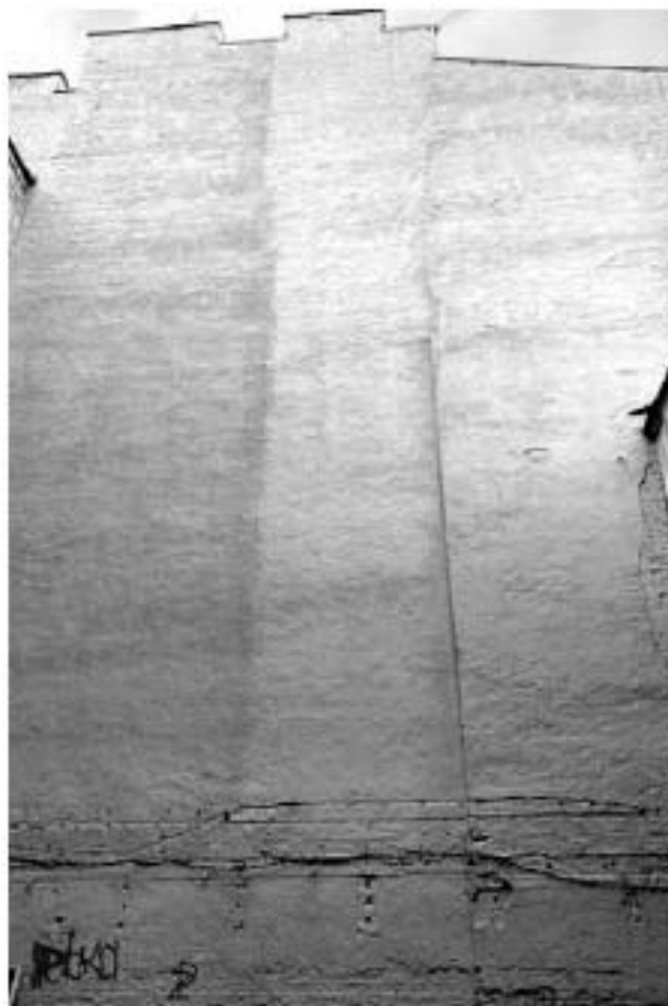
Фото 14. Фасад со стоны востока, северо-восточный корпус.
