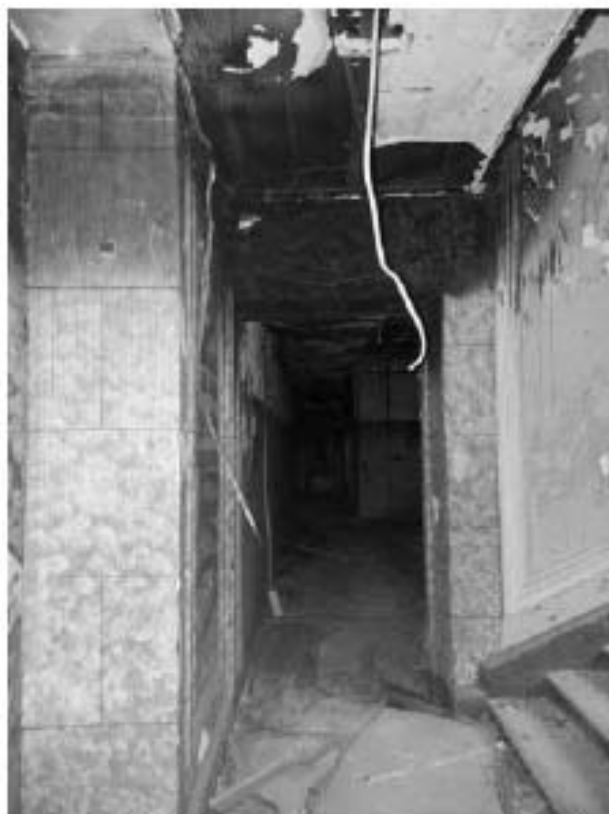
Фото 47. Северная лестница, пятый этаж.
