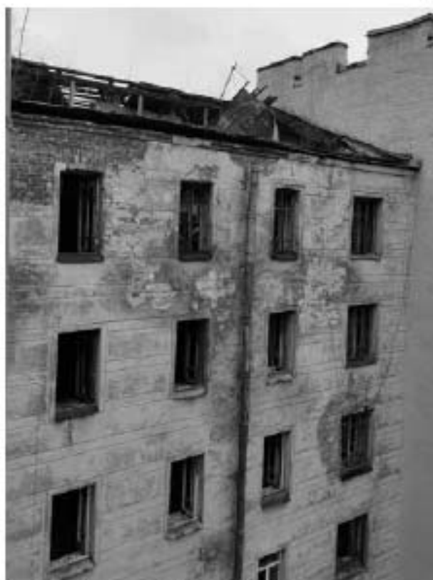
Фото 9. Общий вид сверху центрального корпуса.
