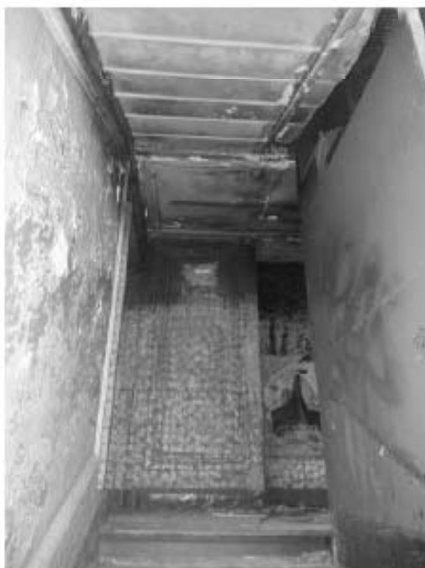
Фото 48. Северная лестница на 5 этаж.
