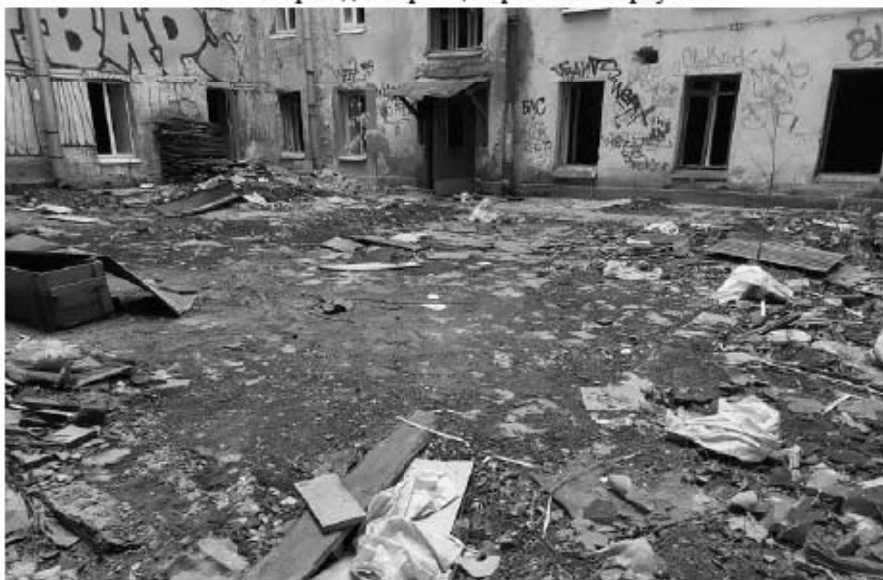
Фото 5. Общий вид второго двора с запада.
