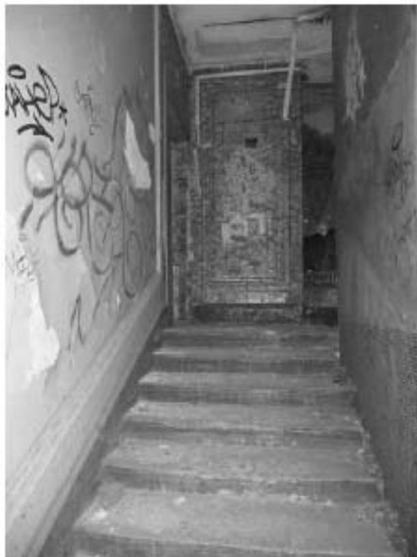
Фото 30. Лестница северная, марш на второй этаж.
