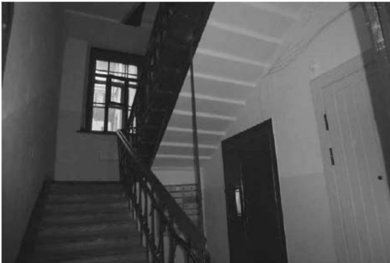
Фото 18. Общий вид 4ЛК.
