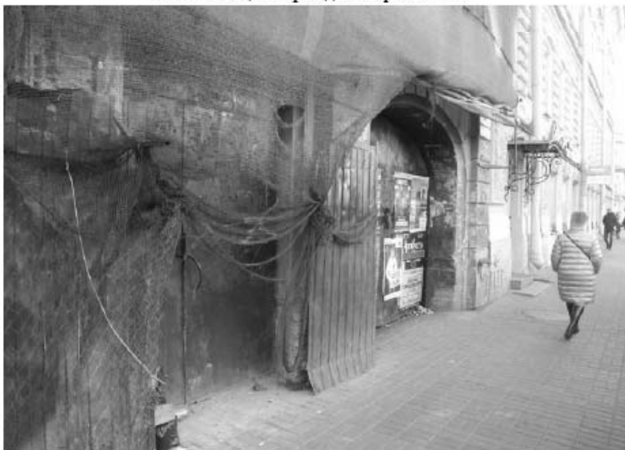
Фото 5. Фрагмент фасада вид на западную часть.
