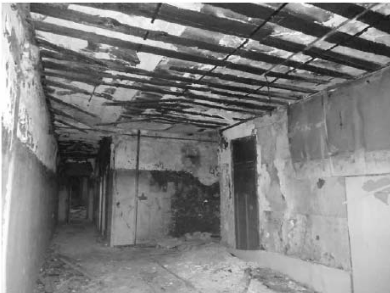
Фото 50. Помещение центрального корпуса.
