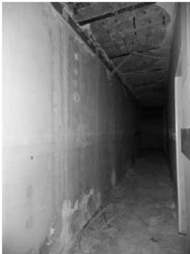
Фото 39. Коридор четвертого этажа.
