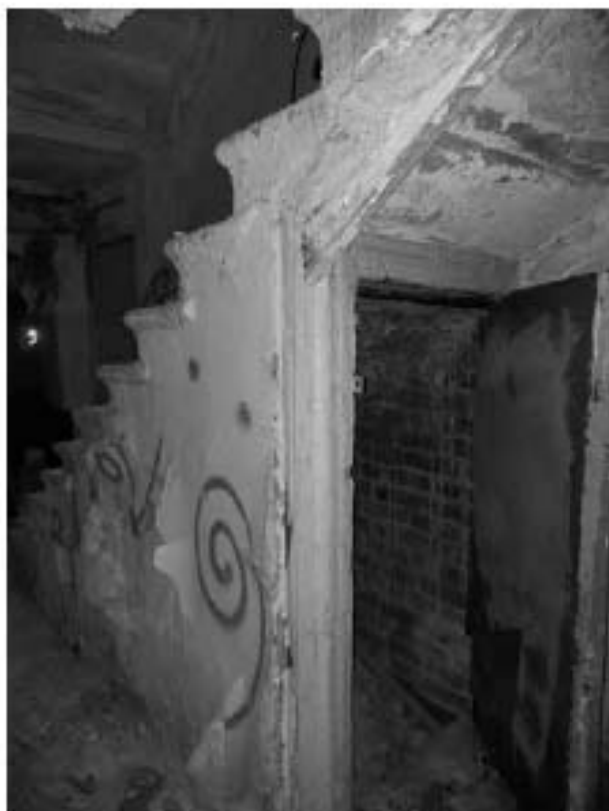
Фото 11. Лестница южного корпуса, первый этаж.
