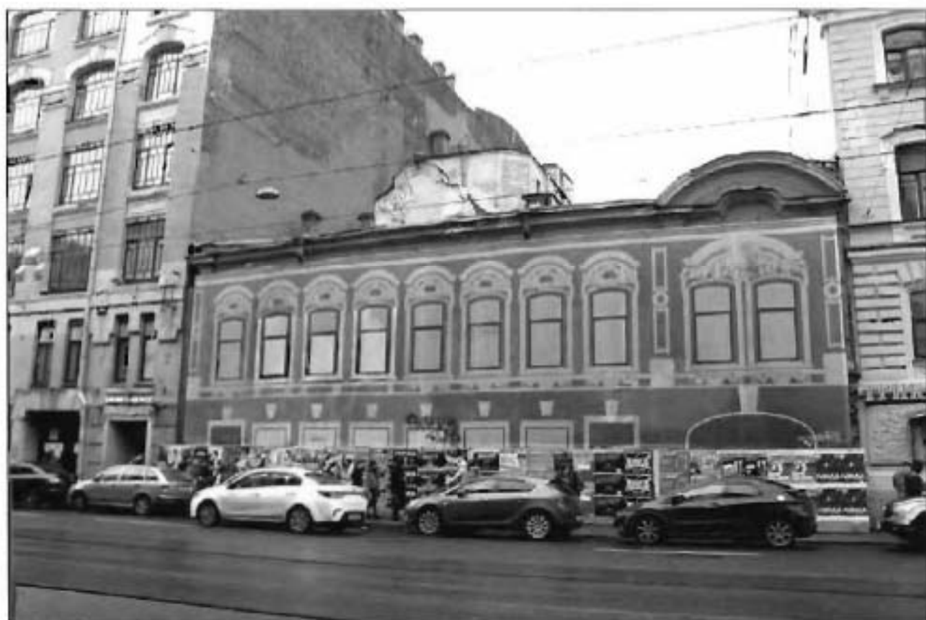
1. Общий вид со стороны лицевого фасада.
