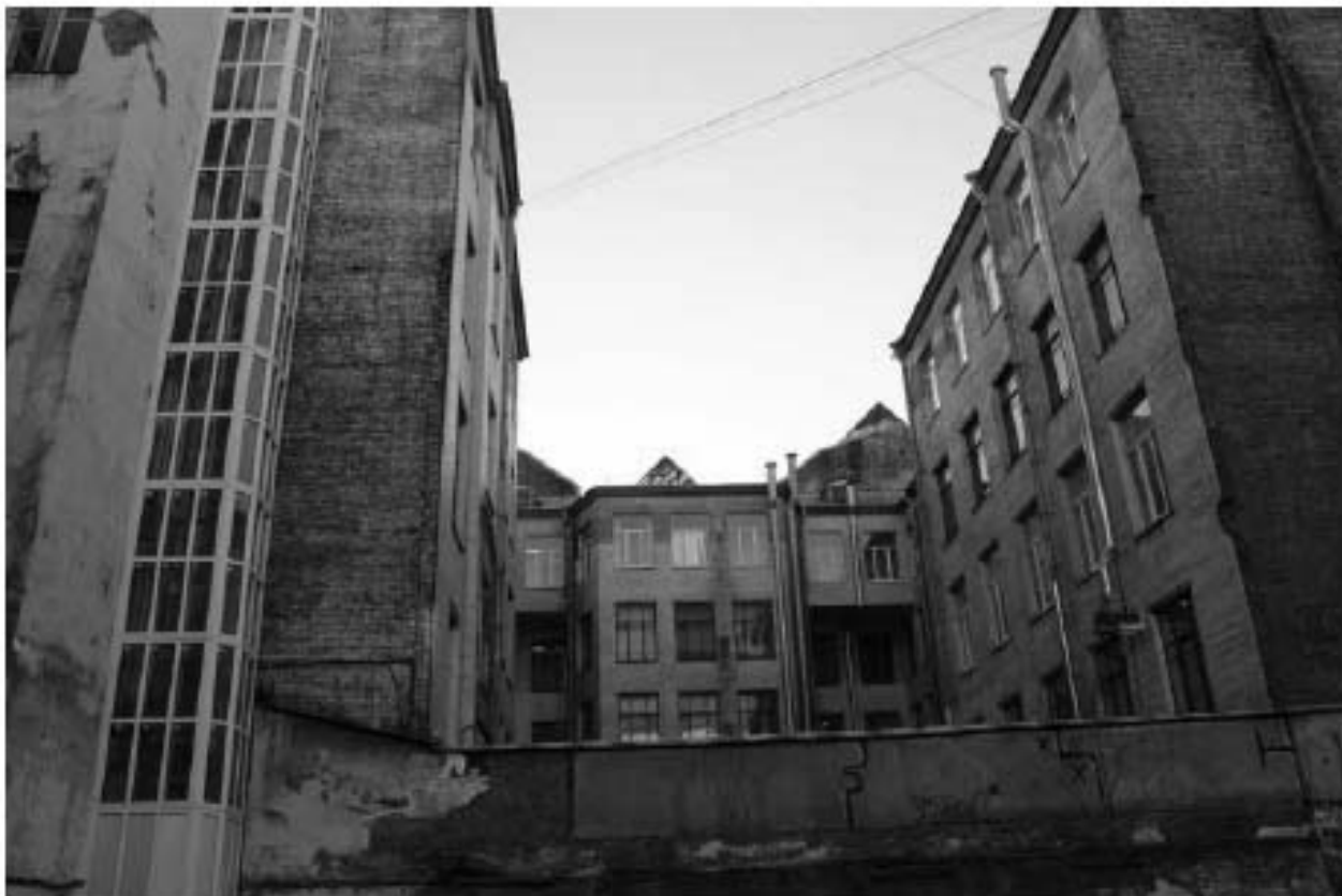
Фото 8. Общий вид дворовой части здания.
