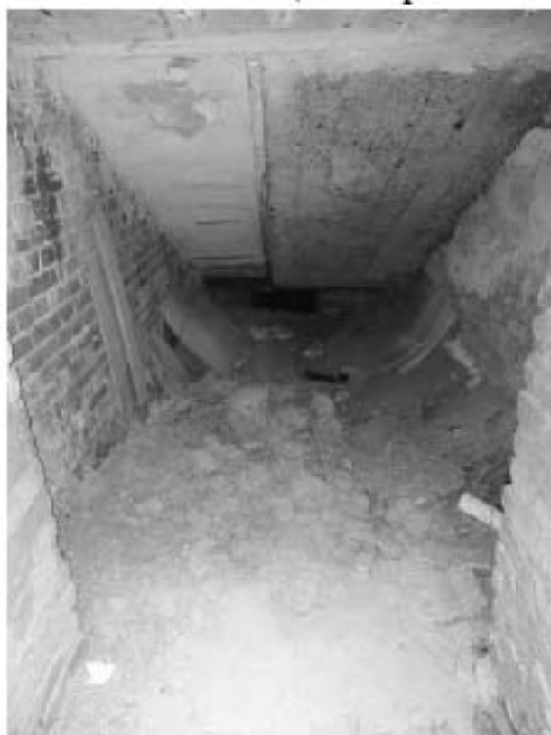
Фото 18. Помещение под лестницей центрального корпуса.
