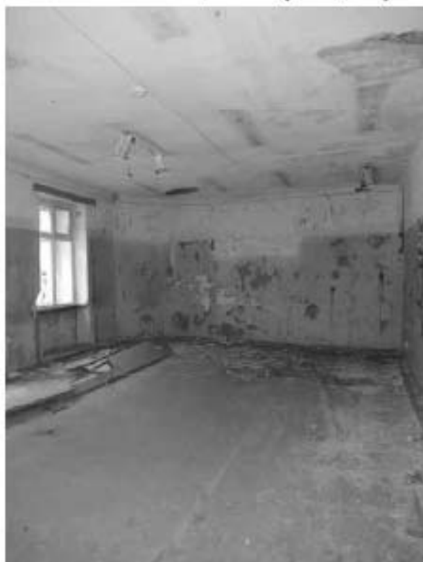
Фото 42. Помещение 1 (северная часть).
