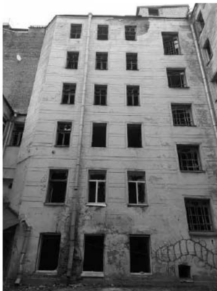
Фото 1. Общий вид западной части корпуса А3.
