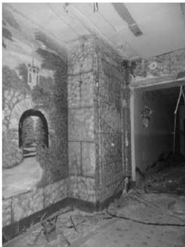
Фото 36. Площадка третьего этажа северной лестницы.
