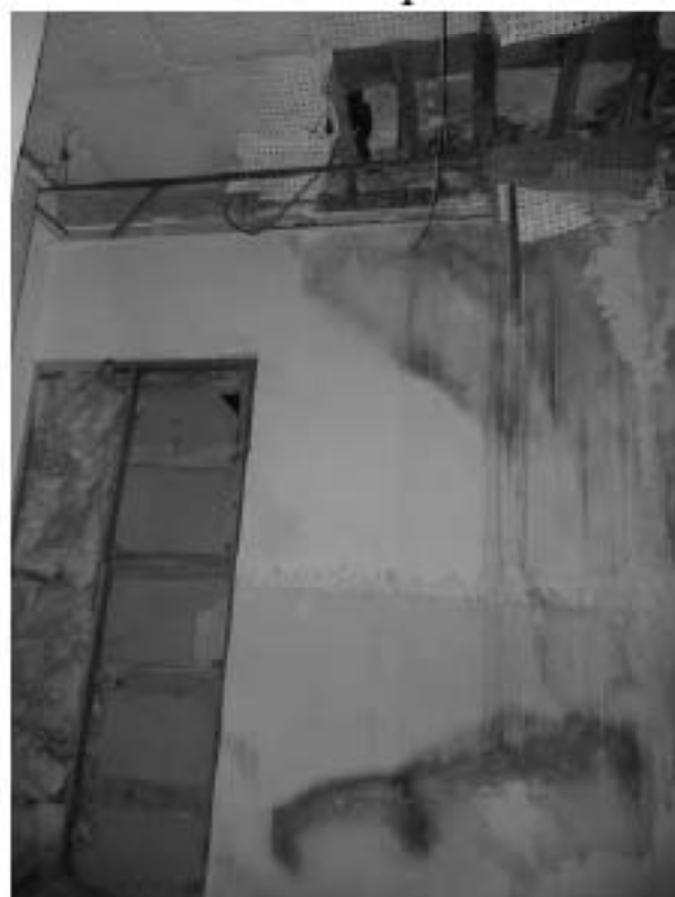
Фото 34. Площадка третьего этажа.
