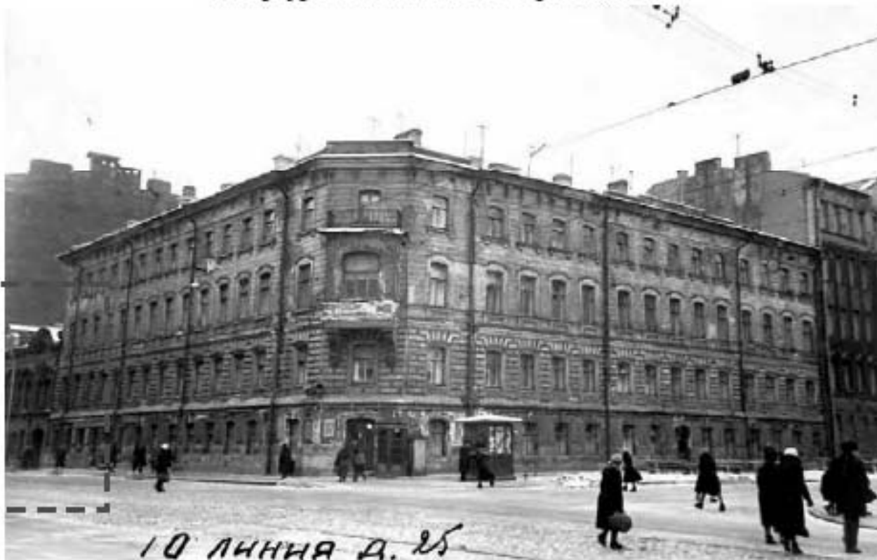
10 линия д. 25 Илл. 7.2. Фрагмент фото 1962-1963 гг. Доходный дом Л.И. Бреше. Из фотоархива Василеостровского района, размещенного Майей Степановой. Источник: https://pastvu.com/p/135697 .
