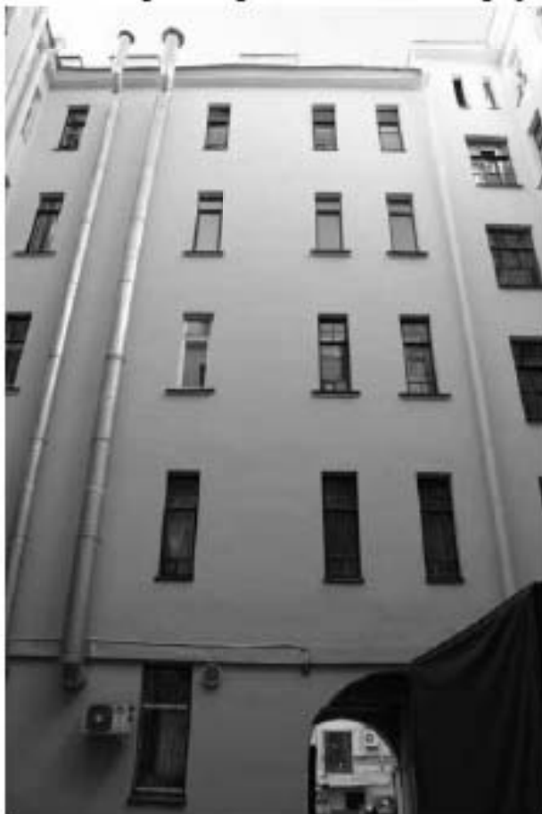
Фото 9. Южный фасад северного дворового корпуса.
