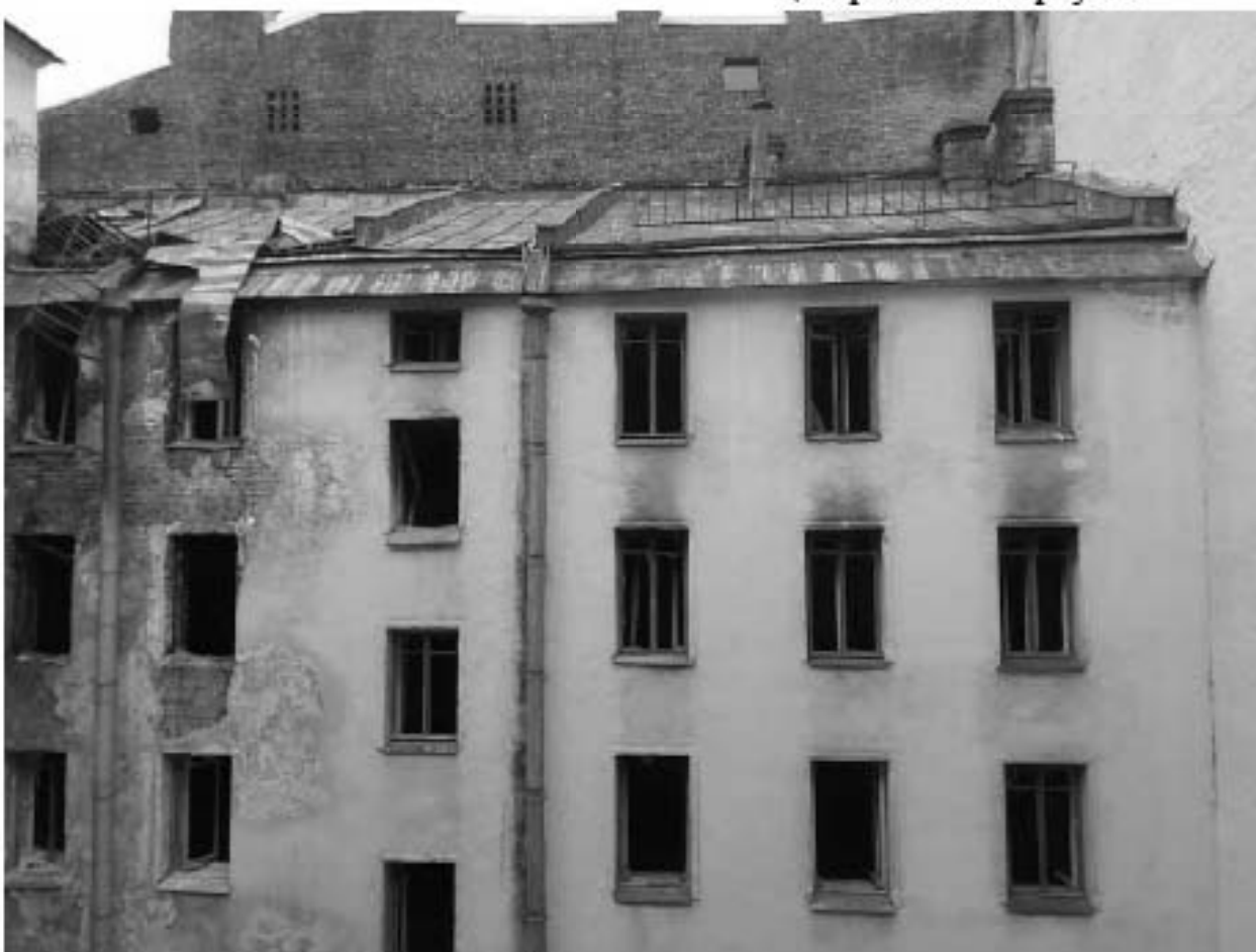
Фото 10. Фасад южного корпуса.
