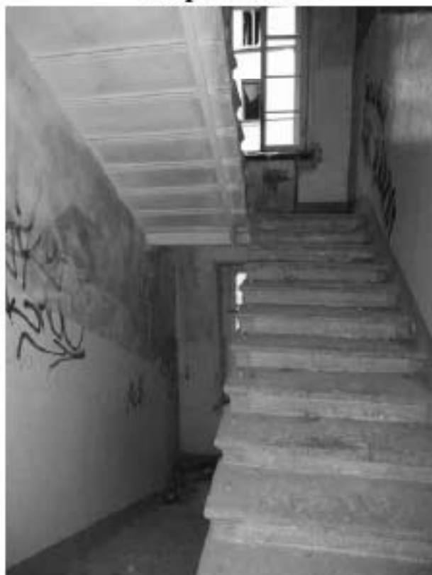
Фото 32. Лестница центрального корпуса со второго этажа.
