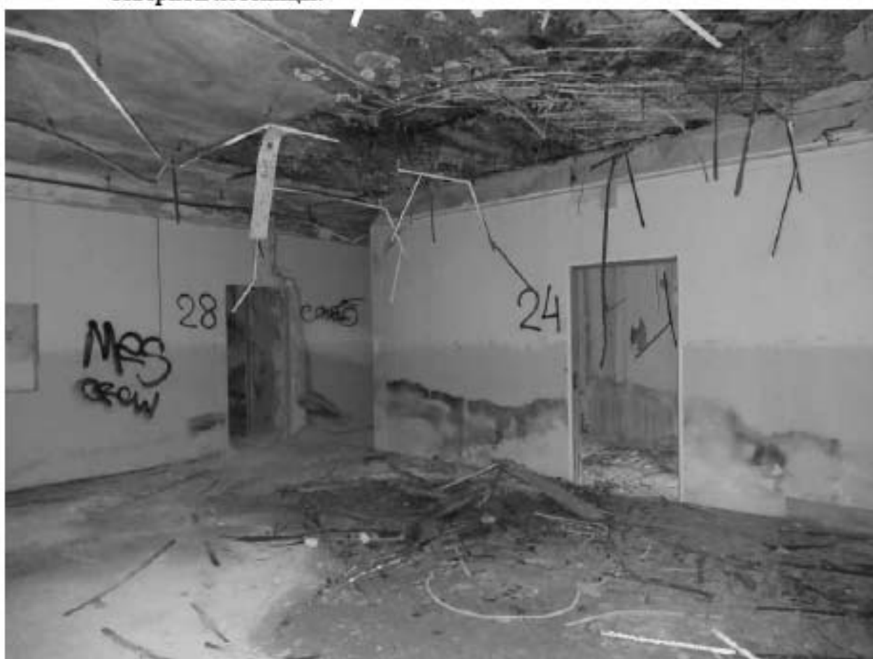
Фото 38. Помещение 1 центрального корпуса.
