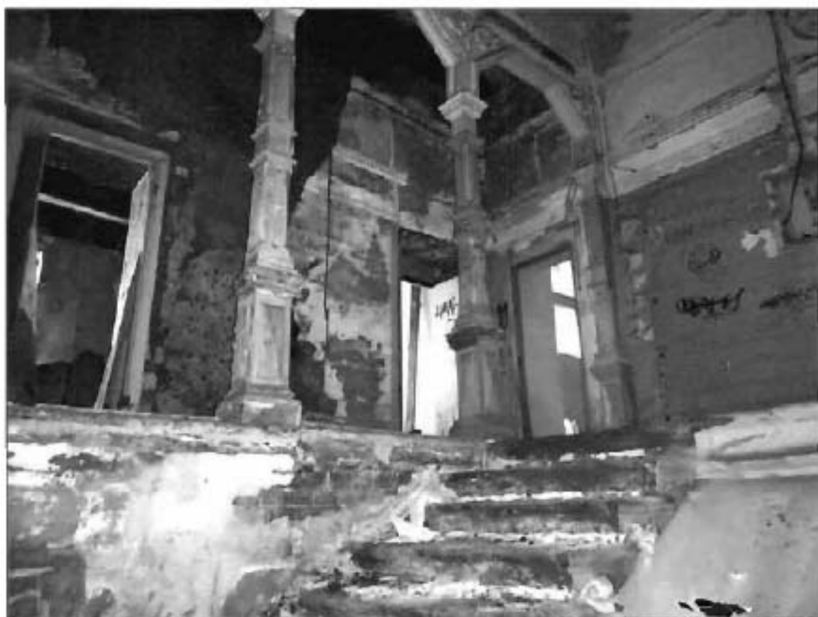
3. Интерьер. Фрагмент. Лестница с арками галереи.
