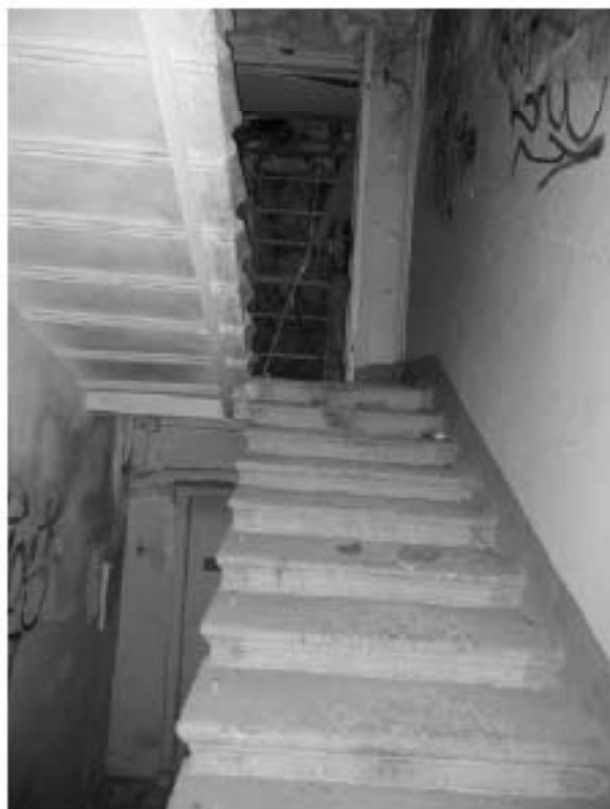
Фото 28. Лестница, вид с междуэтажной площадки.
