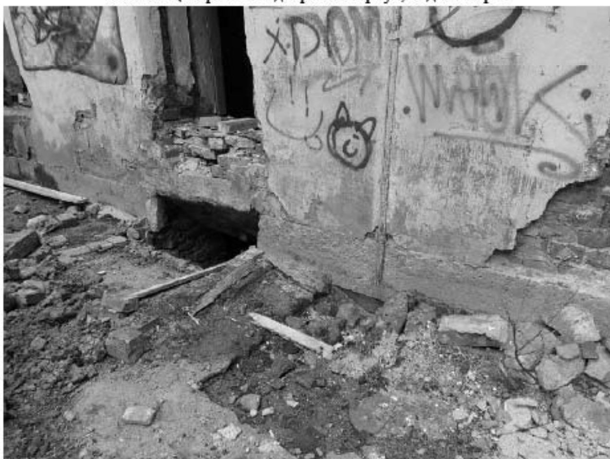
Фото 3. Проем в подвал центрального корпуса.
