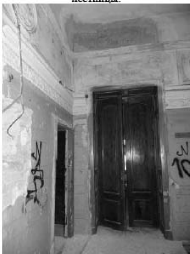
Фото 18. Площадка второго этажа.
