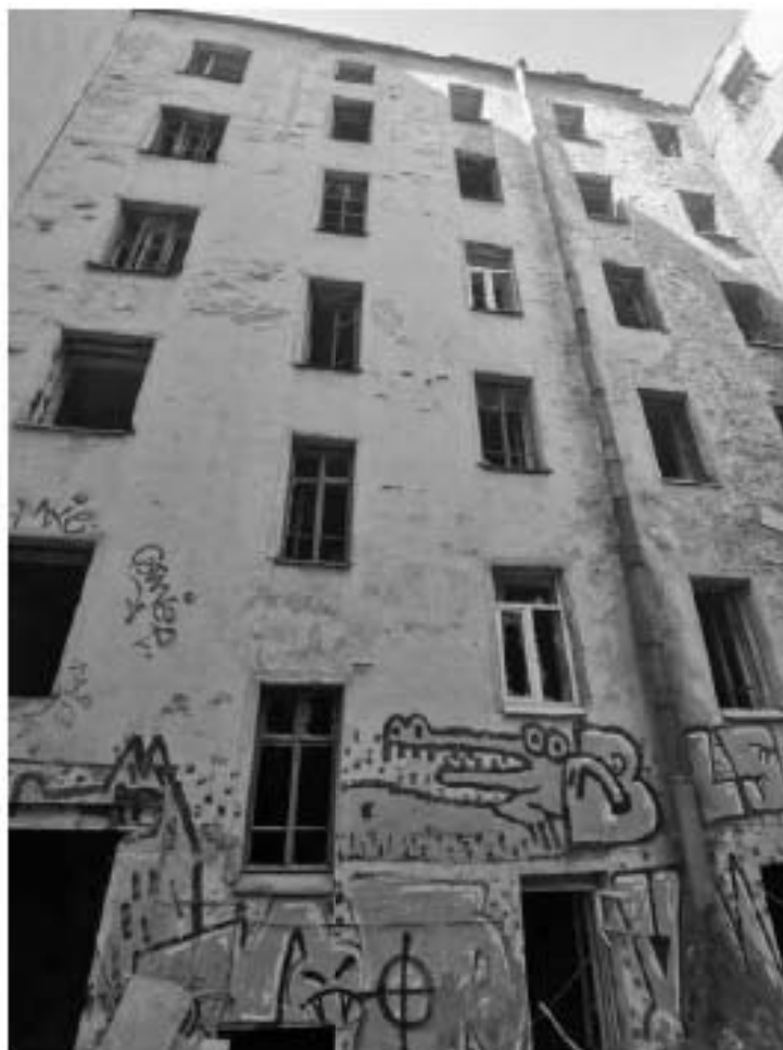
Фото 6. Южный фасад центрального корпуса.
