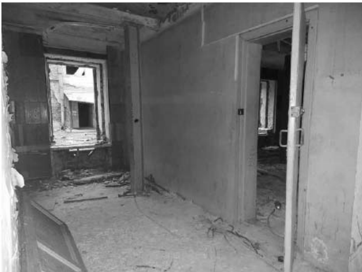
Фото 20. Помещение первого этажа центрального корпуса.
