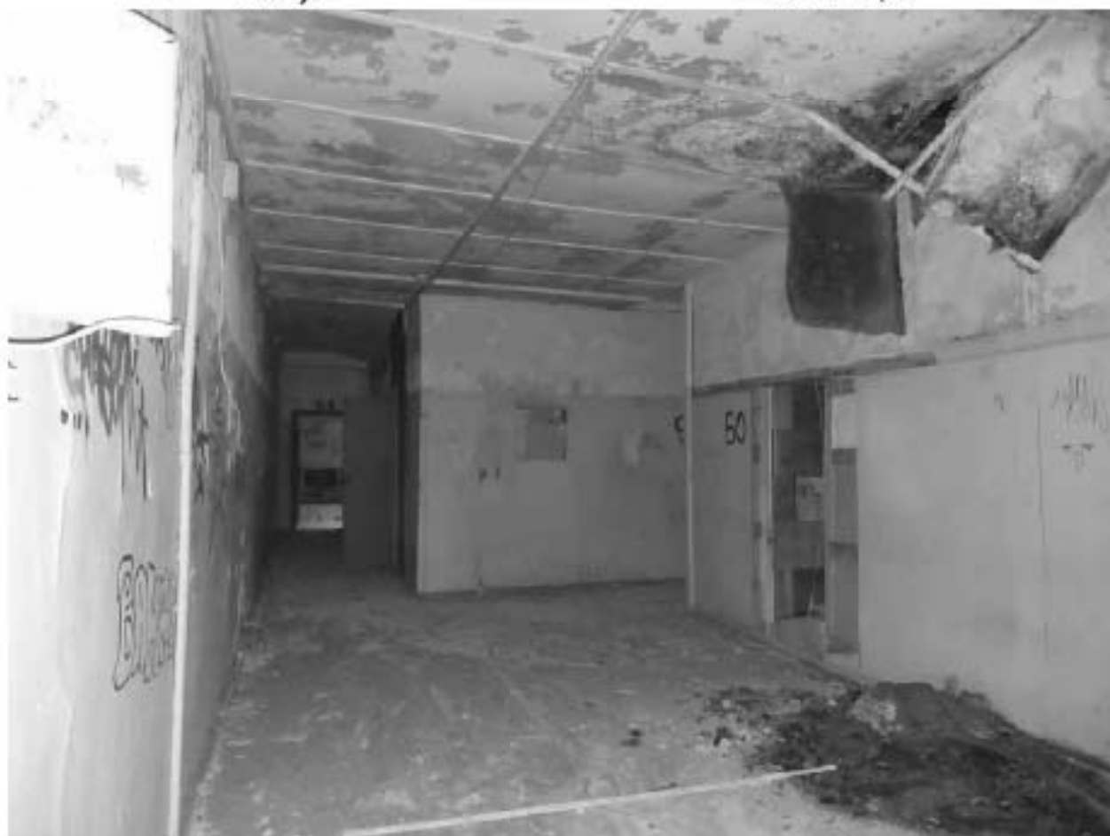
Фото 54. Помещение центрального корпуса на 6 этаже.
