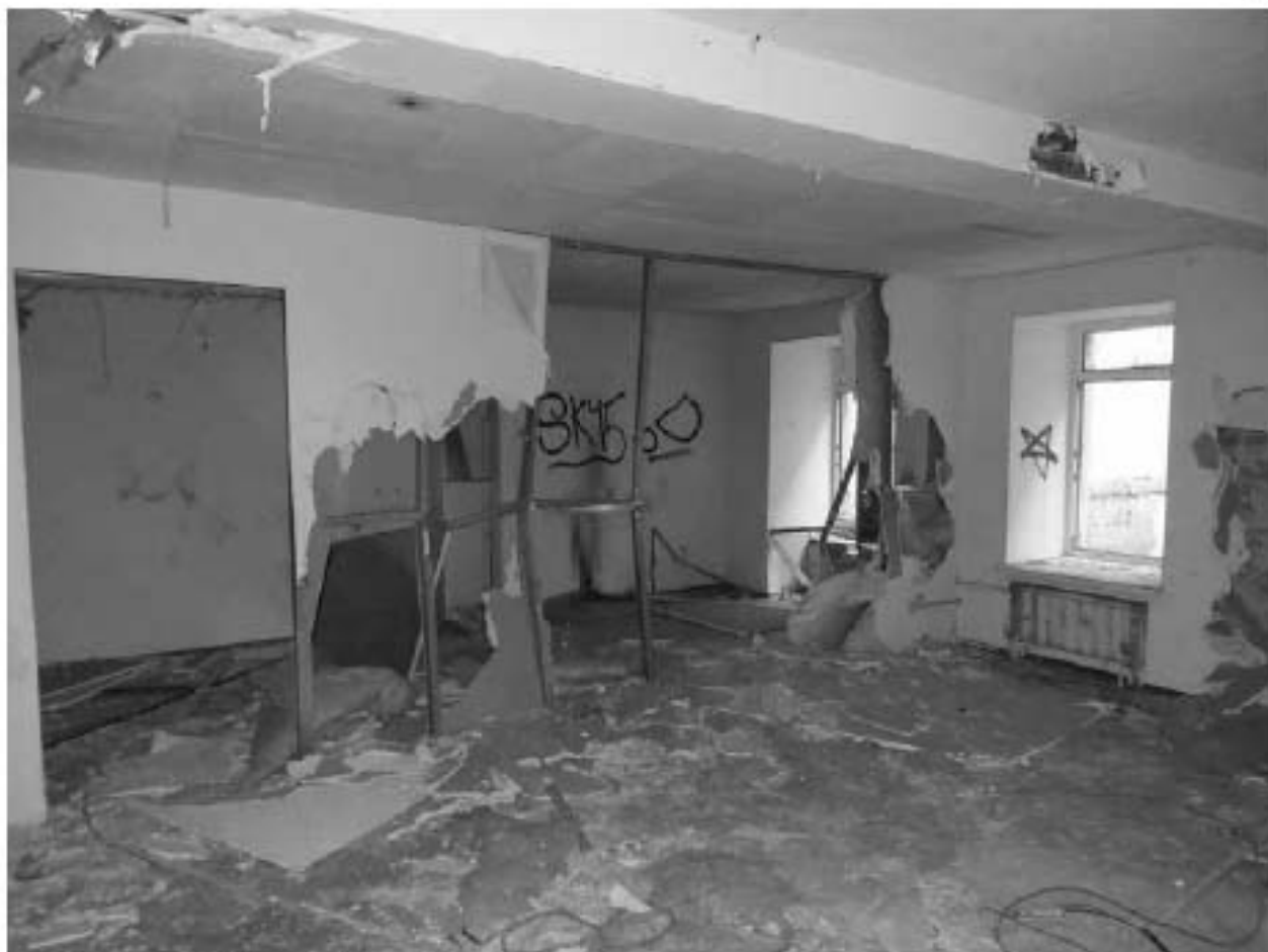
Фото 14 Помещения второго этажа южного корпуса.
