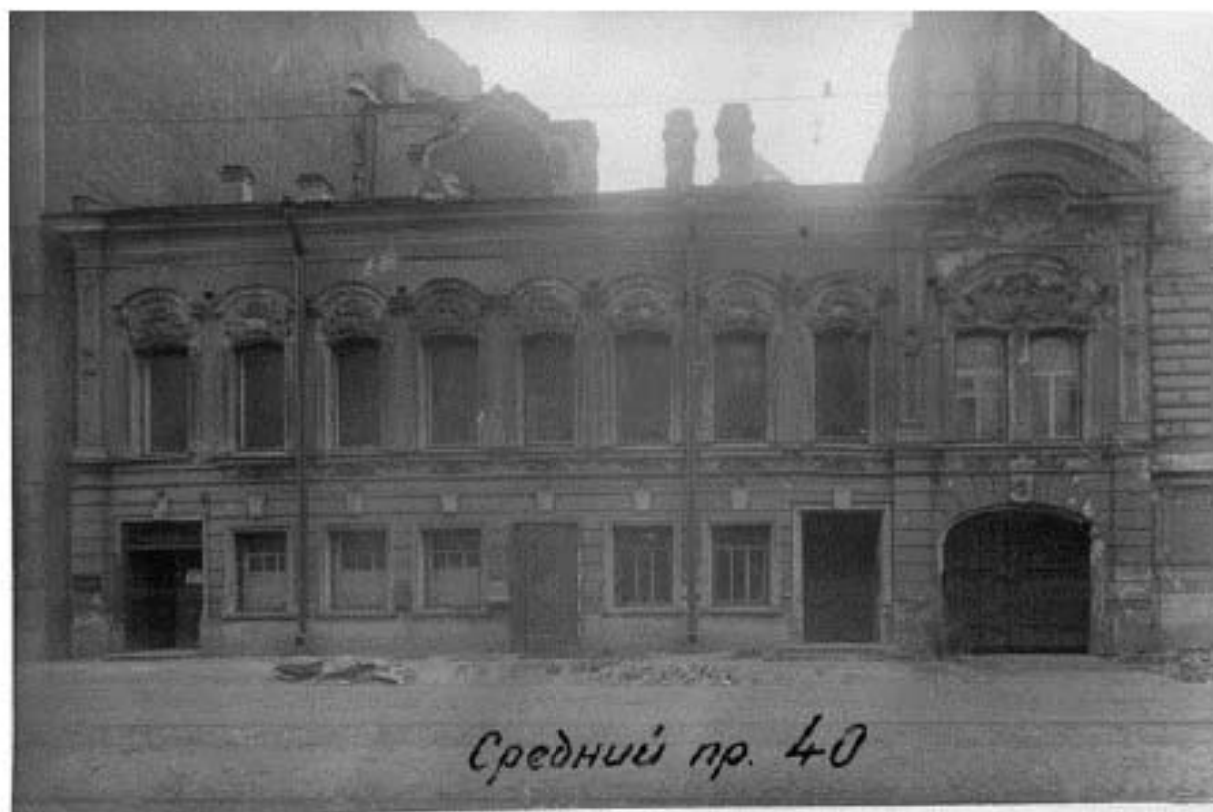
Илл. 2.31. Вид на главный фасад исследуемого дома по адресу: Средний пр. В.О., 40. 1950-1960-х гг. Источник: http://www.citywalls.ru/photo107410.html .
