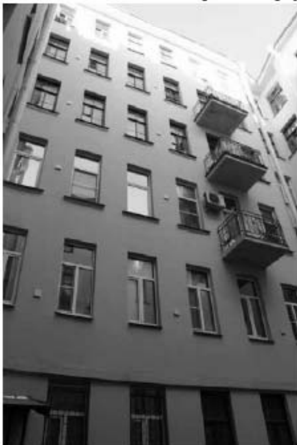
Фото 7. Фасад южного дворового корпуса
