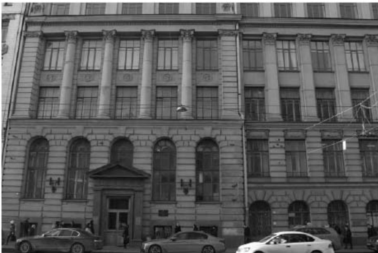
Фото 2. Западная часть лицевого фасада с входом.
