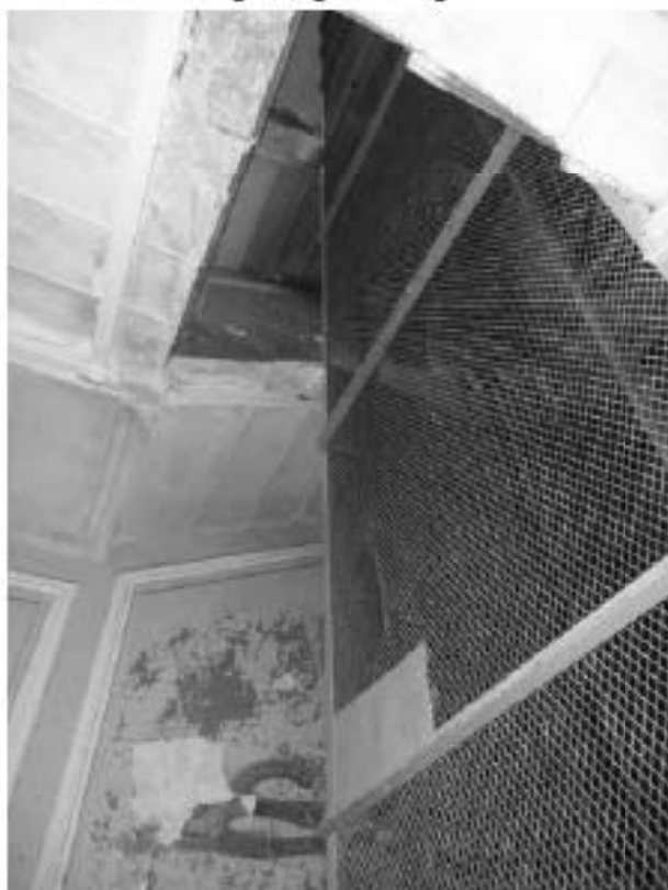
Фото 41. Северная лестничная клетка и лифт.
