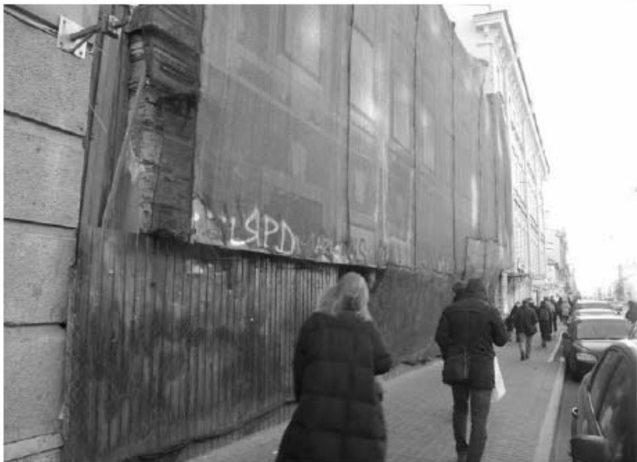
Фото 4. Лицевой фасад с северо-востока.
