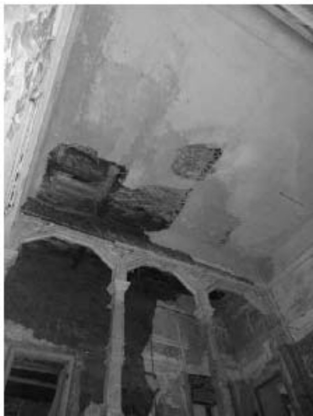
Фото 16. Перекрытие парадной лестницы.
