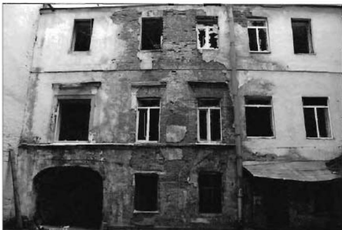
2. Дворовый фасад. Общий вид.
