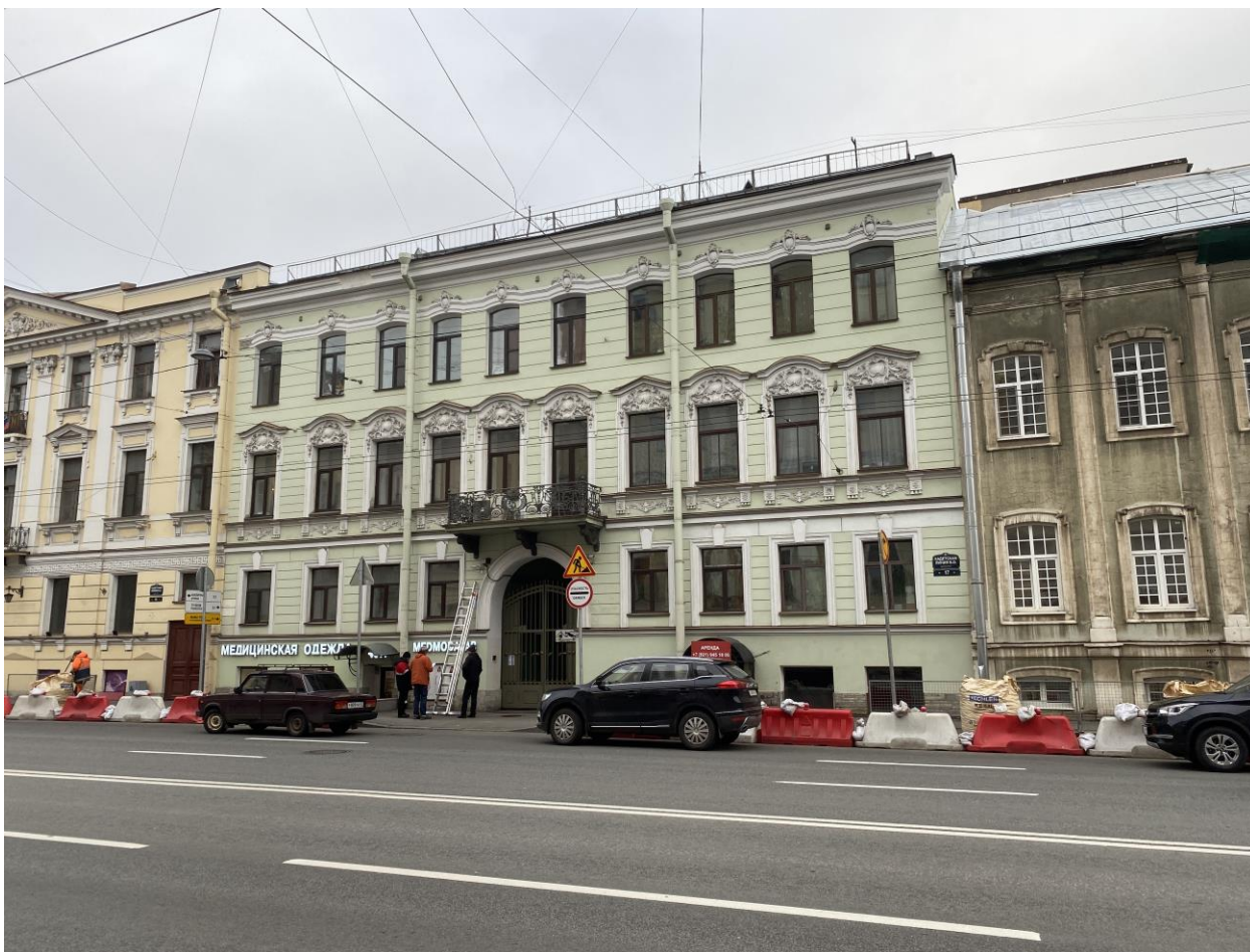
Фото 3. Общий вид объекта культурного наследия в перспективе Съездовской линии. Вид с юго-востока.
