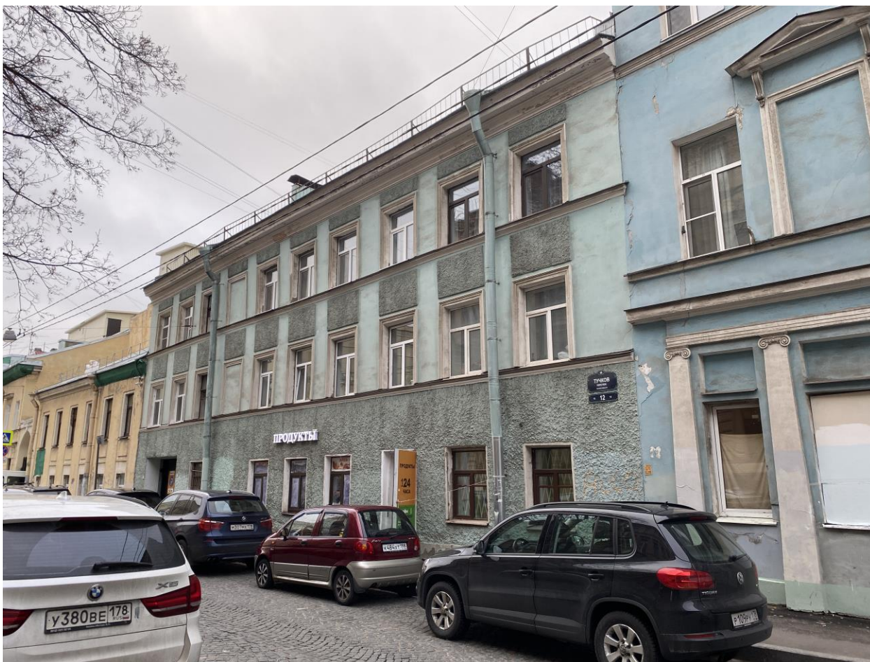
Фото 4. Лицевой фасад объекта культурного наследия по Тучкову переулку. Вид с северо-востока.
