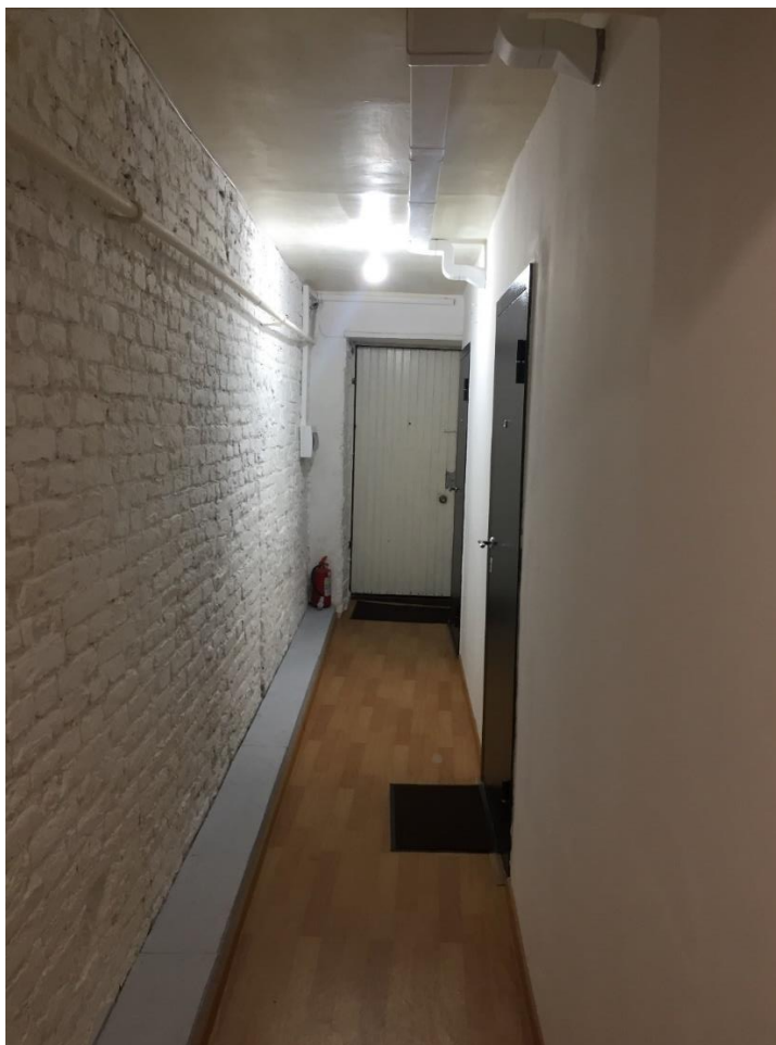
Фото 11. Общий вид коридора (бывшее помещение № 1). Вид с юго-запада.
