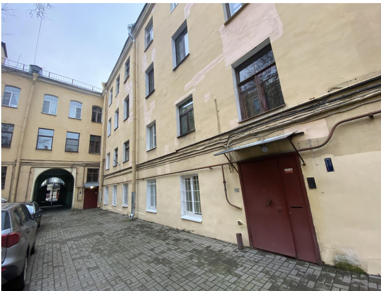
Фото 8. Юго-восточного дворовой фасад. Вид с северо-востока.
