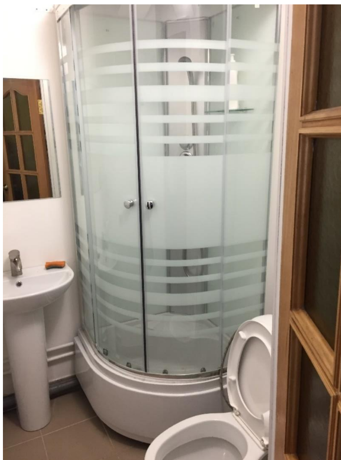
Фото 14. Санузел (бывшее помещение № 2 согласно техническому паспорту). Вид с северо-востока.
