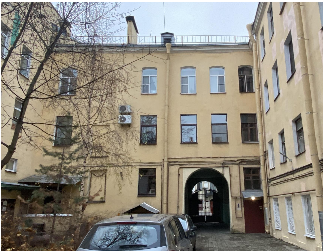
Фото 6. Северо-восточный дворовой фасад. Вид с северо-востока.
