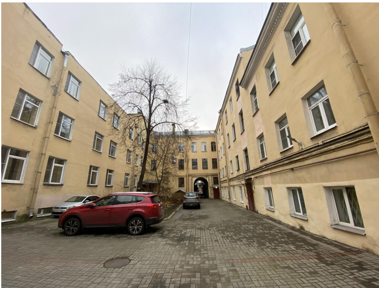
Фото 5. Общий вид северо-восточного и юго-восточного дворовых фасадов. Вид с северо-востока.
