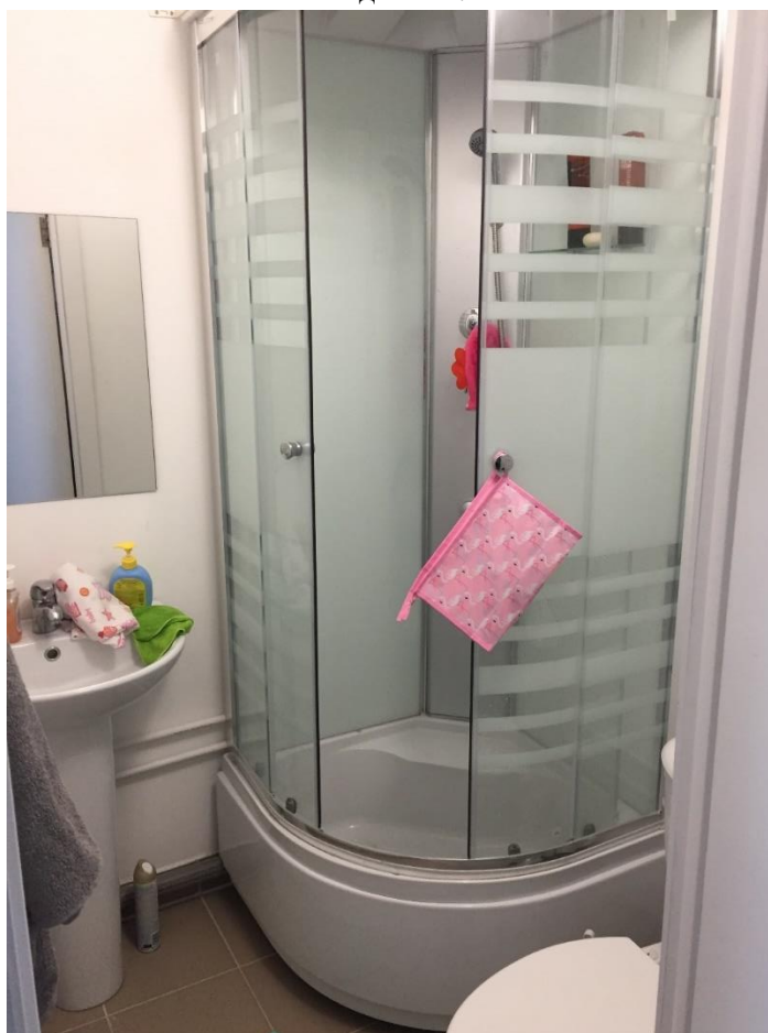
Фото 20. Санузел (бывшее помещение № 4 согласно техническому паспорту). Вид с северо-востока.
