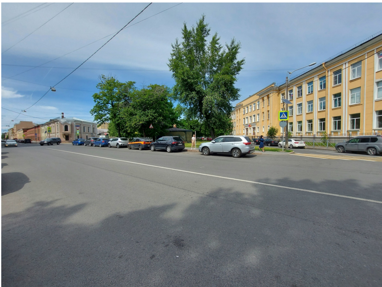
Точка фотофиксации 2. Общий вид на территорию обследования с ЮВ (с противоположной стороны проезжей части ул. Курляндская).
