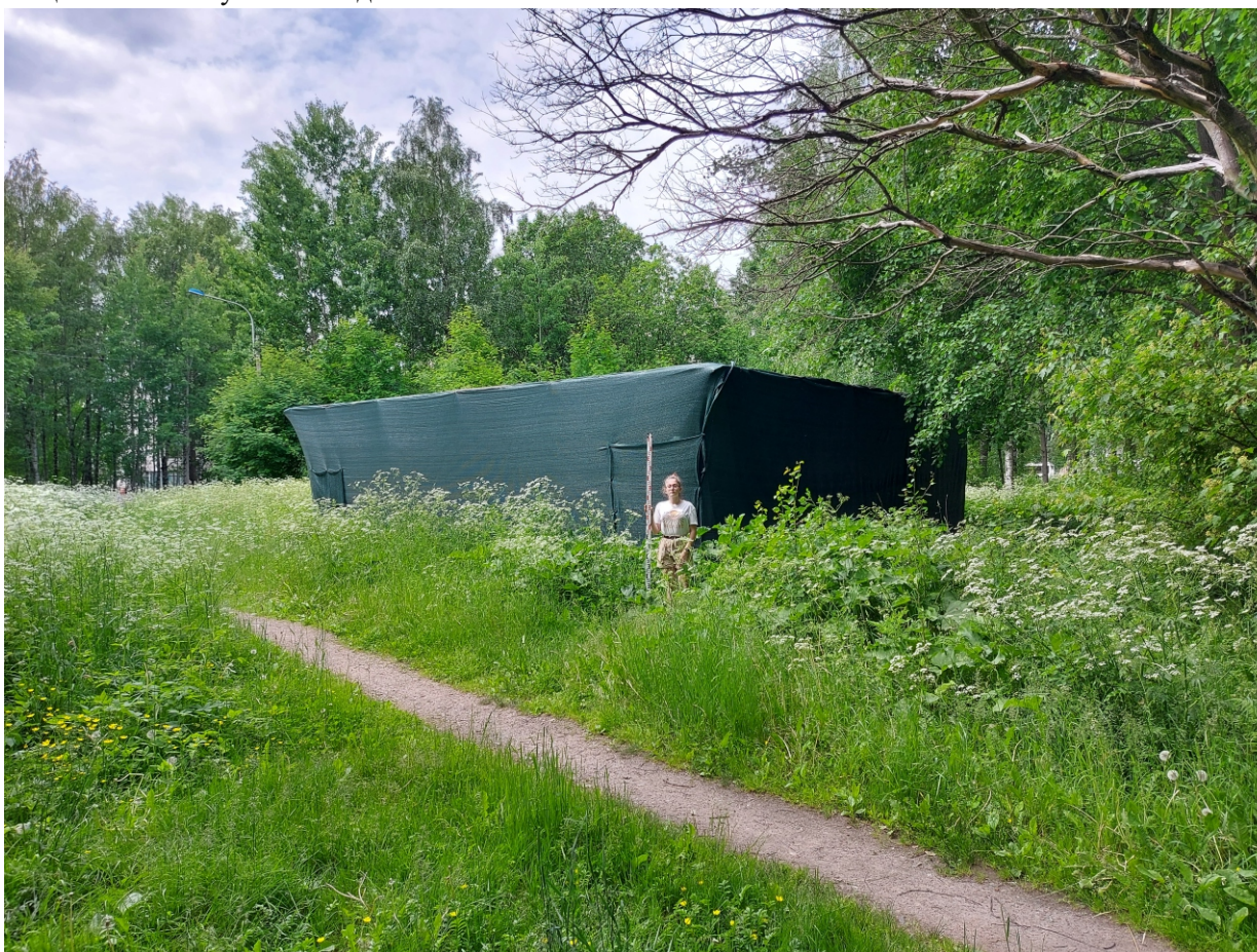
Точка фотофиксации 7. Юго-восточная часть обследуемой территории. Здание реконструируемого общественного туалета. Вид с В.
