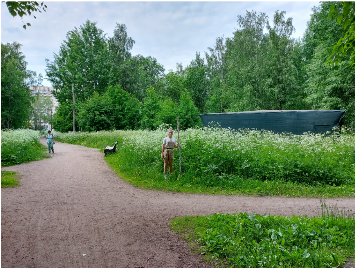
Точка фотофиксации 6. Южная часть обследуемой территории. Здание реконструируемого общественного туалета. Вид с ЮЮВ.
