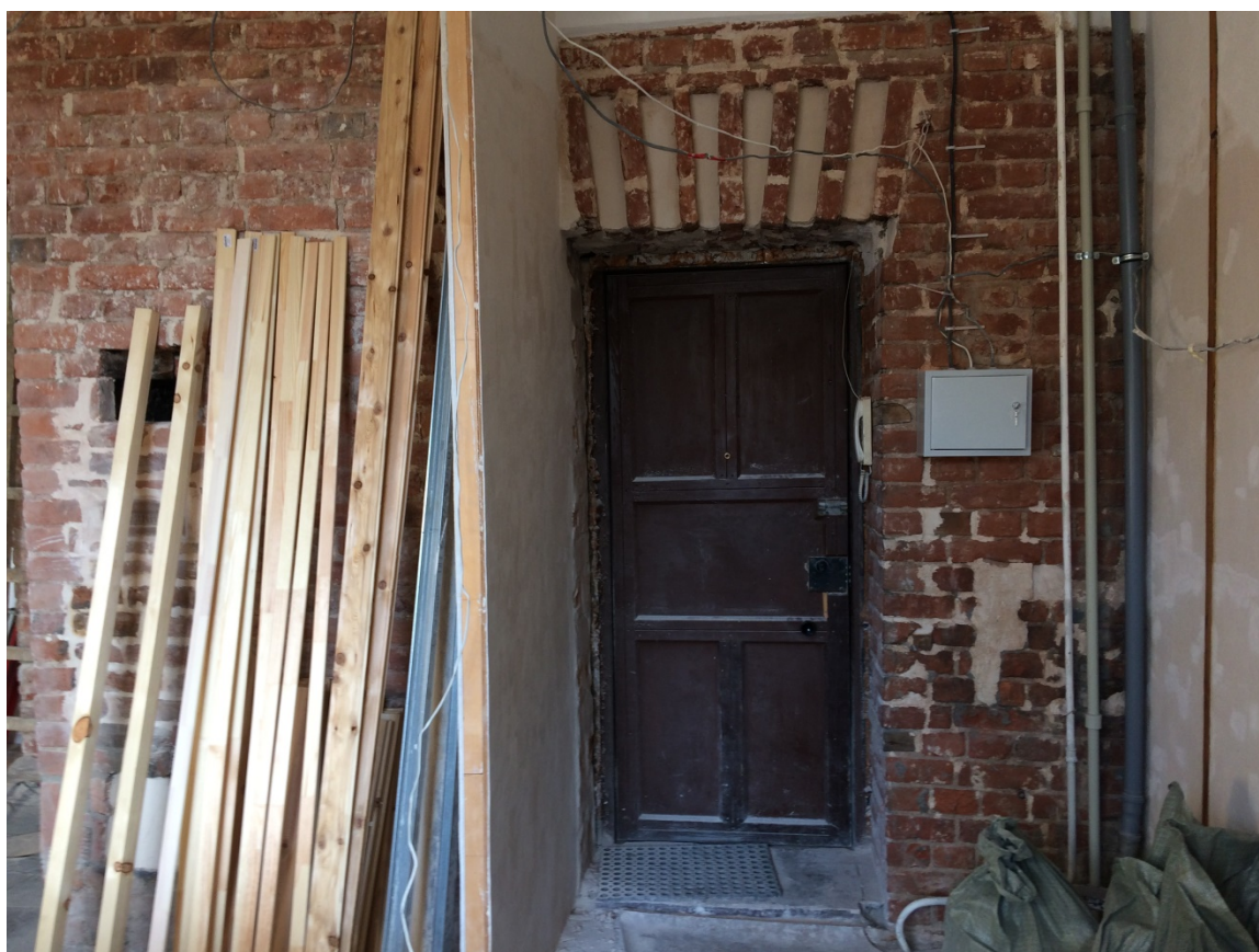
Фото 6. Входная дверь в квартиру № 7 со стороны квартиры.
