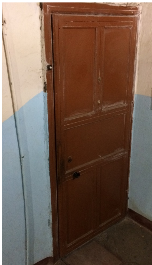
Фото 5. Входная дверь в квартиру № 7 со стороны лестничной площадки.
