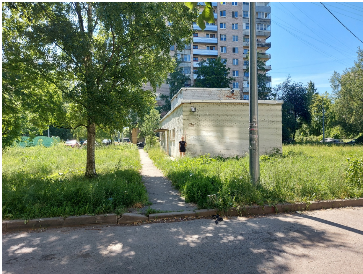
Точка фотофиксации 5. Общий вид на северную часть территории обследования и ЦТП с С.
