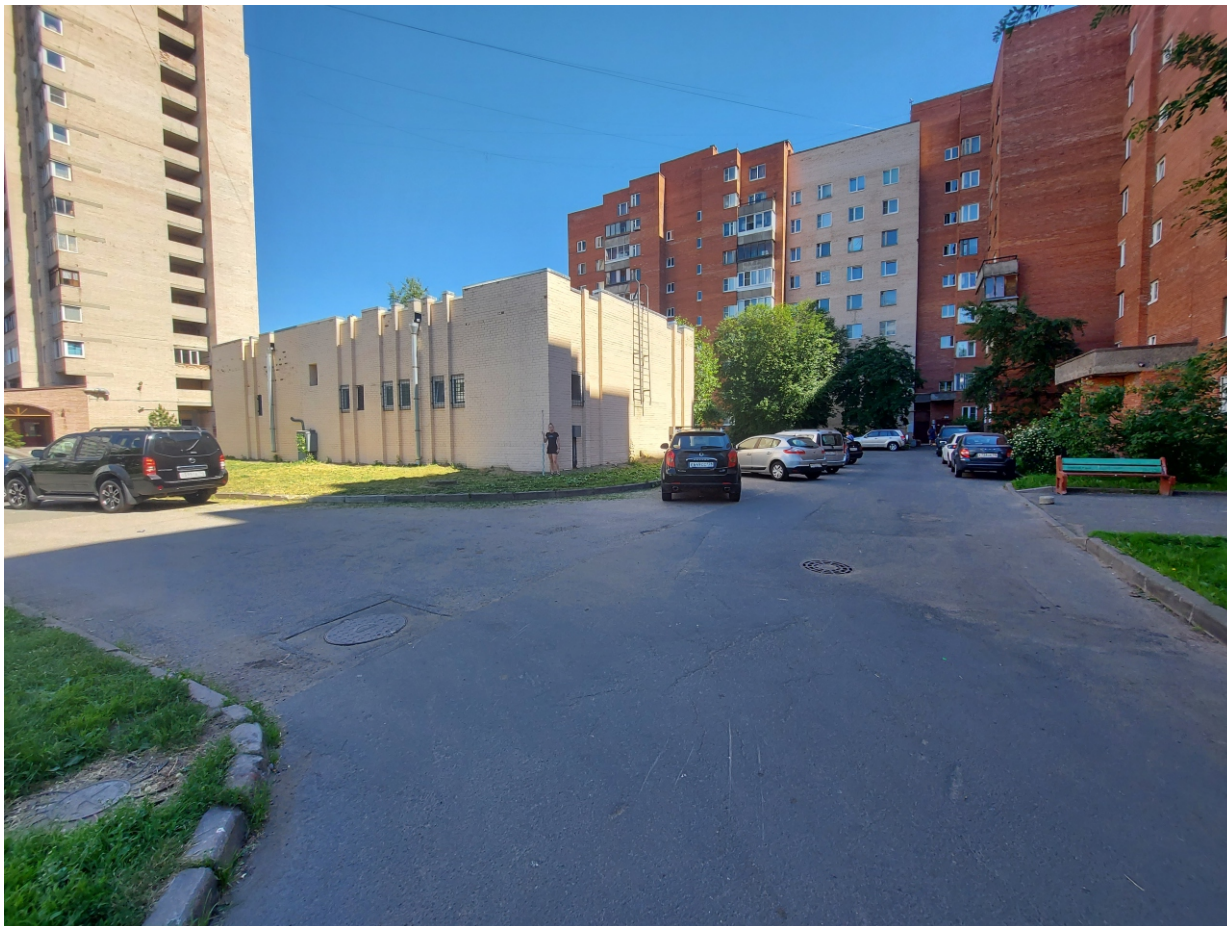
Точка фотофиксации 7. Общий вид на южную часть территории обследования и насосную станцию с ЮВ.
