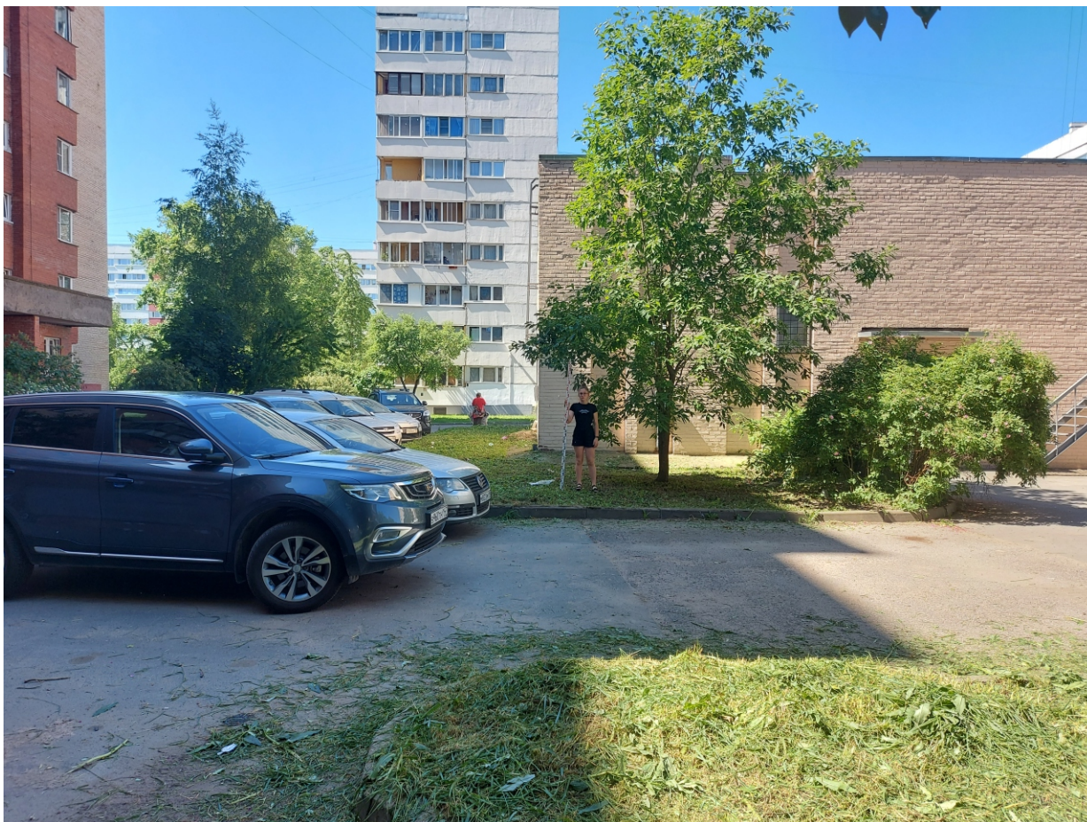
Точка фотофиксации 3. Общий вид на ЮВ часть территории обследования и насосную станцию с В.
