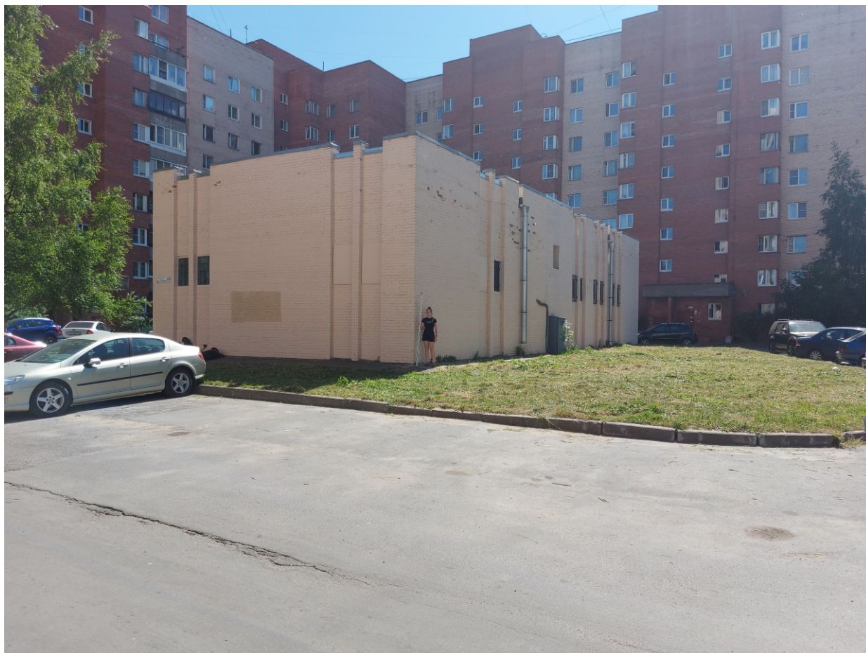
Точка фотофиксации 1. Общий вид на северную часть территории обследования и насосную станцию с СЗ.
