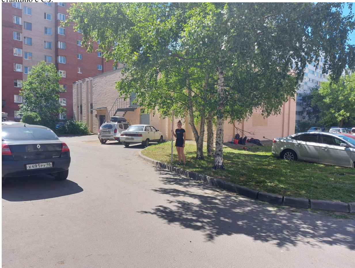
Точка фотофиксации 2. Общий вид на северную часть территории обследования и насосную станцию с СВ.
