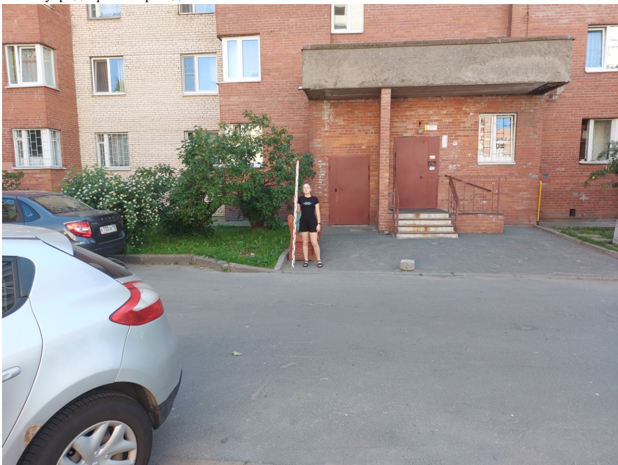
Точка фотофиксации 6. Общий вид на северную часть территории обследования с С. Внутридворовой проезд.
