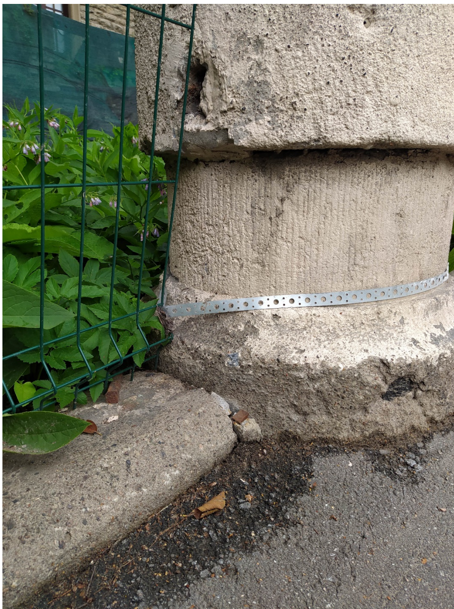
Фрагмент цокольного блока в месте примыкания к колонне. Дата съёмки 14.07.2022.
