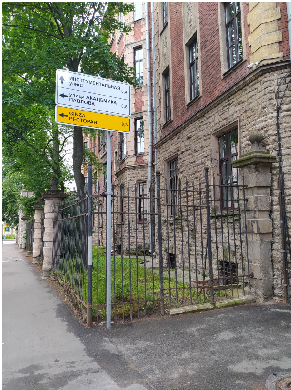
Общий вид со стороны Аптекарского пр. Муфтированная колонна разобрана, установлена временная металлическая стойка в виде трубы. Дата съёмки 14.07.2022.
