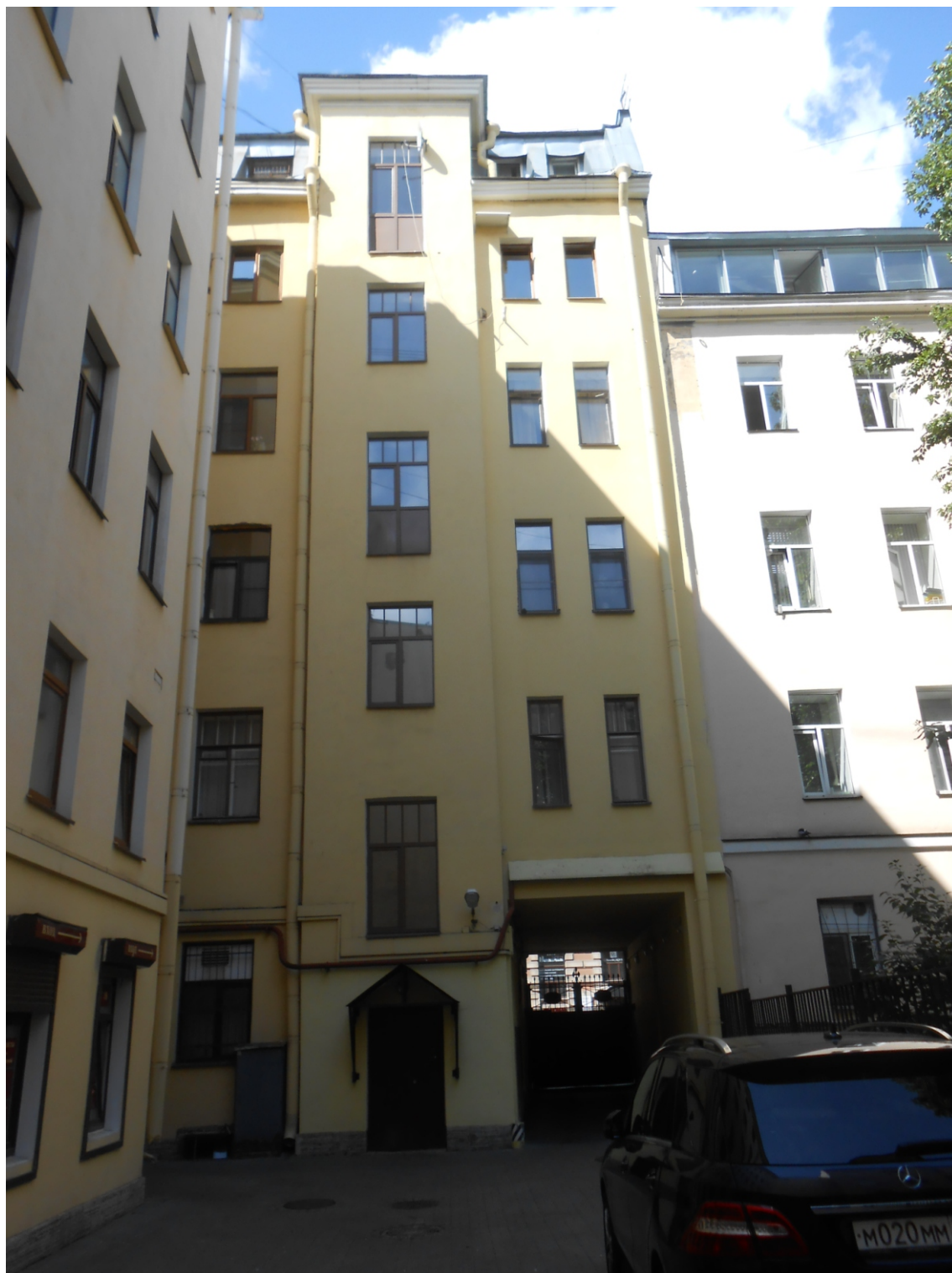
12. “Дом С.Н. Мартенса, А.Н. Тура, С.И. Тимашева”. Восстания ул., 3-5, лит. А. Дворовый фасад лицевого корпуса, левая часть. Фото:20.06.2022.
