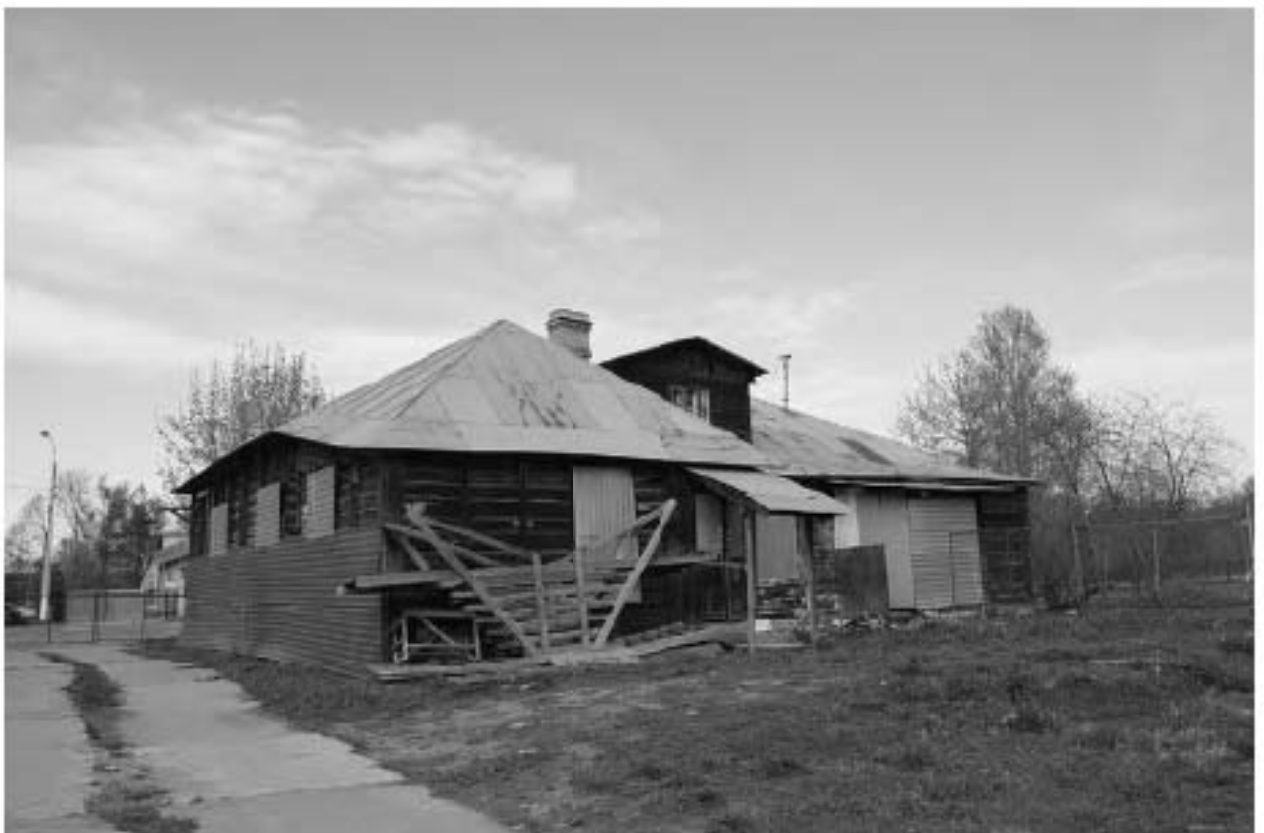
Фото 28. ОКН федерального значения «Дворцово-парковый ансамбль Верхнего парка и Нижнего сада». Фрагмент парка. Дом казначея. Съёмка 10.06.2022 г.
