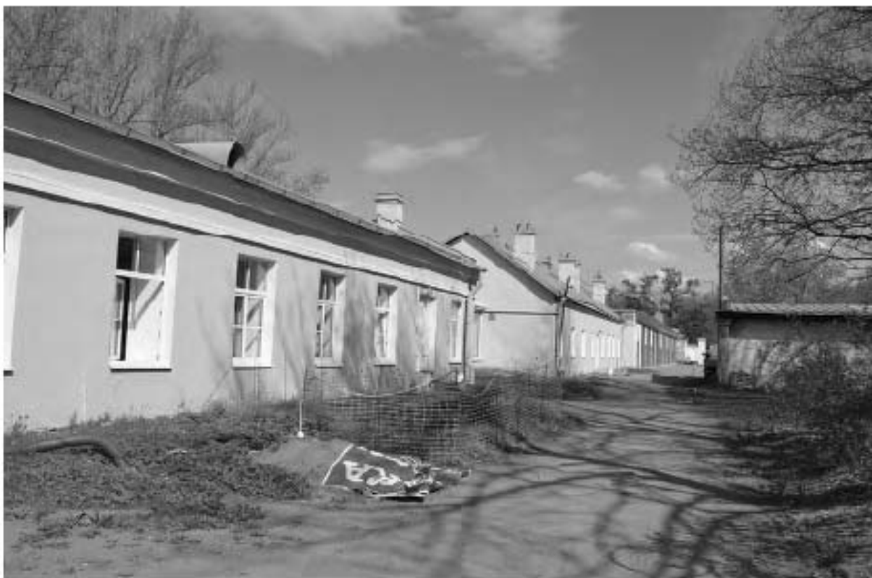
Фото 06. ОКН федерального значения «Дворцово-парковый ансамбль Верхнего парка и Нижнего сада». Центральный корпус (парники). Съёмка 10.06.2022 г.
