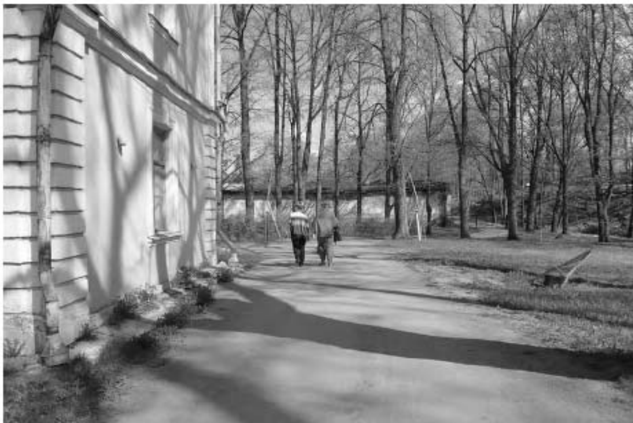
Фото 04. ОКН федерального значения «Дворцово-парковый ансамбль Верхнего парка и Нижнего сада». Фрагмент парка. Службы дома садовника. Съёмка 10.06.2022 г.
