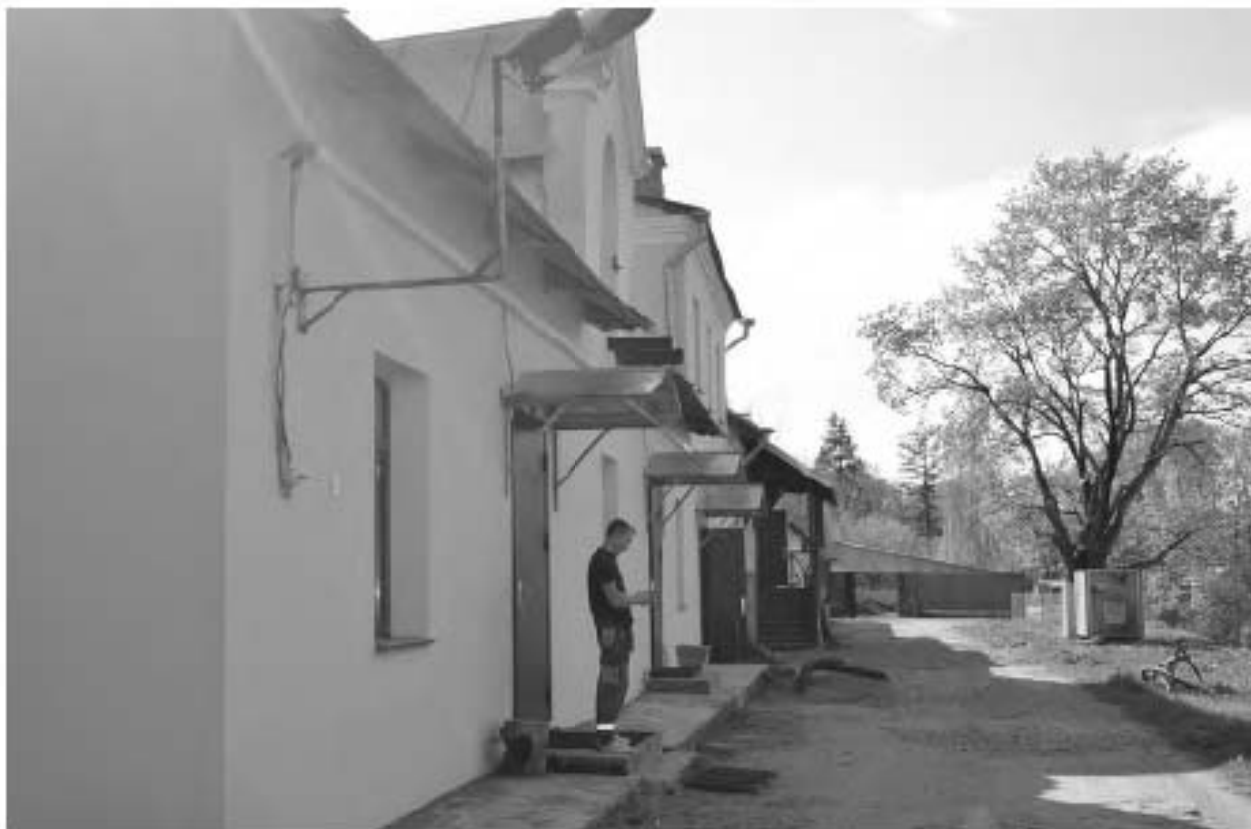
Фото 19. ОКН федерального значения «Дворцово-парковый ансамбль Верхнего парка и Нижнего сада». Фрагмент парка. Служебные дома. Съёмка 10.06.2022 г.
