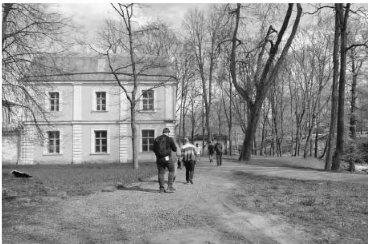
Фото 03. ОКН федерального значения «Дворцово-парковый ансамбль Верхнего парка и Нижнего сада». Фрагмент парка. Службы дома садовника. Съёмка 10.06.2022 г.
