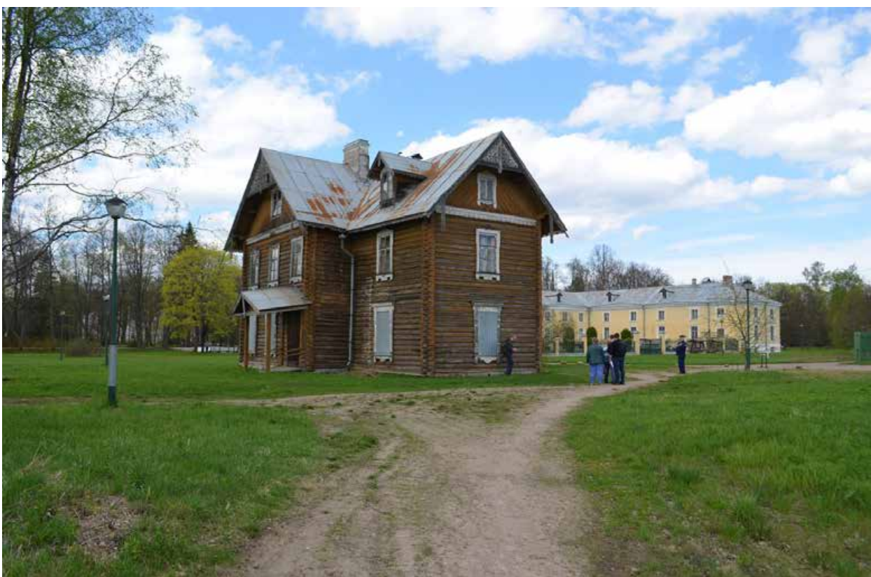
Фото 03. ОКН «Верхний парк». Вид на парк и на ОКН «Дворцовые конюшни и жилой дом». Общий вид. Съёмка 10.06.2022 г.
