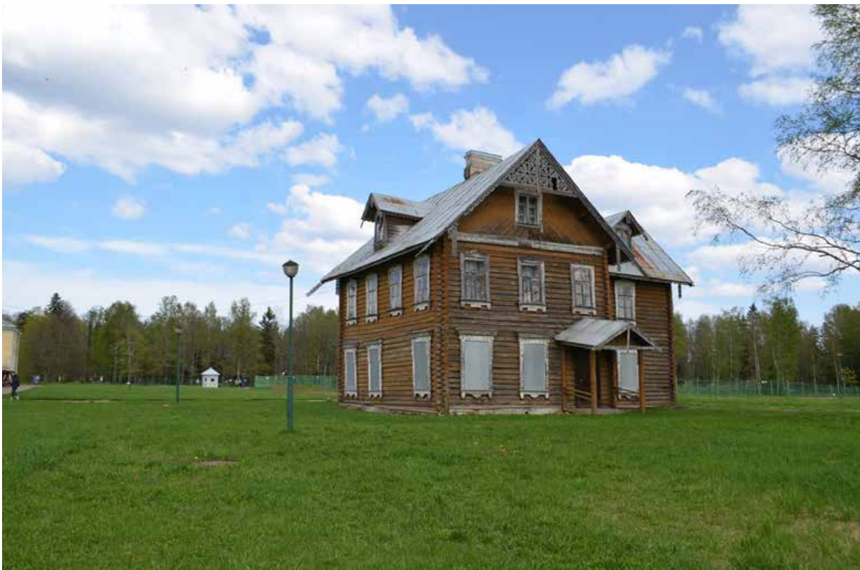
Фото 02. ОКН «Верхний парк». Вид на парк и на ОКН «Дворцовые конюшни и жилой дом». Общий вид. Съёмка 10.06.2022 г.
