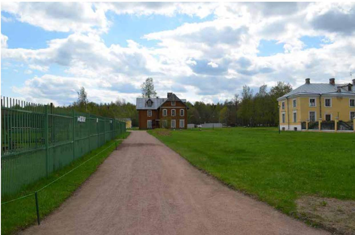
Фото 04. ОКН «Верхний парк». Вид на парк и на ОКН «Дворцовые конюшни и жилой дом». Общий вид. Съёмка 10.06.2022 г.
