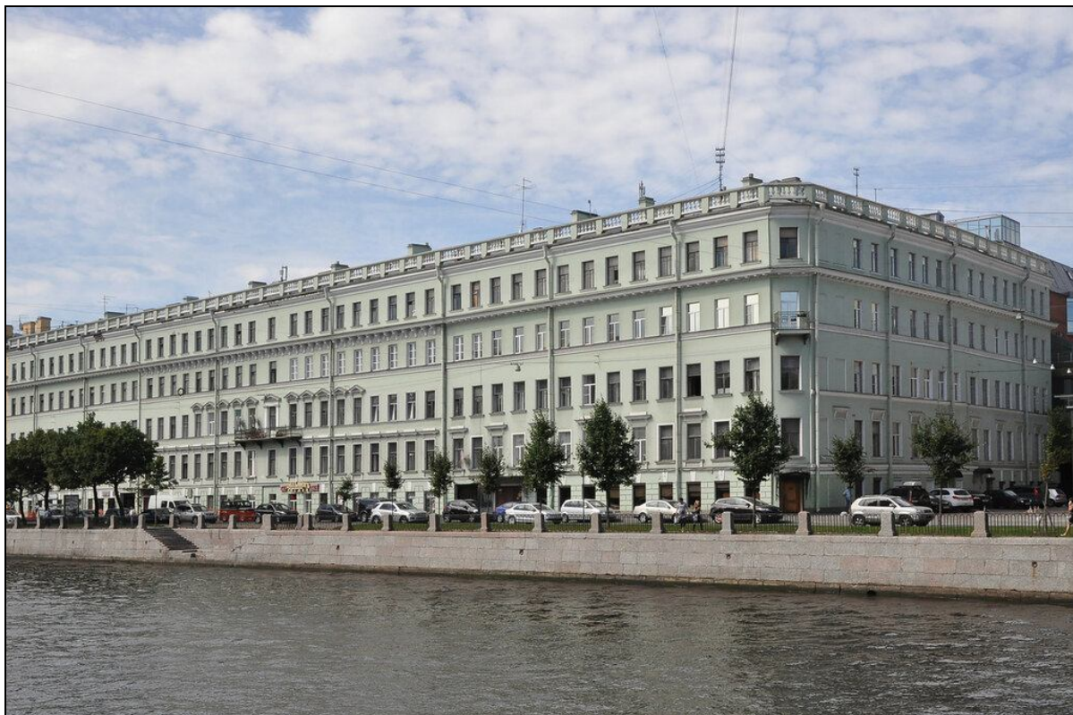
1. Вид лицевых фасадов со стороны набережной реки Фонтанки. Общий вид.
