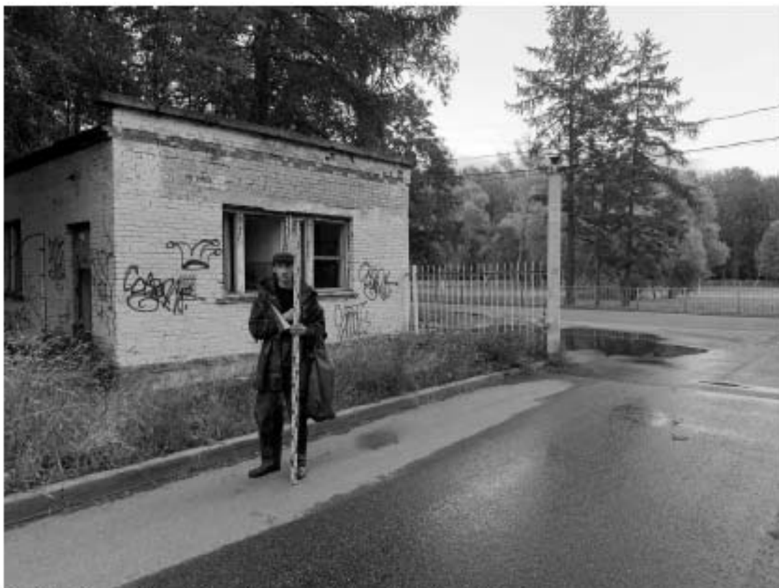
Илл. 18. Санкт-Петербург, Красносельский район. Общий вид участка обследования. Точка съемки 3. Вид с Ю.
