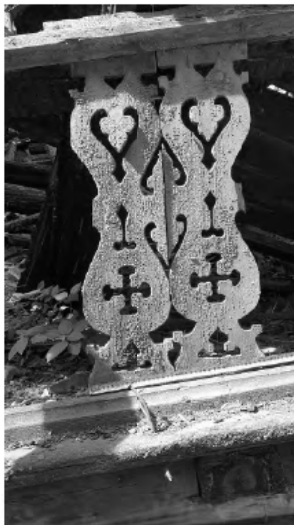
29. ОКН РЗ «Дача Гербель» по адресу: г. Санкт-Петербург, ул. Межозёрная, дом 4, литера А. Фрагмент декоративной панели. Дата съёмки: 19.06.2019 г.
