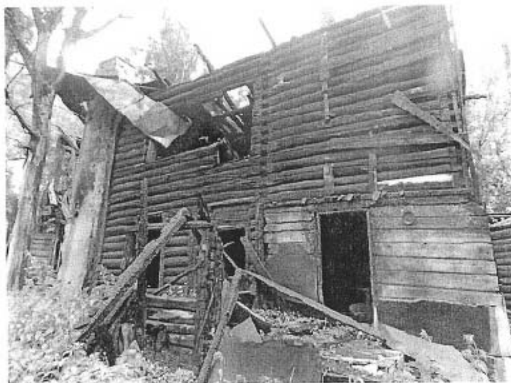
4. Объект культурного наследия «Дача Гербель с участком», западный фасад.
