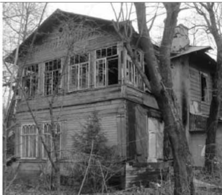
30. Дача Гербель (Межозёрная ул., д. 4, лит. А). Северный фасад. Фото 2013 года. (Архив КГИОП).
