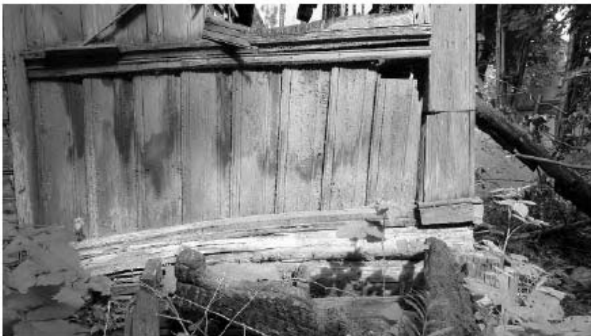
27. ОКН РЗ «Дача Гербель» по адресу: г. Санкт-Петербург, ул. Межозёрная, дом 4, литера А. Восточный фасад, фрагмент дощатой обшивки фасада. Дата съёмки: 19.06.2019 г.
