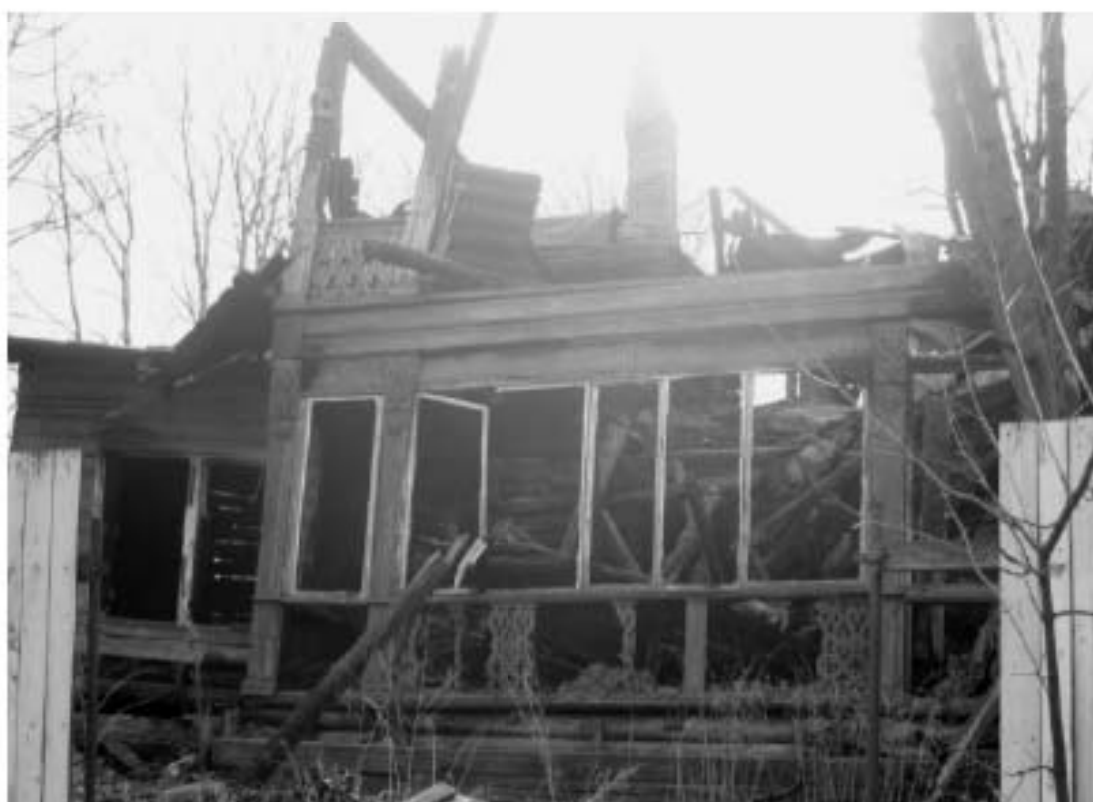
12. ОКН РЗ «Дача Гербель» по адресу: г. Санкт-Петербург, ул. Межозёрная, дом 4, литера А. Восточный фасад. Фрагмент. Дата съёмки: 06.04.2016 г.
