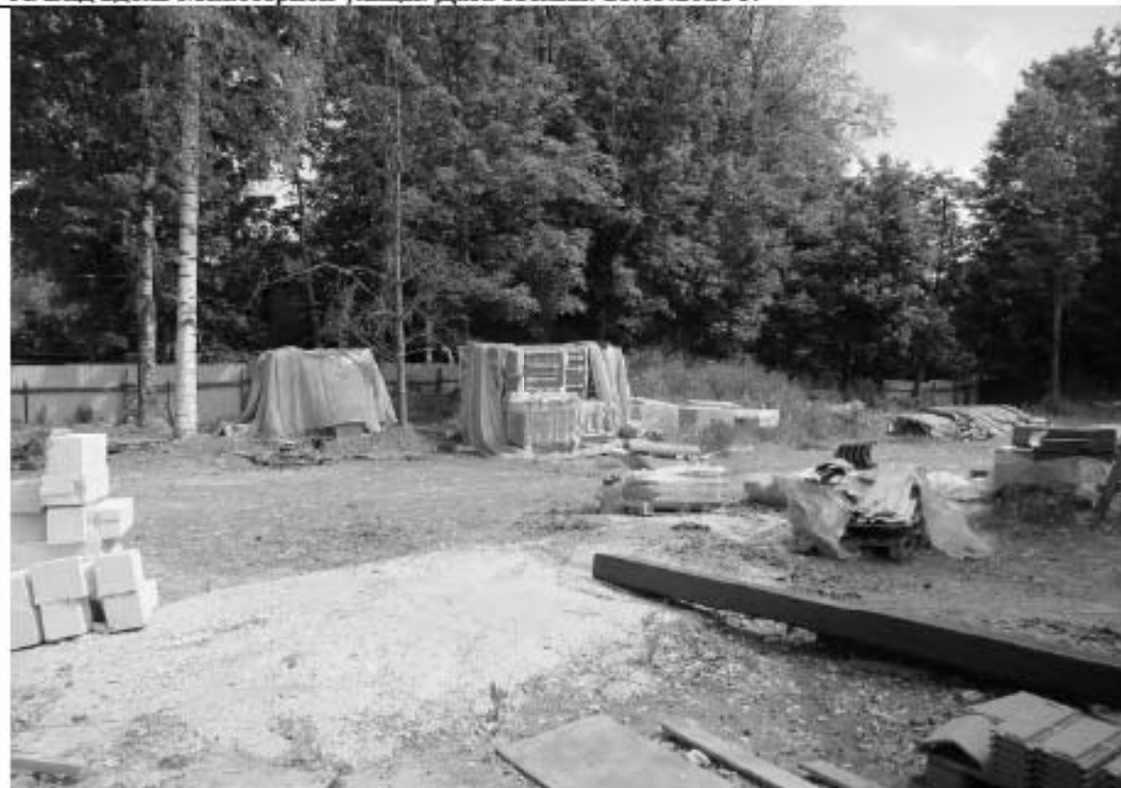
48. ОКН РЗ «Дача Гербель» по адресу: г. Санкт-Петербург, ул. Межозёрная, дом 4, литера А. Вид на северный фасад и Межозёрную улицу. Дата съёмки: 28.05.2021 г.
