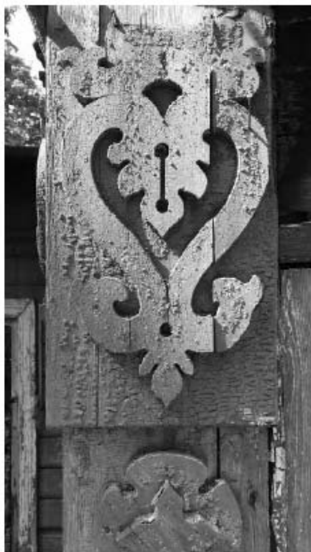
24. ОКН РЗ «Дача Гербель» по адресу: г. Санкт-Петербург, ул. Межозёрная, дом 4, литера А. Фрагмент декоративной панели. Дата съёмки: 19.06.2019 г.
