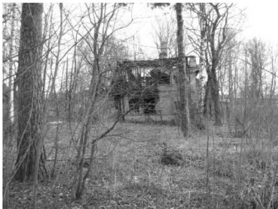
8. ОКН РЗ «Дача Гербель» по адресу: г. Санкт-Петербург, ул. Межозёрная, дом 4, литера А. Вид на юго-западную часть земельного участка и северный фасад здания. Дата съёмки: 06.04.2016 г.
