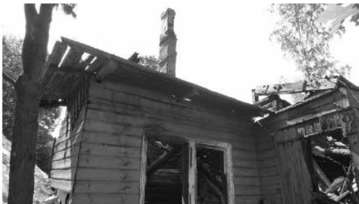
18. ОКН РЗ «Дача Гербель» по адресу: г. Санкт-Петербург, ул. Межозёрная, дом 4, литера А. Восточный фасад. Дата съёмки: 19.06.2019 г.
