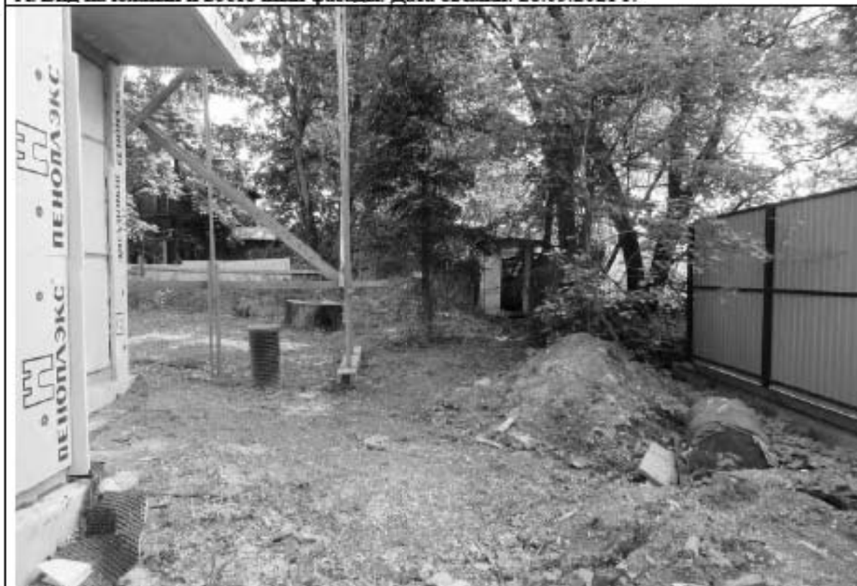
50. ОКН РЗ «Дача Гербель» по адресу: г. Санкт-Петербург, ул. Межозёрная, дом 4, литера А. Западная сторона. Дата съёмки: 28.05.2021 г.
