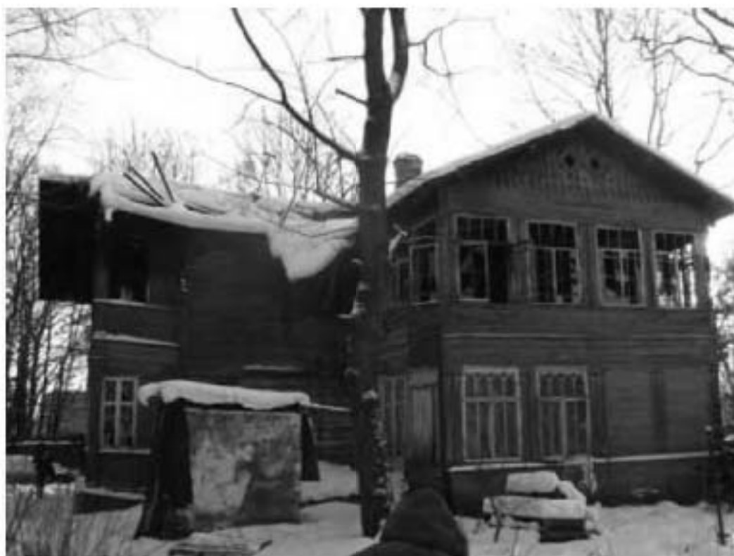
31. Дача Гербель (Межозёрная ул., д. 4, лит. А). Северный фасад. Фото 2013 года. (Архив КГИОП).
