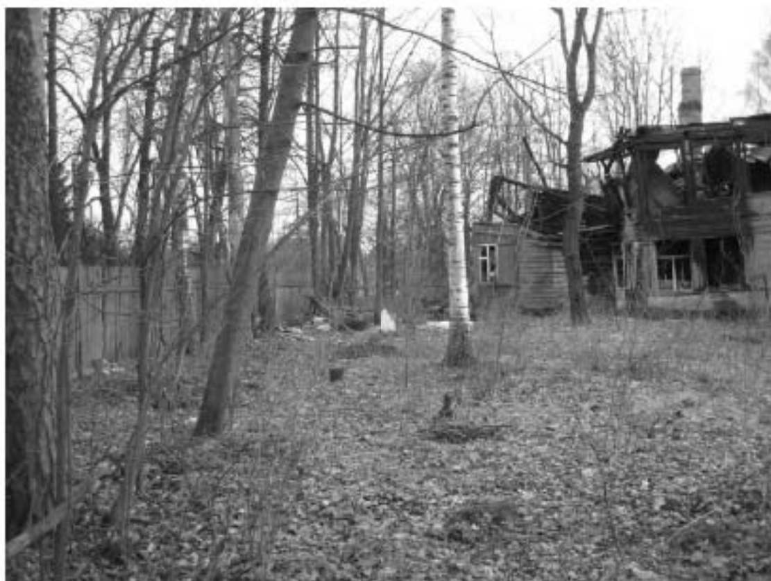
9. ОКН РЗ «Дача Гербель» по адресу: г. Санкт-Петербург, ул. Межозёрная, дом 4, литера А. Вид на юго-восточную часть земельного участка и северный фасад здания. Дата съёмки: 06.04.2016 г.
