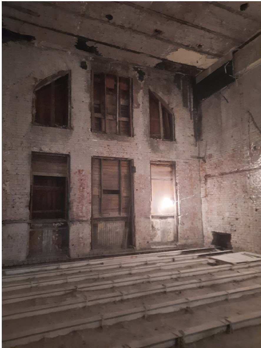
Фото №5. Помещение 3-Н, третий этаж.
