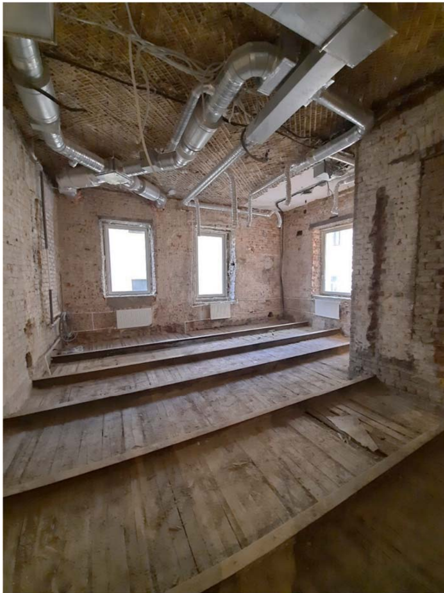
Фото №4. Помещение 3-Н, третий этаж.
