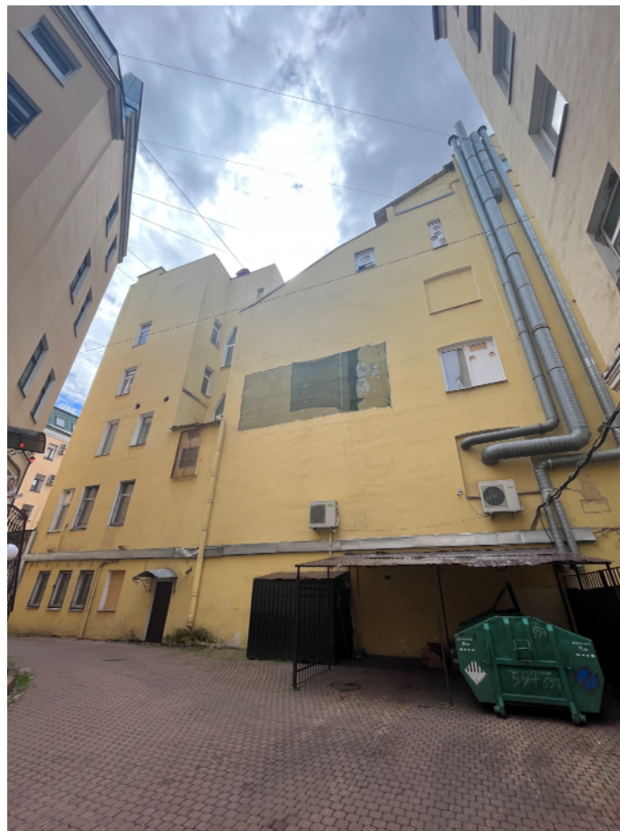
Фото №3. Северный дворовый фасад.
