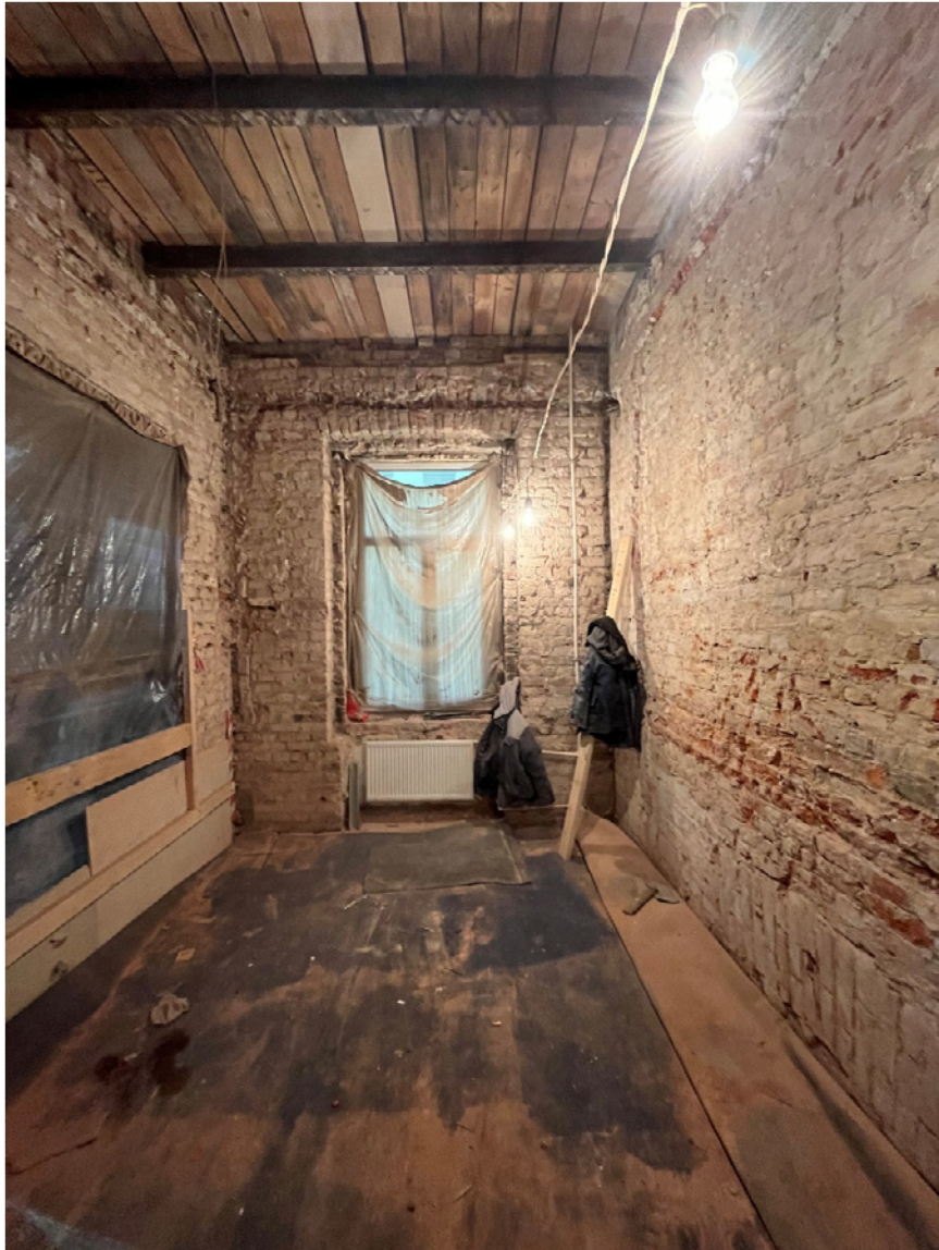
Фото №7. Помещение 3-Н, четвертый этаж.
