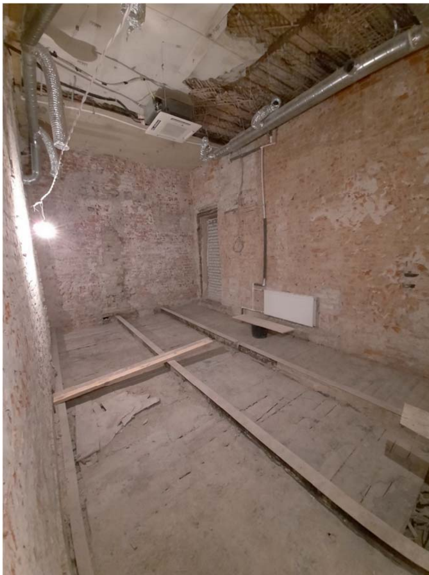
Фото №6. Помещение 3-Н, третий этаж.
