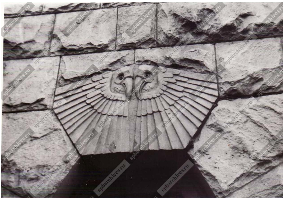
Илл. 92. Вид части парадного входа, облицованного блоками гранита с рельефами дома № 72 по Невскому проспекту. 1986 г. ЦГАКФФД СПб. Ар 215592.
