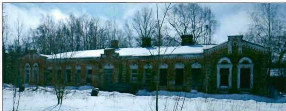
11. Санкт-Петербург, г. Кронштадт, Кронштадтское шоссе, д. 30, лит. Ж. Общий вид с севера.
