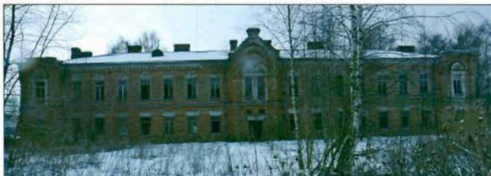
7. Санкт-Петербург, г. Кронштадт, Кронштадтское шоссе, д. 30, лит. Е. Общий вид с северо-востока.
