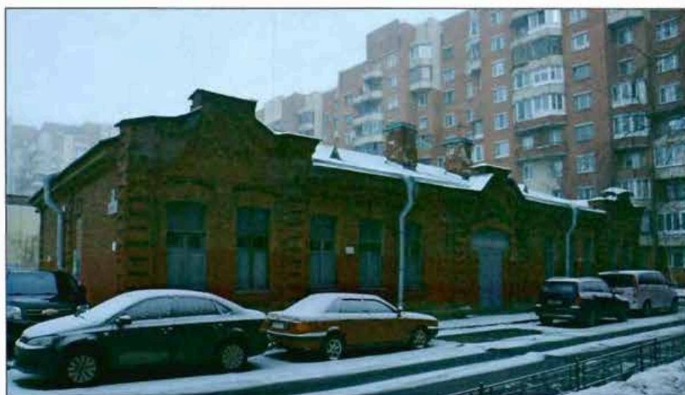
21. Санкт-Петербург, г. Кронштадт, Кронштадтское шоссе, д. 66, лит. А. Общий вид с юга.
