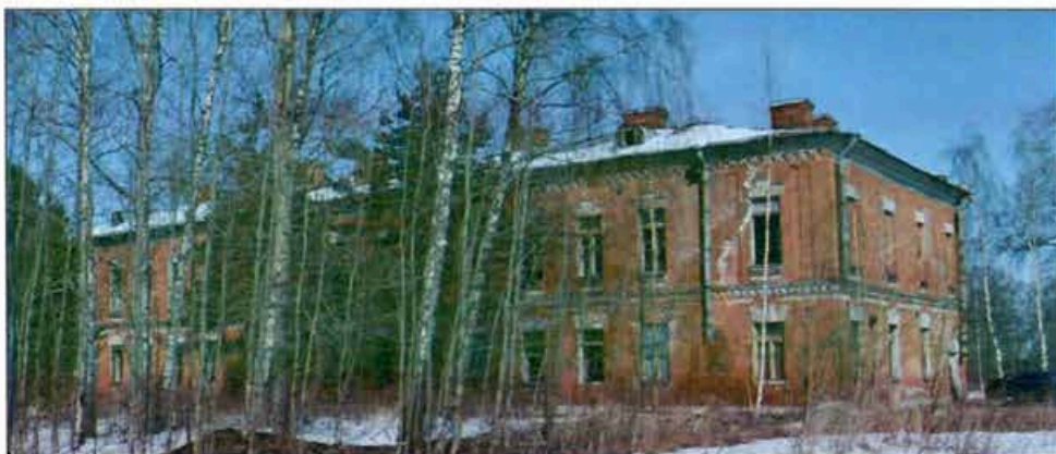
8. Санкт-Петербург, г. Кронштадт, Кронштадтское шоссе, д. 30, лит. Е. Общий вид с юга.
