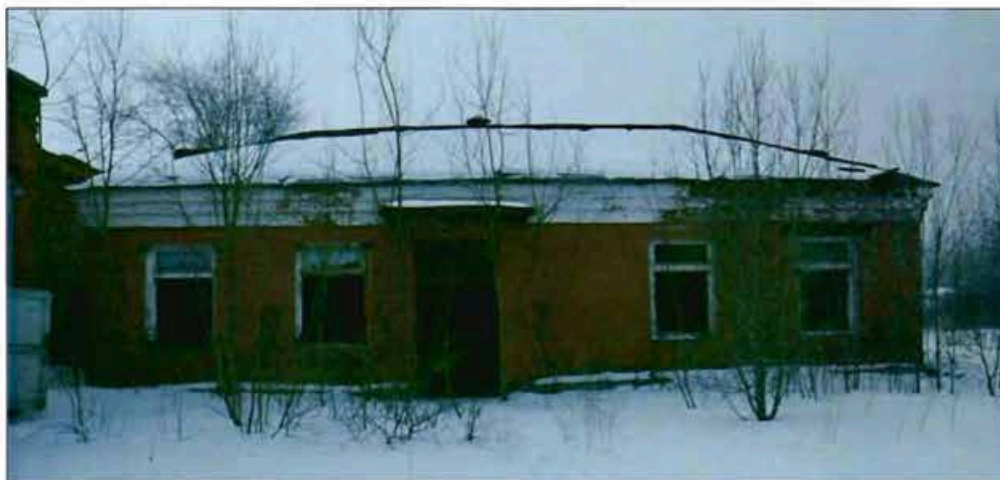
1. Санкт-Петербург, г. Кронштадт, Кронштадтское шоссе, д. 30, лит. Б. Общий вид с северо-востока.
