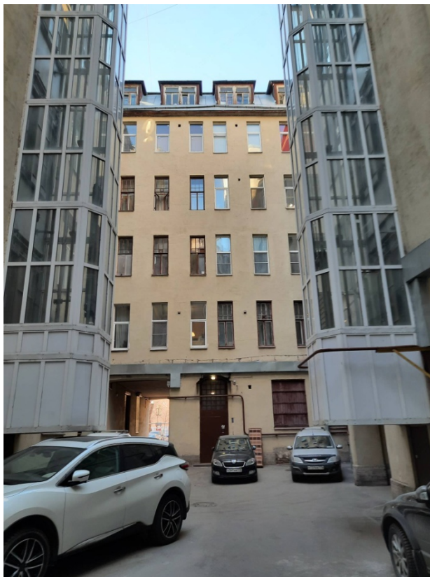
Фото 7 Фрагмент дворового фасада выявленного объекта культурного наследия «Дом Т.Н. Путиловой» расположенного по адресу: Санкт-Петербург, Большой пр. П.С., д. 44, лит. А
