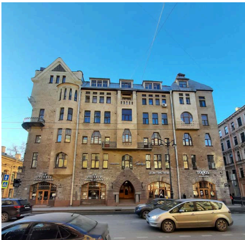
Фото 1 Лицевой фасад выявленного объекта культурного наследия «Дом Т.Н. Путиловой» расположенного по адресу: Санкт-Петербург, Большой пр. П.С., д. 44, лит. А
