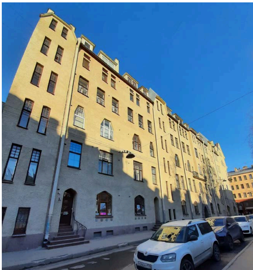
Фото 3 Лицевой фасад выявленного объекта культурного наследия «Дом Т.Н. Путиловой» расположенного по адресу: Санкт-Петербург, Большой пр. П.С., д. 44, лит. А
