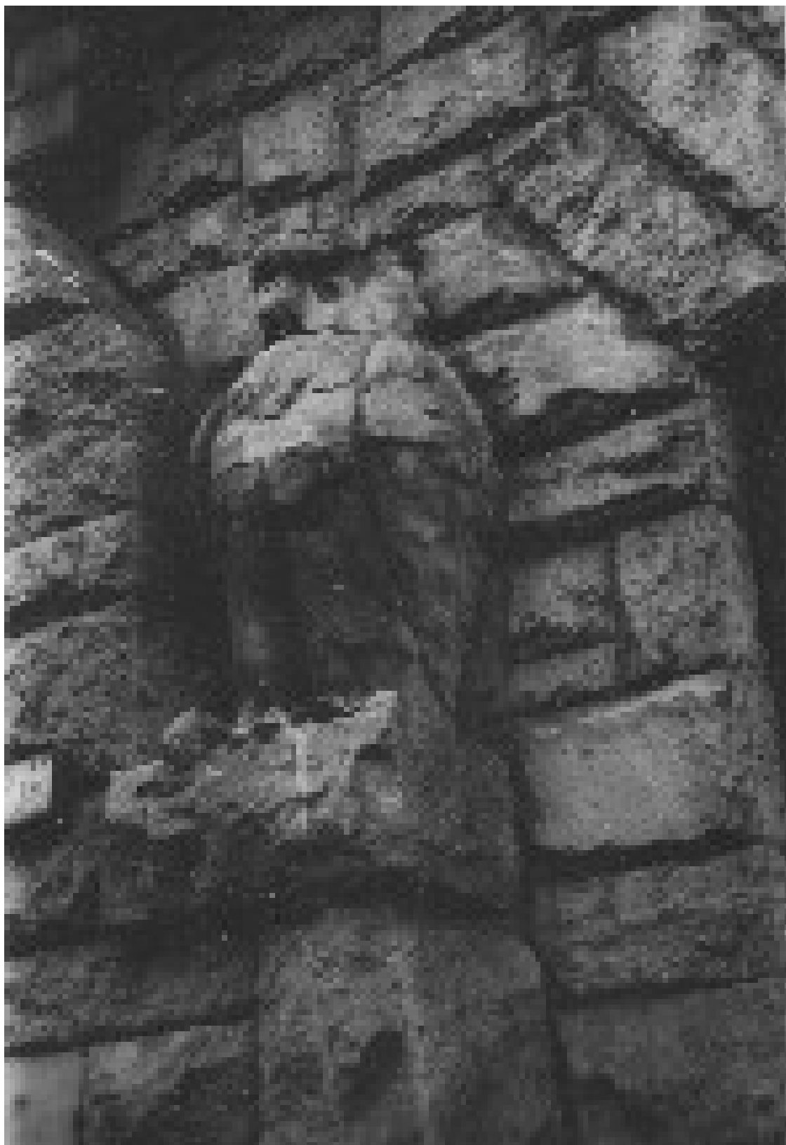
27. Вид части гранитного портала с изображением совы, дома № 44 Большому проспекту Петроградской стороны (бывший дом Т.Н. Путиловой, или «Дом с совами», архитектор И.А.Претро). 28 декабря 1991 г. — ЦГАКФФД СПб. Шифр: Ар 211598.
