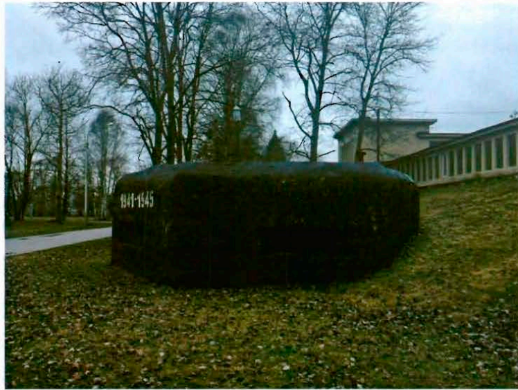
3. Вид с юго-восточной стороны.
