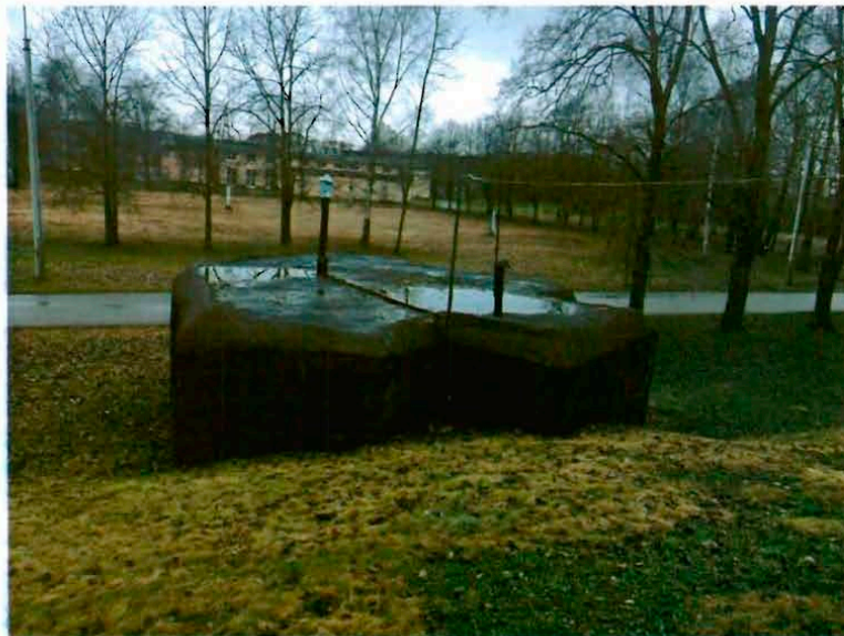
4. Вид с восточной стороны.
