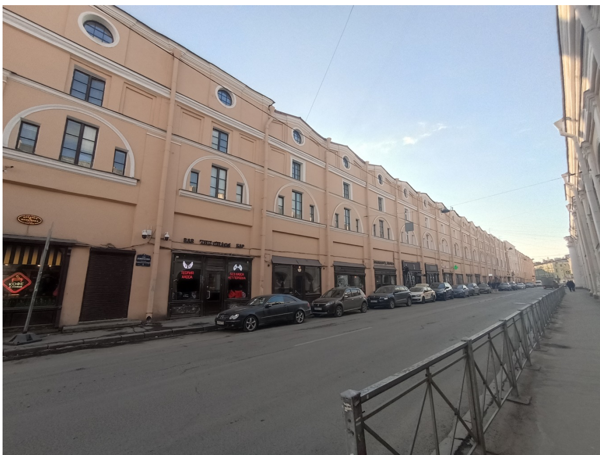
Фото 4. Вид на северо-восточный фасад.
