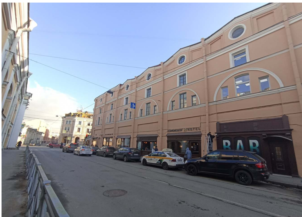
Фото 2. Вид на северо-восточный фасад. Фрагмент.
