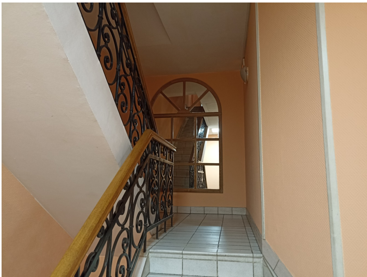
Фото 16. Помещение 8-Н. Лестница.
