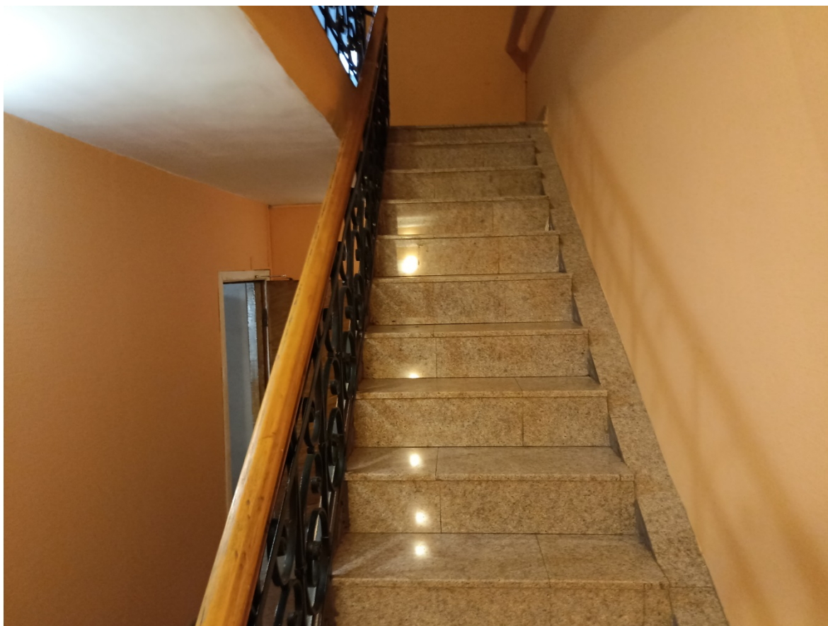
Фото 27. Помещение 8-Н. Лестница.
