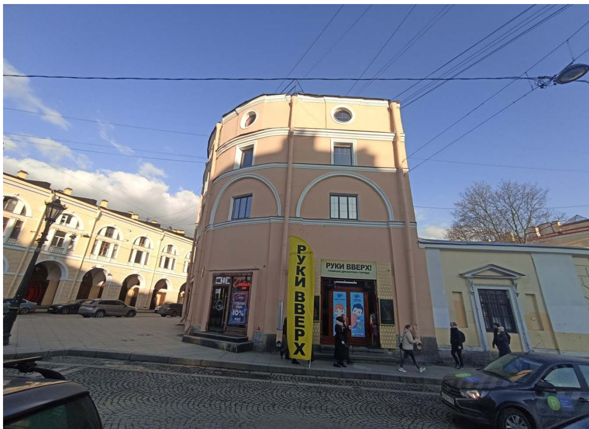
Фото 5. Вид на северо-западный торцевой фасад.
