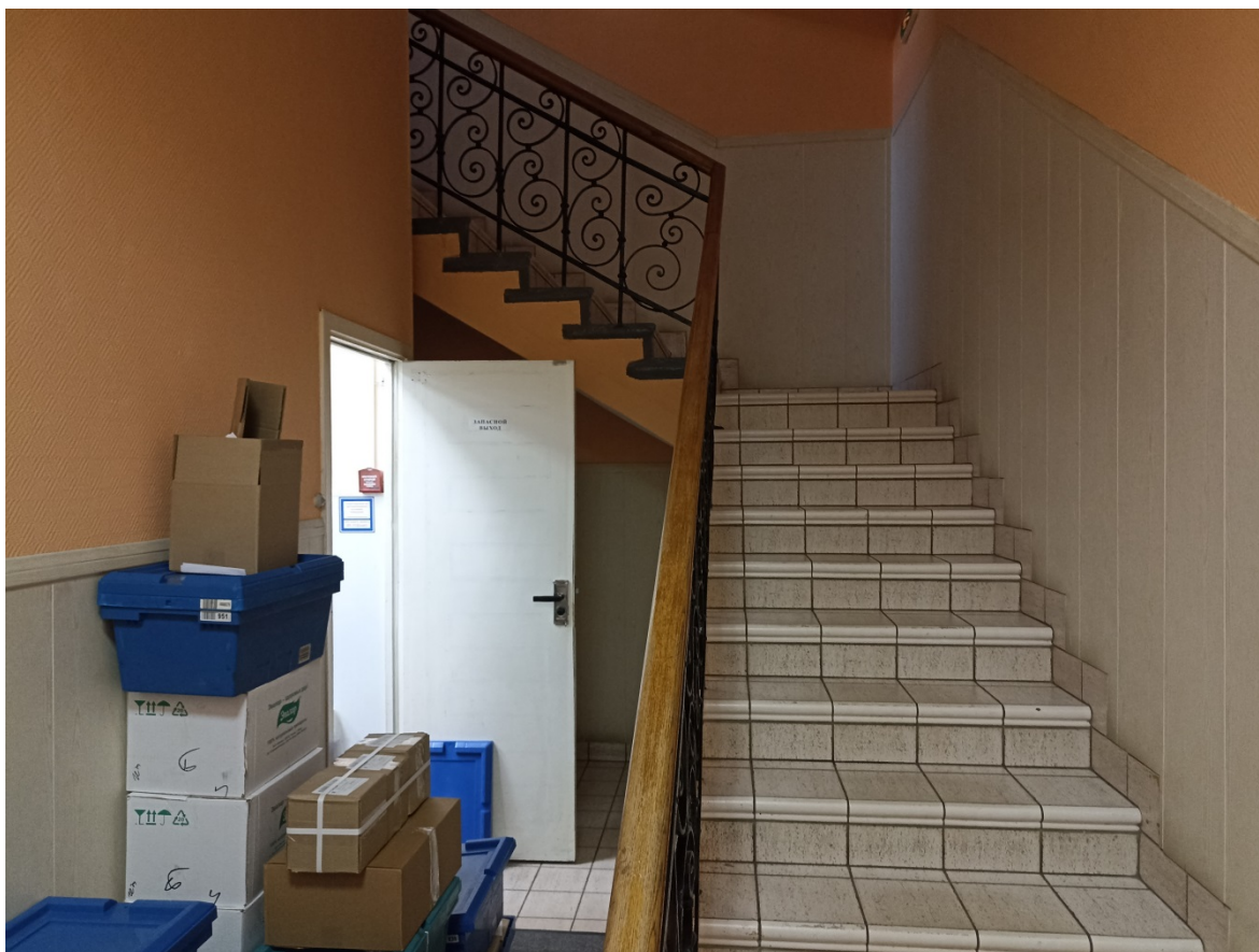
Фото 8. Помещение 8-Н. Лестница.
