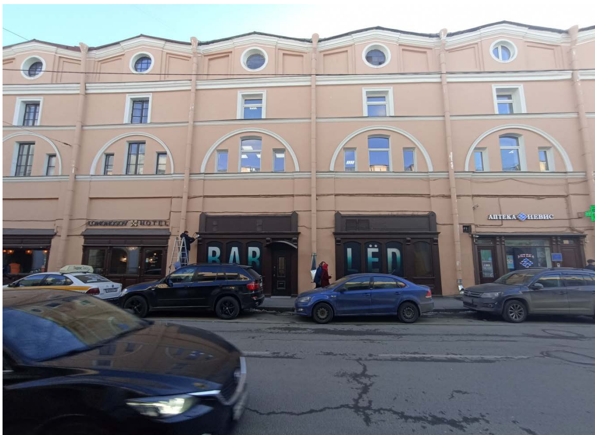
Фото 3. Вид на северо-восточный фасад. Входная зона помещений 8-Н, 69-Н.
