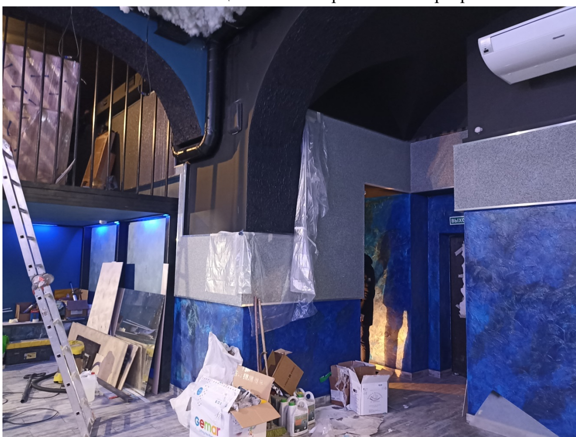
Фото 35. Помещение 69-Н. Фрагмент интерьера.
