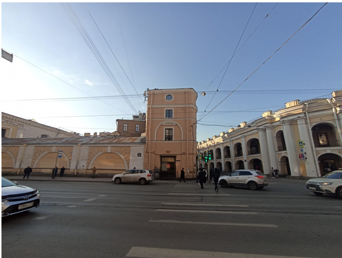
Фото 1. Вид на юго-восточный торцевой фасад.
