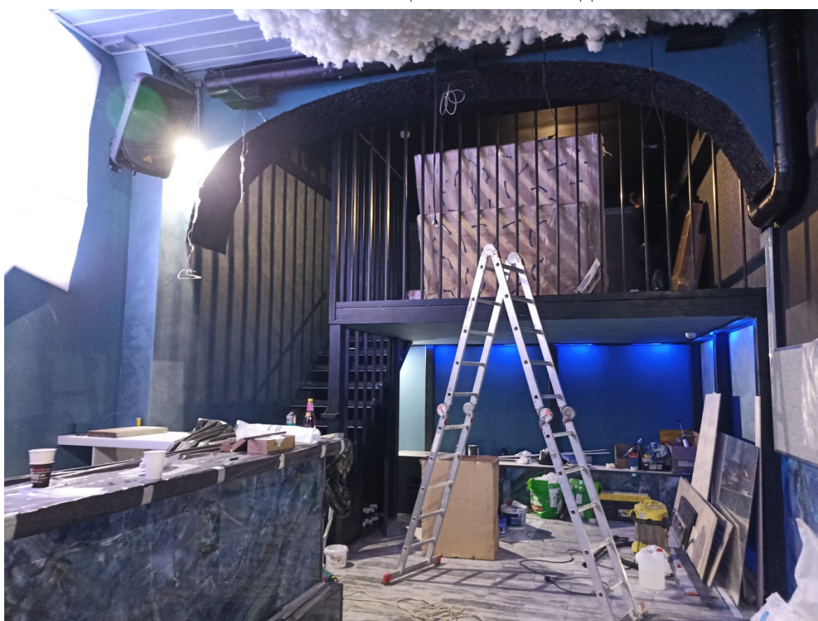
Фото 33. Помещение 69-Н. Фрагмент интерьера.
