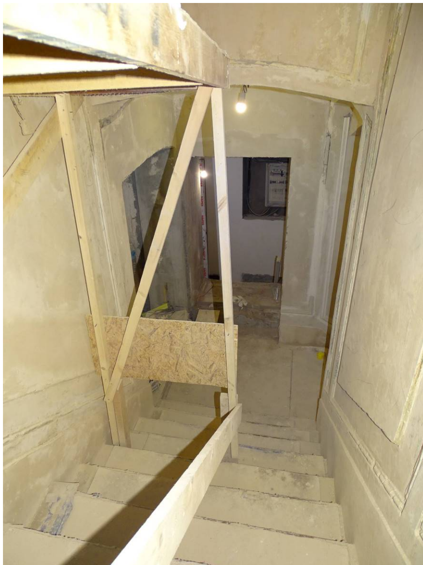
Илл. 16. Здание по адресу: г. Санкт-Петербург, наб. Крюкова кан., д. 23, лит. А. Квартира № 9. Лестница 2-ЛК. Вид с междуэтажной площадки. Съемка 08.06.2022 г. Полетайкин В.В.
