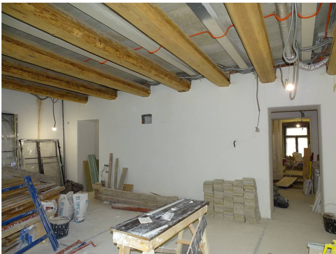
Илл. 14. Здание по адресу: г. Санкт-Петербург, наб. Крюкова кан., д. 23, лит. А. Квартира № 9. 1-й этаж. Пом. 16/18,2; 17/31,9. Съёмка 08.06.2022 г. Полетайкин В.В.
