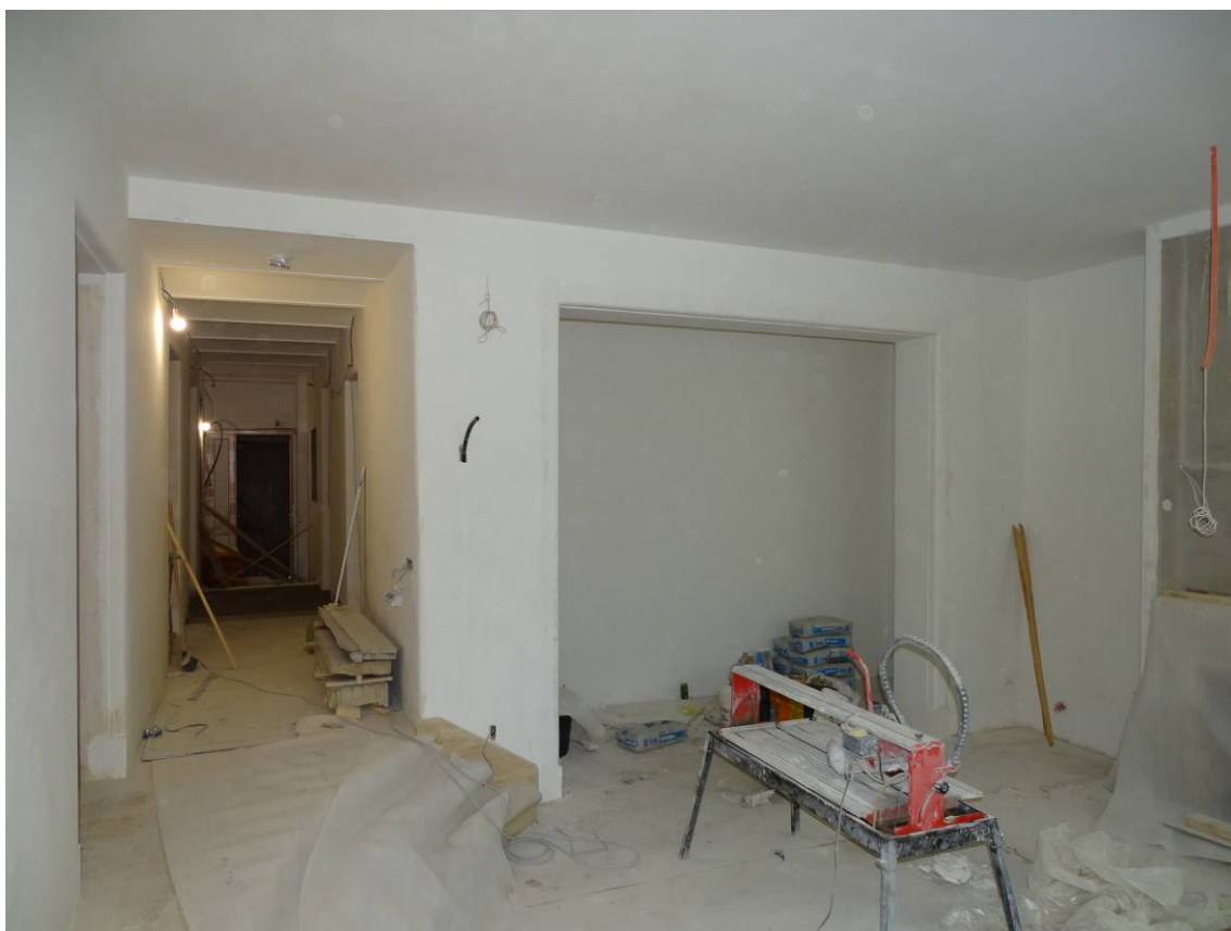
Илл. 12. Здание по адресу: г. Санкт-Петербург, наб. Крюкова кан., д. 23, лит. А. Квартира № 9. 1-й этаж. Пом. 13/12,7; 12/23,6. Съёмка 08.06.2022 г. Полетайкин В.В.
