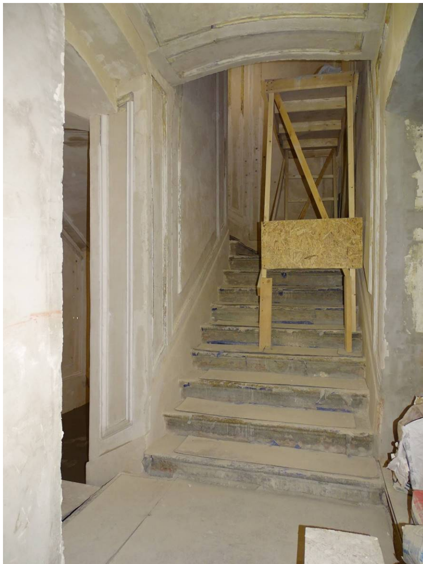
Илл. 06. Здание по адресу: г. Санкт-Петербург, наб. Крюкова кан., д. 23, лит. А. Квартира № 9. 1-й этаж. Лестница 2-ЛК. Съемка 08.06.2022 г. Полетайкин В.В.
