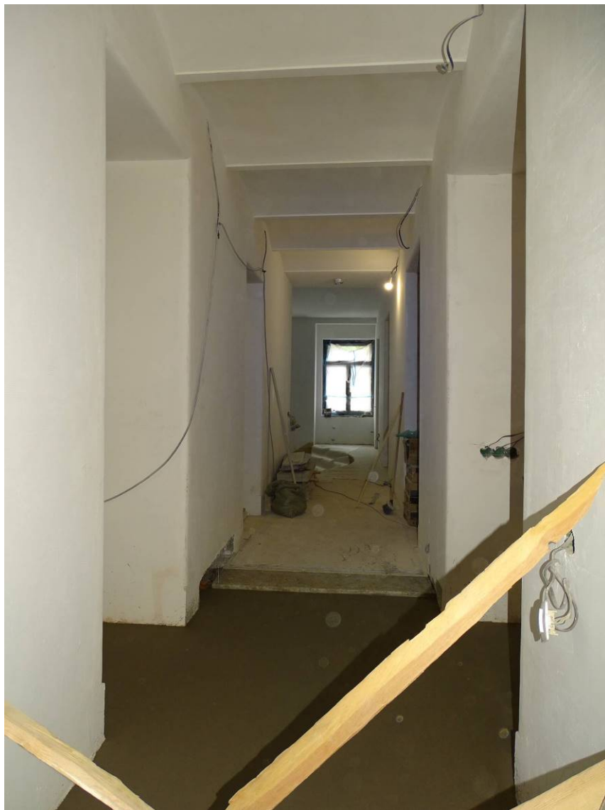
Илл. 05. Здание по адресу: г. Санкт-Петербург, наб. Крюкова кан., д. 23, лит. А. Квартира № 9. 1-й этаж. Пом. 1/6,8. Съемка 08.06.2022 г. Полетаikin В.В.
