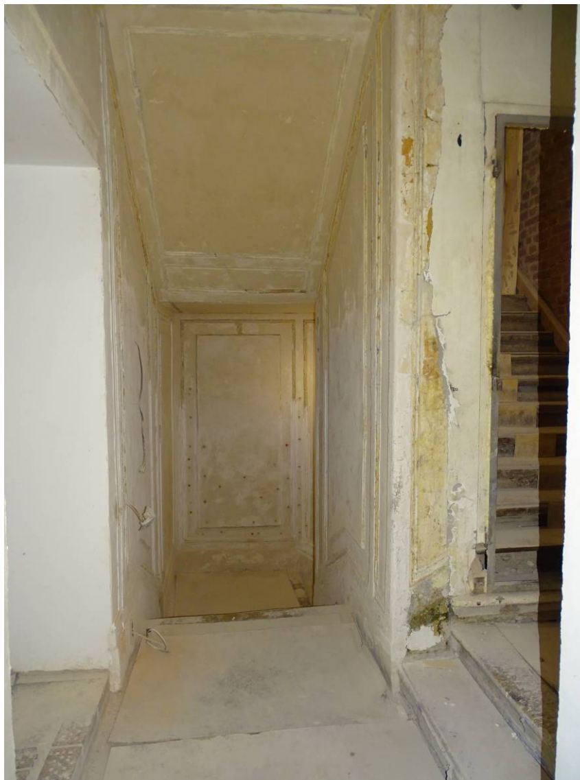
Илл. 29. Здание по адресу: г. Санкт-Петербург, наб. Крюкова кан., д. 23, лит. А. Квартира № 9. Лестница 2-ЛК. 2-й этаж. Съемка 08.06.2022 г. Полетайкин В.В.
