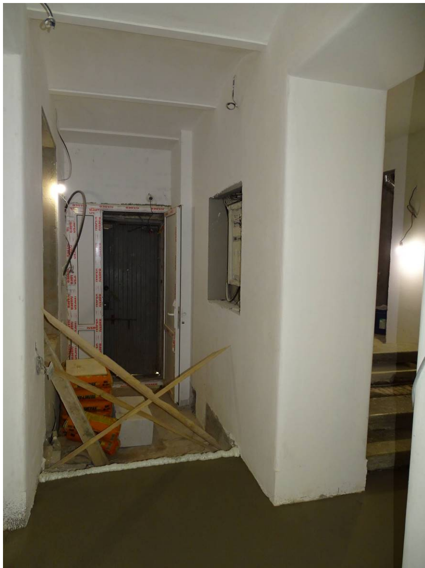
Илл. 07. Здание по адресу: г. Санкт-Петербург, наб. Крюкова кан., д. 23, лит. А. Квартира № 9. 1-й этаж. Пом. 1/6,8. Съемка 08.06.2022 г. Полетаikin В.В.
