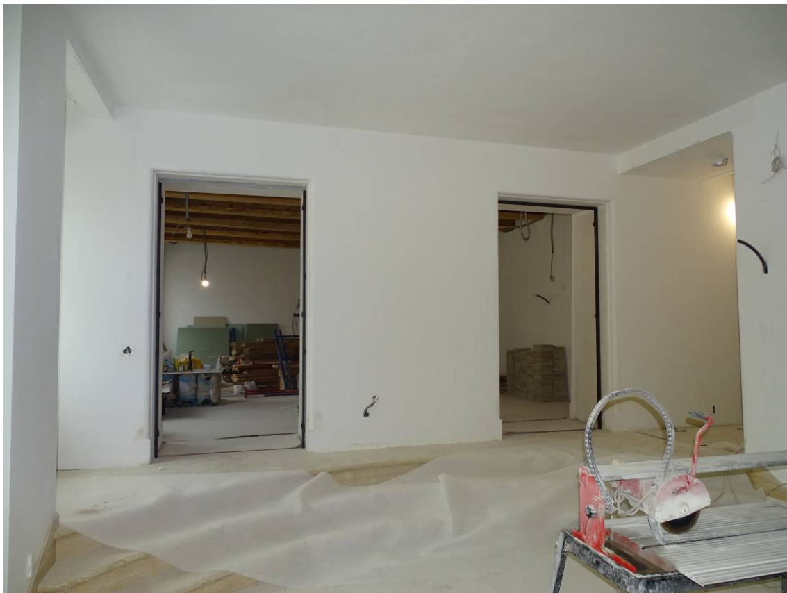
Илл. 11. Здание по адресу: г. Санкт-Петербург, наб. Крюкова кан., д. 23, лит. А. Квартира № 9. 1-й этаж. Пом. 13/12,7; 12/23,6. Съёмка 08.06.2022 г. Полетайкин В.В.
