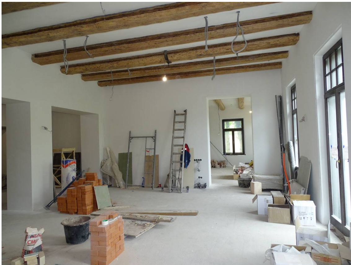
Илл. 18. Здание по адресу: г. Санкт-Петербург, наб. Крюкова кан., д. 23, лит. А. Квартира № 9. 2-й этаж. Пом. 35/15,3; 34/34,4. Съёмка 08.06.2022 г. Полетайкин В.В.
