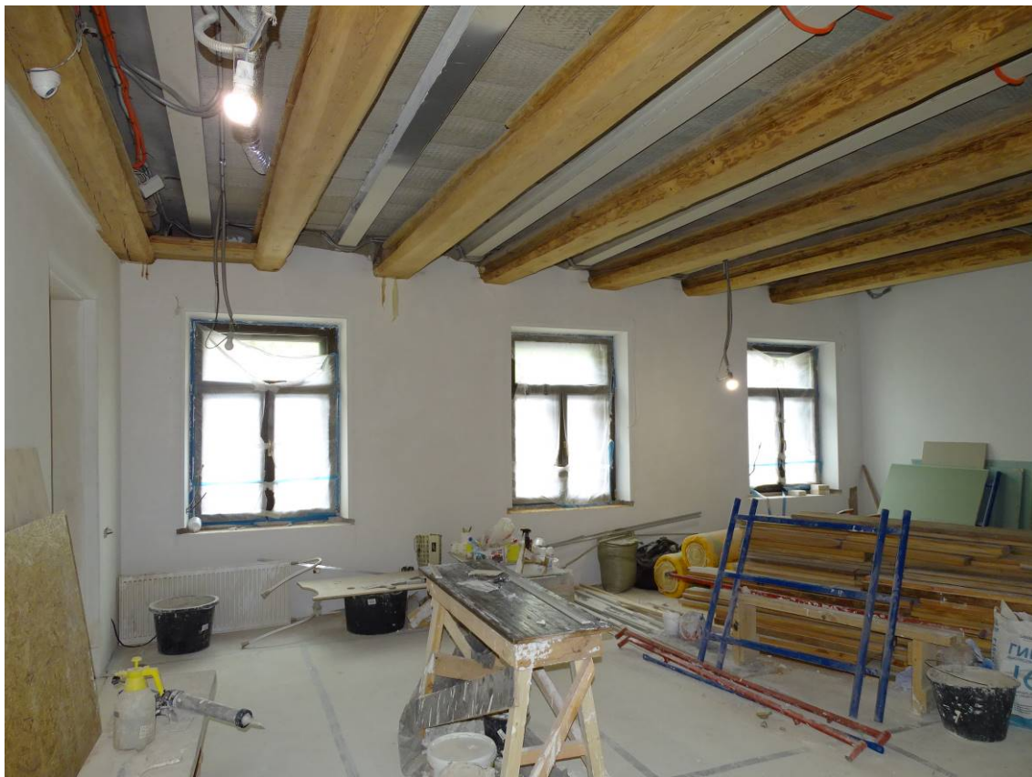
Илл. 13. Здание по адресу: г. Санкт-Петербург, наб. Крюкова кан., д. 23, лит. А. Квартира № 9. 1-й этаж. Пом. 16/18,2; 17/31,9. Съёмка 08.06.2022 г. Полетайкин В.В.
