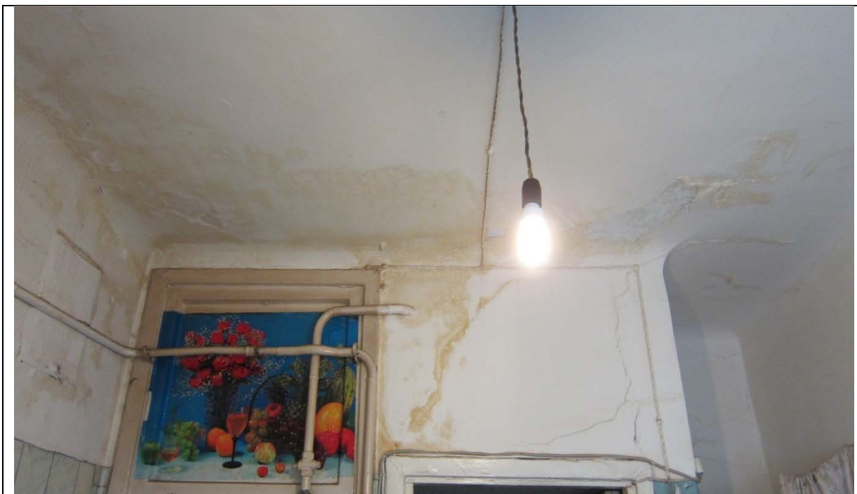
8. Помещение №7. Фото: 28.05.2021 г.
