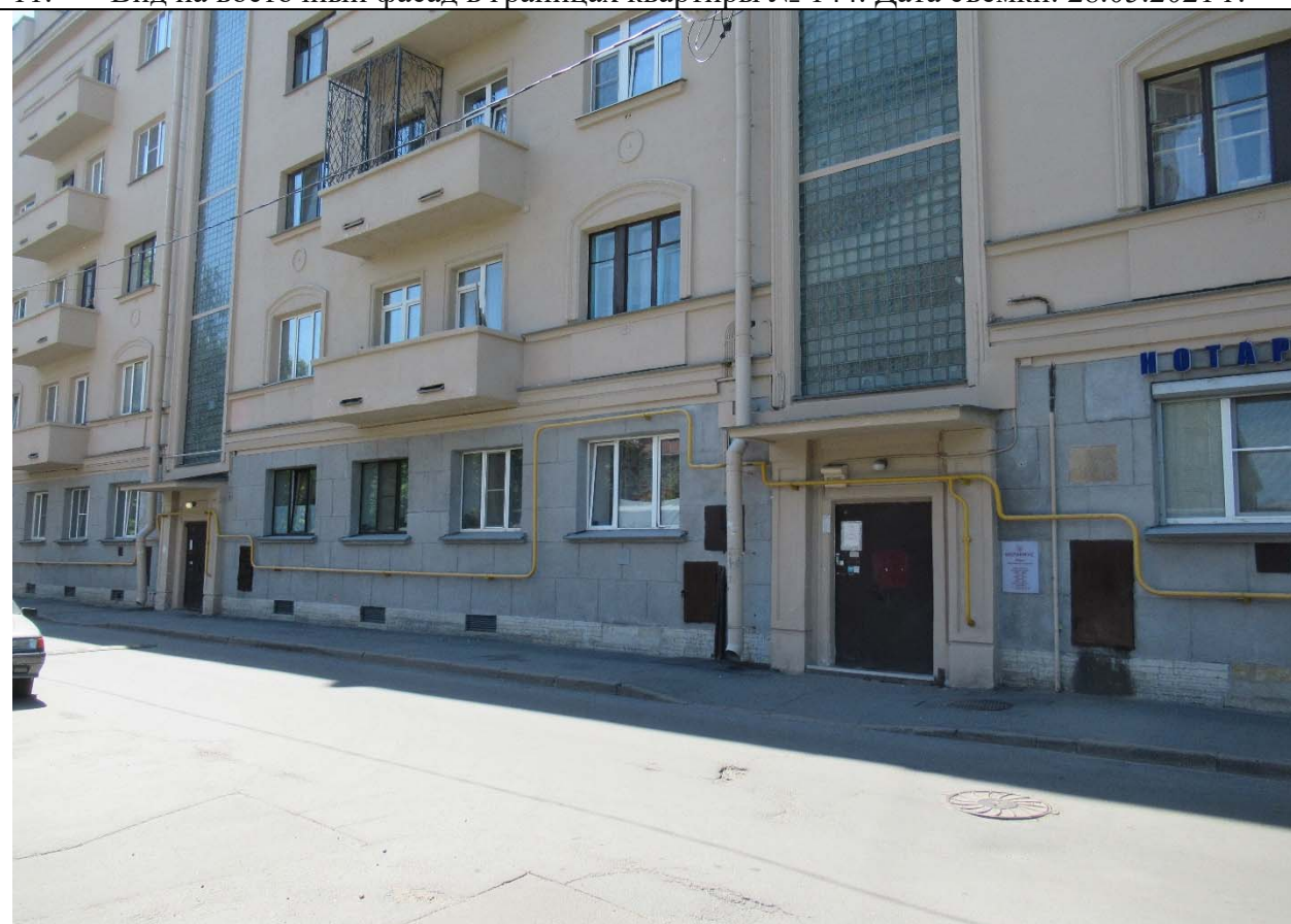
12. Вид на восточный фасад. Дата съемки: 28.05.2021 г.
