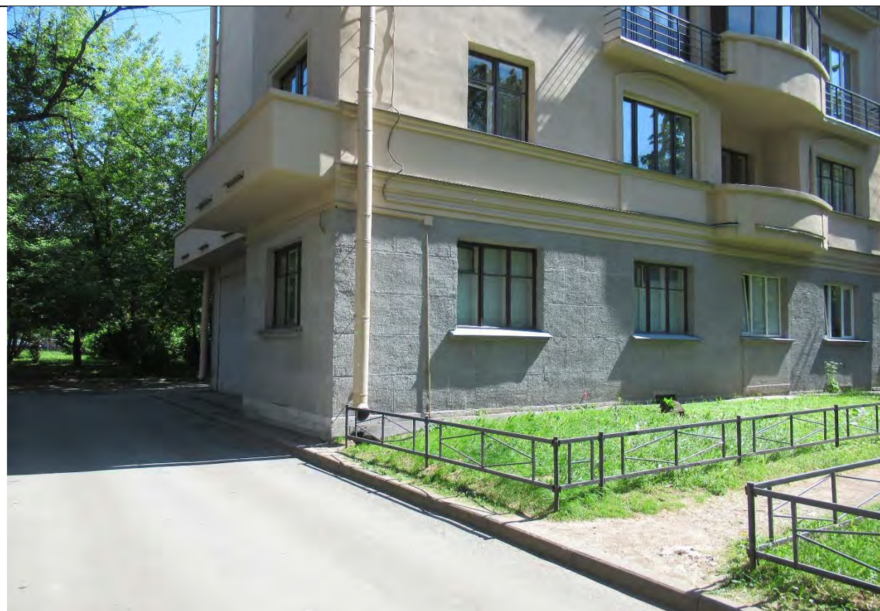
4. Вид на фасады с северо-запада, окна кв. № 144. Дата съемки: 28.05.2021 г.
