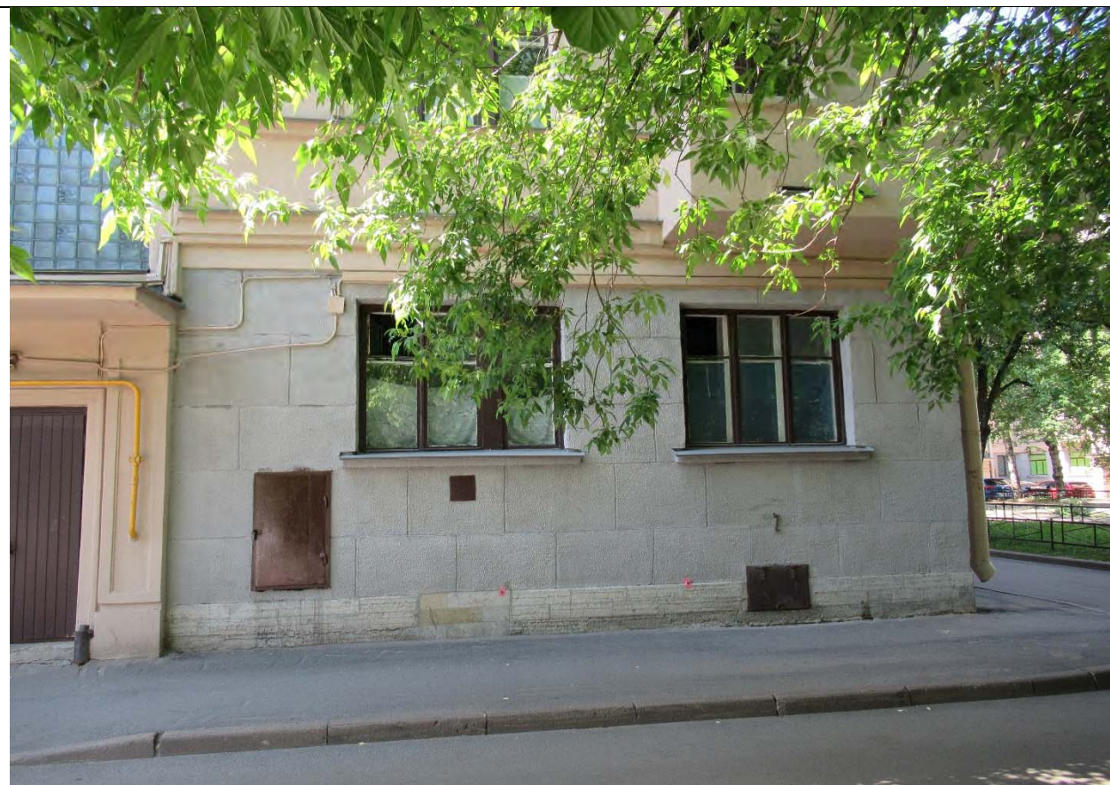
11. Вид на восточный фасад в границах квартиры № 144. Дата съемки: 28.05.2021 г.
