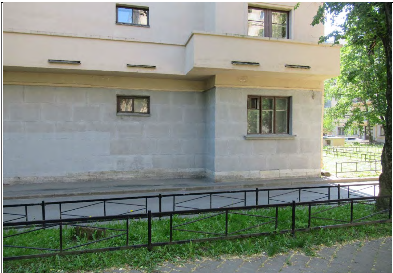
1. Вид на северный фасад, окно кв. № 144. Дата съемки: 28.05.2021 г.
