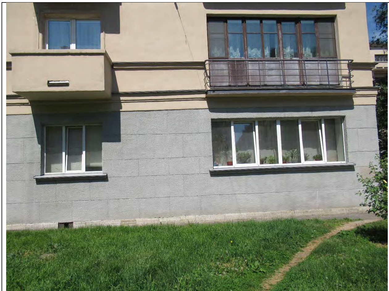
19. Вид на южный фасад. Дата съемки: 28.05.2021 г.
