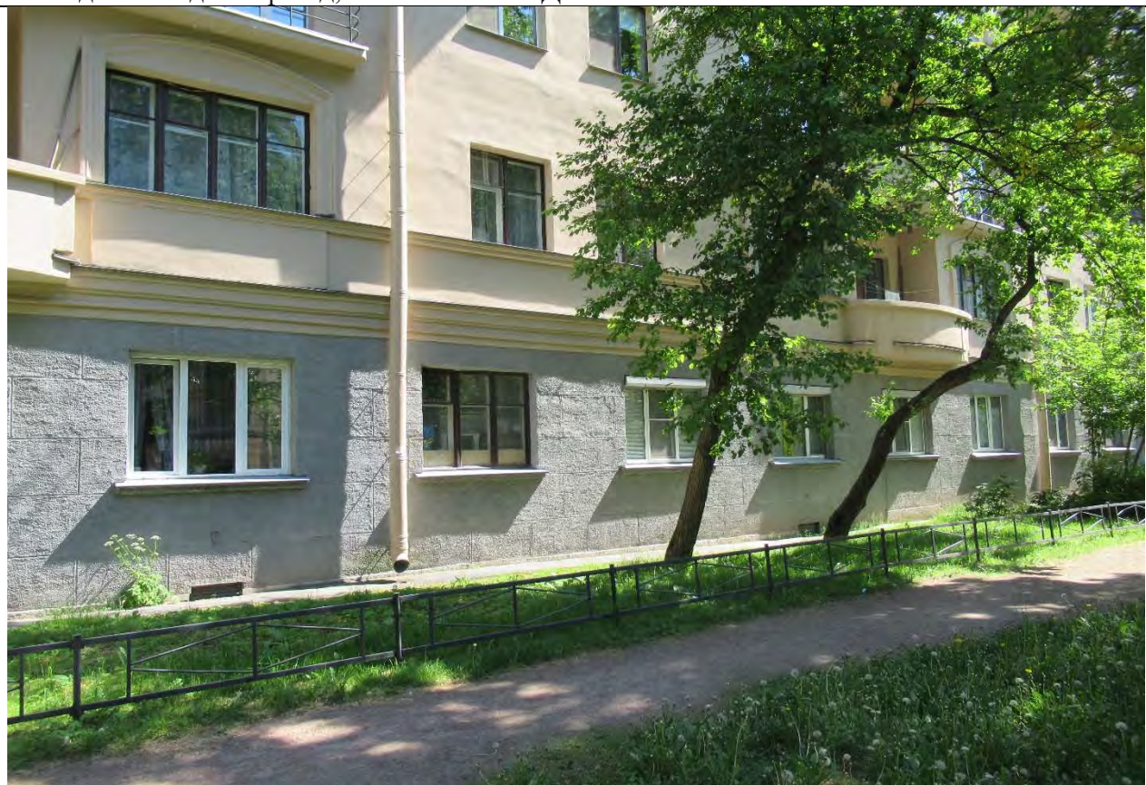
6. Вид на западный фасад, окна кв. № 144. Дата съемки: 28.05.2021 г.
