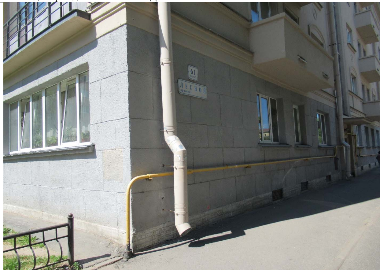
18. Вид на фасады с юго-востока. Дата съёмки: 28.05.2021 г.
