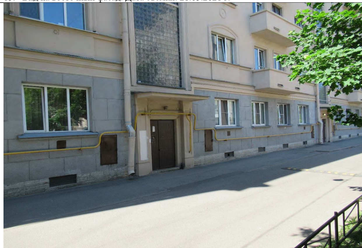
16. Вид на восточный фасад. Дата съемки: 28.05.2021 г.
