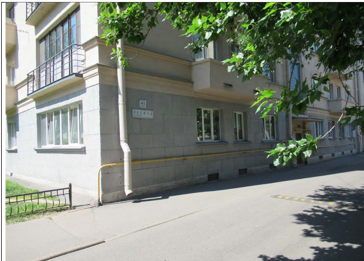
17. Вид на фасады с юго-востока. Дата съёмки: 28.05.2021 г.
