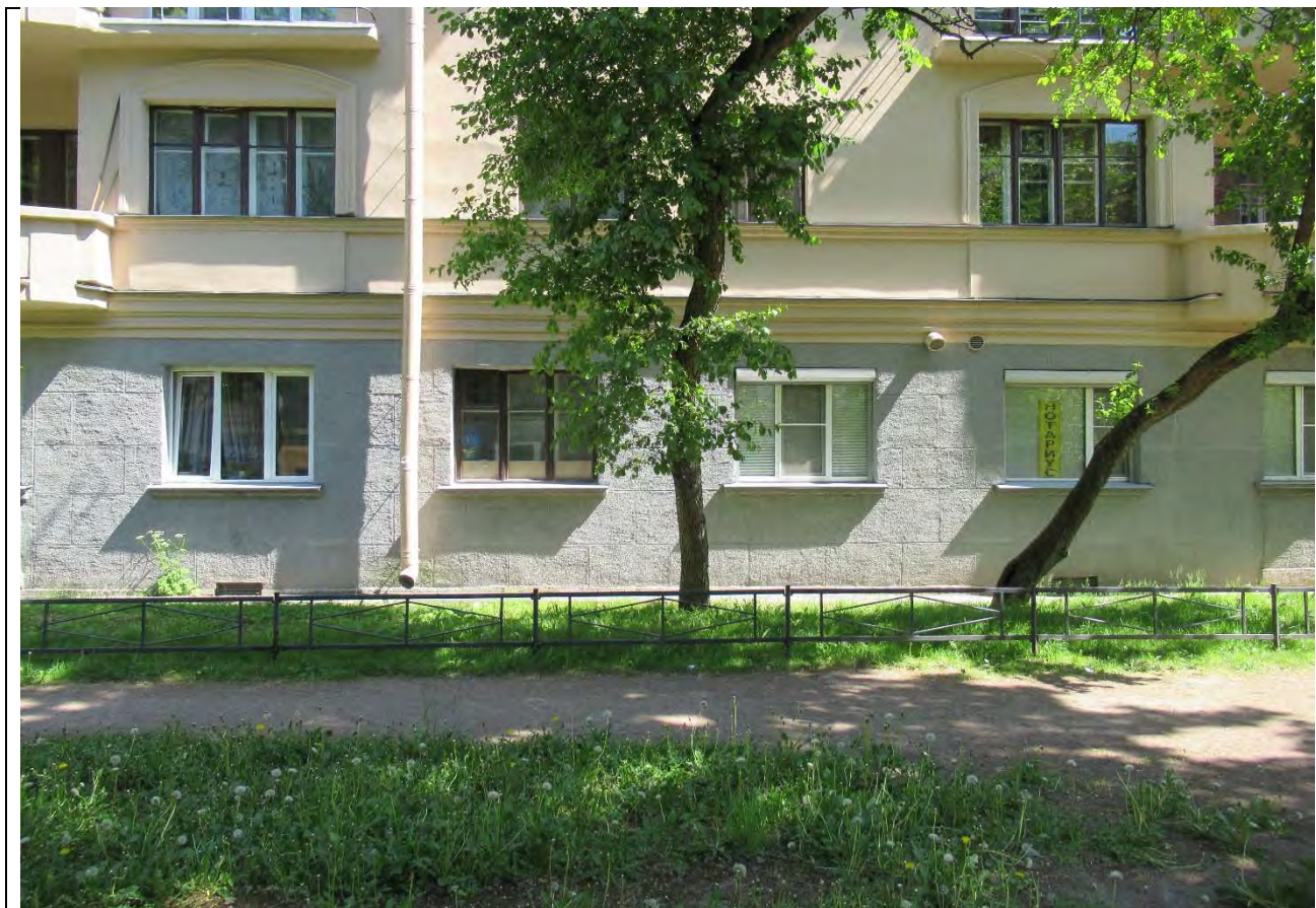
7. Вид на западный фасад. Дата съемки: 28.05.2021 г.
