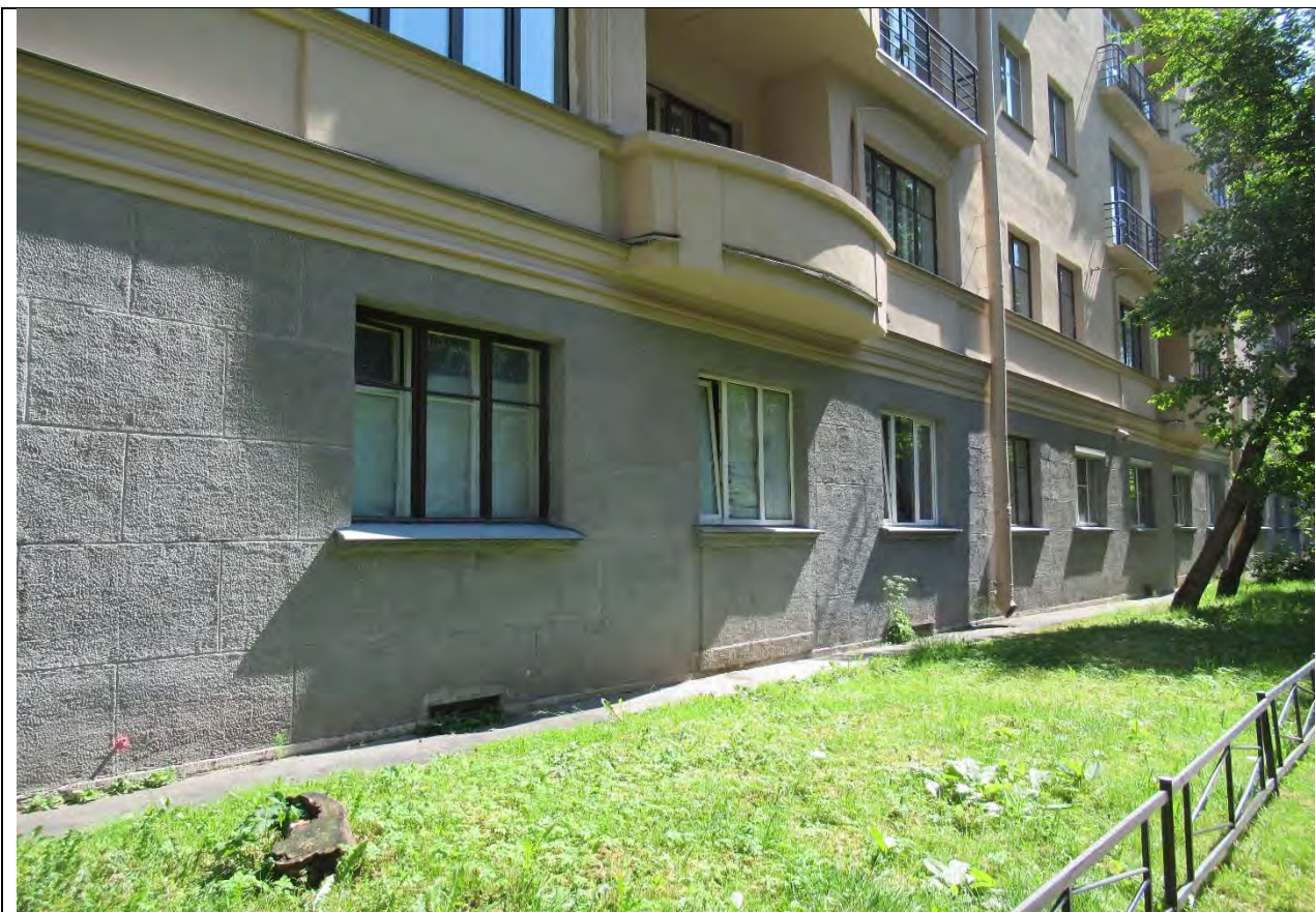
5. Вид на западный фасад, окна кв. №144. Дата съемки: 28.05.2021 г.
