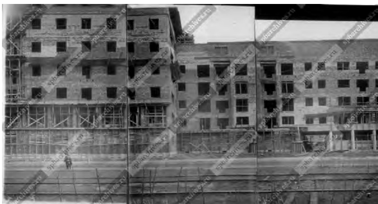
23. 1934-1937 гг. Фасад корп.№1 Дома специалистов на Лесном пр., 61 на этапе строительства. (ЦГАКФФД).
