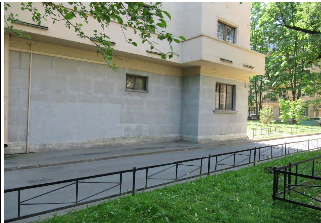
3. Вид на северный фасад, окно кв. № 144. Дата съемки: 28.05.2021 г.
