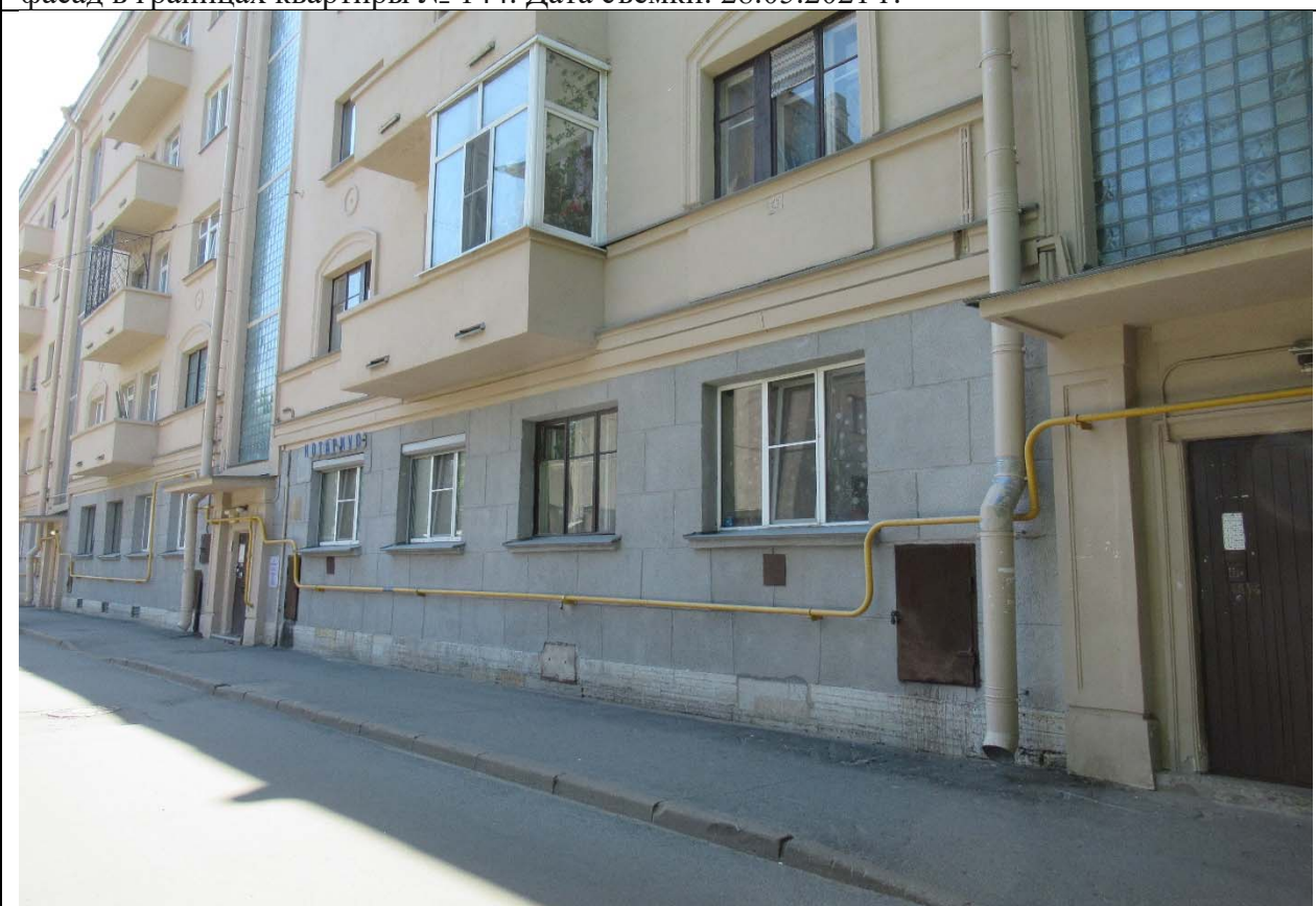
10. Вид на восточный фасад в границах квартиры № 144. Дата съемки: 28.05.2021 г.
