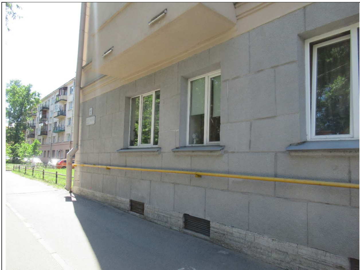
15. Вид на восточный фасад. Дата съемки: 28.05.2021 г.
