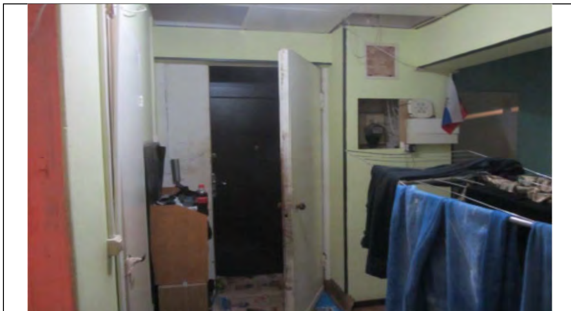
2. Помещение №1. Лестница на первый этаж. Фото: 28.05.2021 г.
