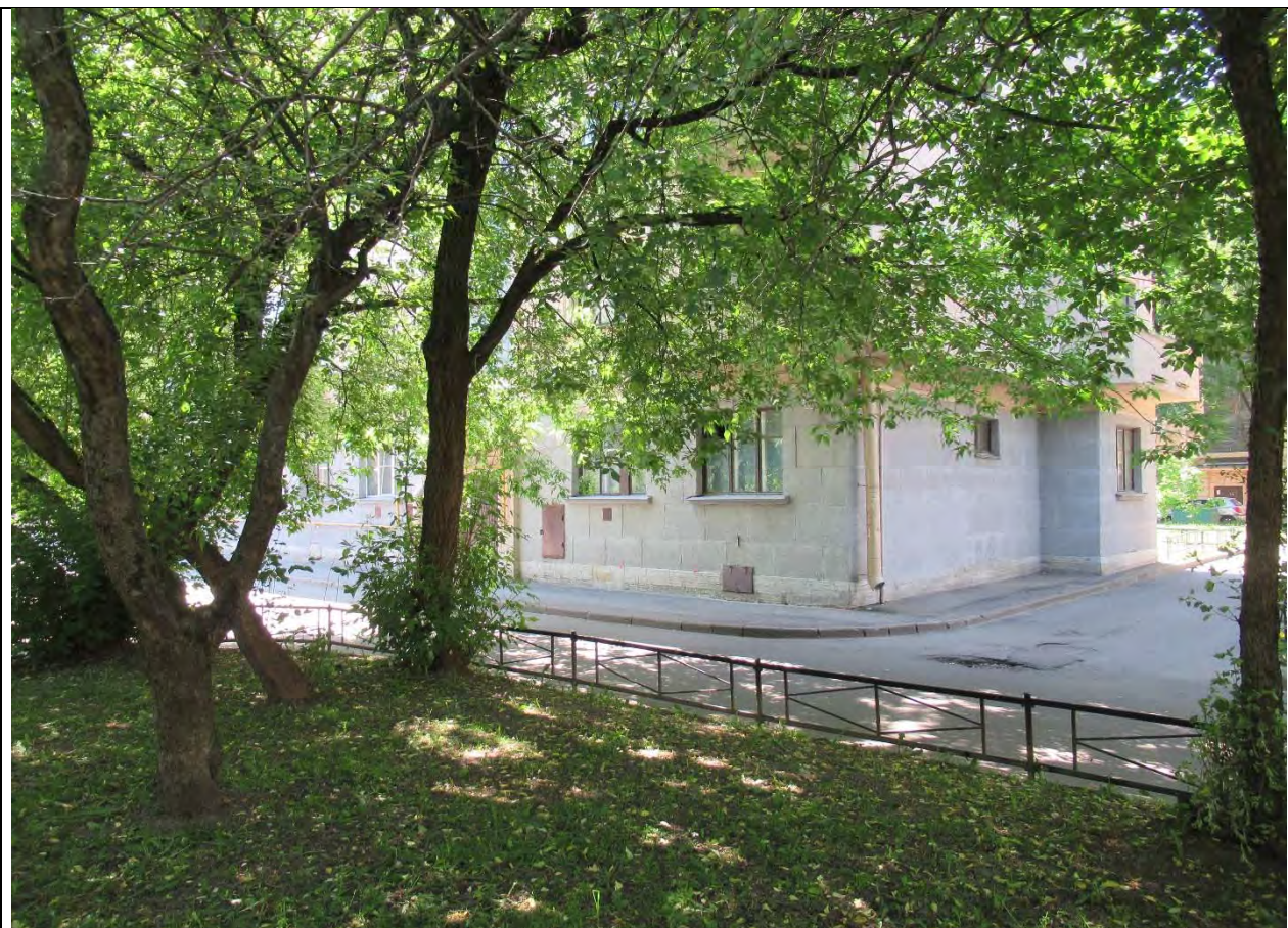
9. Вид на фасады с северо-востока, окно кв.№ 144 на северном фасаде, восточный фасад в границах квартиры № 144. Дата съемки: 28.05.2021 г.
