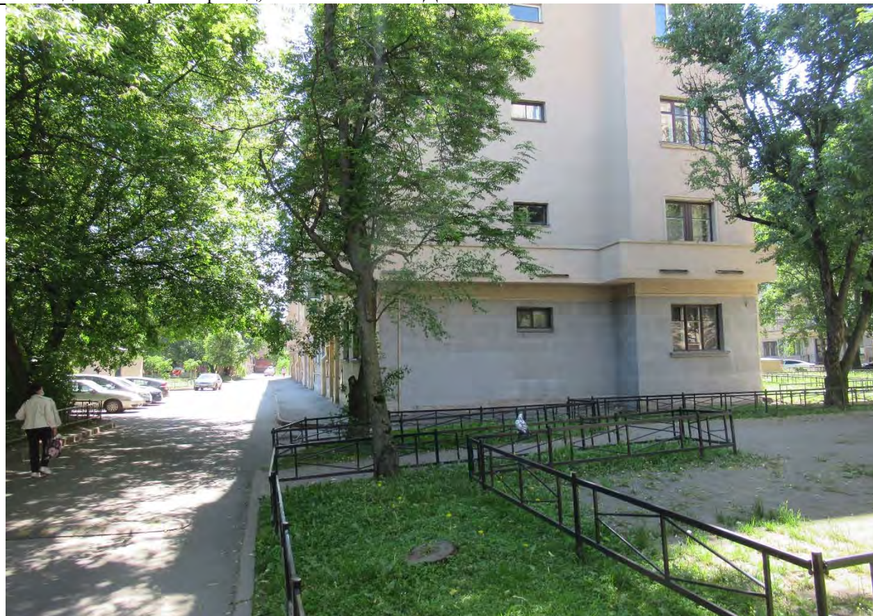
2. Вид на фасады с северо-востока, окно кв.№ 144. Дата съемки: 28.05.2021 г.
