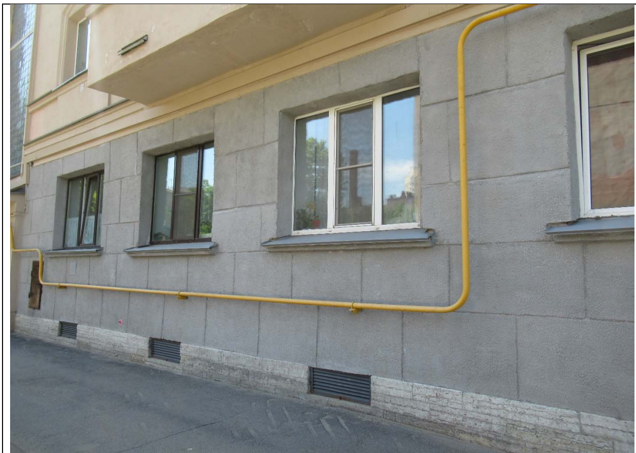
13. Вид на восточный фасад. Дата съемки: 28.05.2021 г.
