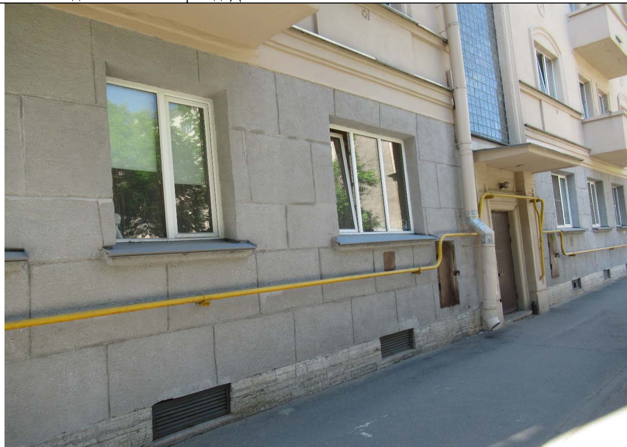
14. Вид на восточный фасад. Дата съемки: 28.05.2021 г.
