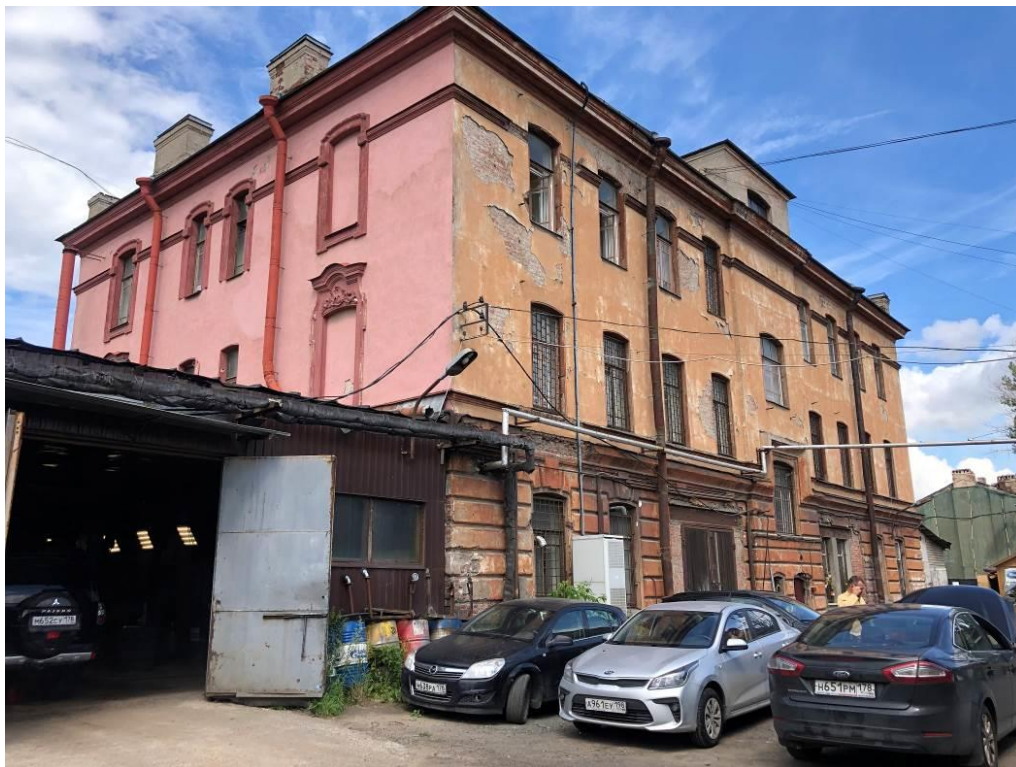
6. Объект культурного наследия регионального значения «Церковный дом», расположенный по адресу: г. Санкт-Петербург, Митрофаньевское шоссе, д. 4-6-8, литера А, входящий в состав объекта культурного наследия регионального значения «Митрофаньевское кладбище (православное и лютеранское) с территорией и зданиями», расположенного по адресу: г. Санкт-Петербург, Митрофаньевское шоссе, д. 4, 6, 8, 10, 16, кварталы 7501 Б-4, 7501 Б-12, 7501 Б-13, 7501 Б-14, 7509 А-1, 7509 А-2, 7509 А-3, 7509 А-4, 7509 А-5, 7517 Б-1, 7517 Б-2, 8002 А. Вид на Южный и восточные фасады. Общий вид в северном направлении.
