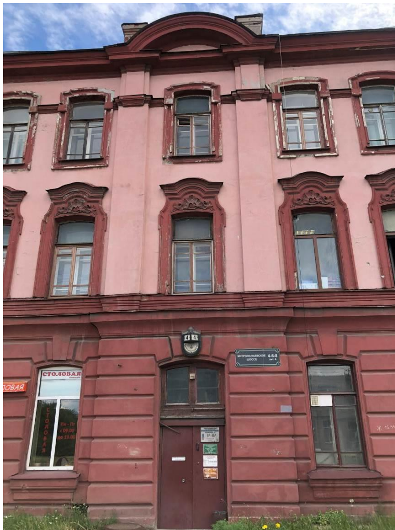
16. Объект культурного наследия регионального значения «Церковный дом», расположенный по адресу: г. Санкт-Петербург, Митрофаньевское шоссе, д. 4-6-8, литера А, входящий в состав объекта культурного наследия регионального значения «Митрофаньевское кладбище (православное и лютеранское) с территорией и зданиями», расположенного по адресу: г. Санкт-Петербург, Митрофаньевское шоссе, д. 4, 6, 8, 10, 16, кварталы 7501 Б-4, 7501 Б-12, 7501 Б-13, 7501 Б-14, 7509 А-1, 7509 А-2, 7509 А-3, 7509 А-4, 7509 А-5, 7517 Б-1, 7517 Б-2, 8002 А. Западный фасад. Фрагмент.
