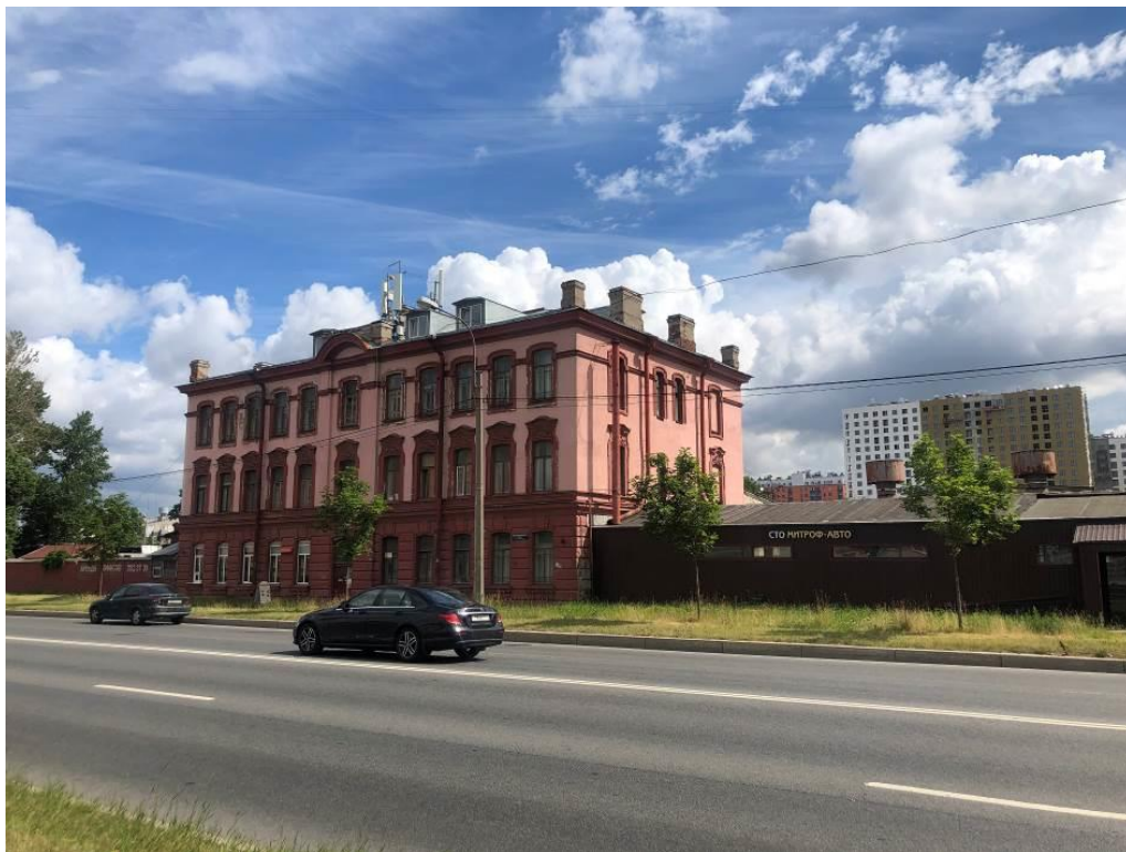
2. Объект культурного наследия регионального значения «Церковный дом», расположенный по адресу: г. Санкт-Петербург, Митрофаньевское шоссе, д. 4-6-8, литера А, входящий в состав объекта культурного наследия регионального значения «Митрофаньевское кладбище (православное и лютеранское) с территорией и зданиями», расположенного по адресу: г. Санкт-Петербург, Митрофаньевское шоссе, д. 4, 6, 8, 10, 16, кварталы 7501 Б-4, 7501 Б-12, 7501 Б-13, 7501 Б-14, 7509 А-1, 7509 А-2, 7509 А-3, 7509 А-4, 7509 А-5, 7517 Б-1, 7517 Б-2, 8002 А. Вид на Западный и Южный фасады. Общий вид со стороны Митрофаньевского шоссе.
