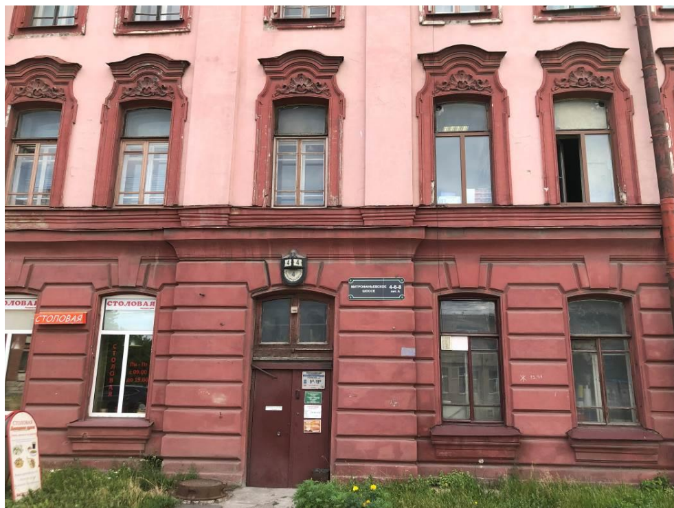
14. Объект культурного наследия регионального значения «Церковный дом», расположенный по адресу: г. Санкт-Петербург, Митрофаньевское шоссе, д. 4-6-8, литера А, входящий в состав объекта культурного наследия регионального значения «Митрофаньевское кладбище (православное и лютеранское) с территорией и зданиями», расположенного по адресу: г. Санкт-Петербург, Митрофаньевское шоссе, д. 4, 6, 8, 10, 16, кварталы 7501 Б-4, 7501 Б-12, 7501 Б-13, 7501 Б-14, 7509 А-1, 7509 А-2, 7509 А-3, 7509 А-4, 7509 А-5, 7517 Б-1, 7517 Б-2, 8002 А. Западный фасад. Фрагмент.
