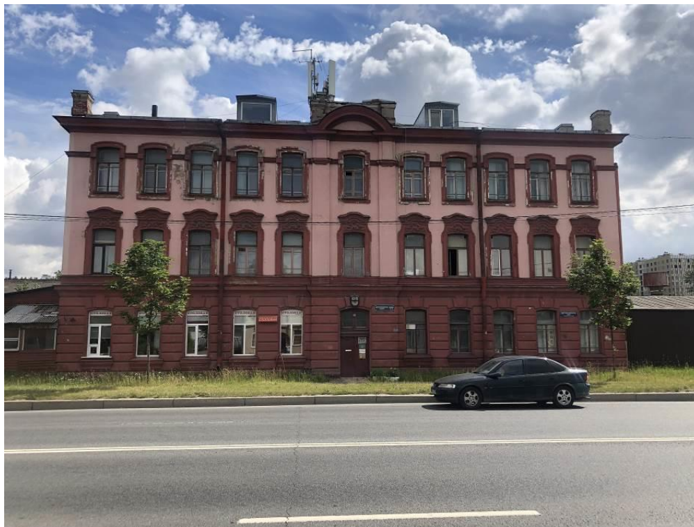
1. Объект культурного наследия регионального значения «Церковный дом», расположенный по адресу: г. Санкт-Петербург, Митрофаньевское шоссе, д. 4-6-8, литера А, входящий в состав объекта культурного наследия регионального значения «Митрофаньевское кладбище (православное и лютеранское) с территорией и зданиями», расположенного по адресу: г. Санкт-Петербург, Митрофаньевское шоссе, д. 4, 6, 8, 10, 16, кварталы 7501 Б-4, 7501 Б-12, 7501 Б-13, 7501 Б-14, 7509 А-1, 7509 А-2, 7509 А-3, 7509 А-4, 7509 А-5, 7517 Б-1, 7517 Б-2, 8002 А. Западный фасад. Общий вид со стороны Митрофаньевского шоссе.
