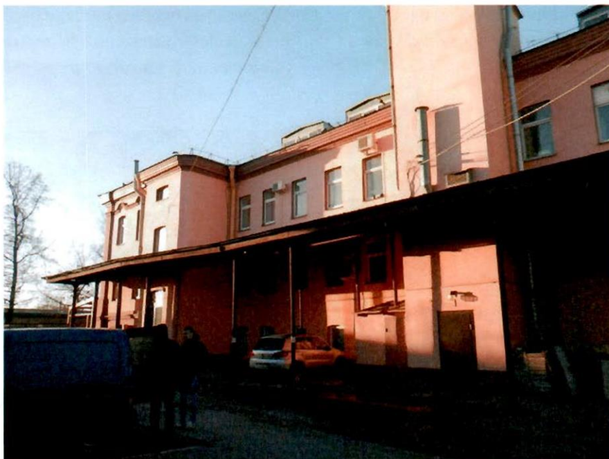
15) Объект культурного наследия регионального значения «Дом причта» Дворовый фасад.
