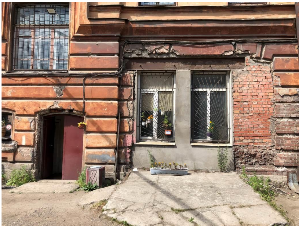
12. Объект культурного наследия регионального значения «Церковный дом», расположенный по адресу: г. Санкт-Петербург, Митрофаньевское шоссе, д. 4-6-8, литера А, входящий в состав объекта культурного наследия регионального значения «Митрофаньевское кладбище (православное и лютеранское) с территорией и зданиями», расположенного по адресу: г. Санкт-Петербург, Митрофаньевское шоссе, д. 4, 6, 8, 10, 16, кварталы 7501 Б-4, 7501 Б-12, 7501 Б-13, 7501 Б-14, 7509 А-1, 7509 А-2, 7509 А-3, 7509 А-4, 7509 А-5, 7517 Б-1, 7517 Б-2, 8002 А. Восточный фасад. Фрагмент.
