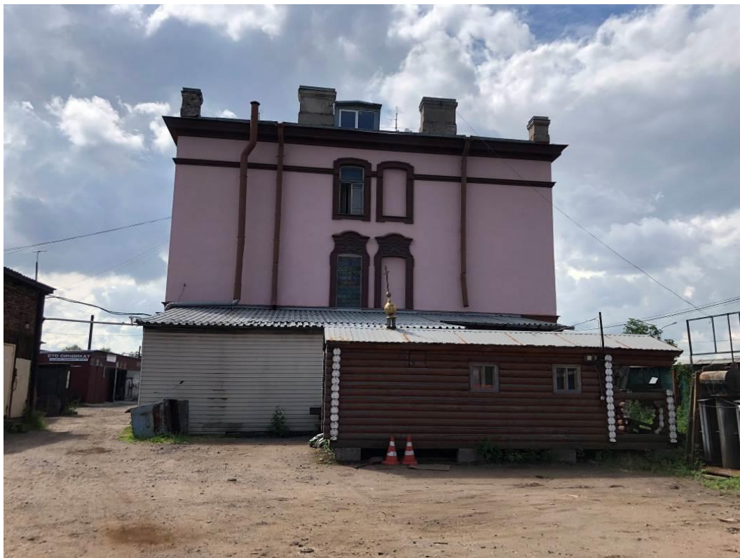
9. Объект культурного наследия регионального значения «Церковный дом», расположенный по адресу: г. Санкт-Петербург, Митрофаньевское шоссе, д. 4-6-8, литера А, входящий в состав объекта культурного наследия регионального значения «Митрофаньевское кладбище (православное и лютеранское) с территорией и зданиями», расположенного по адресу: г. Санкт-Петербург, Митрофаньевское шоссе, д. 4, 6, 8, 10, 16, кварталы 7501 Б-4, 7501 Б-12, 7501 Б-13, 7501 Б-14, 7509 А-1, 7509 А-2, 7509 А-3, 7509 А-4, 7509 А-5, 7517 Б-1, 7517 Б-2, 8002 А. Южный фасад. Общий вид в северном направлении.
