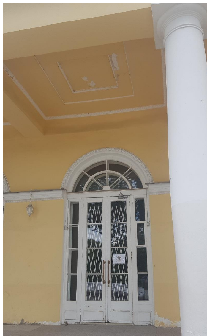
Фото 8. Дверной проем северного фасада.
