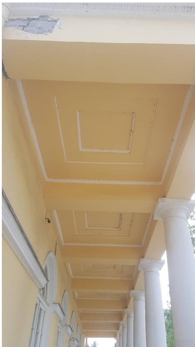
Фото 9. Потолок. Северный фасад.
