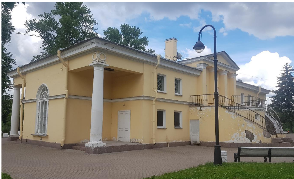
Фото 3. Вид на южный и западный фасады.
