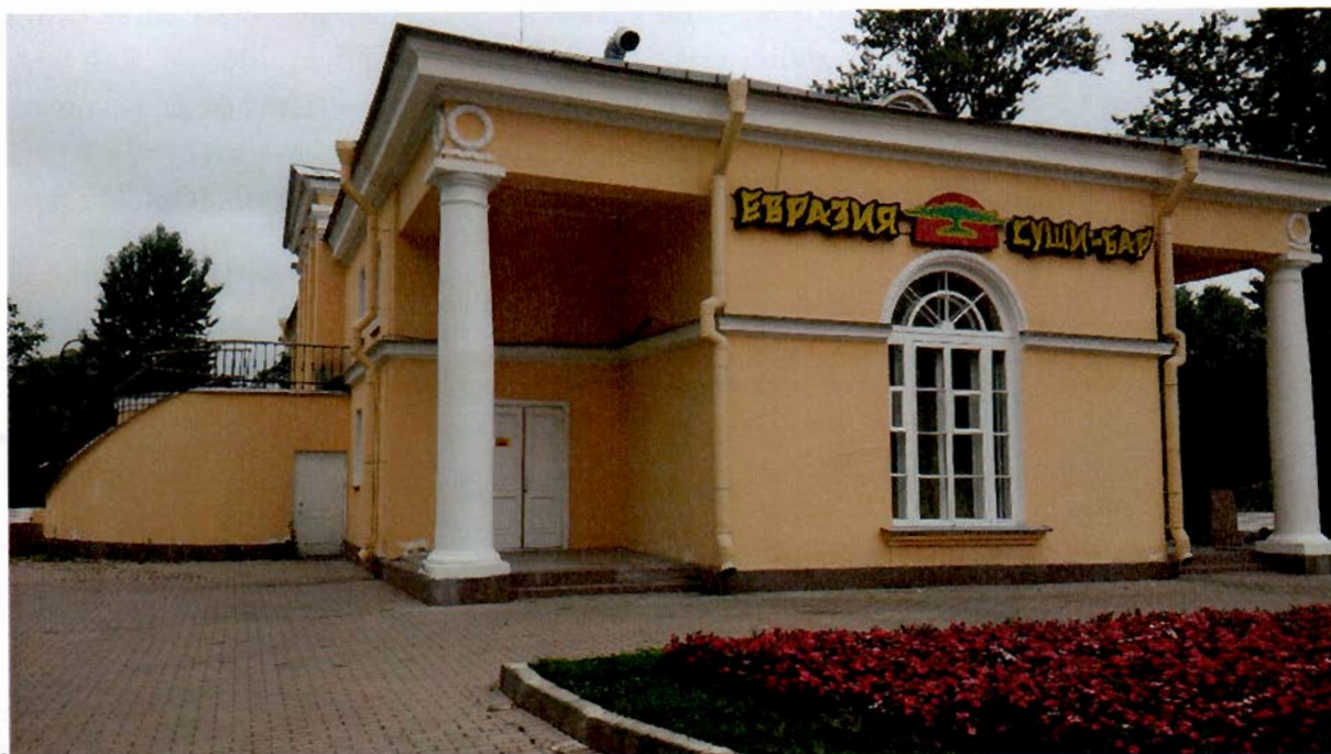
3, 4. Общий вид (восточный и южный фасады)
