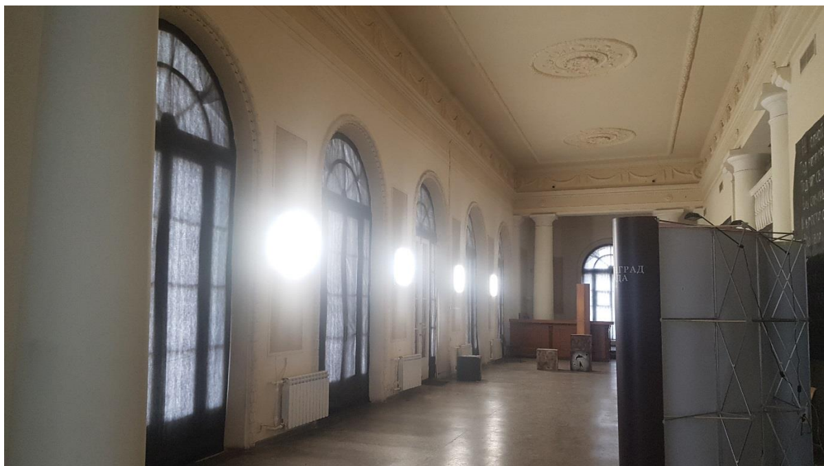
Фото 15. Помещение № 1. Вид на оконные и дверной проем.
