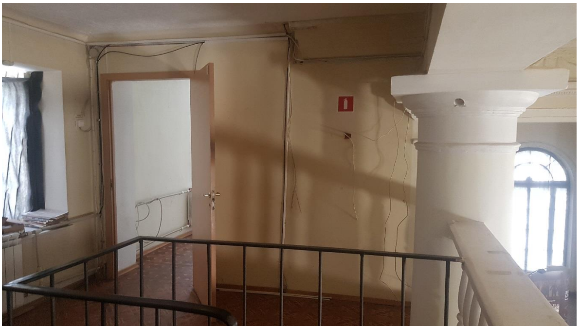
Фото 20. Помещение № 16. Вид в сторону помещения № 19.
