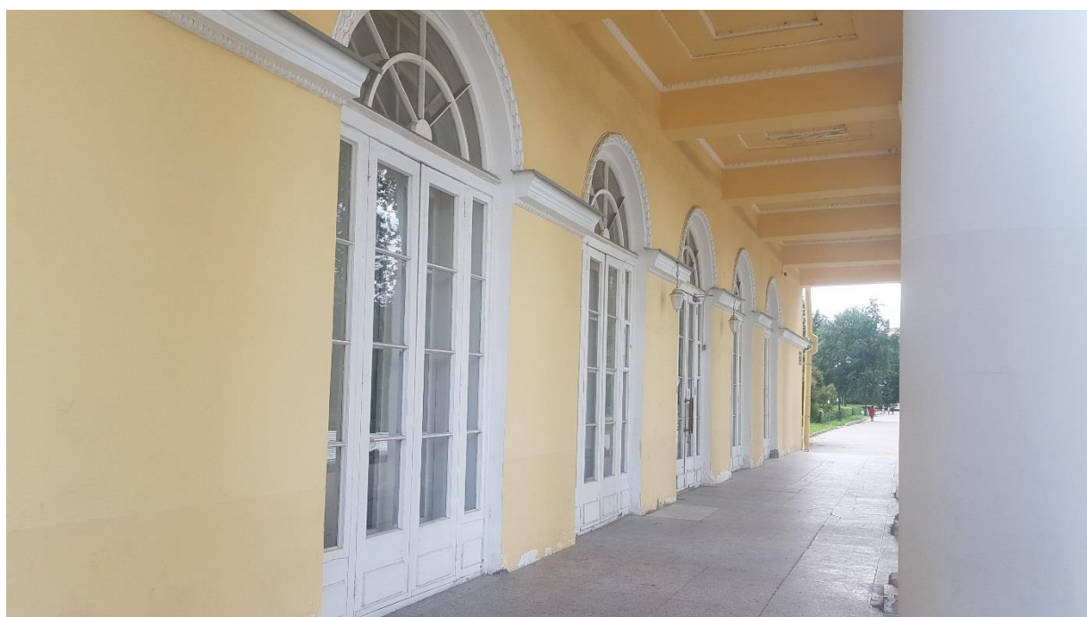
Фото 10. Оконные и дверные проемы. Северный фасад.
