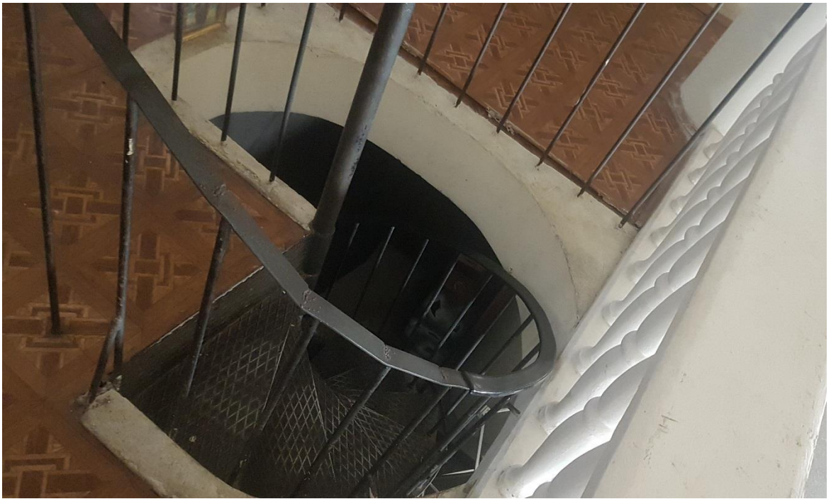
Фото 19. Помещение № 16. Вид на лестницу.
