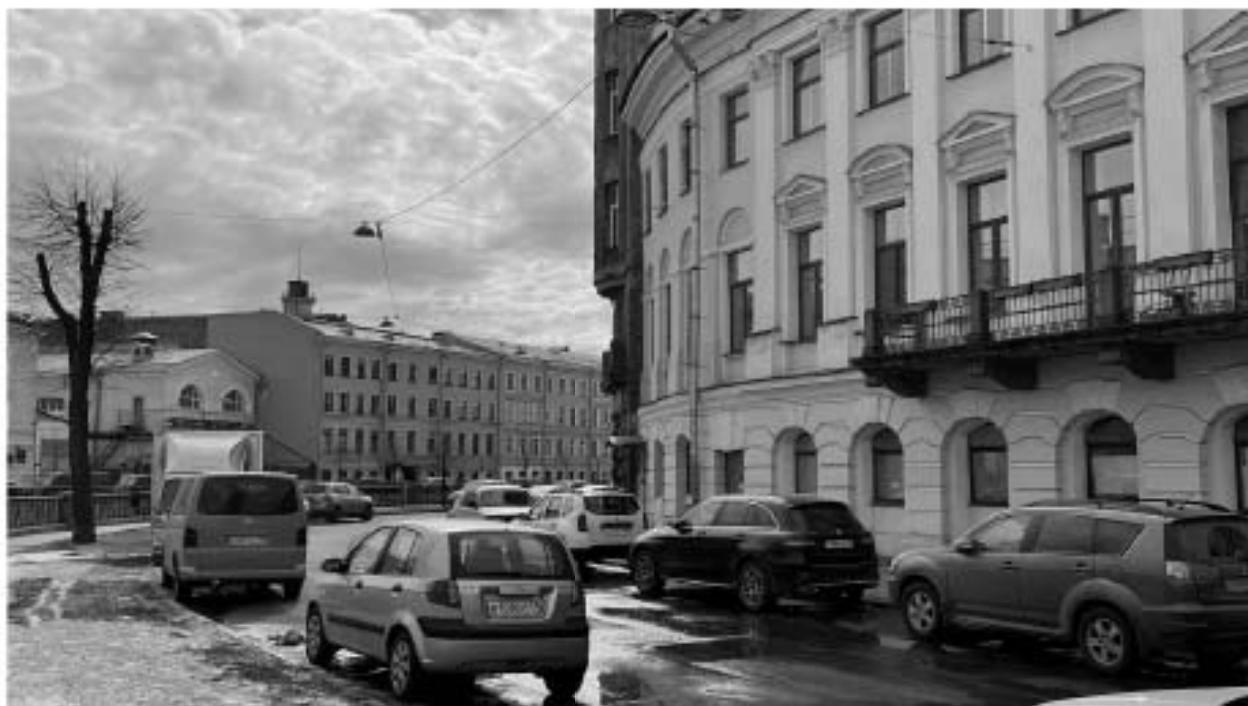
7. Общий вид восточного фасада дома №119-121 на наб. Канала Грибоедова;
