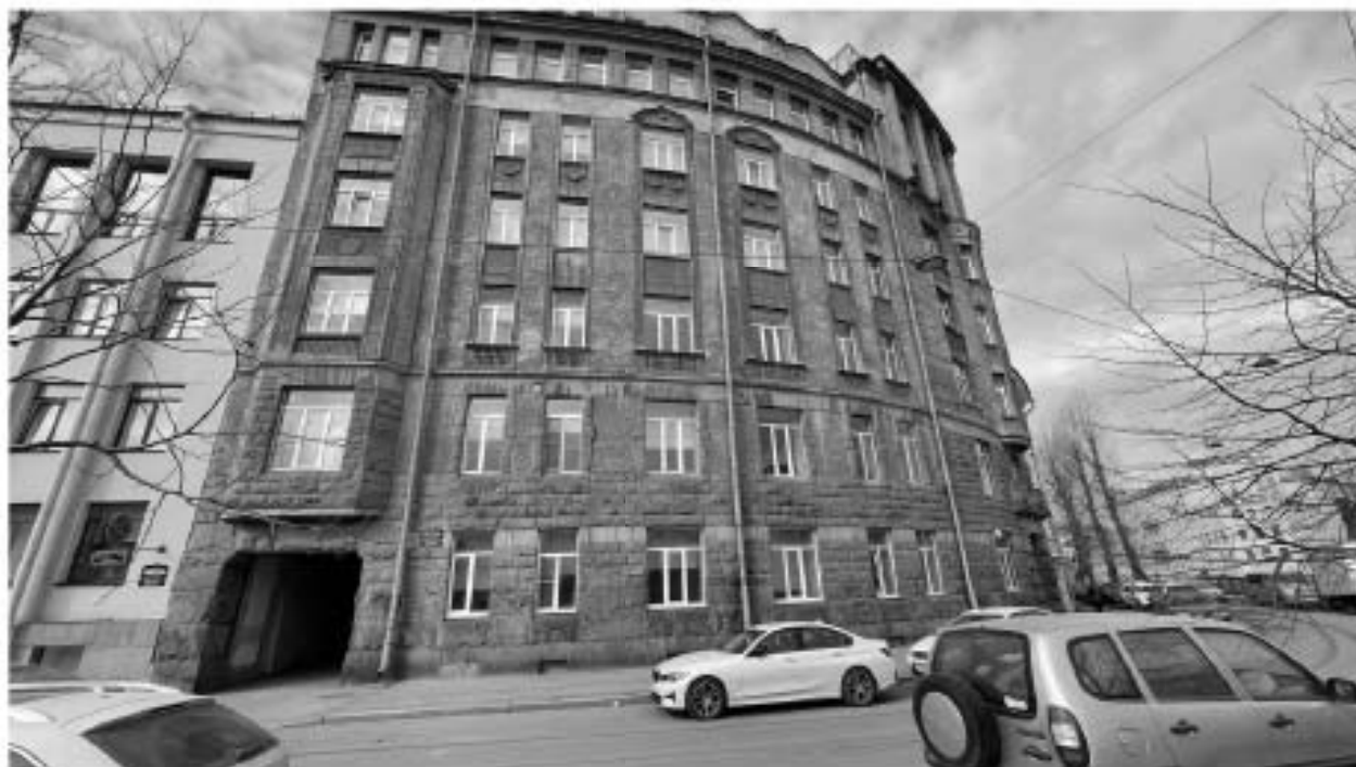
4. Общий вид восточного фасада дома №119-121 на наб. Канала Грибоедова;
