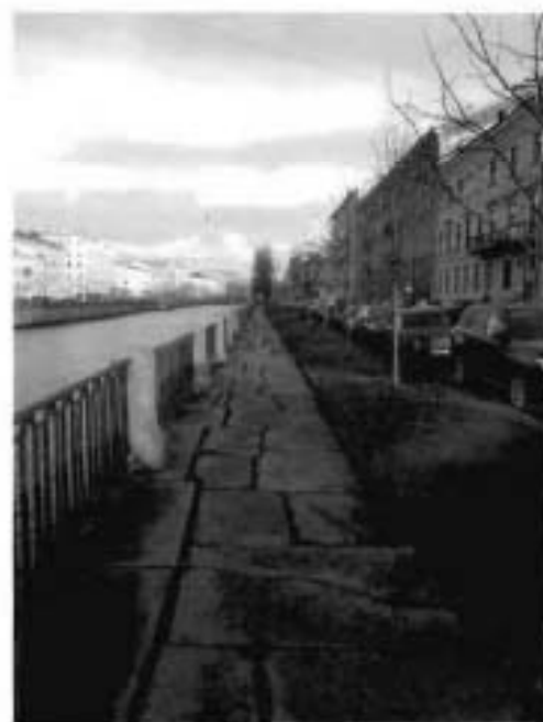
настил тротуара гранитными плитами, рисунок укладки плит;
