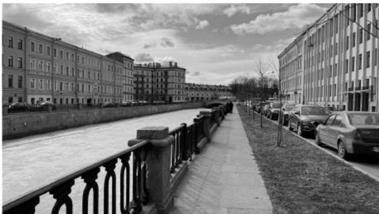
2. Вид на наб. Канала Грибоедова и Ново-Никольский мост в южном направлении;
