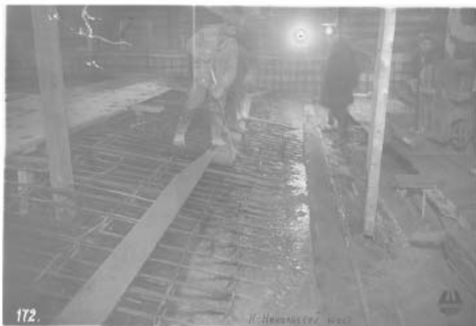
Ил.9. Никольский мост. Фотография. Ок. 1934 г. [Электронный ресурс].
