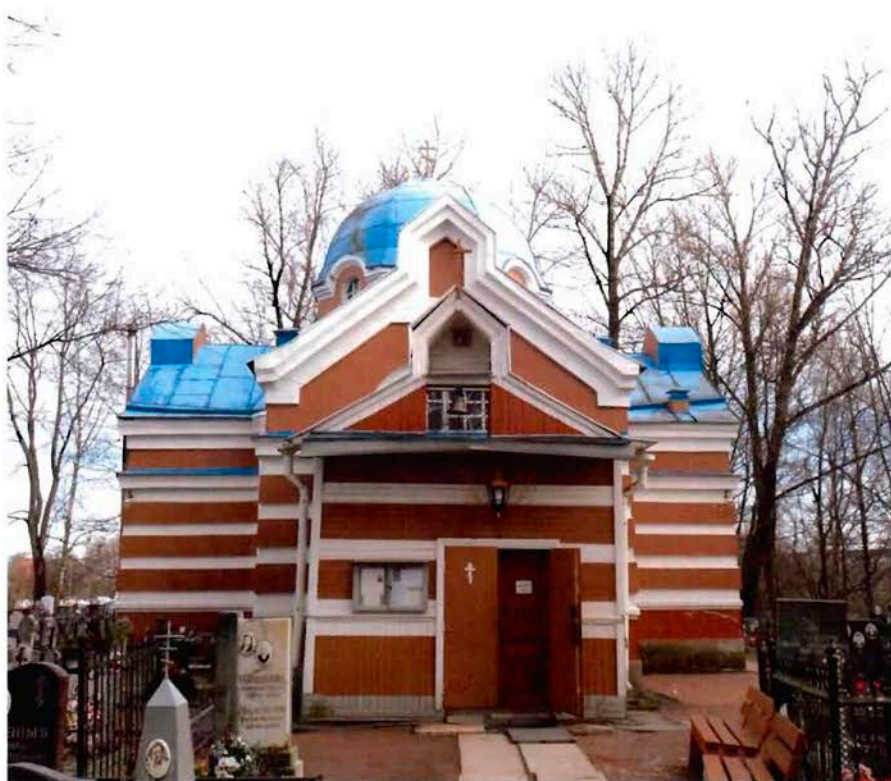
1. Лицевой фасад. Общий вид.
