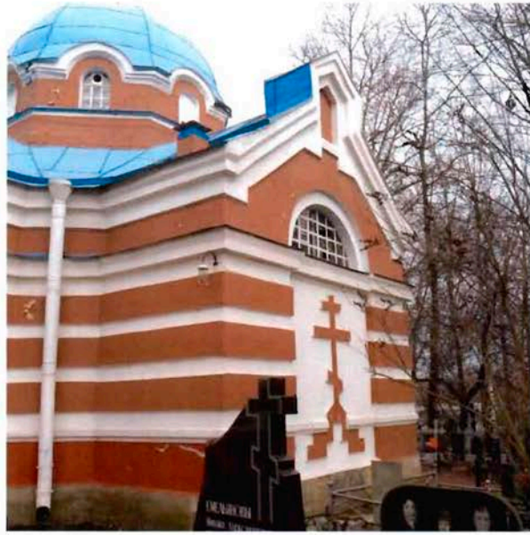
2. Южный фасад. Фрагмент.
