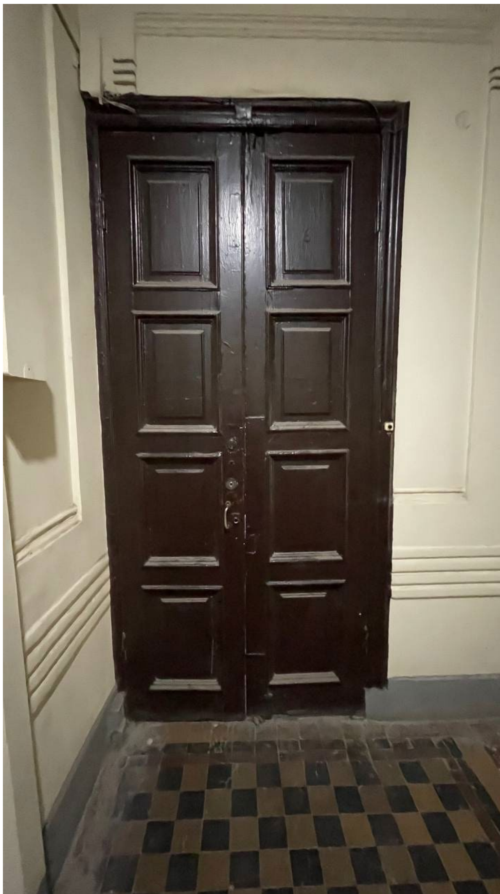
3. Вид на входную дверь квартиры № 6
