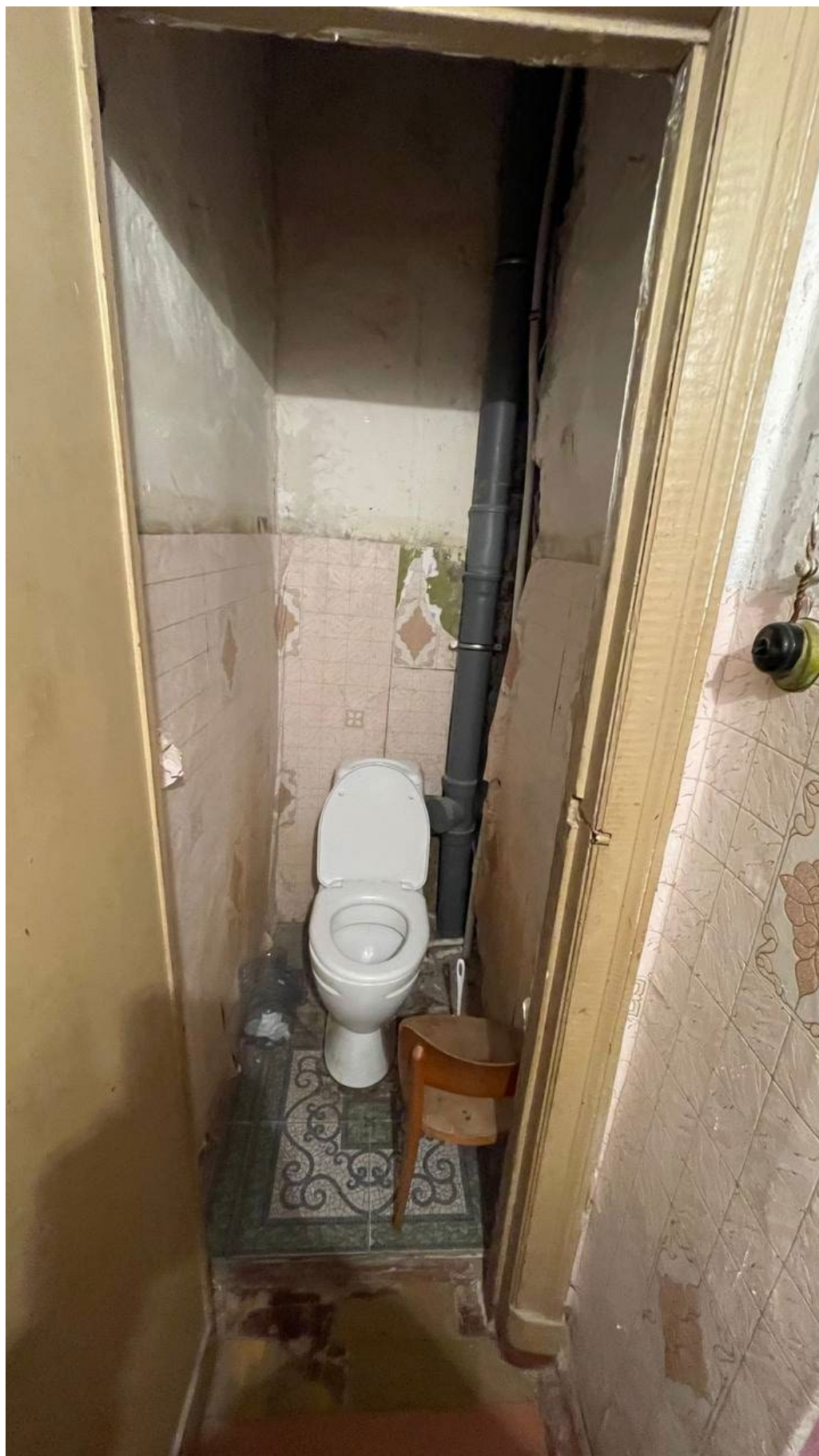
22. Фрагмент интеръера туалета (помещение № 9);
