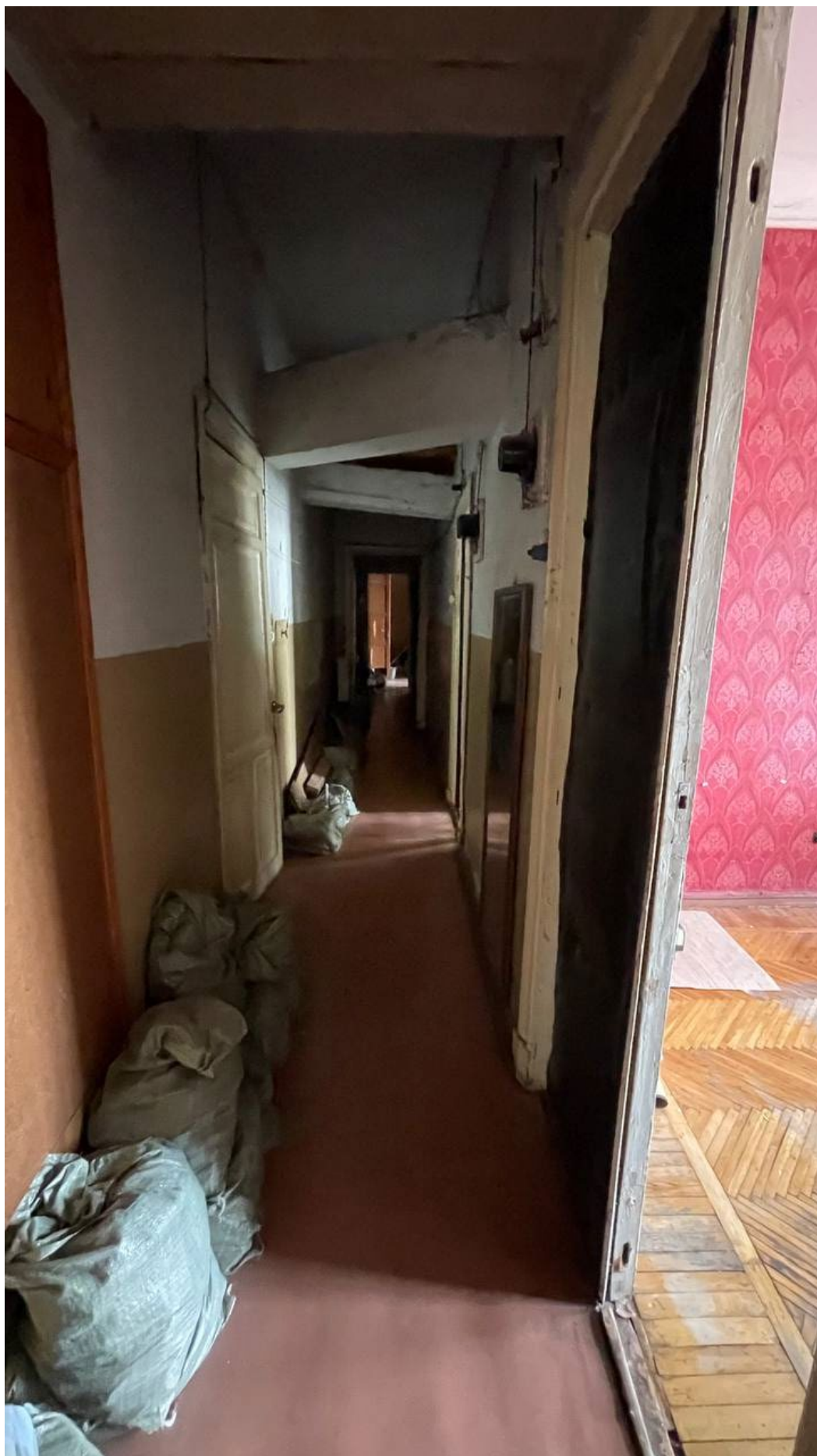
29. Фрагмент интеръера коридора (помещение №8);
