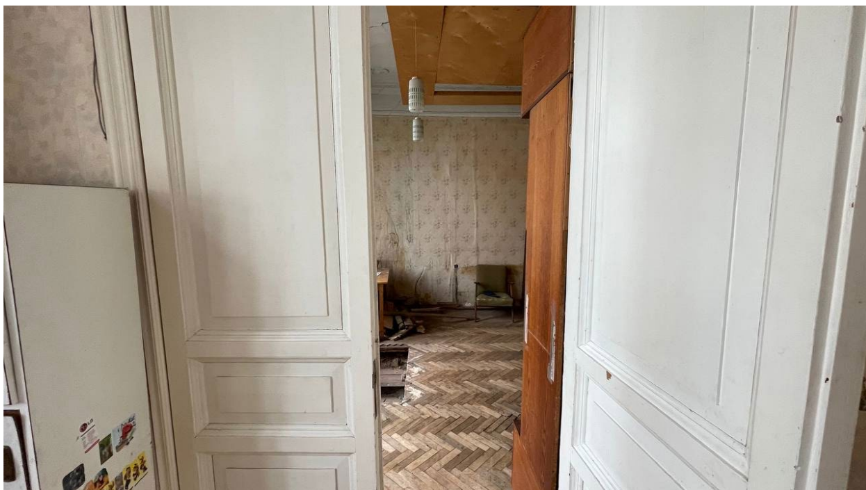
14. Вид на комнату (помещение № 4);
