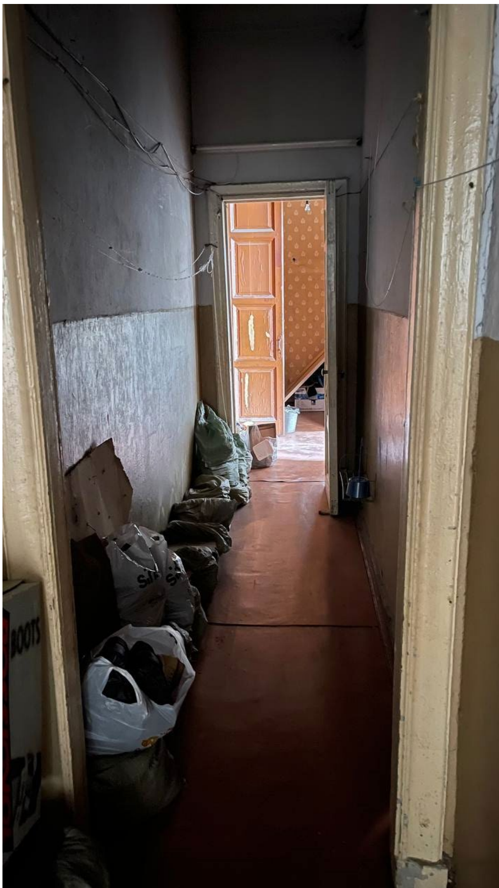
30. Фрагмент интеръера коридора (помещение №6);
