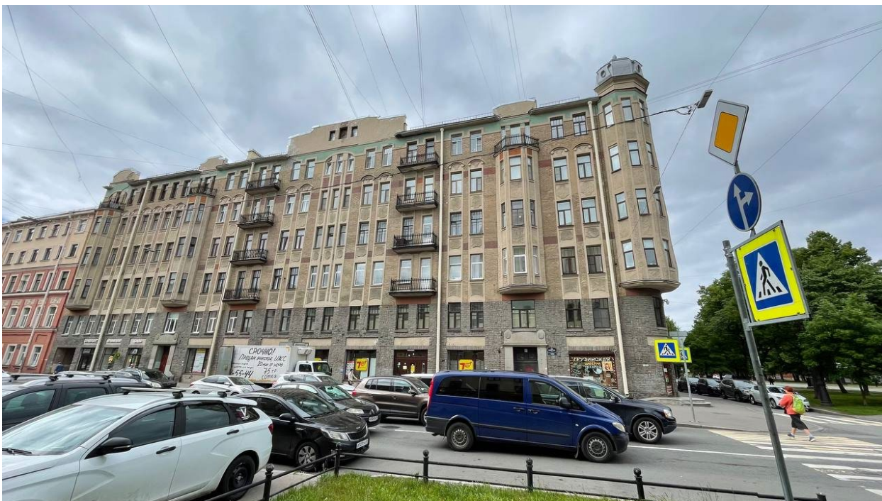
1. Вид на главный фасад здания по 19 линии В.О., 14;
