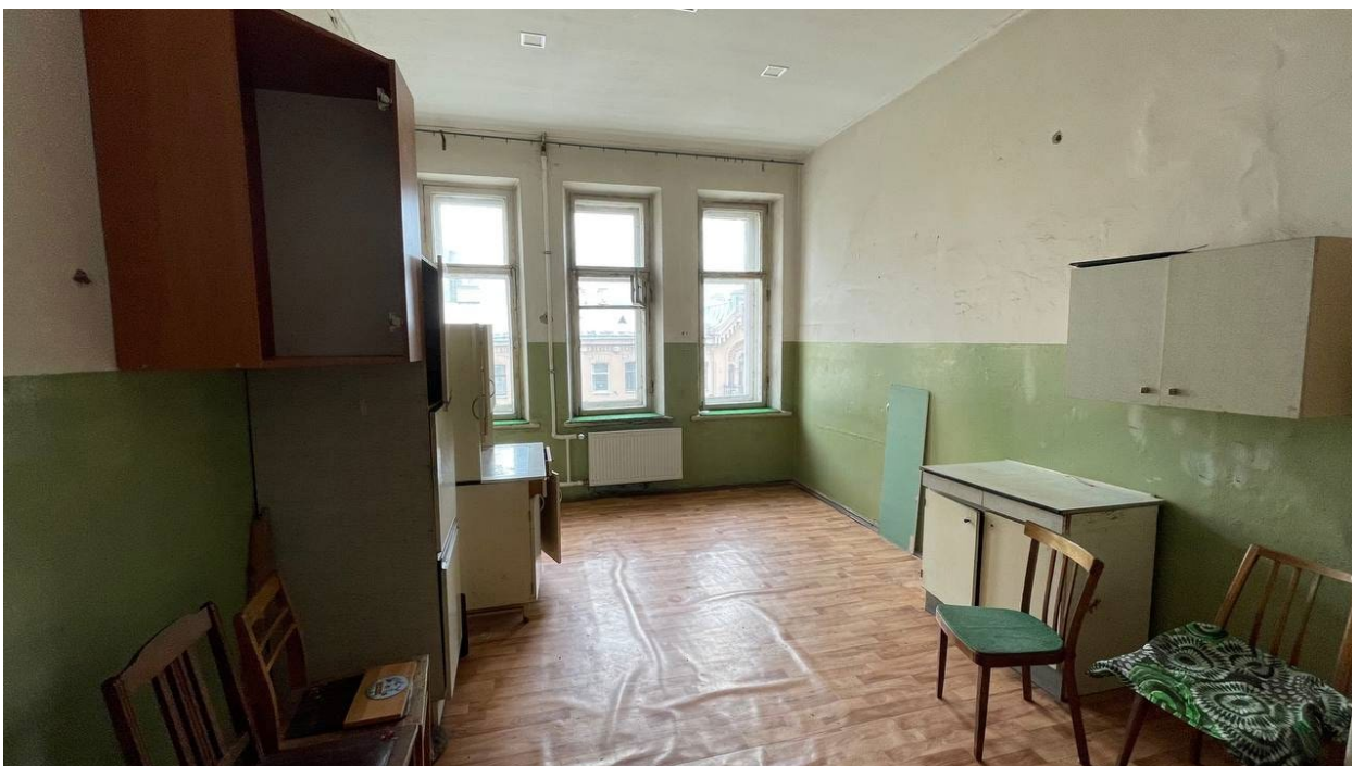
27. Фрагмент интерьера кухни (помещение № 7);
