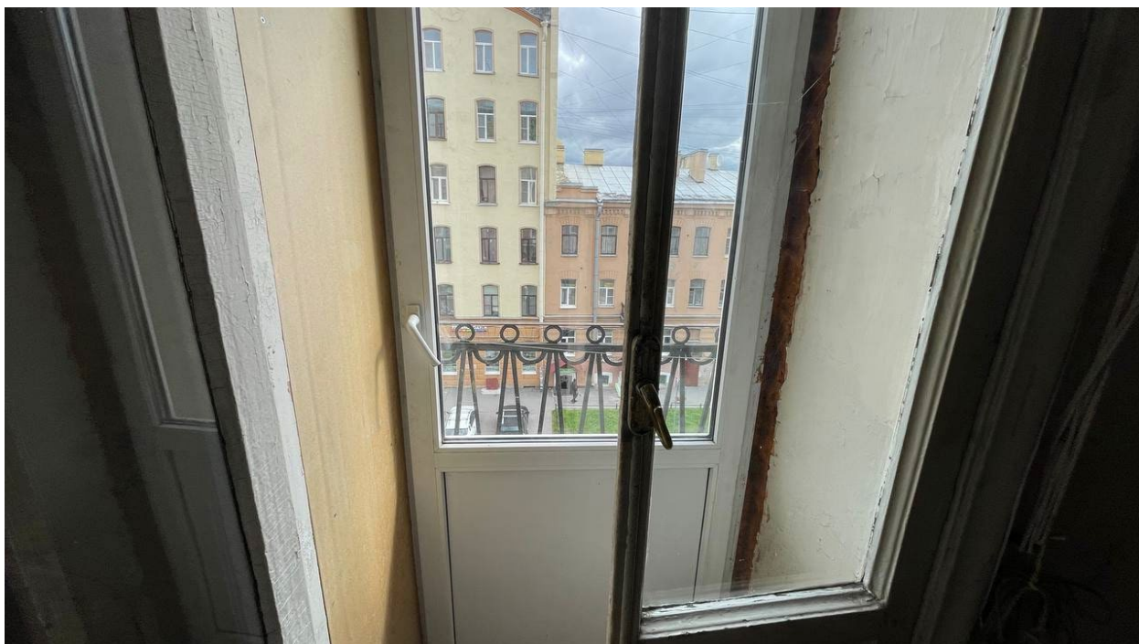
17. Вид на балкон (помещение № 4);
