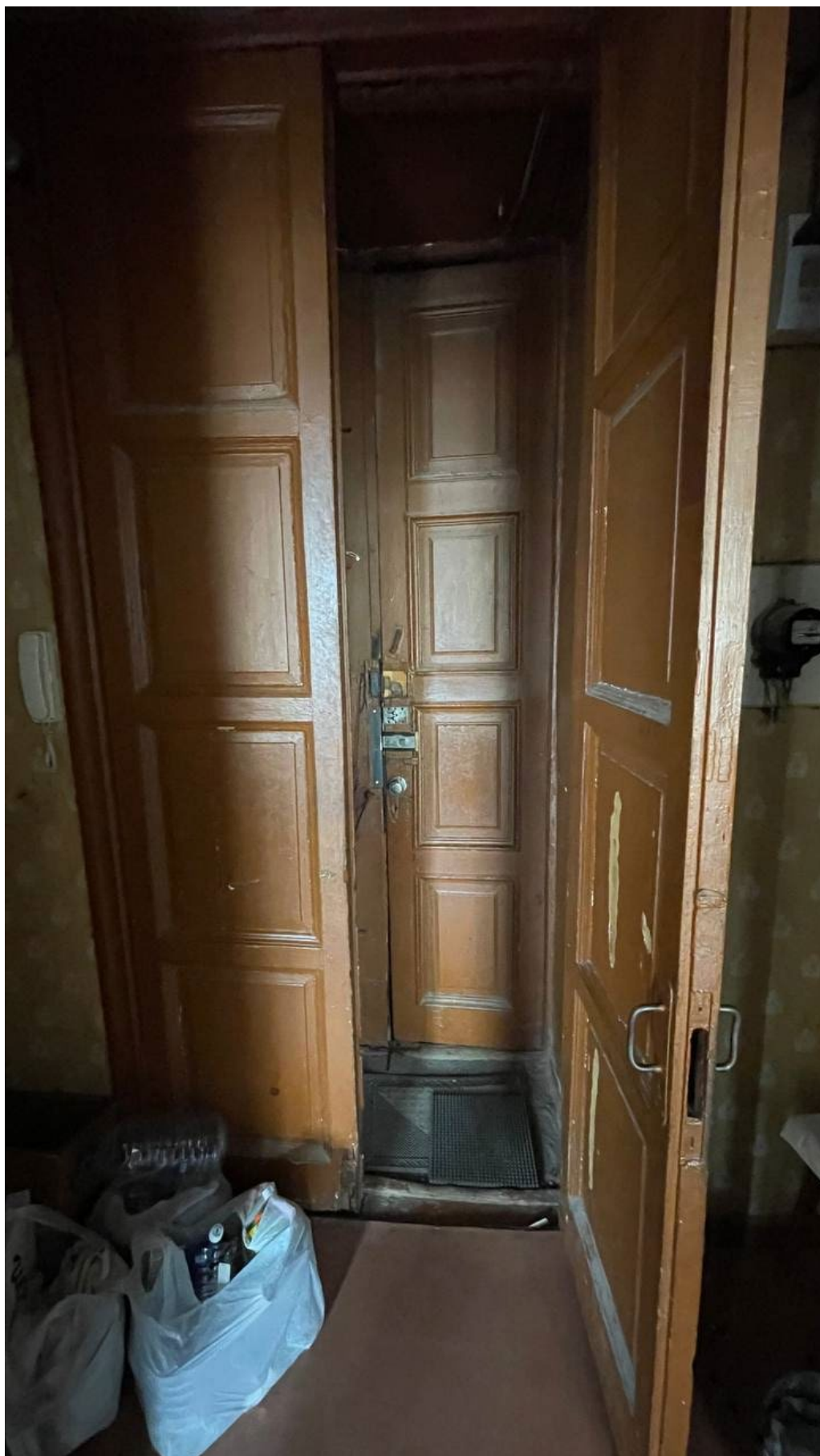
4. Вид на входную дверь в квартире № 6;
