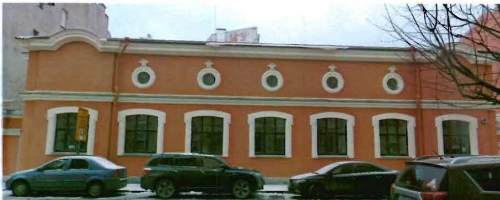
23. Общий вид Флигеля со стороны внутреннего двора.
