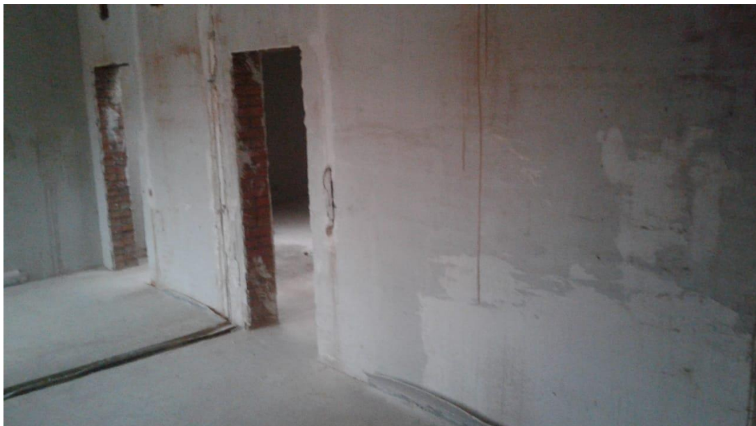
39. Здание по адресу: г. Санкт-Петербург, улица Восстания, дом 45, литера В. Фрагмент интерьера первого этажа.
