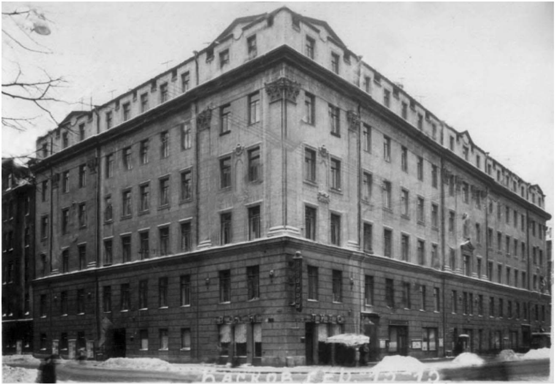
Илл. 25. Фасад углового дома № 13 – 15 в Басковом переулке. Фотография. 1960 г. Автор съемки: неизвестен. ЦГАКФФД СПб. Шифр: Гр 74965.
