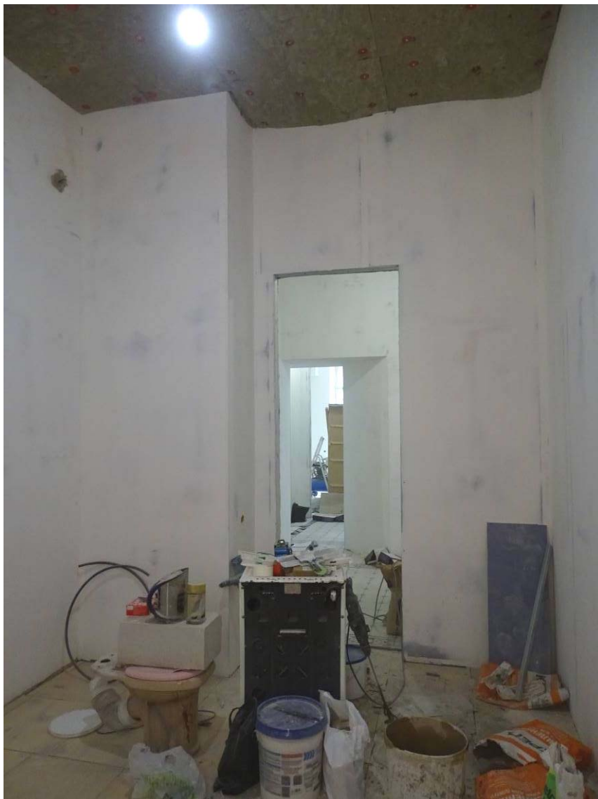
Фото 7. Квартира № 13. Пом. 8/13,5. Съемка 25.03.2022 г. Трушковский В. Э.
