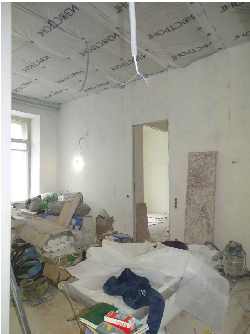
Фото 12. Квартира № 13. Пом. 6/19,5. Съемка 25.03.2022 г. Трушковский В. Э.
