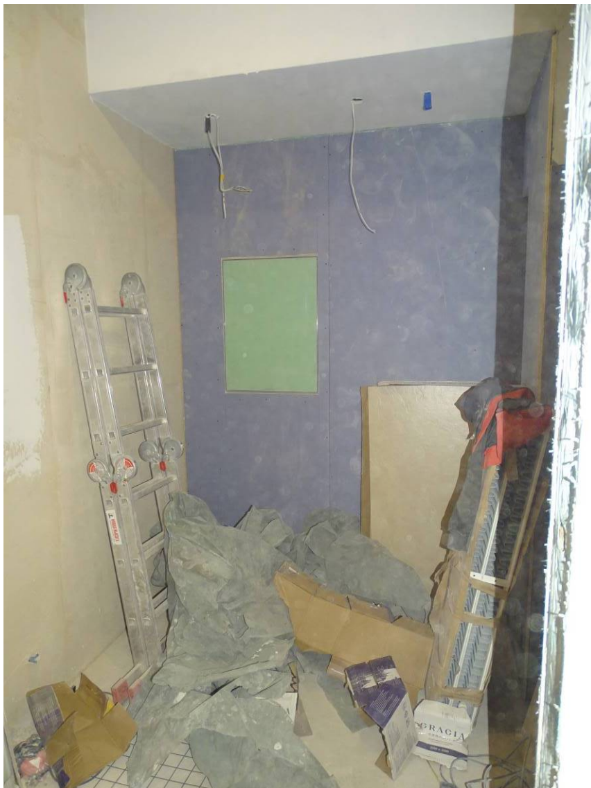
Фото 9. Квартира № 13. Пом. 4. Съемка 25.03.2022 г. Трушковский В. Э.
