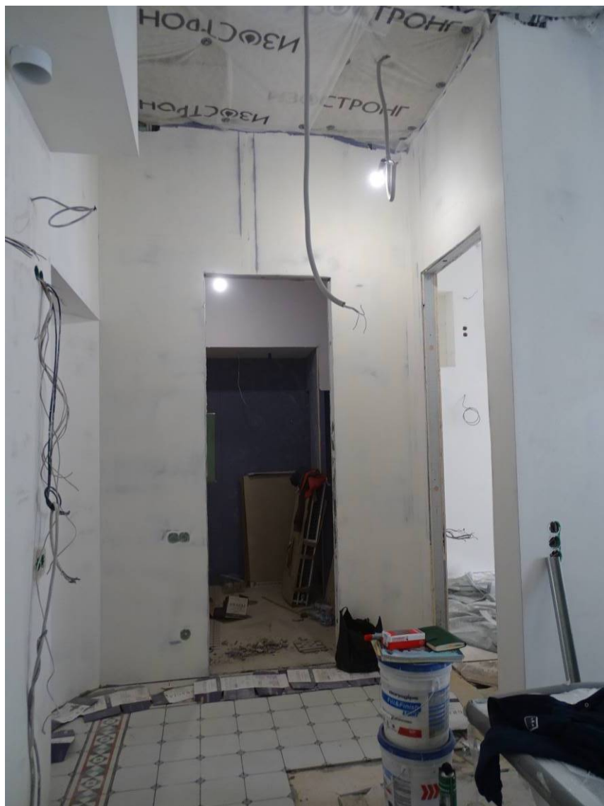
Фото 8. Квартира № 13. Пом. 1/15,3; 3/5,3. Съемка 25.03.2022 г. Трушковский В. Э.
