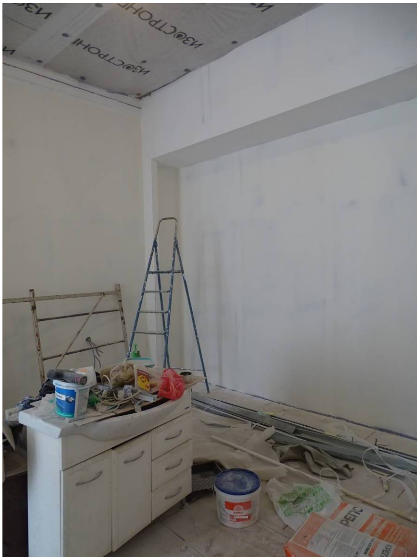
Фото 13. Квартира № 13. Пом. 6/19,5. Съемка 25.03.2022 г. Трушковский В. Э.
