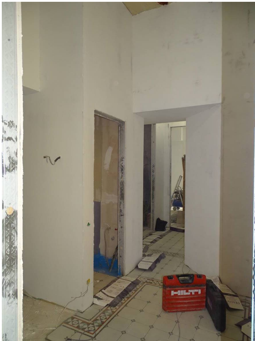
Фото 5. Квартира № 13. Пом. 1/15,3. Съемка 25.03.2022 г. Трушковский В. Э.
