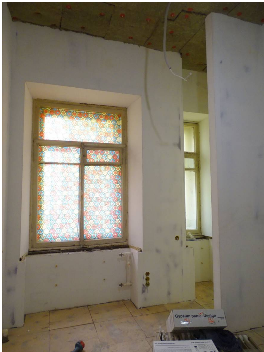
Фото 6. Квартира № 13. Пом. 8/13,5. Съемка 25.03.2022 г. Трушковский В. Э.
