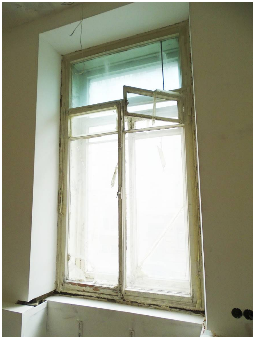
Фото 11. Квартира № 13. Пом. 5/17,4. Оконное заполнение. Съемка 25.03.2022 г. Трушковский В. Э.
