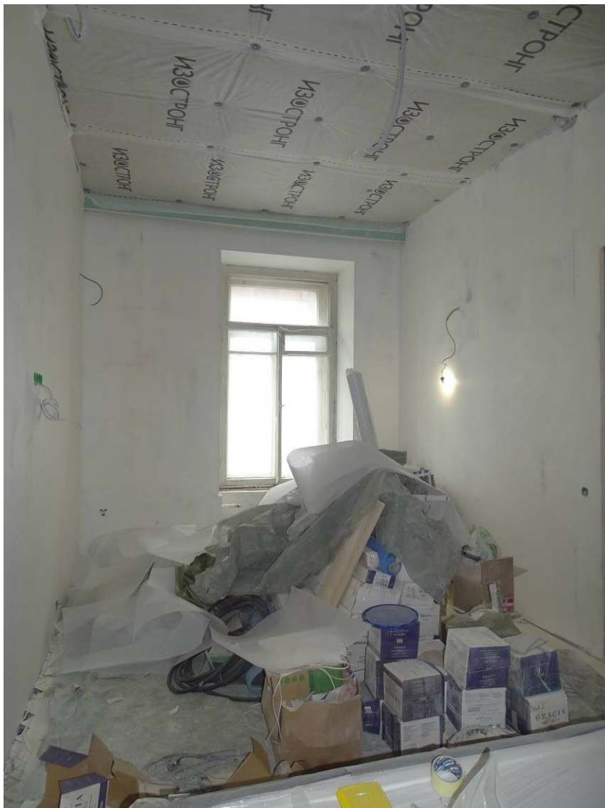
Фото 10. Квартира № 13. Пом. 5/17,4. Съемка 25.03.2022 г. Трушковский В. Э.
