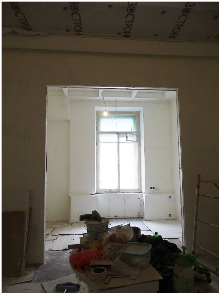
Фото 14. Квартира № 13. Пом. 7/29,6. Съемка 25.03.2022 г. Трушковский В. Э.
