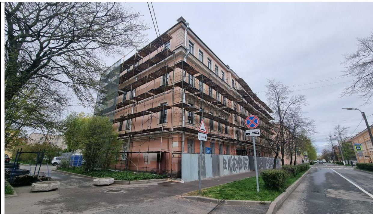
Фото 3. Общий вид торцевого фасада по ул. Посадской.
