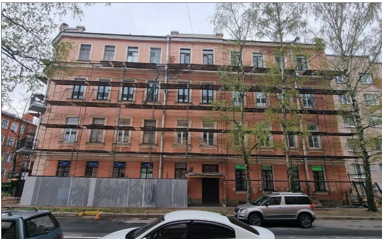
Фото 5. Общий вид лицевого фасада по ул. Всеволода Вишневского.
