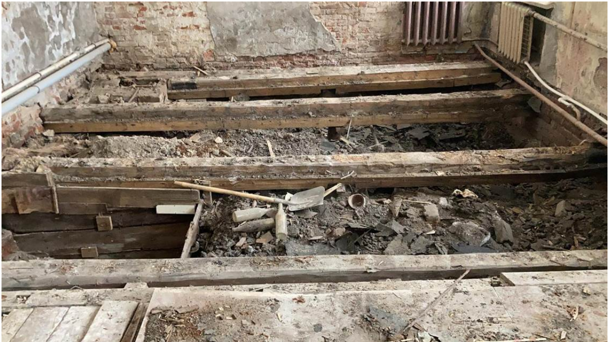
18. Объект культурного наследия регионального значения «3-я линия фруктовых теплиц с квартирами садовников и конторой» в составе объекта культурного наследия регионального значения комплекса «Дворцовые теплицы». Помещение 10. Вскрытие полов.
