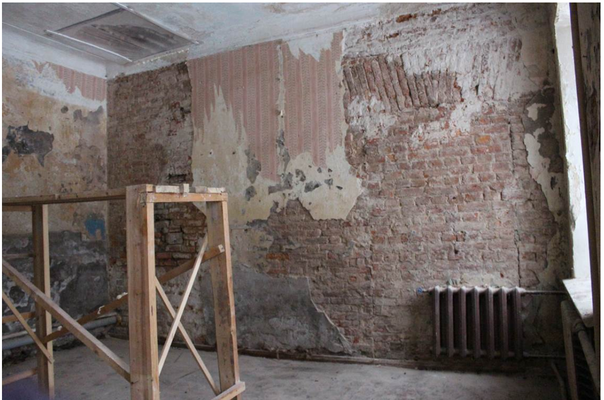
9. Объект культурного наследия регионального значения «3-я линия фруктовых теплиц с квартирами садовников и конторой» в составе объекта культурного наследия регионального значения комплекса «Дворцовые теплицы». Внутренняя капитальная стена по оси 1. Вид со стороны пом. 5-Н.
