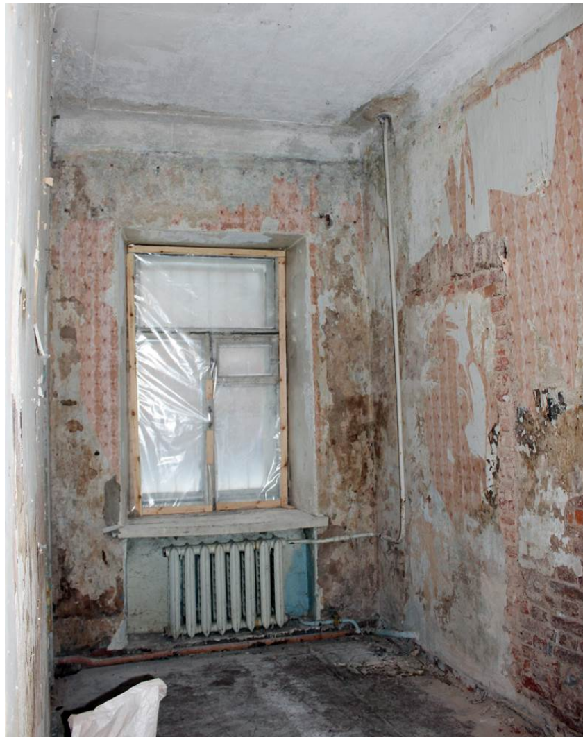
15. Объект культурного наследия регионального значения «3-я линия фруктовых теплиц с квартирами садовников и конторой» в составе объекта культурного наследия регионального значения комплекса «Дворцовые теплицы». Помещение 10. Вид от стены по оси Б в сторону наружной стены по оси А.
