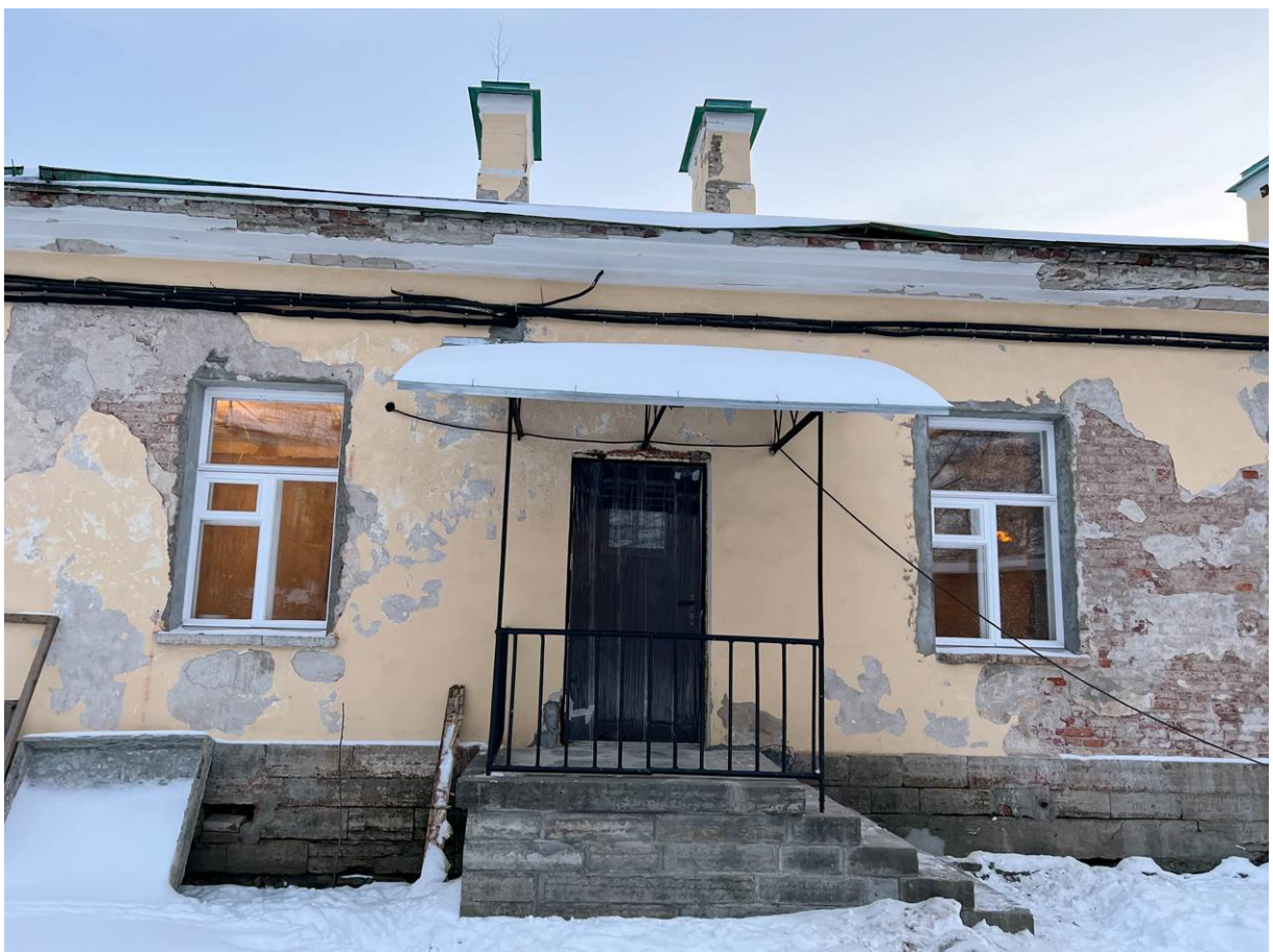
2. Объект культурного наследия регионального значения «3-я линия фруктовых теплиц с квартирами садовников и конторой» в составе объекта культурного наследия регионального значения комплекса «Дворцовые теплицы». Фрагмент северного фасада западного крыла 3-й линии фруктовых теплиц. Вход в помещение 5-Н. Вид с севера.
