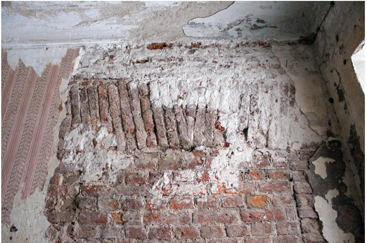
10. Объект культурного наследия регионального значения «3-я линия фруктовых теплиц с квартирами садовников и конторой» в составе объекта культурного наследия регионального значения комплекса «Дворцовые теплицы». Внутренняя капитальная стена по оси 1. Клинчатая перемычка ранее существовавшего дверного проема между помещениями.
