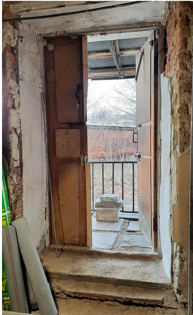
8. Объект культурного наследия регионального значения «3-я линия фруктовых теплиц с квартирами садовников и конторой» в составе объекта культурного наследия регионального значения комплекса «Дворцовые теплицы». Входная дверь в помещение 5-Н. Вид из интерьера.
