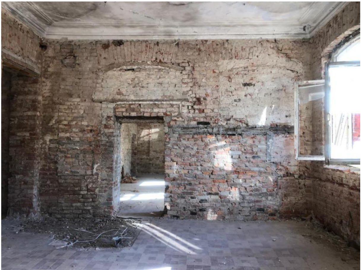
Фото 30. Стена по оси 10 в осях Б – В (первоначально – наружная). При пристройке части здания между осями 10 – 13 оконные проемы – заложены. Вид с западной стороны.
