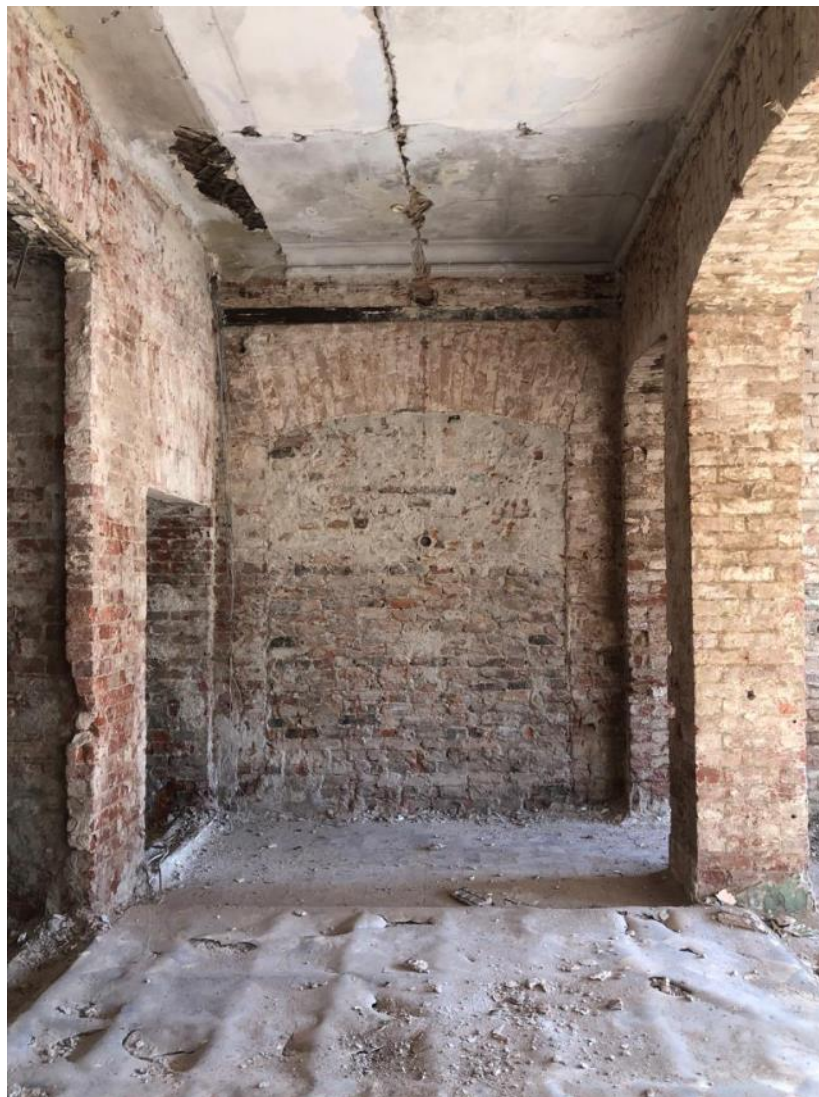
Фото 29. Заложенный дверной проем в стене по оси 10 в осях В – Г. Вид с западной стороны.
