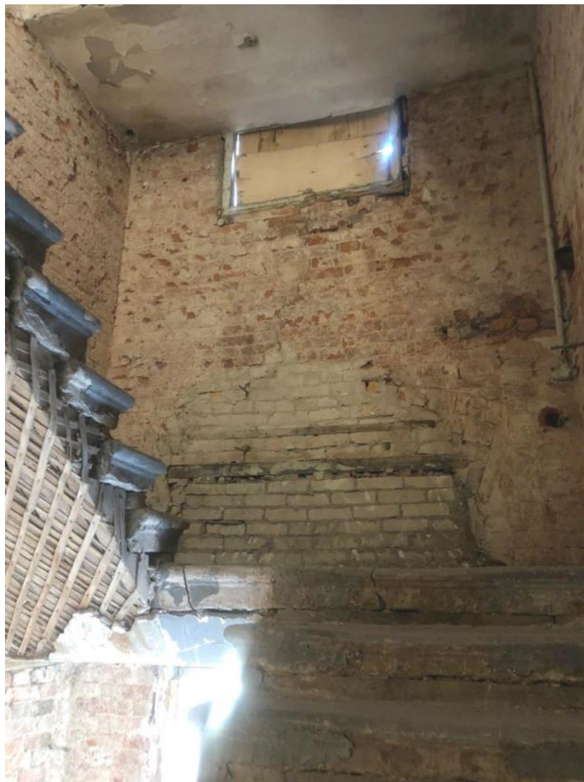
Фото 13. Западная лестница. Вид нижнего марша на междуэтажную площадку.
