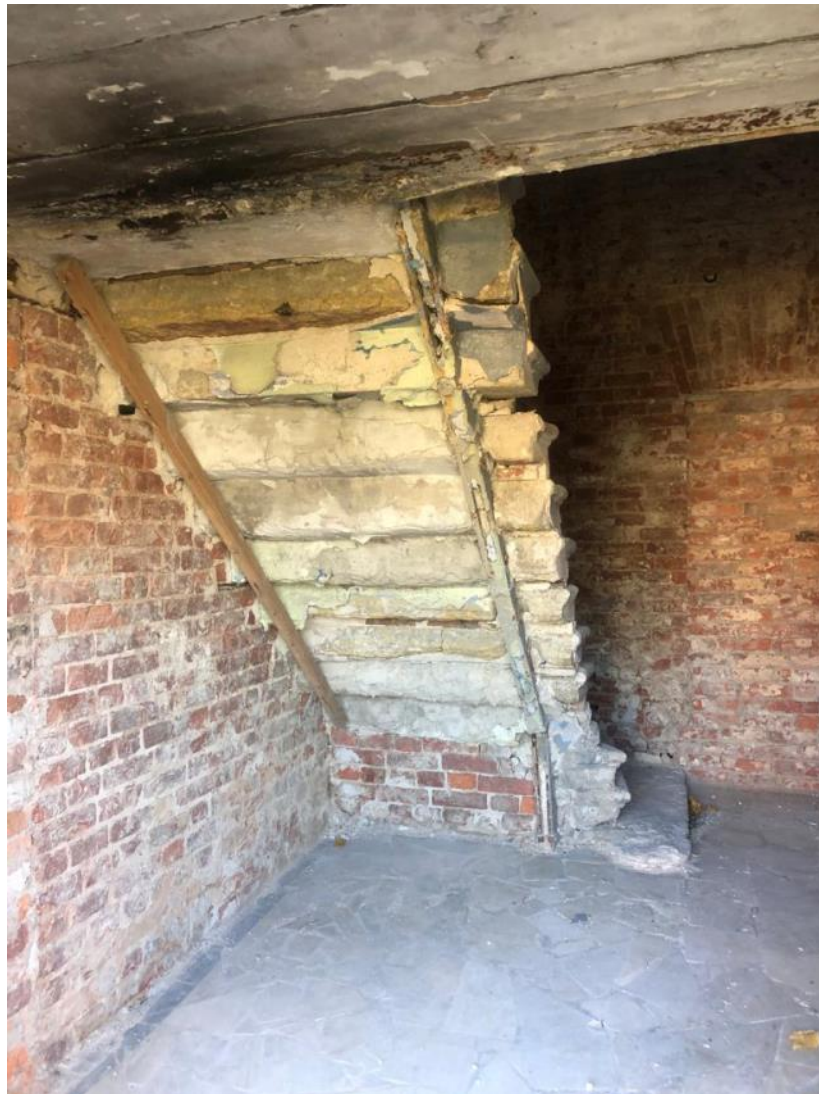
Фото 12. Нижний марш лестницы в осях В – Г между осями 1 – 2 (западной). Вид с площадки 1-го этажа
