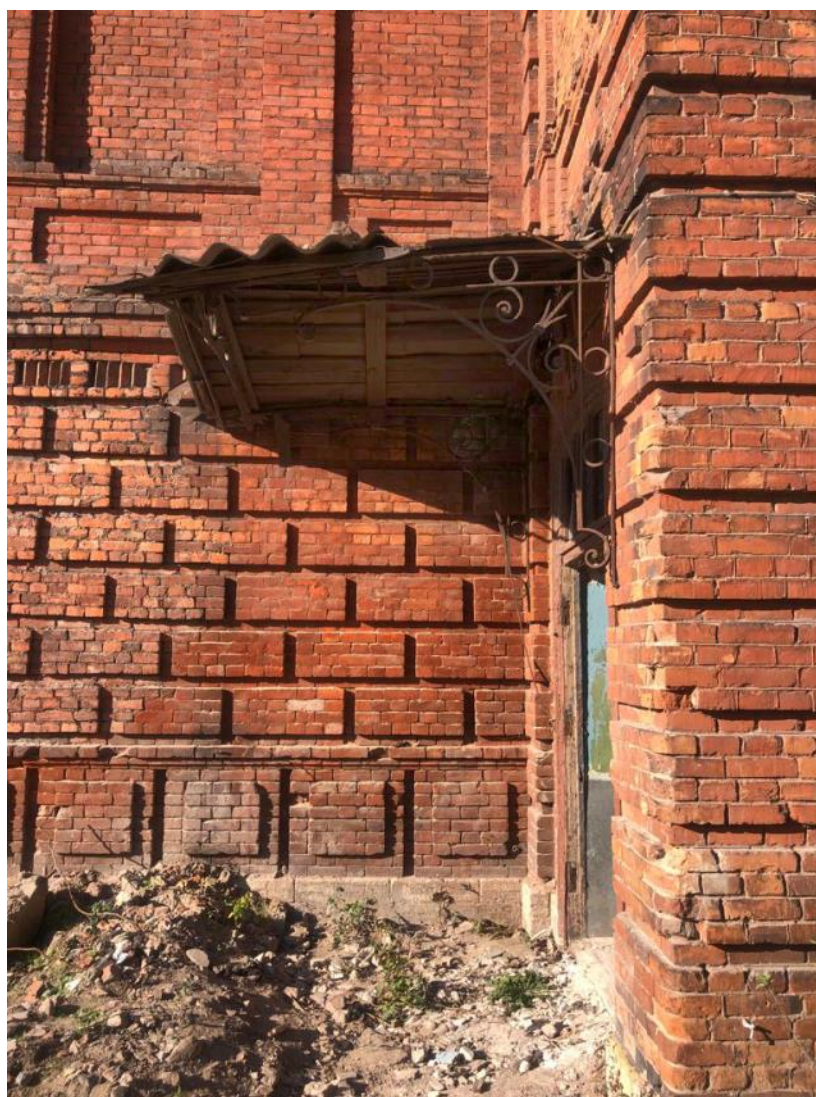
Фото 10. Объект культурного наследия регионального значения «Товарная контора Варшавского вокзала». Фрагмент восточного фасада. Вход в пристройку
