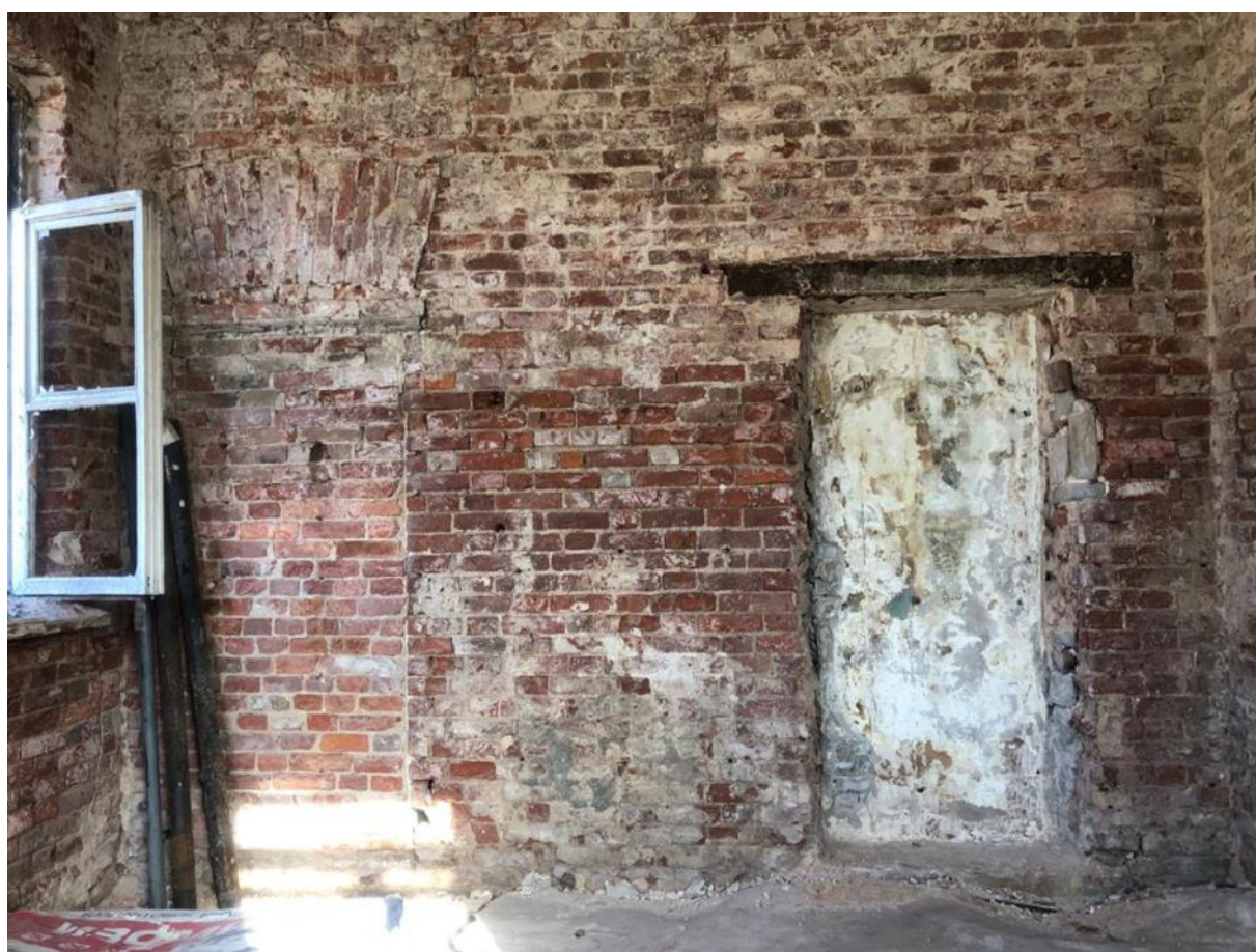
Фото 24. Помещение 1-го этажа в осях 1 – 2/Б – В. Вид на стену по оси В с юга.
