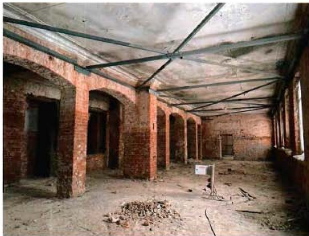
3. Общий вид помещения 1 этажа объекта культурного наследия.
