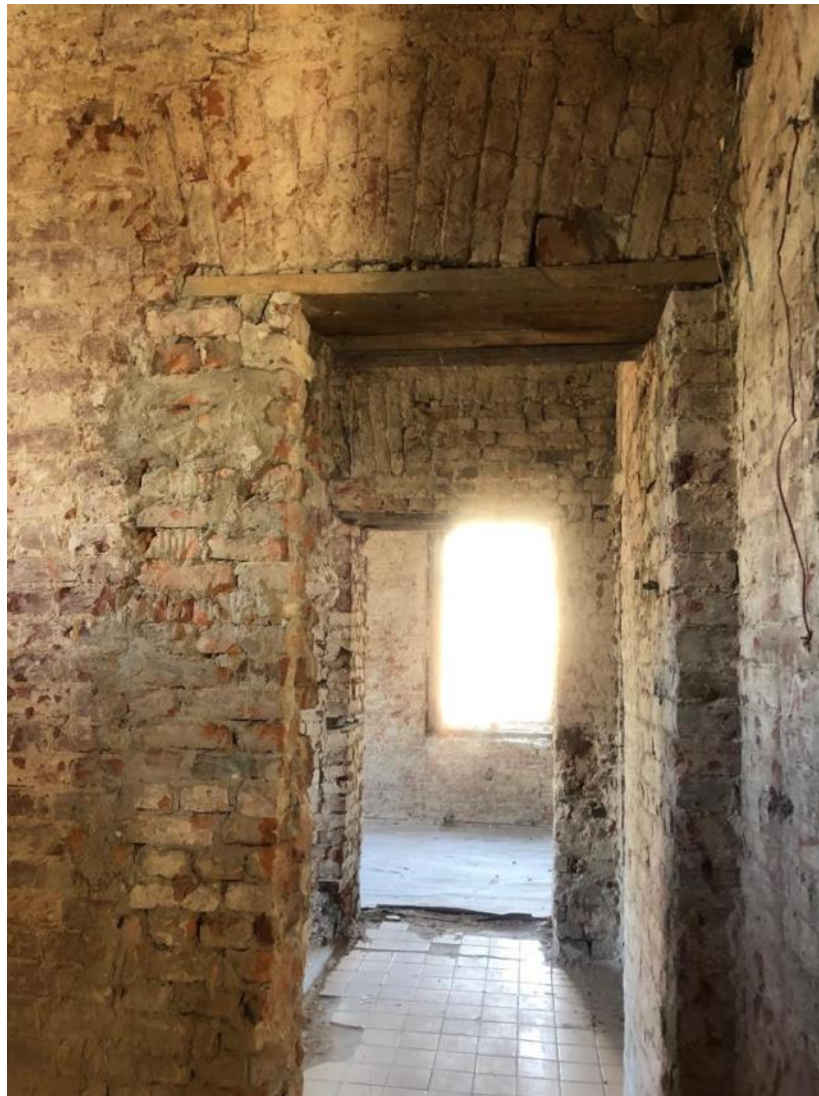
Фото 17. Вид с площадки 2-го этажа западной лестницы на север.
