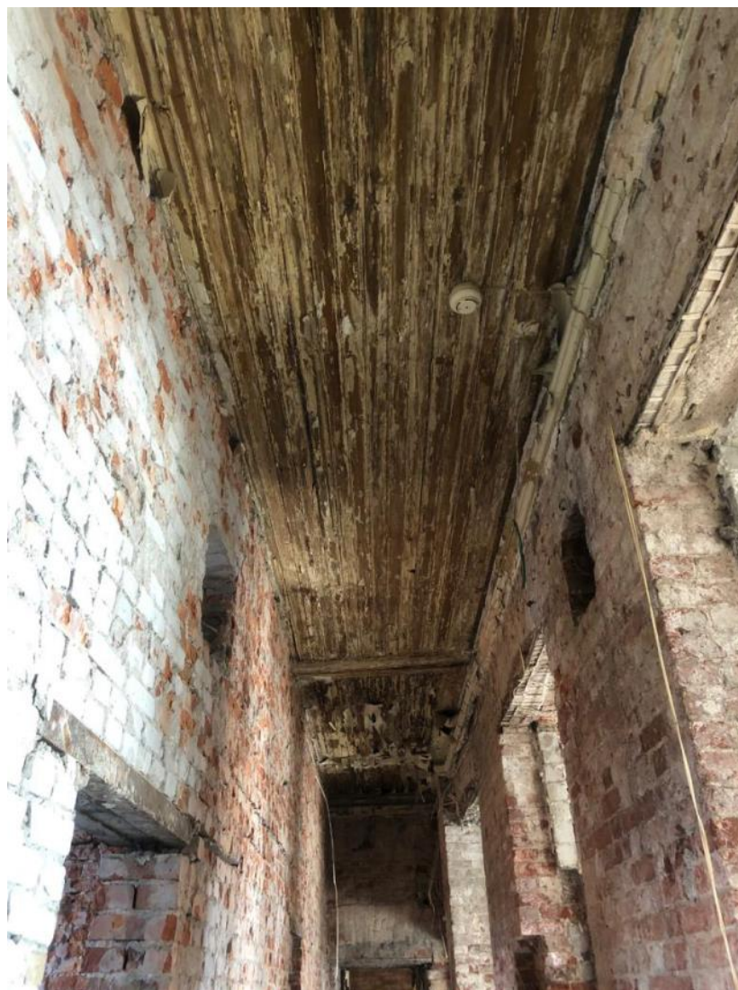
Фото 28. Подшивка потолка коридора 1-го этажа в осях В – Г. Вид с западной стороны.
