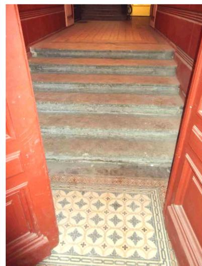
лестница – габариты, тип (двухмаршевая), конструкция (на косоурах), материал ступеней (лещадная плита), профиль ступеней;
