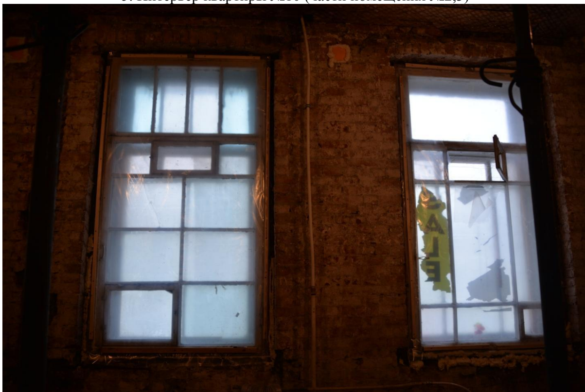
6. Оконные проемы в квартире №10 (части помещения 2, 3)
