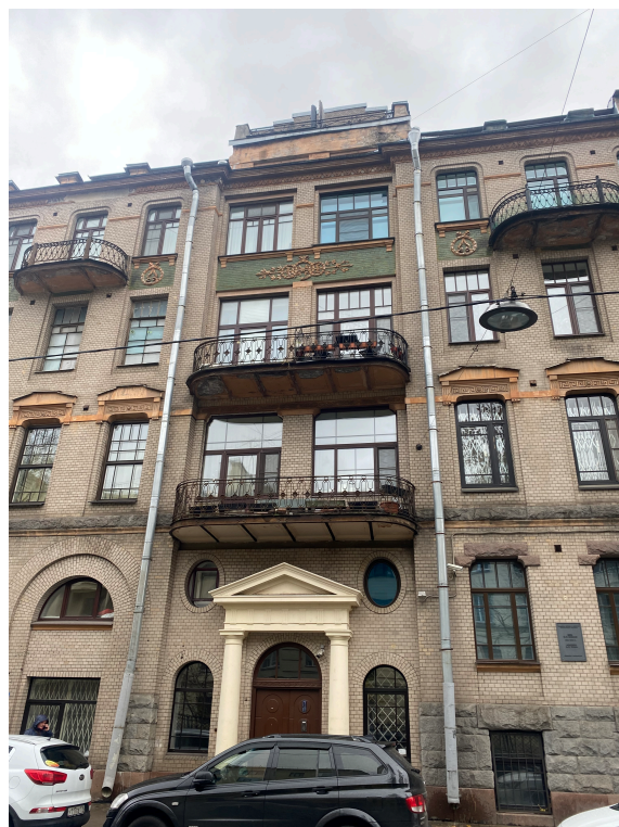
2. Фрагмент лицевого фасада объекта культурного наследия регионального значения «Дом И.Ф. Хреновой»
