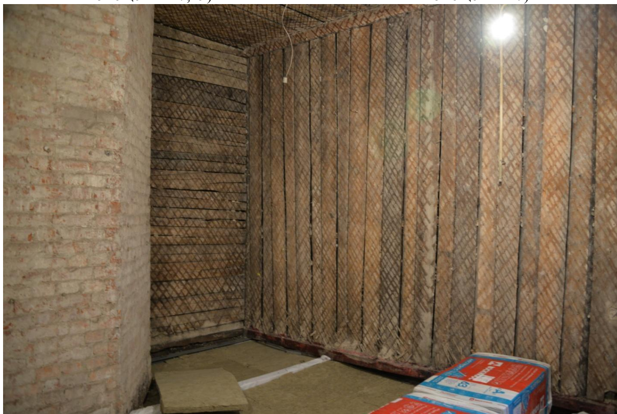
17. Интерьер квартиры №10 (части помещения №17)
