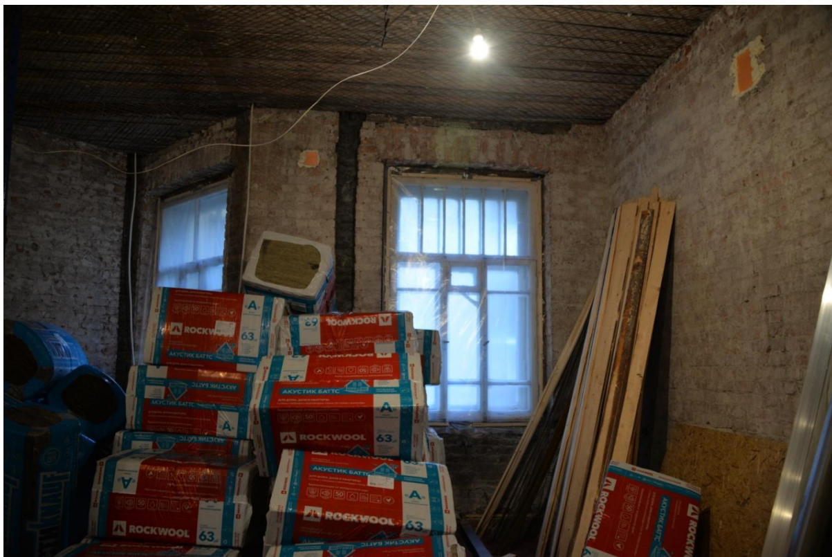
9. Интерьер квартиры №10 (части помещения №10, 11)
