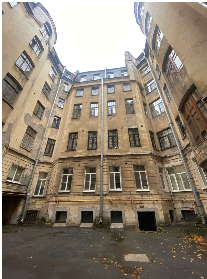
3. Фрагмент дворового фасада
