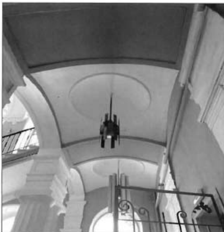
11. Интерьер помещения № 13-Н(11) объекта культурного наследия.
