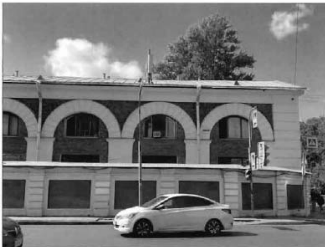
3. Фрагмент южного лицевого фасада объекта культурного наследия.
