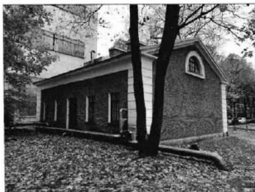
2. Вид на северный фасад с территории объекта культурного наследия.
