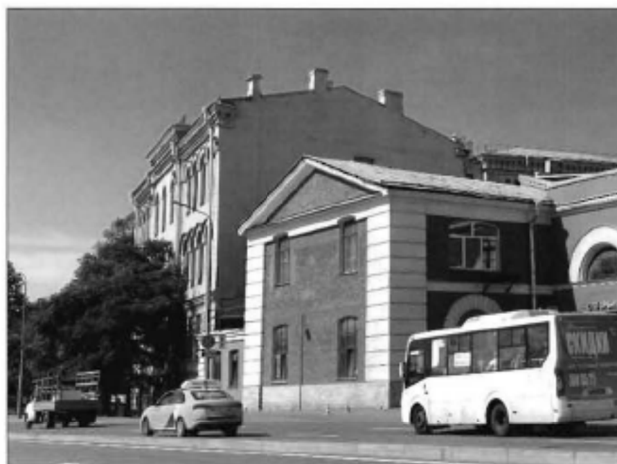
1. Южный и восточный фасады объекта культурного наследия.
