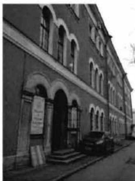
3. Входная группа южного фасада.
