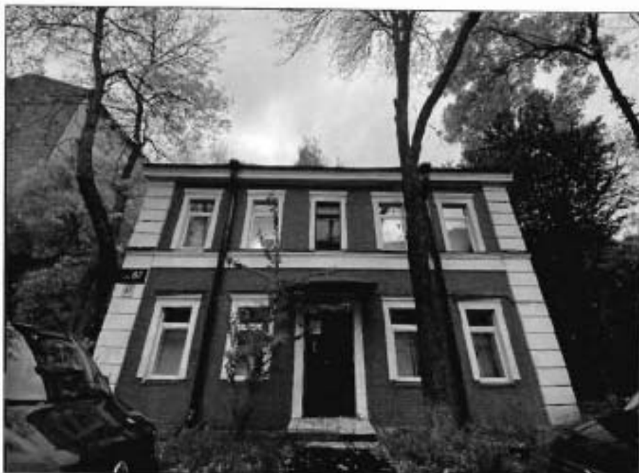
10. Вид на лицевой фасад.
