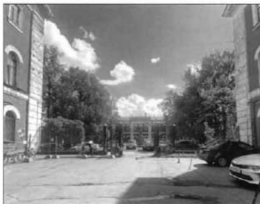
2. Общий вид на объект культурного наследия с прилегающей территории.
