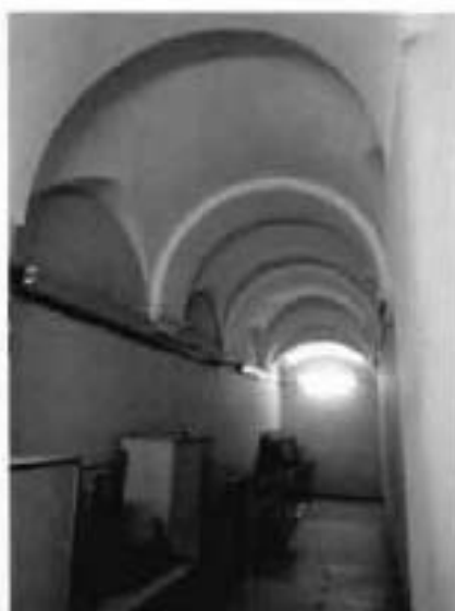
8. Коридор 1-го этажа.
