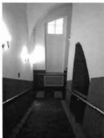
7. Лестница в западной части здания.
