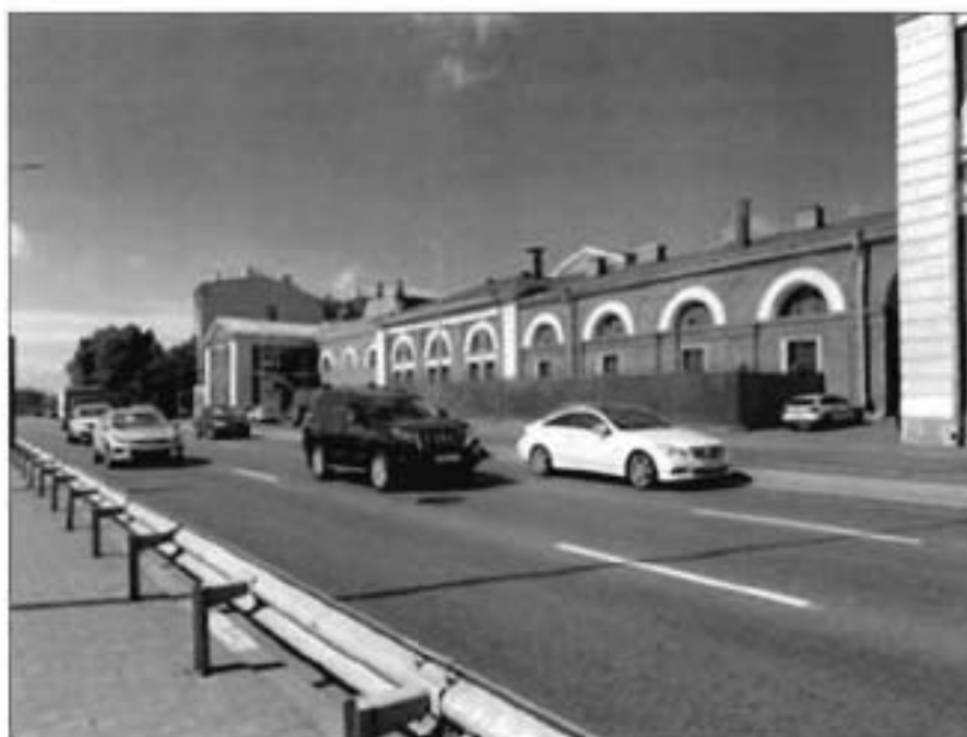
2. Фрагмент южного лицевого фасада объекта культурного наследия.
