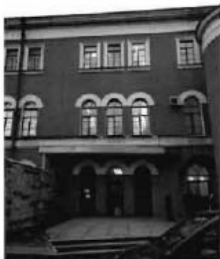
4. Входная группа северного фасада.
