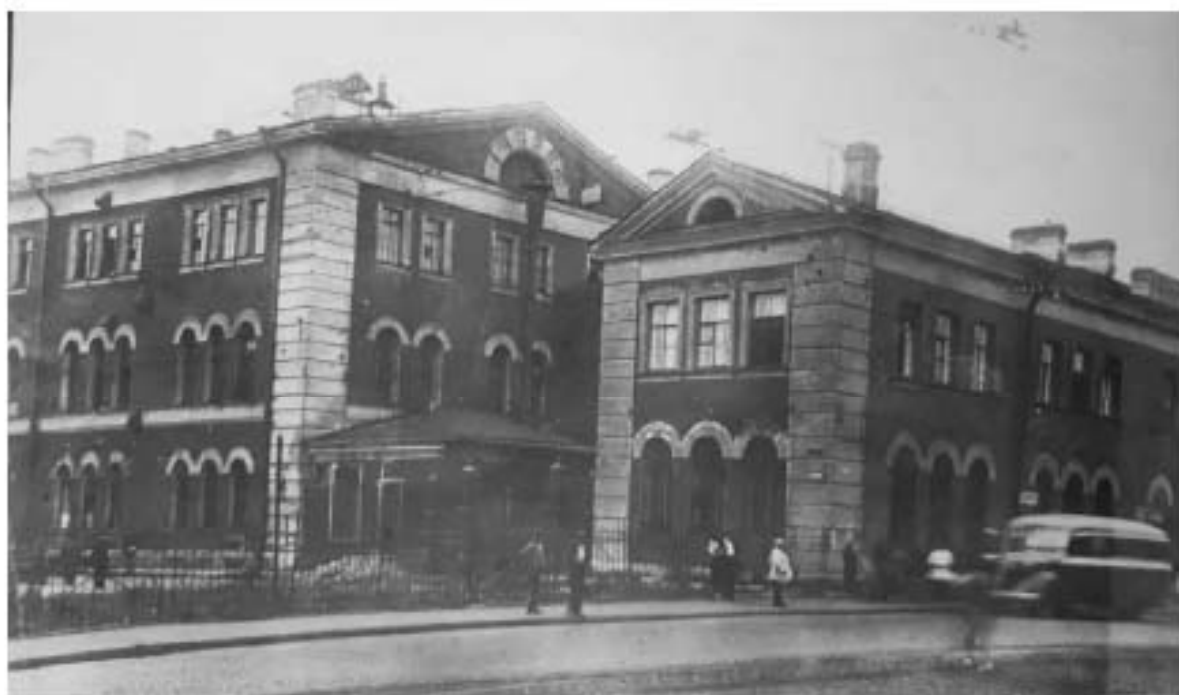
39. Вид на пересечении ул. Комсомола и Арсенальной. 1948 г. Архив КГИОП, № 21171
