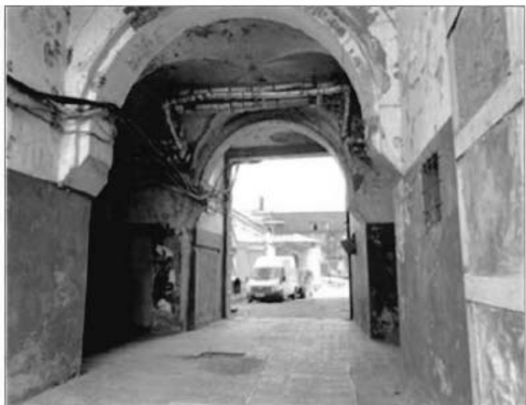
6. Арочный проезд северного фасада объекта культурного наследия.
