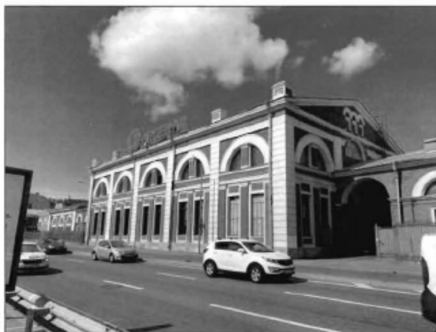
1. Фрагмент южного лицевого фасада объекта культурного наследия.
