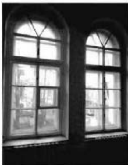
5. Окна 2-го этажа.
