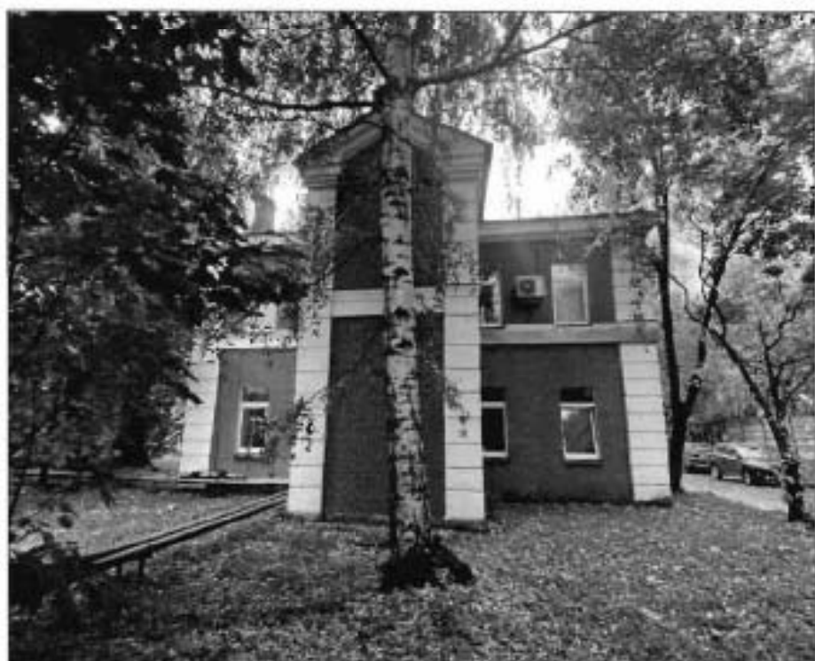
11. Вид на северный фасад с территории объекта культурного наследия.
