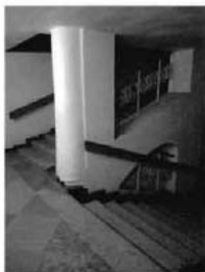
6. Лестница в центральной части здания.
