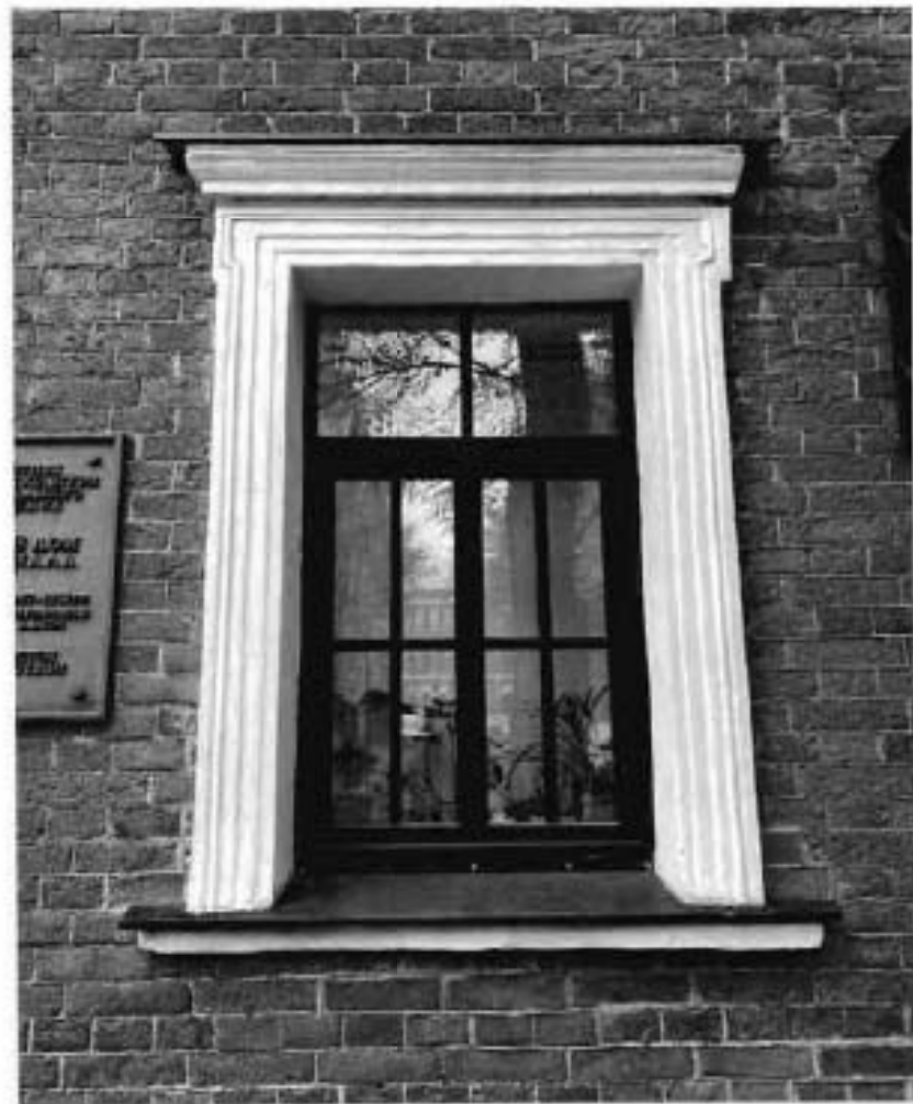
4. Фрагмент южного фасада. Профилированный наличник оконного проема с сандриком.
