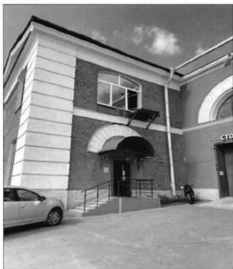
4. Восточный фасад объекта культурного наследия.
