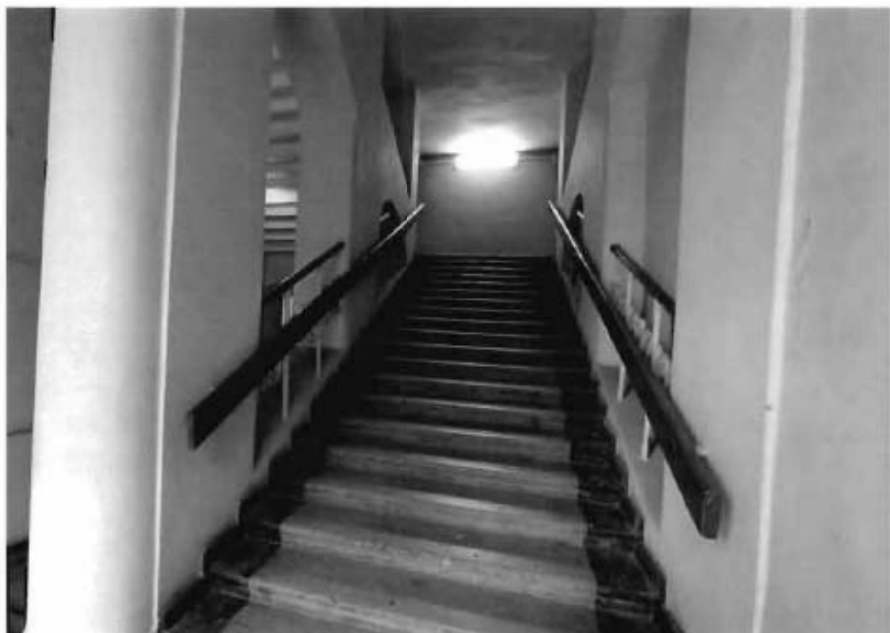
5. Лестница в центральной части объекта культурного наследия.
