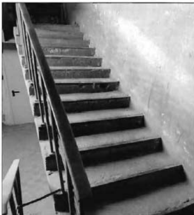
15. Лестница в помещении 13-Н(77) объекта культурного наследия.
