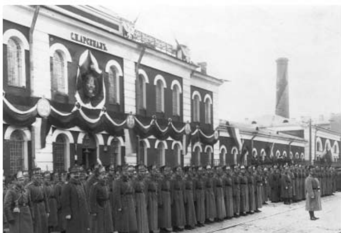
28. Здание главных мастерских. Фото начала XX в. Из коллекции музея завода «Арсенал».
