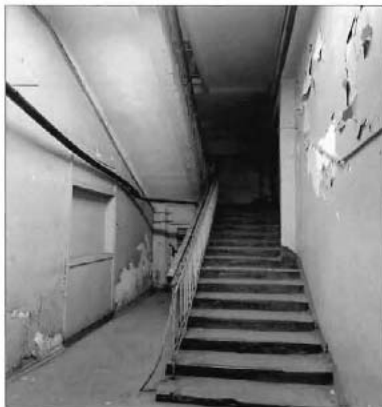
16. Лестница в помещении 13-Н (21) объекта культурного наследия.
