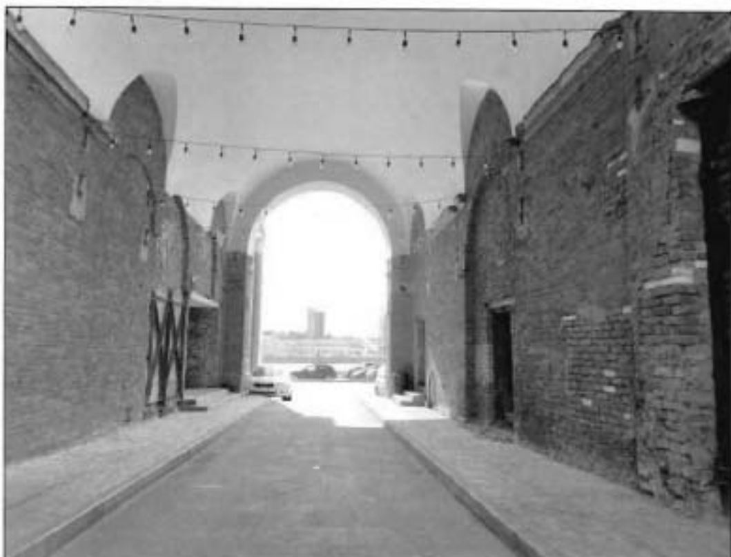
5. Арочный проезд южного фасада объекта культурного наследия.
