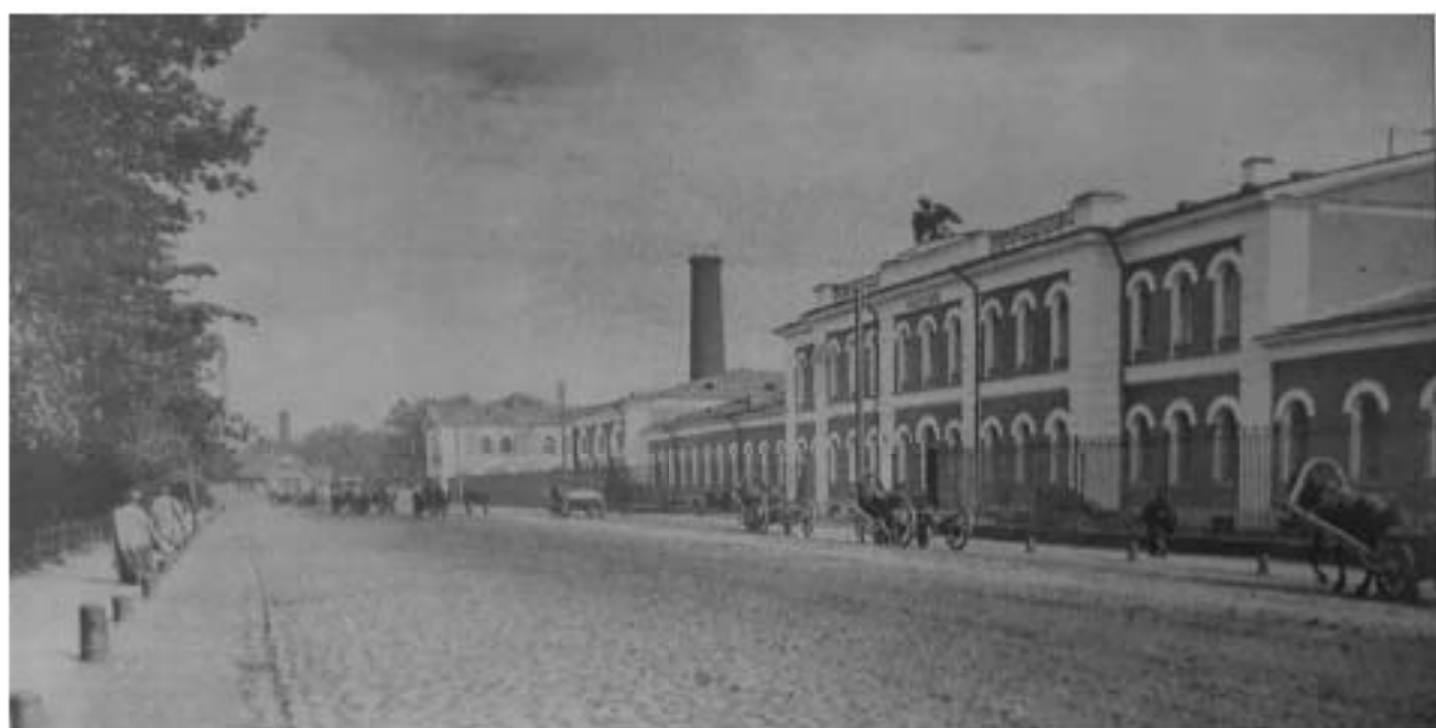
6. Здание главных мастерских. Фото 1872 г. //Историко-культурные исследования по объектам культурного наследия с целью определения предметов охраны. ОКН «Арсенал». Архитектурная мастерская Н.Ф. Никитина. 2009 г.
