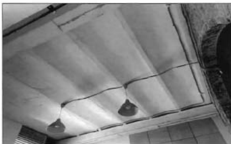
10. Интерьер помещения № 3-Н (2) объекта культурного наследия.
