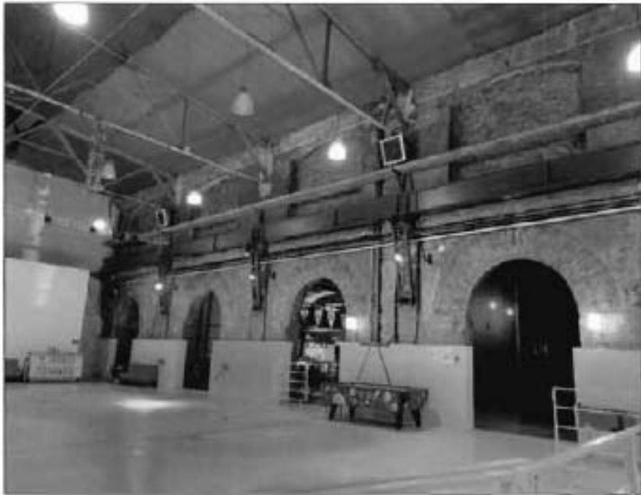
5. Фрагмент восточного фасада (бывшего дворового, расположенного внутри современного цеха) объекта культурного наследия.
