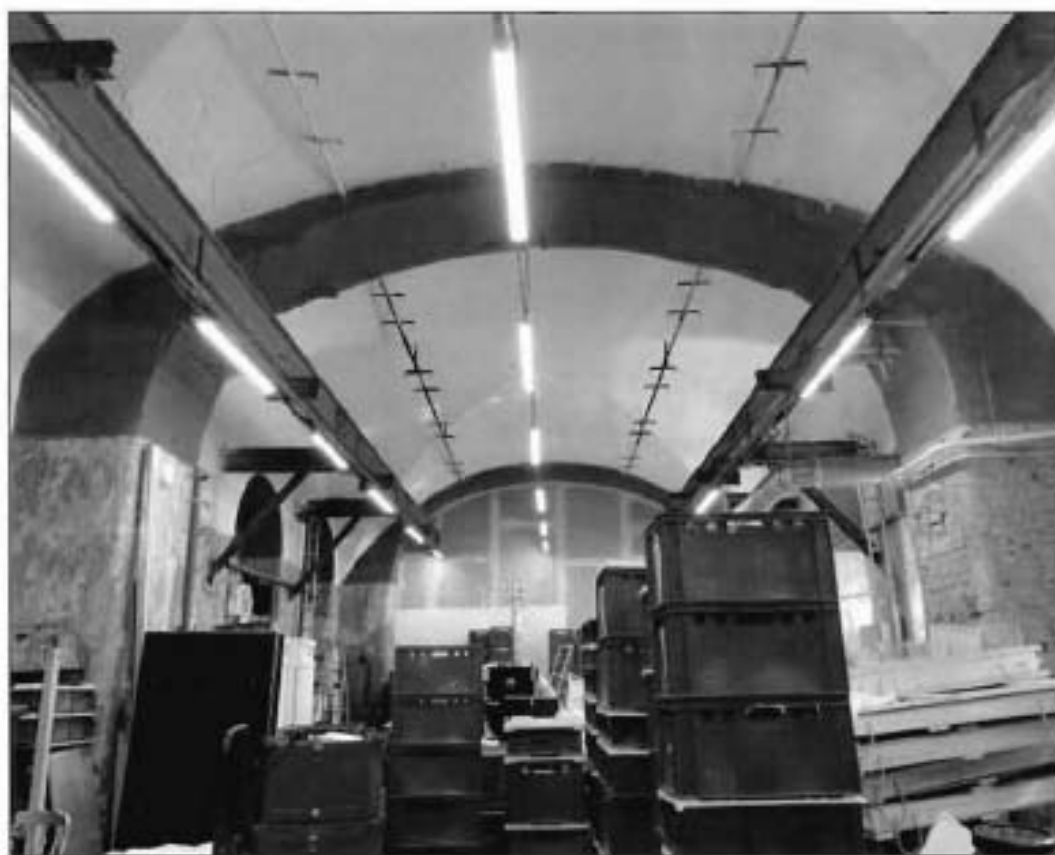
14. Интерьер помещения № 13-Н(39) объекта культурного наследия.
