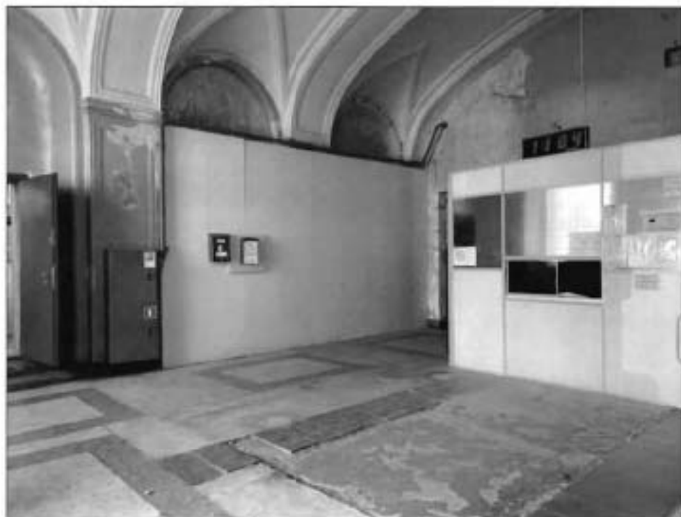
9. Интерьер помещения № 13Н(1) объекта культурного наследия.
