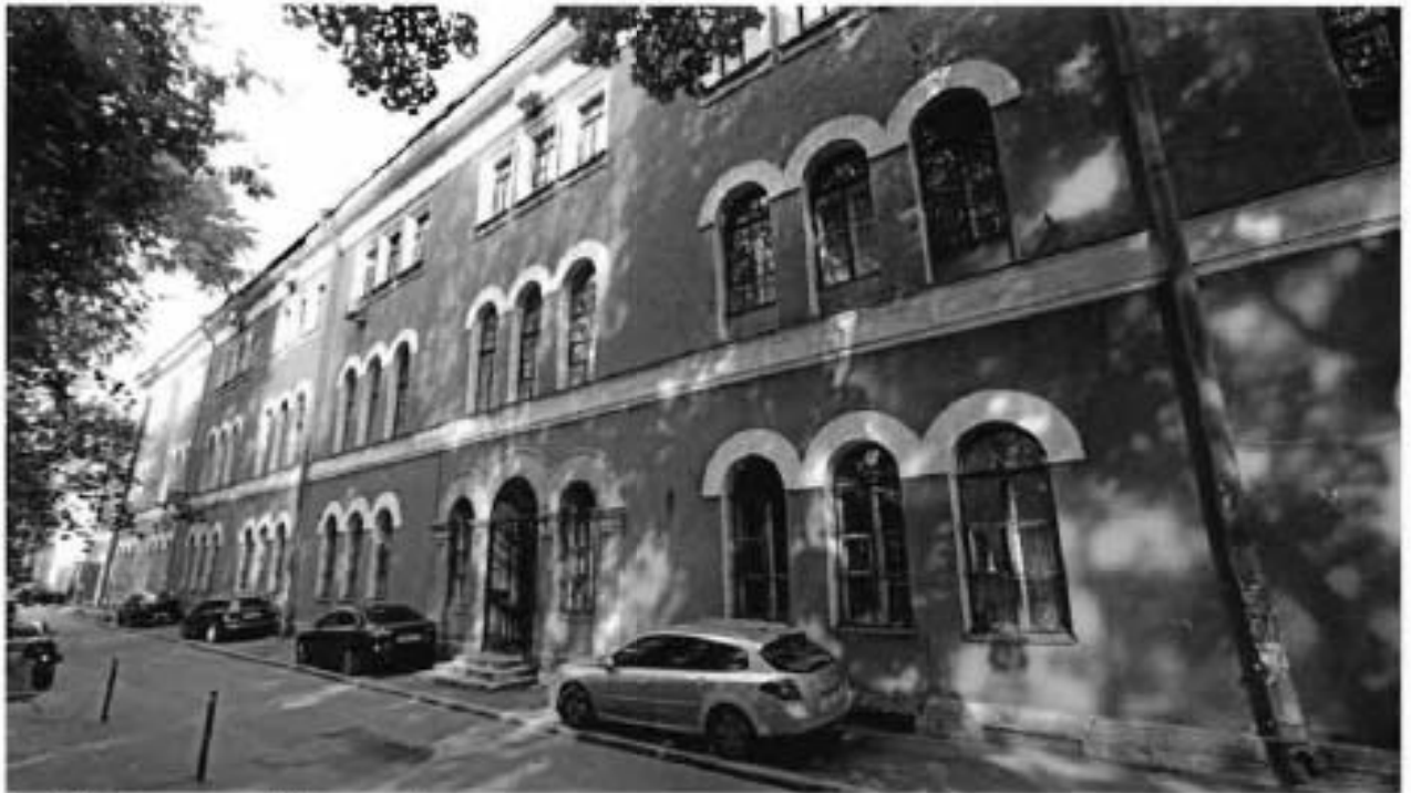
2. Вид на южный фасад объекта культурного наследия.
