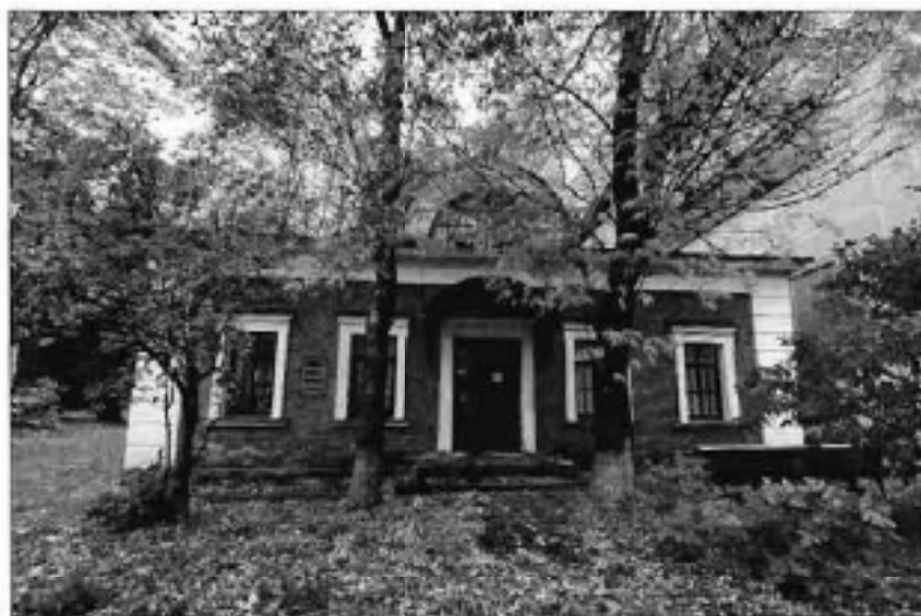
1. Общий вид на лицевой фасад с южной стороны.
