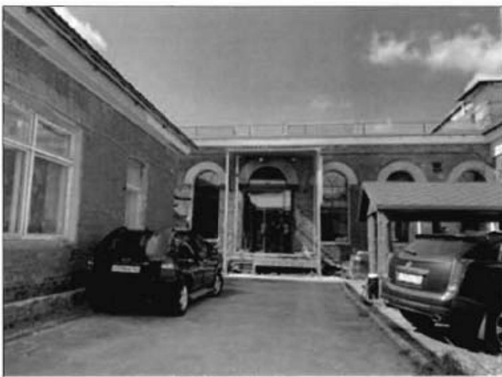
8. Фрагмент северного дворового фасада объекта культурного наследия.
