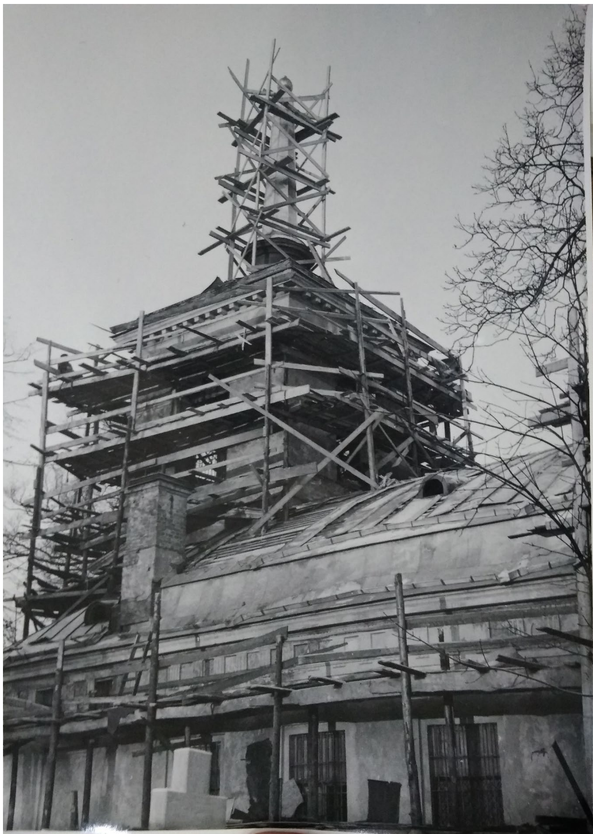
Ил. 14. Церковь Воскресения на Волковском кладбище. Западная часть южного фасада. Ремонтные работы. Начало 1950-х гг. /Январь 1951 г./ Поступила в КГИОП 23.01.1951 г. КГИОП. Фототека №35340/1.
