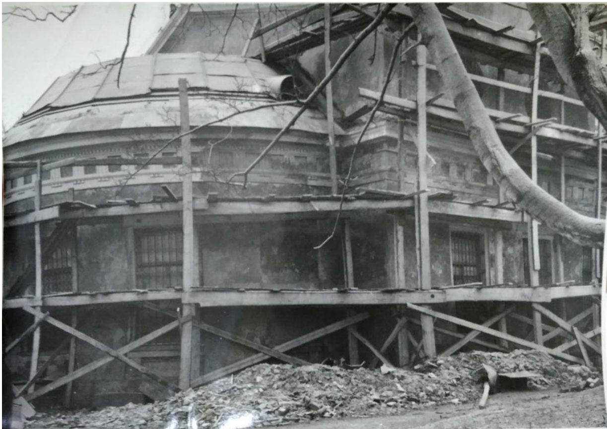
Ил. 15. Церковь Воскресения на Волковском кладбище. Западная часть южного фасада. Ремонтные работы. Начало 1950-х гг. /Январь 1951 г./ Поступила в КГИОП 23.01.1951 г. КГИОП. Фототека №35341/1.
