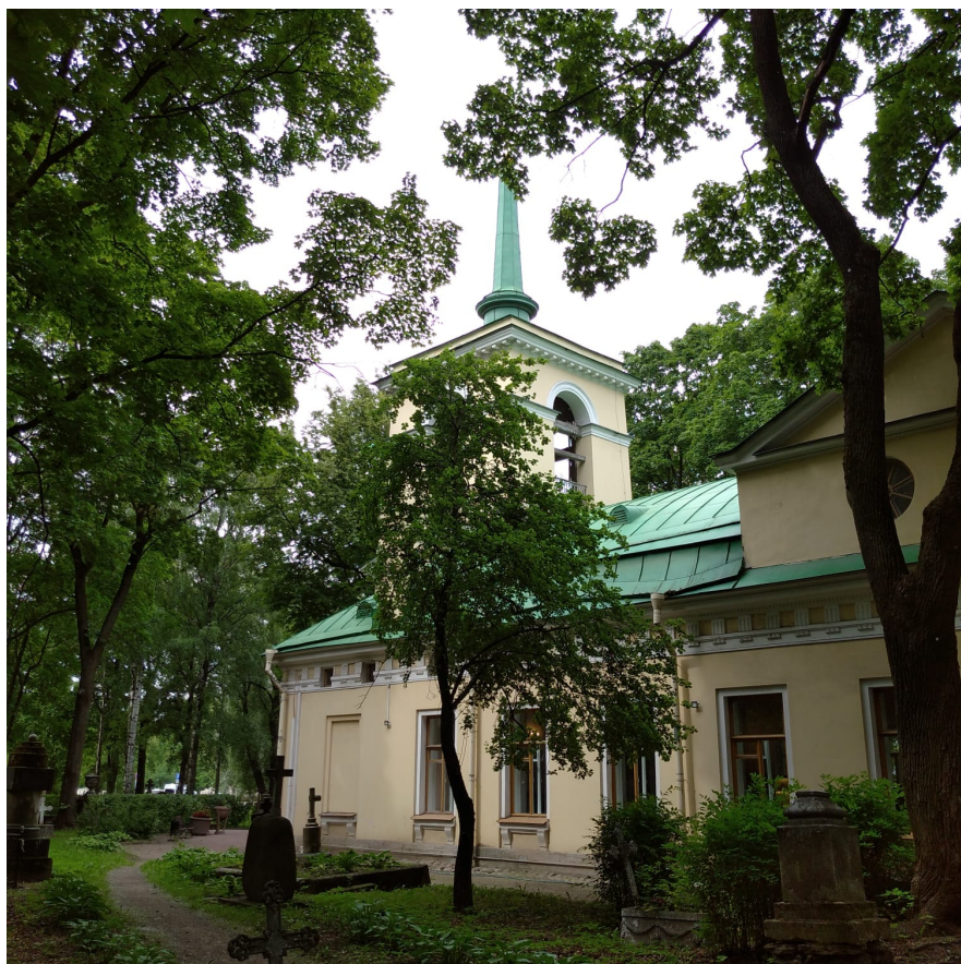
Фото 3. Фрагмент северного фасада.
