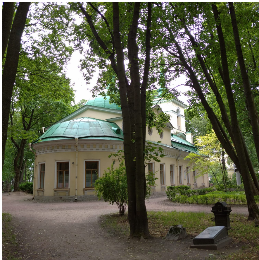
Фото 4. Фрагмент северного и восточного фасада.
