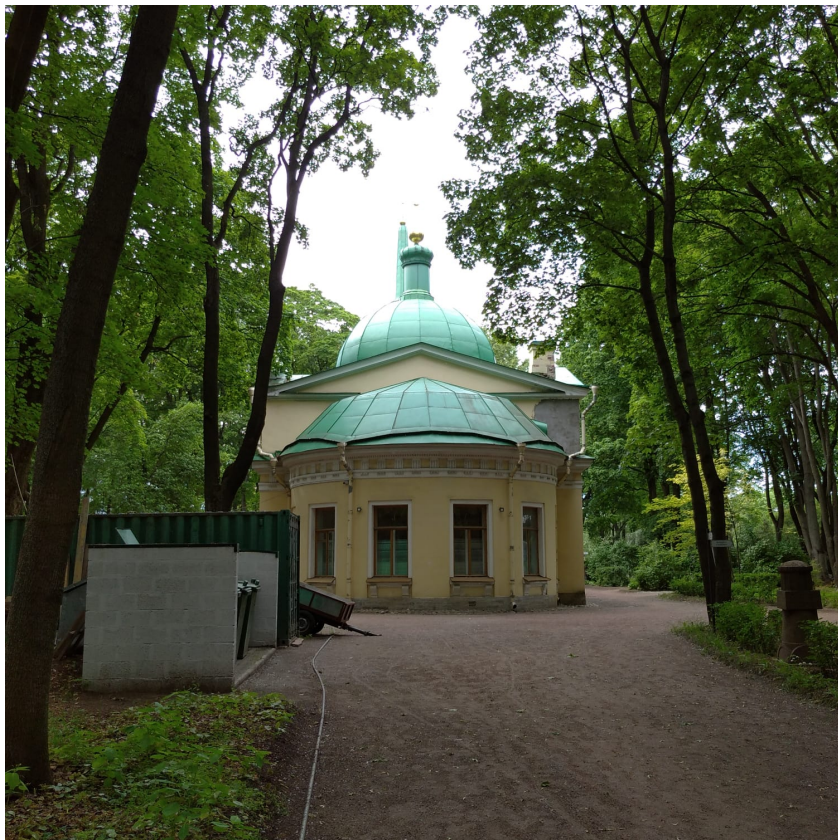
Фото 5. Общий вид восточного фасада.
