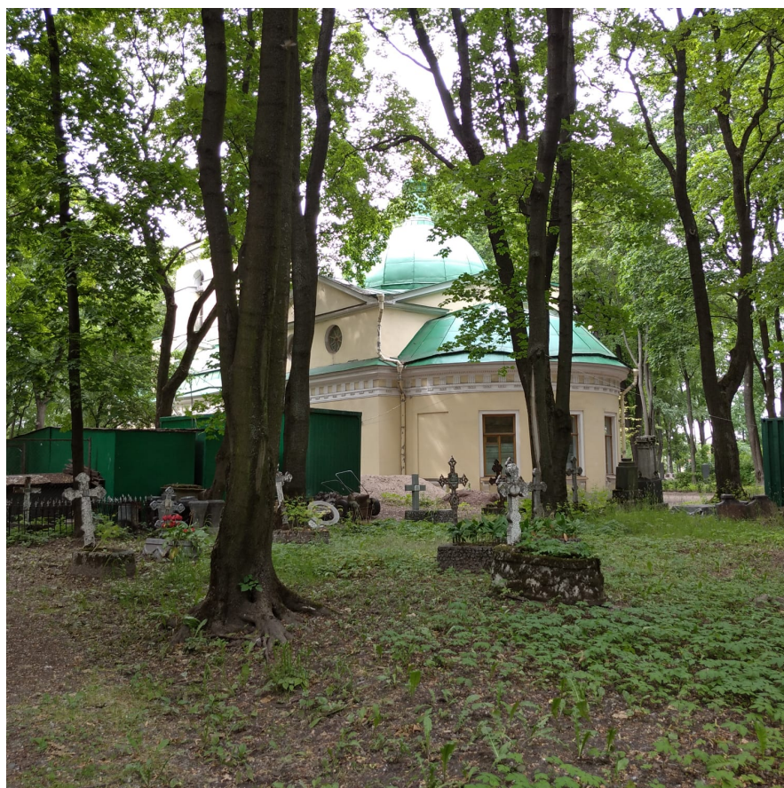
Фото 6. Фрагмент восточного и южного фасада.
