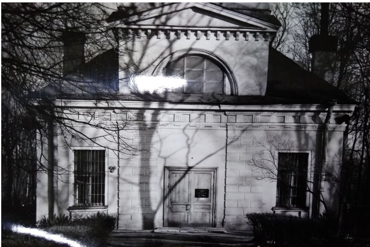
Ил. 25. Церковь Воскресения на Волковском кладбище. Фрагмент западного фасада. Октябрь 1990 г. КГИОП. Фототека без №.
