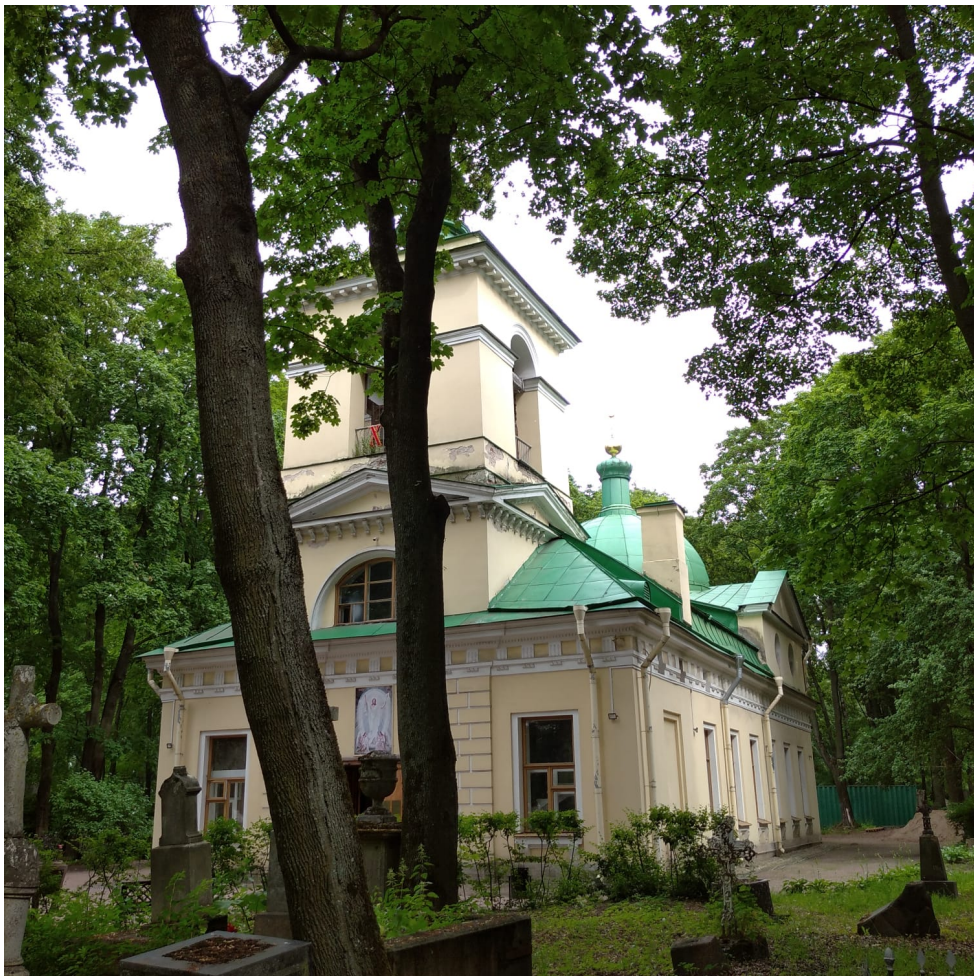
Фото 7. Фрагмент южного и западного фасада.
