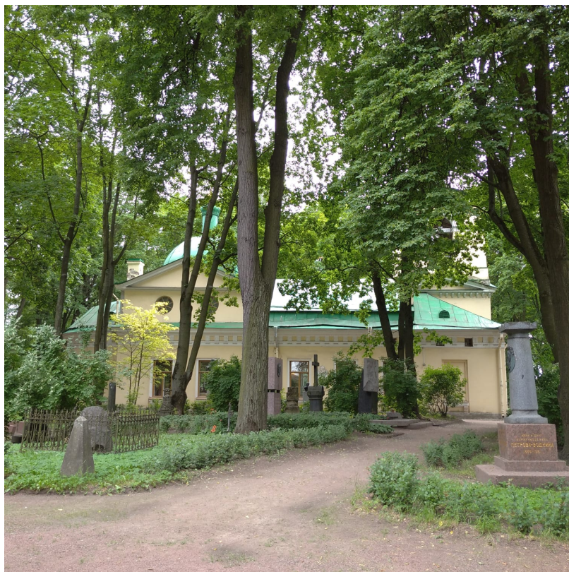
Фото 2. Общий вид северного фасада.
