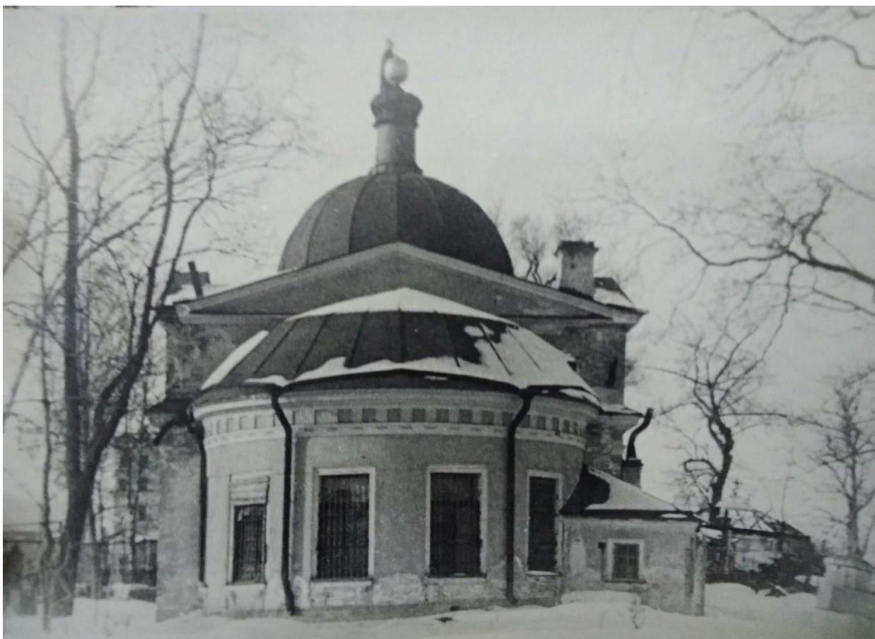
Ил. 7. Церковь Воскресения на Волковском кладбище. Восточный фасад. Начало 1940-х гг. Поступила в КГИОП 11.03.1944 г. КГИОП. Фототека №11950/1.
