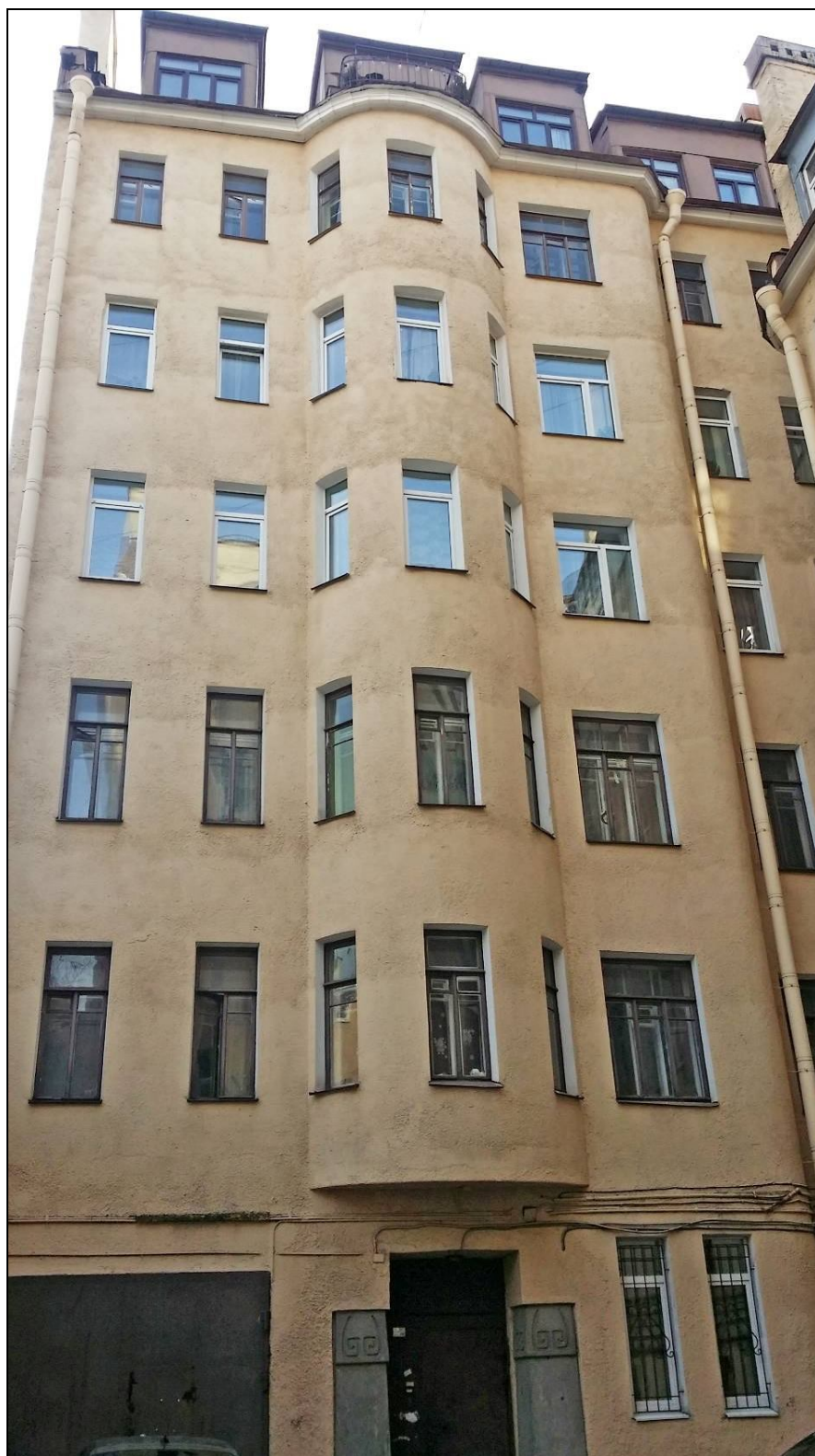
03. Фрагмент дворового фасада юго-восточного дворового флигеля.
