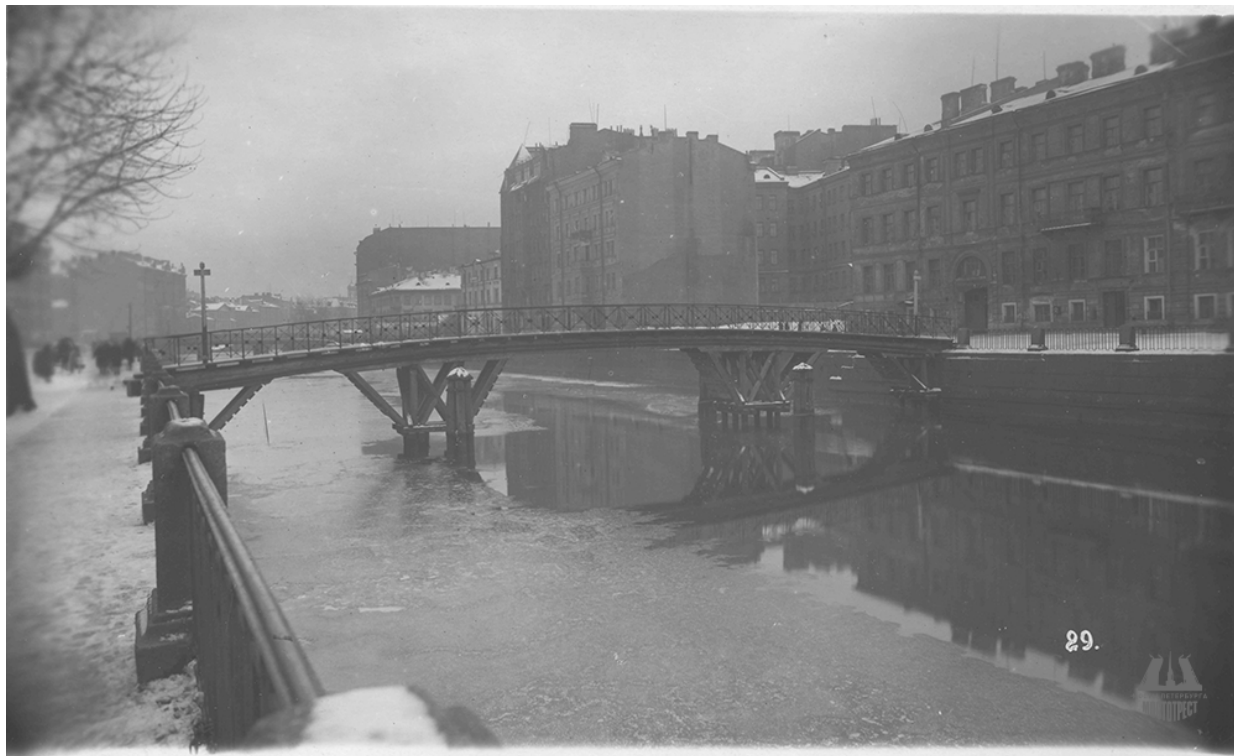
Рис.11. Фотография 1936 г. Источник: https://mostotrest-spb.ru/bridges/kolomenskij
