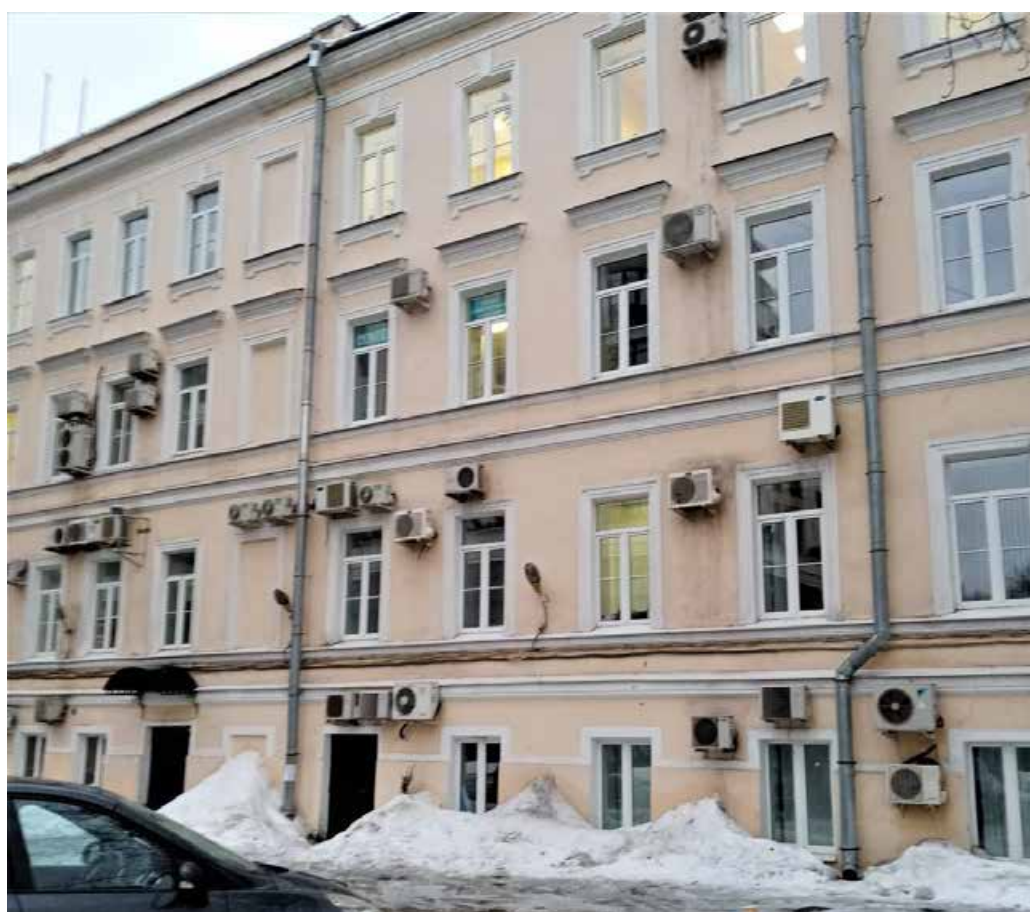
12. Объект культурного наследия регионального значения «10-я и 11-я солдатские казармы», по адресу: Санкт-Петербург, ул. Радищева, д.39, л. Д, в составе объекта культурного наследия регионального значения «Комплекс казарм лейб-гвардии Преображенского полка». Дворовый фасад с восточной стороны. Дата съемки: 20.01.2021г.
