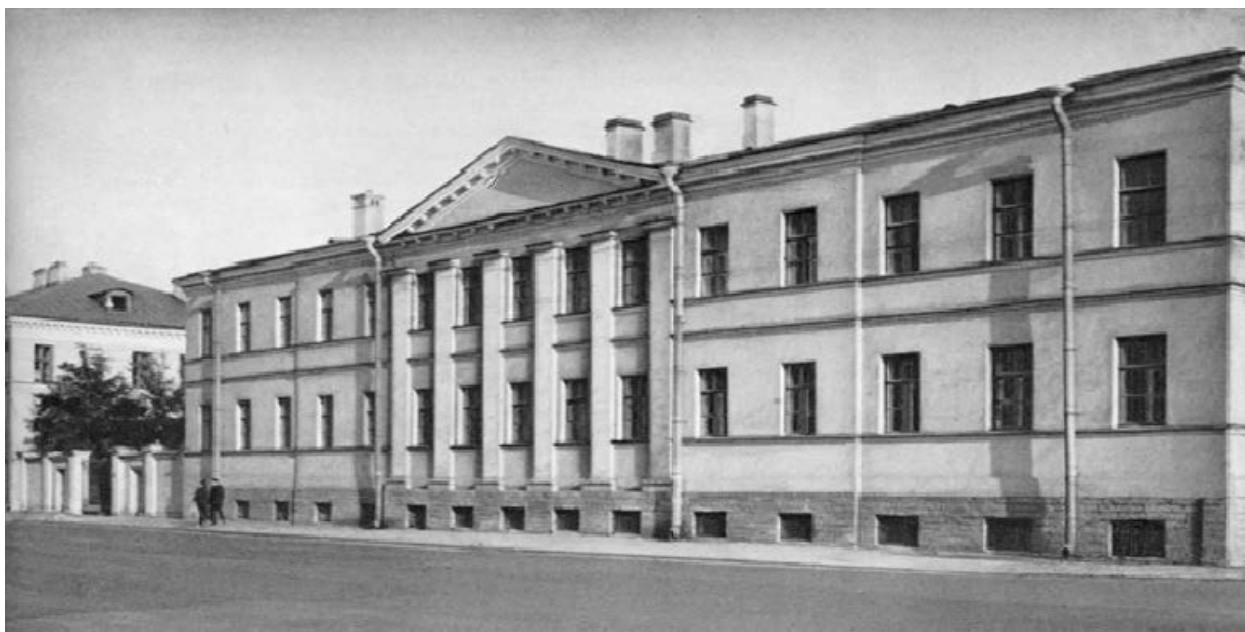
12. Казарма лейб-гвардии Преображенского полка на Кирочной улице. 1972 – 1973 гг. Источник: «Памятники архитектуры Ленинграда. гл. ред. Г.Н. Булдаков Изд. 4-е, перераб. Л., Стройиздат, ЛО, 1975.
