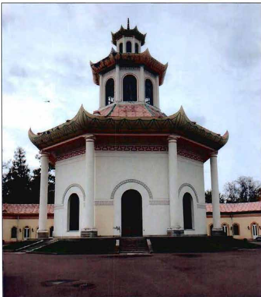
1. Общий вид с северо-востока.
