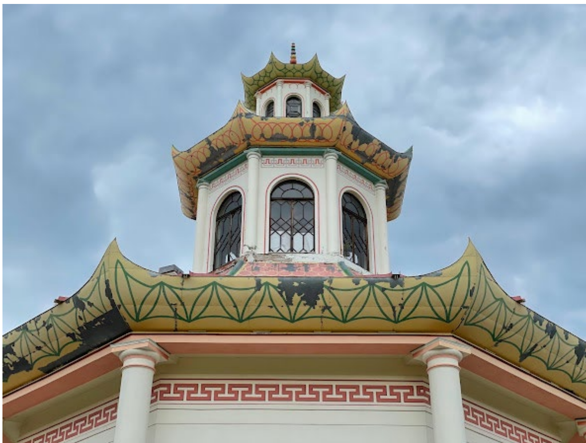
5. Фрагмент юного фасада
