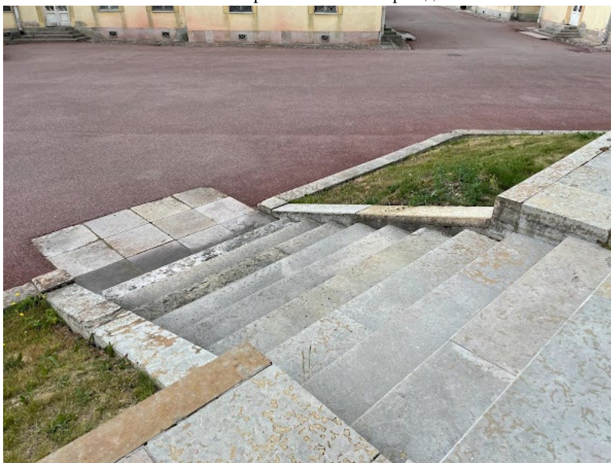
28. Лестница на юго-западном фасаде
