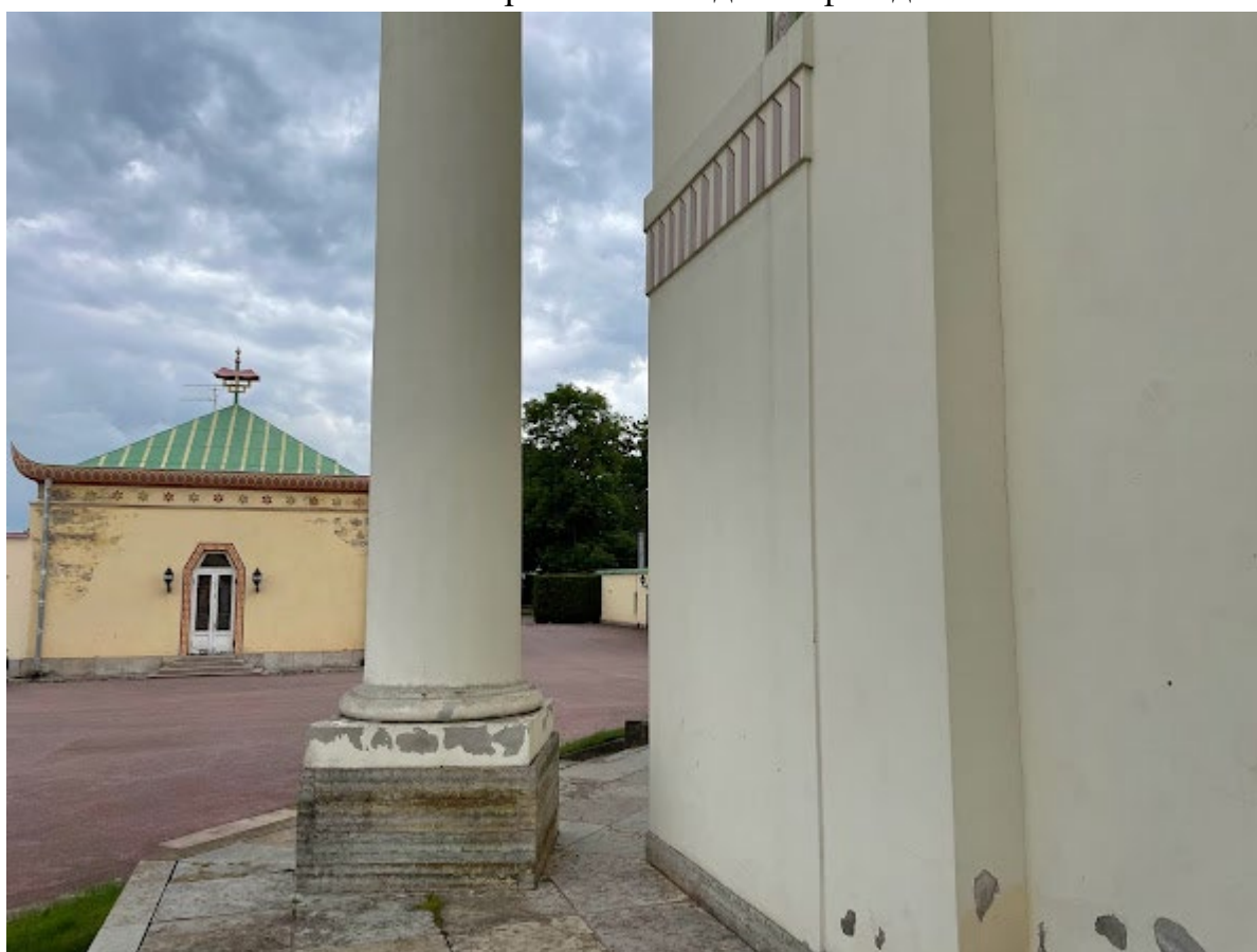
30. Фрагмент северо-западного фасада
