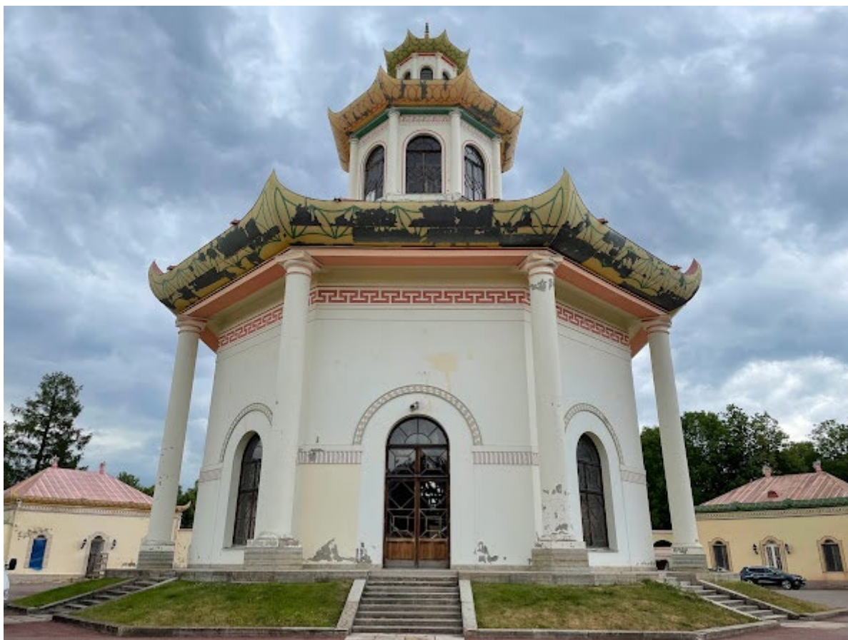
7. Вид на западный фасад
