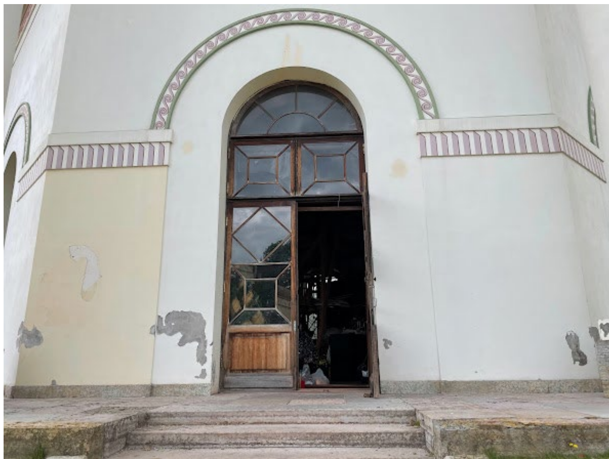
25. Фрагмент восточного фасада
