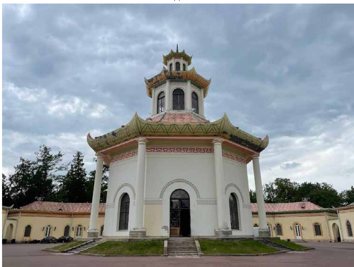
2. Вид на восточный фасад
