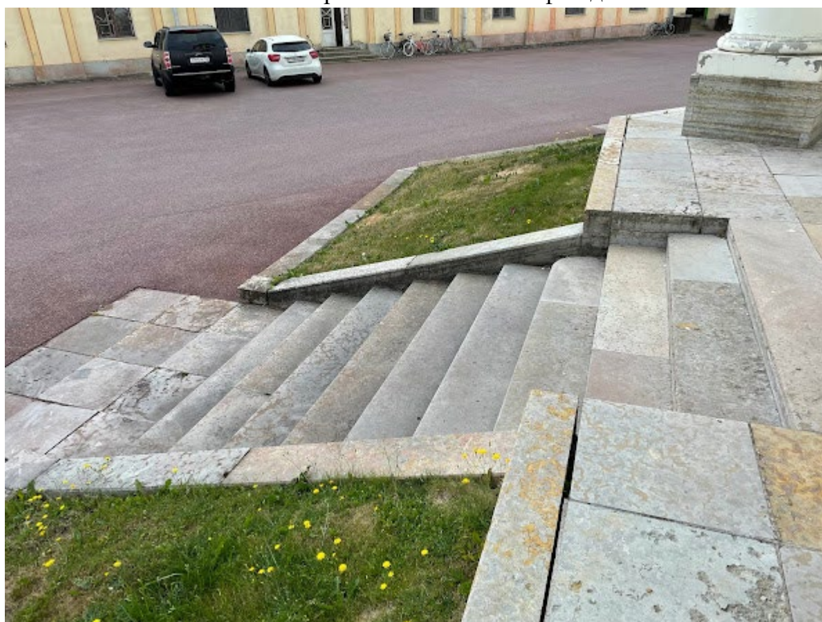
26. Лестница на юго-восточном фасаде
