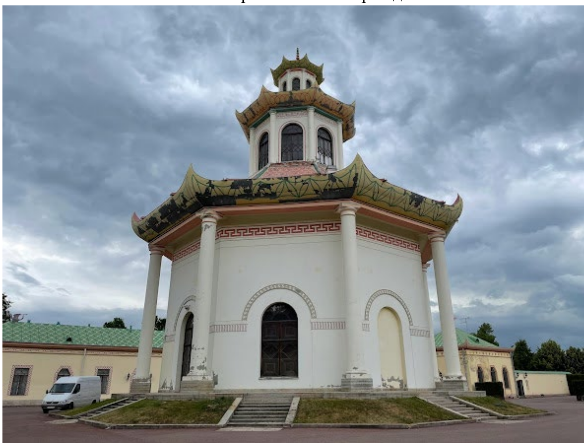
6. Вид на юго-западный фасад
