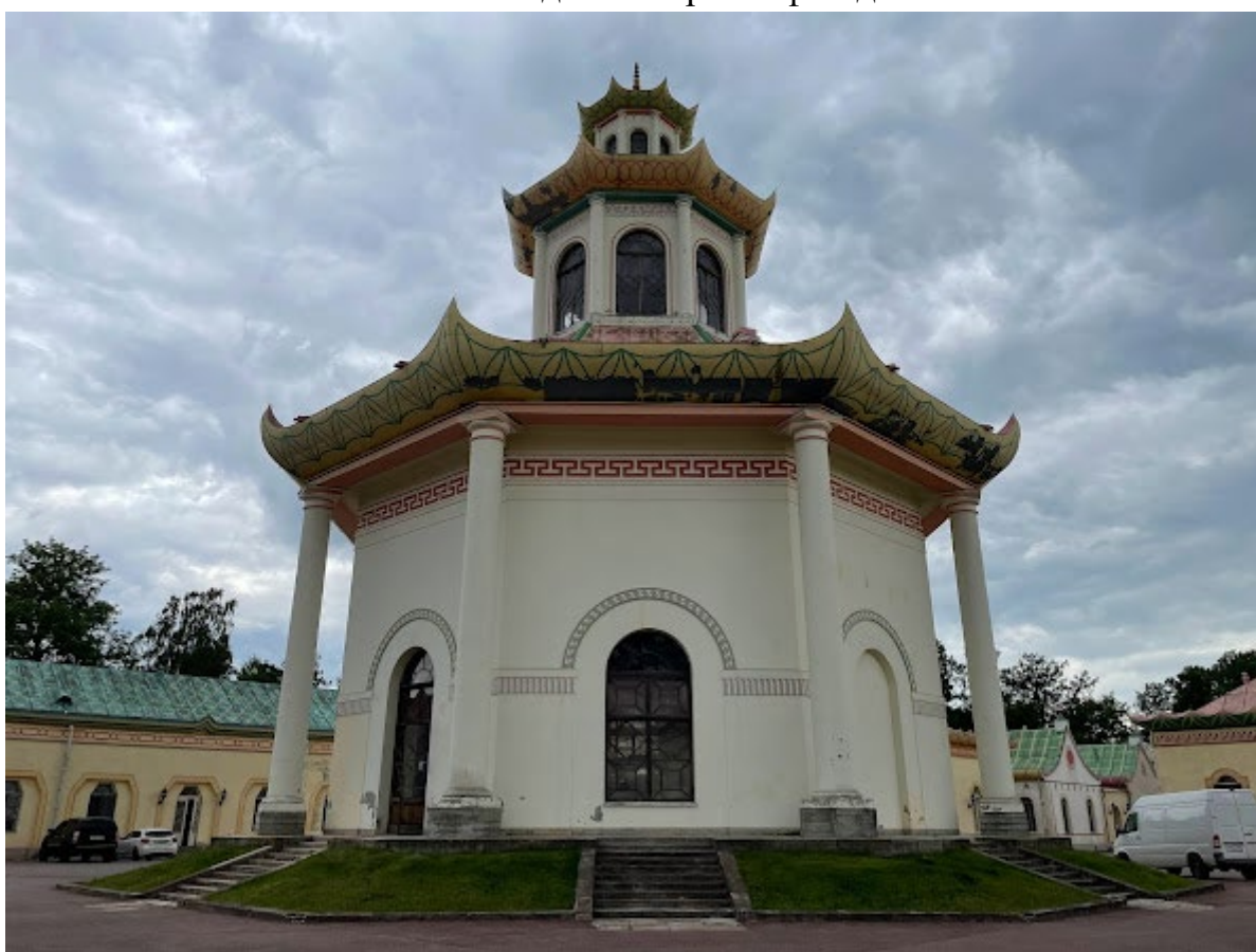
10. Вид на северо-восточный фасад
