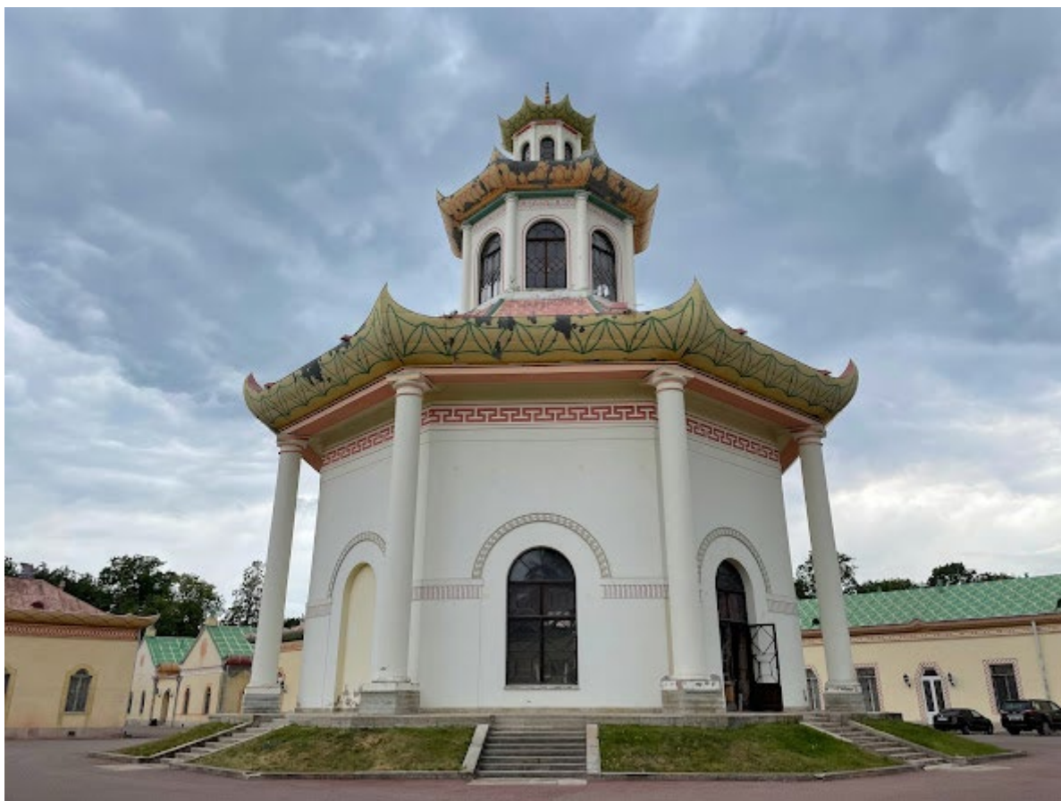
3. Вид на юго-восточный фасад
