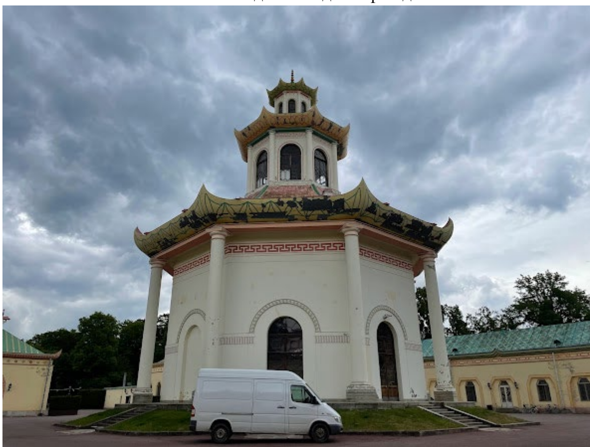
8. Вид на северо-западный фасад
