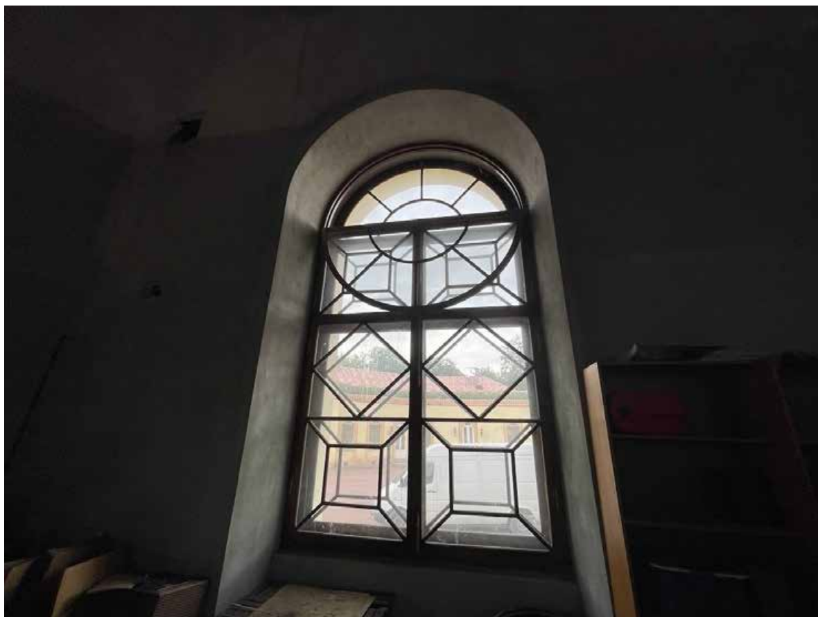
17. Заполнение оконного проема первого яруса со стороны внутреннего помещения
