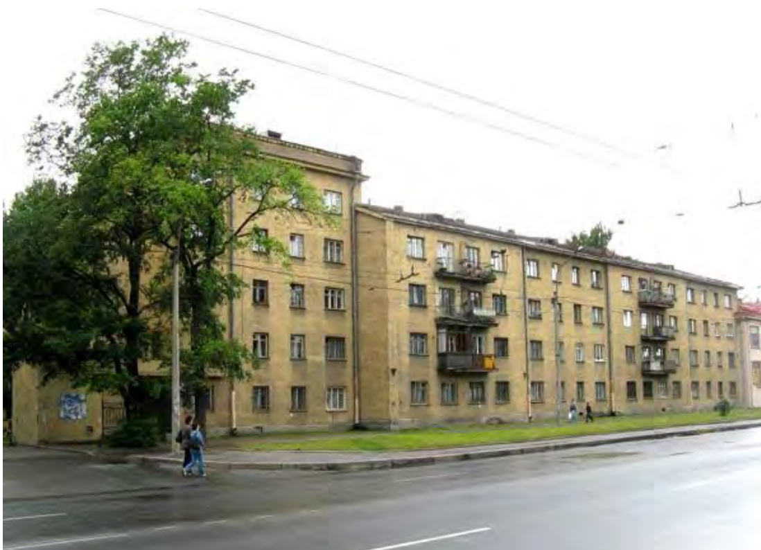
18. «Кондратьевский жилмассив», по адресу: Санкт-Петербург, Кондратьевский проспект, 40. Корпус 10, 2009 г.
