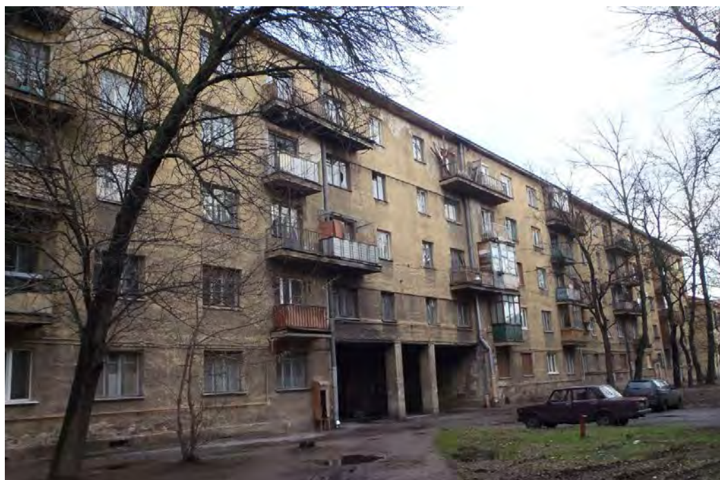
22. «Кондратьевский жилмассив», по адресу: Санкт-Петербург, Кондратьевский проспект, 40. Дворовый фасад корпуса 11. 2020 год.
