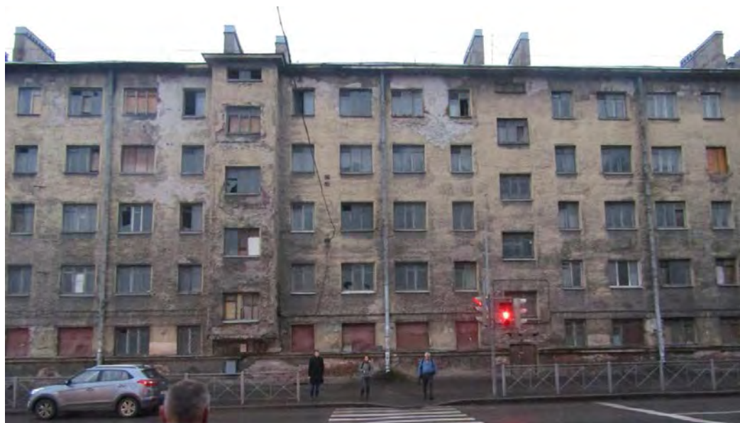
21. «Кондратьевский жилмассив», по адресу: Санкт-Петербург, Кондратьевский проспект, 40. Фасад корпуса 1, 2020 г.
