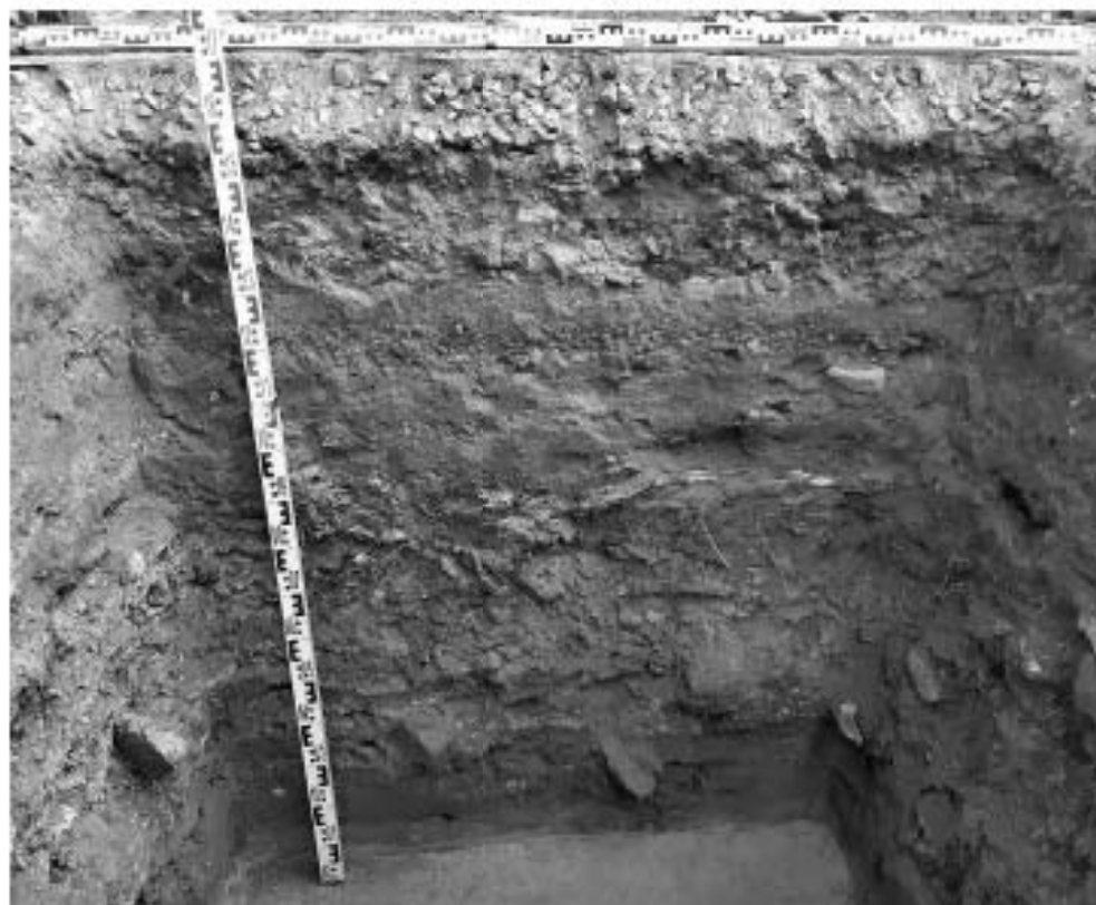
Рис. 45. Санкт-Петербург, «Приспособление для современного использования фонтанов, являющихся объектами культурного наследия, расположенных по адресам: Румянцевская пл., д.2, сооружение 1, литера Ф; д.2, сооружение 2, литера Н». Шурф 1. Фотофиксация стратиграфии юго-западной стенки.
