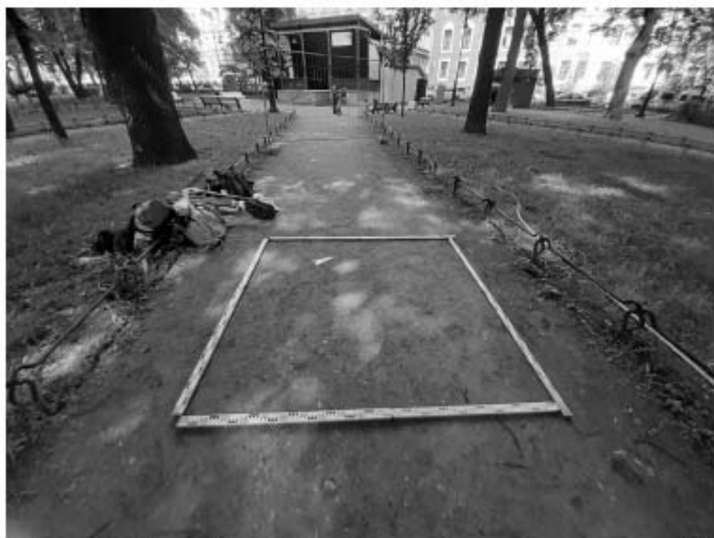
Рис. 27. Санкт-Петербург, «Приспособление для современного использования фонтанов, являющихся объектами культурного наследия, расположенных по адресам: Румянцевская пл., д.2, сооружение 1, литера Ф; д.2, сооружение 2, литера Н» Шурф 1. Общий вид до начала работ. Вид на северо-запад.
