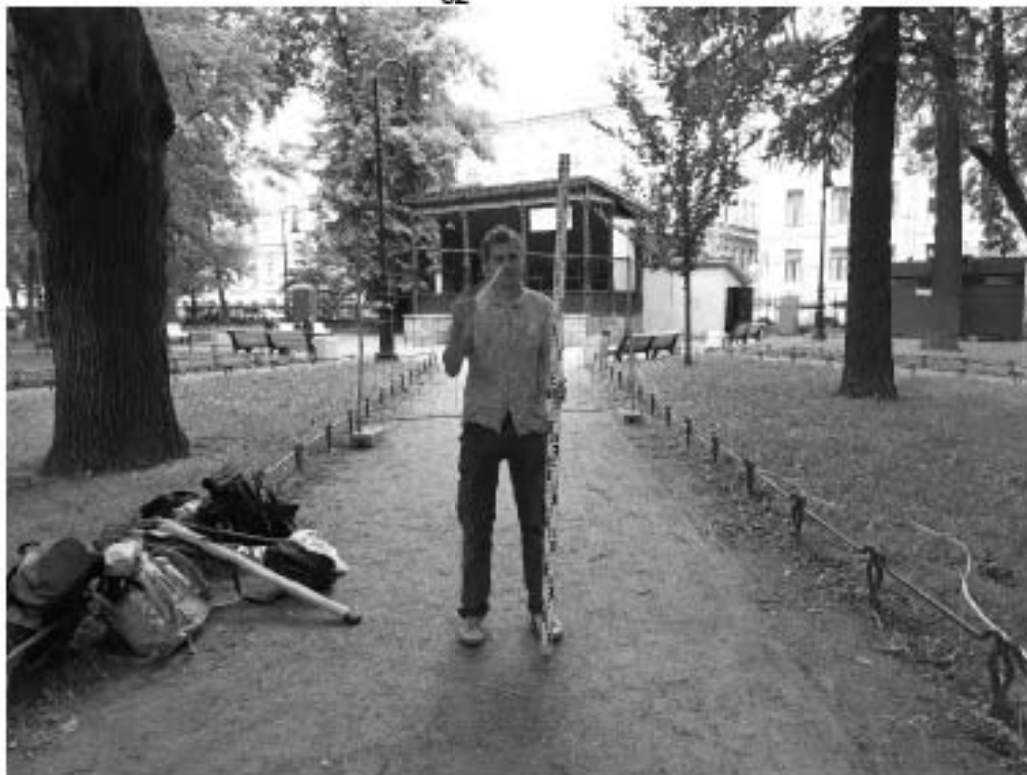
Рис. 26. Санкт-Петербург, «Приспособление для современного использования фонтанов, являющихся объектами культурного наследия, расположенных по адресам: Румянцевская пл., д.2, сооружение 1, литера Ф; д.2, сооружение 2, литера Н». Шурф 1. Общий вид до начала работ. Вид на северо-запад.
