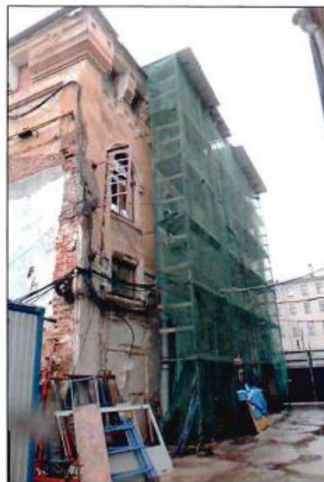
3. Общий вид северо-восточного фасада объекта культурного наследия.
