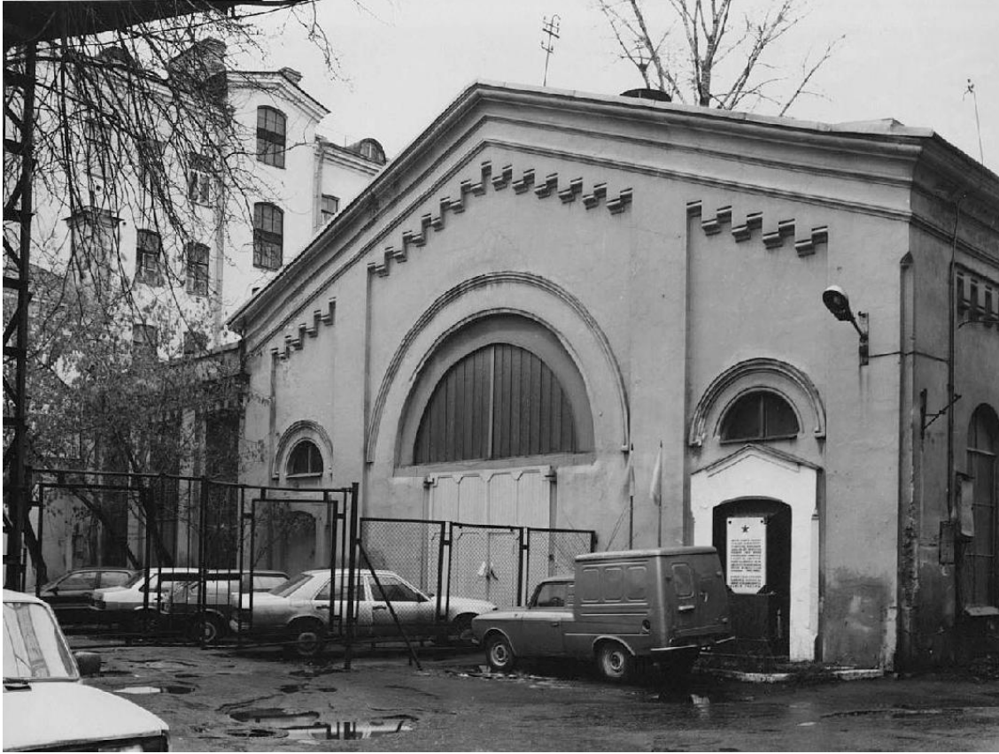
Илл. 75. Главный (юго-западный) фасад здания конторы. Фото 1999 г. КГИОП. Паспорт. Завод Чугуно-литейный и механический Ф.К. Сан-Галли. Контора. 294-З. Инв. № 880п. Составитель Луцко Е.И.
