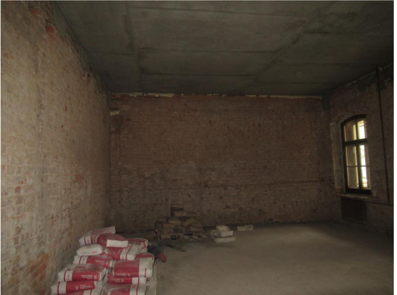
20. Помещение первого этажа здания Проходной, обращенного на дворовую территорию.
