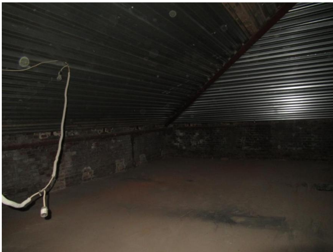
27. Технический этаж здания Проходной.
