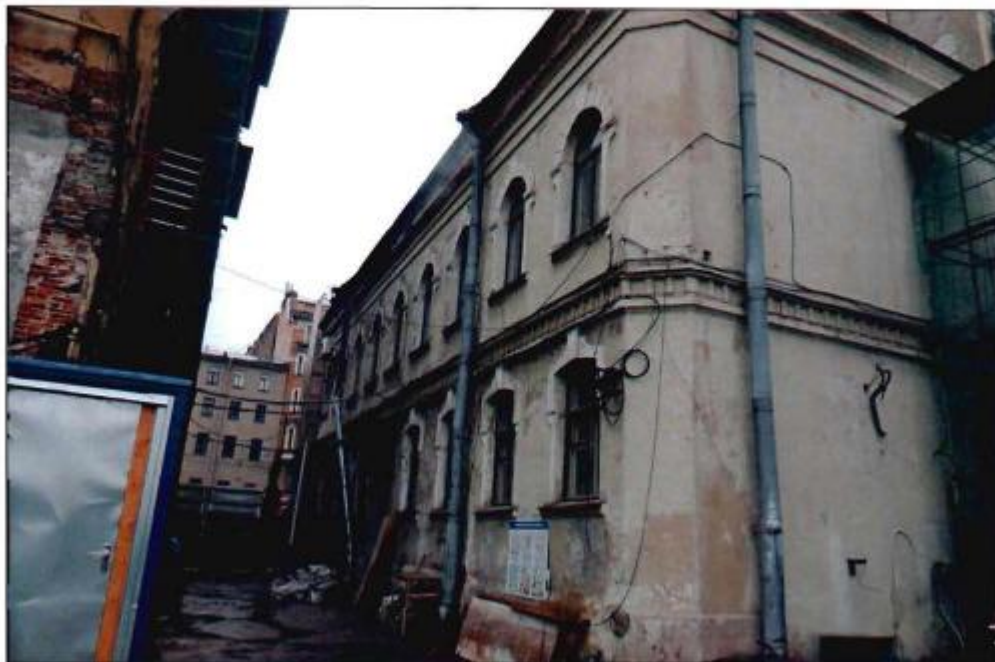
5. Общий вид объекта культурного наследия с юго-востока.
