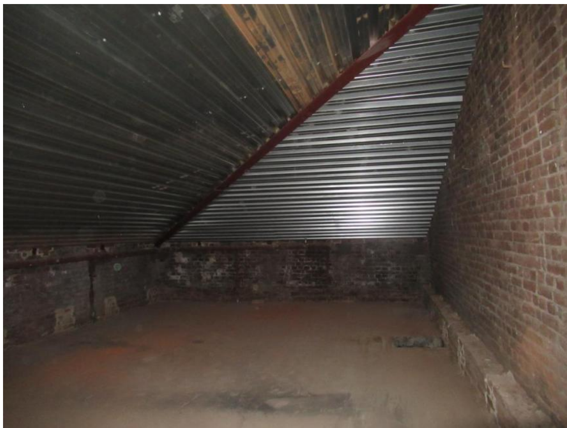
26. Технический этаж здания Проходной.
