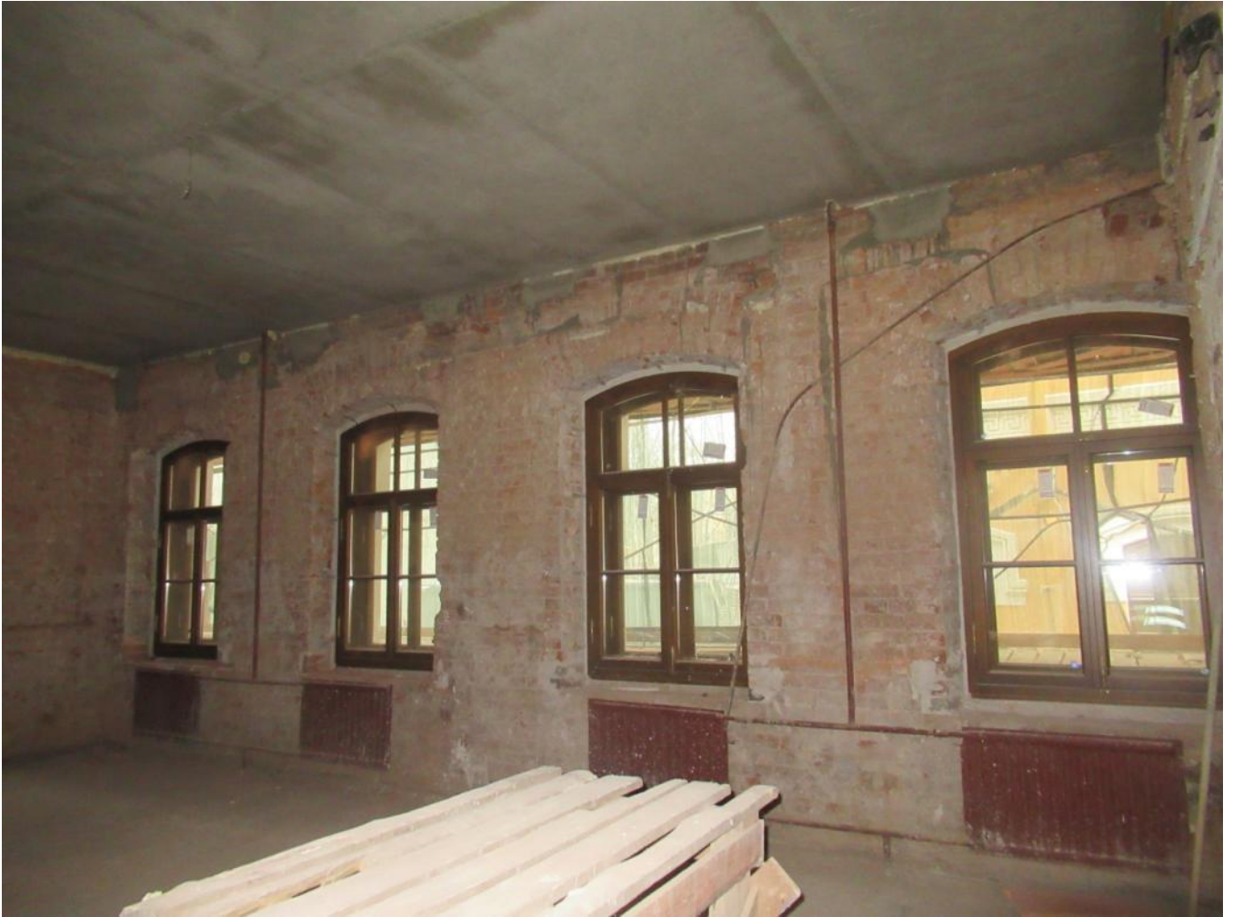
19. Помещение первого этажа здания Проходной, обращенного на дворовую территорию.
