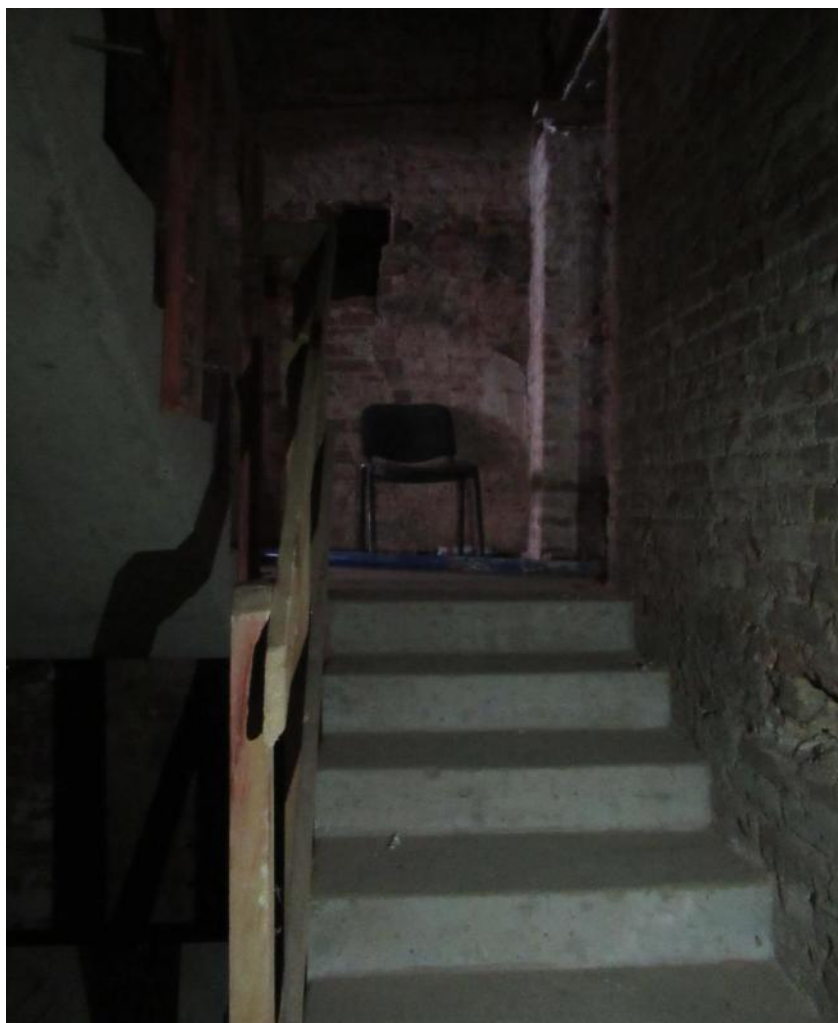
15. Лестничный марш на площадку первого этажа в здании Проходной.
