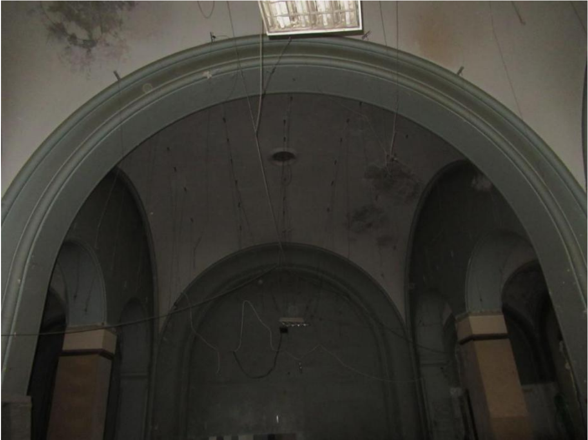
37. Парусные своды центрального пролета здания Конторы.
