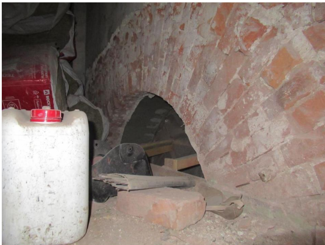
53. Помещение северо-восточной пристройки здания Конторы. Фрагмент.
