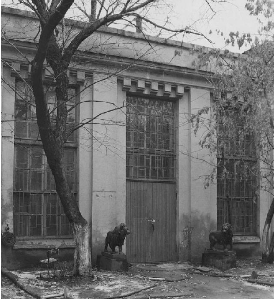
Илл. 76. Здание конторы. Юго-западный фасад пристройки. Фото 1999 г. КГИОП. Паспорт. Завод Чугуно-литейный и механический Ф.К. Сан-Галли. Контора. 294-З. Инв. № 880п. Составитель Луцко Е.И.
