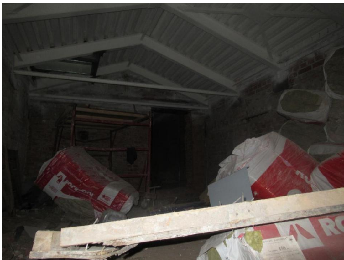
54. Помещение северо-восточной пристройки здания Конторы. Фрагмент.
