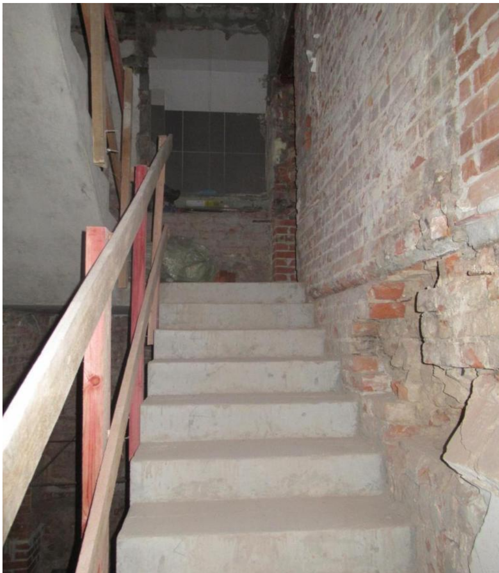
21. Марш лестницы на второй этаж.
