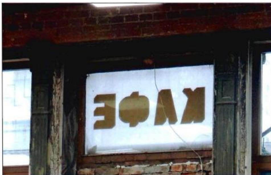
4. Интерьер. Фрагмент. Каннелированные чугунные пилястры.
