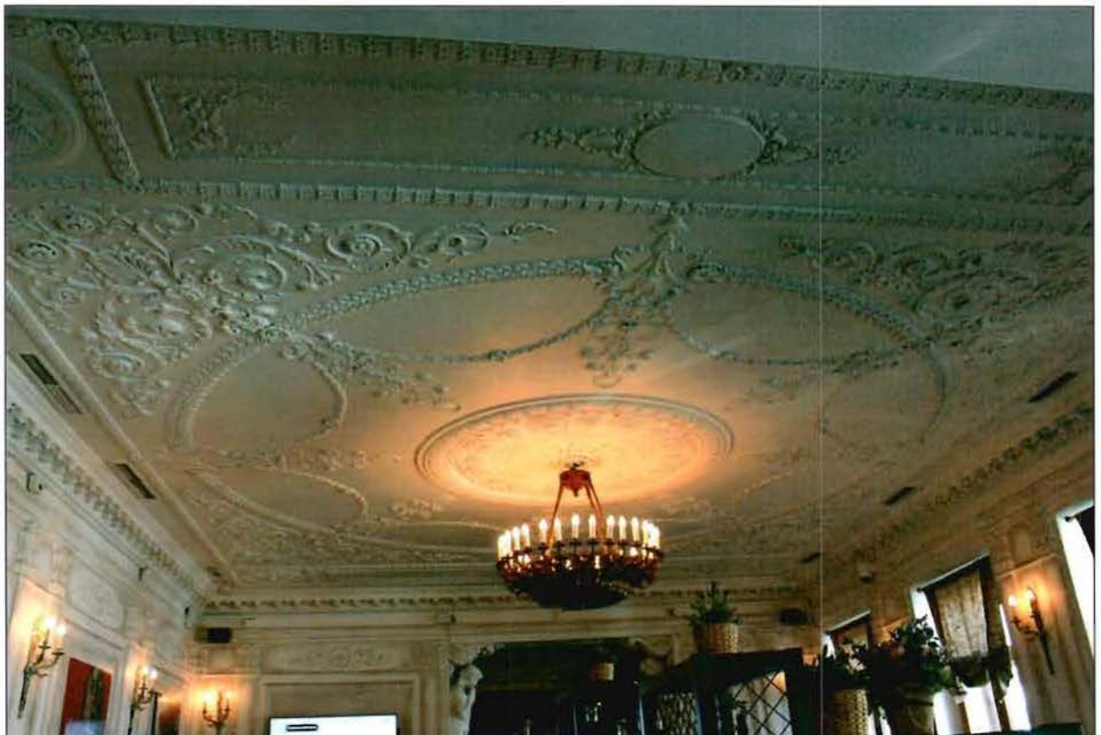
Фото №3, 4. Помещение 58-Н (1) 2-го этажа.
